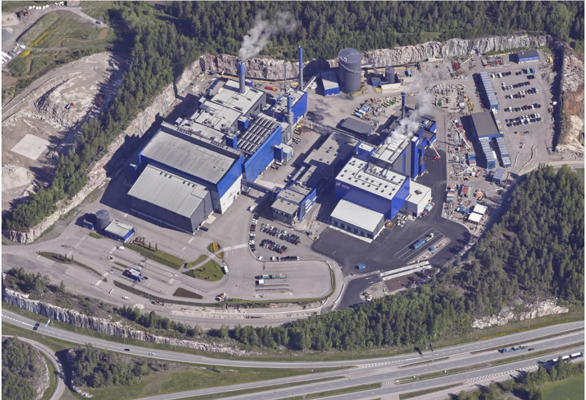
Viistoilmakuva Vantaan Energia Oy:n jätevoimalasta v. 2022
