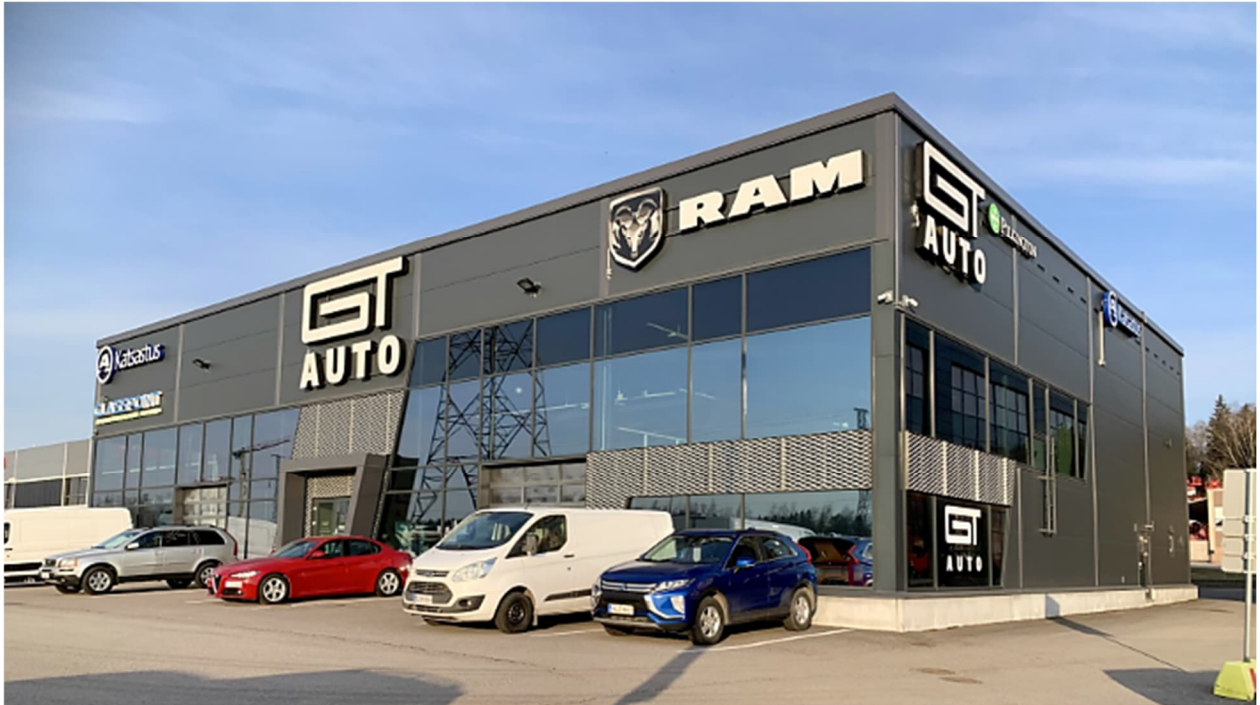
Tiilipojanlenkki 4b Kehä III:n ja pihan suuntaan.
