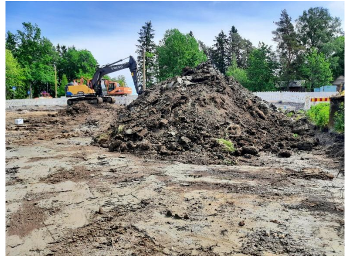
Kuva 2. Alemman ohjearvon ylittävien maiden kaivua.
