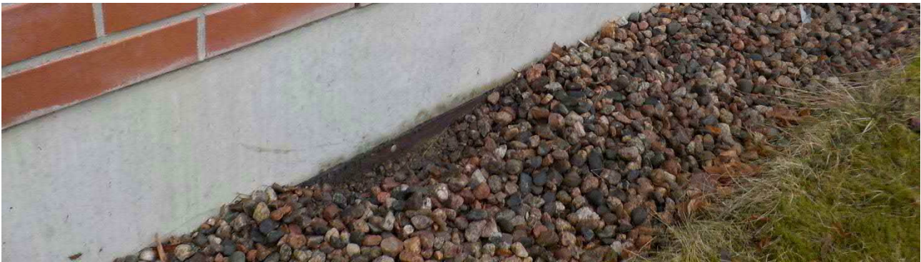
Kuva 36. Laajennusosalla sokkelin ja maa-aineksen erottava patolevy oli ehjä ja toimiva.
