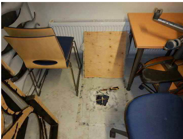
Kuva 64. Varaston 008 alapuolisessa putkikanaalissa havaittiin orgaanista ja epäorgaanista rakennusjätettä.
