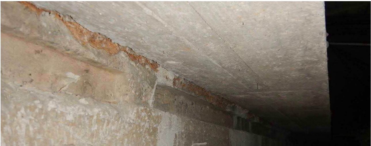
Kuva 105. A- ja B-osan välisessä liikuntasaumassa on kovalevyä.
