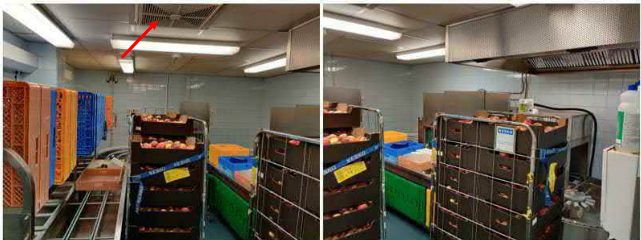
Kuva 197. Keittiön tiskauslinjan ilmanvaihto. Jäähdytyskone JK3:n sisäyksikkö merkitty punaisella.
