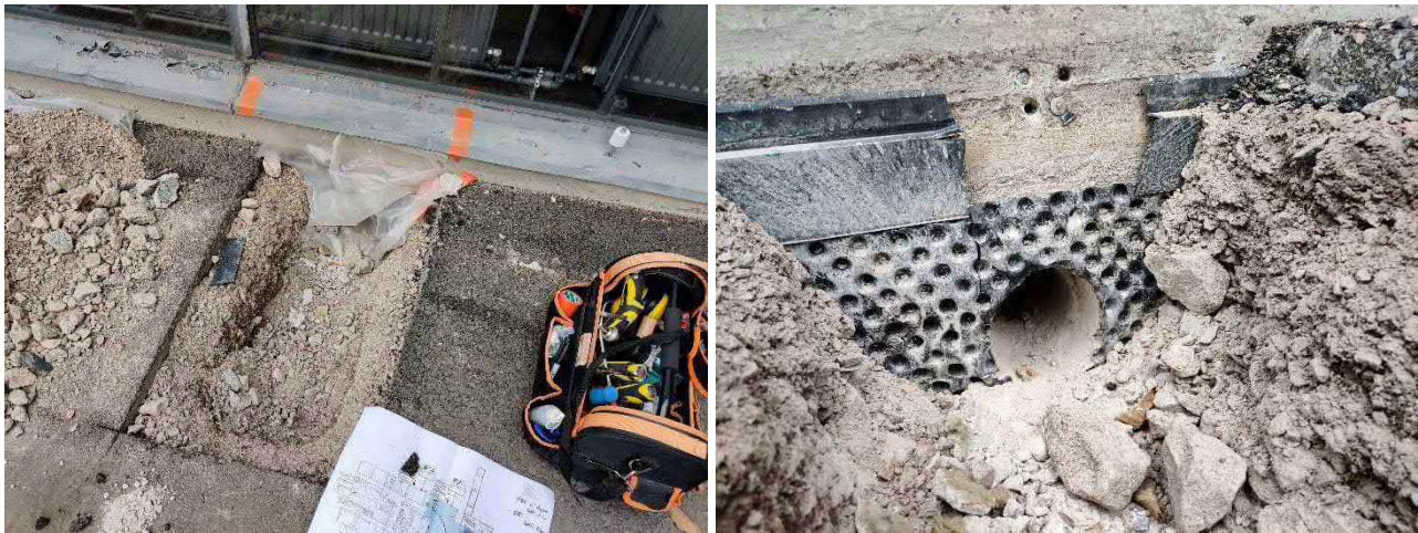
Kuva 41. Sokkelirakenteeseen SK1 tehty rakenneavaus SK1.6.
