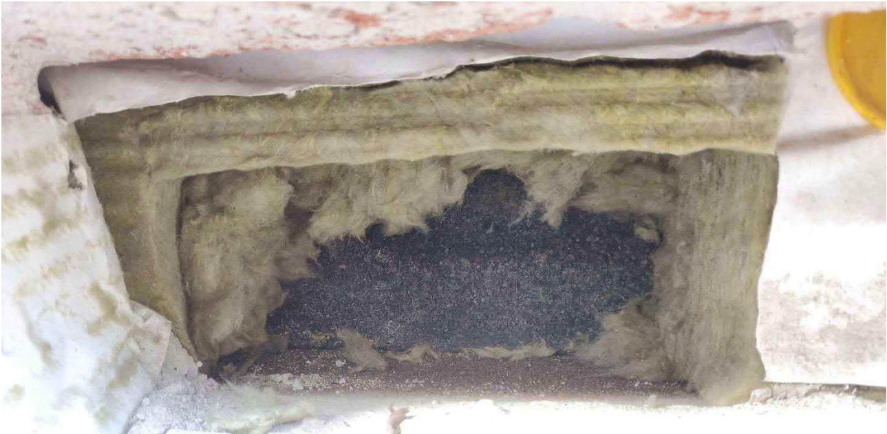
Kuva 123 Ulkoseinärakenteeseen US1 tehty avaus US1.7
