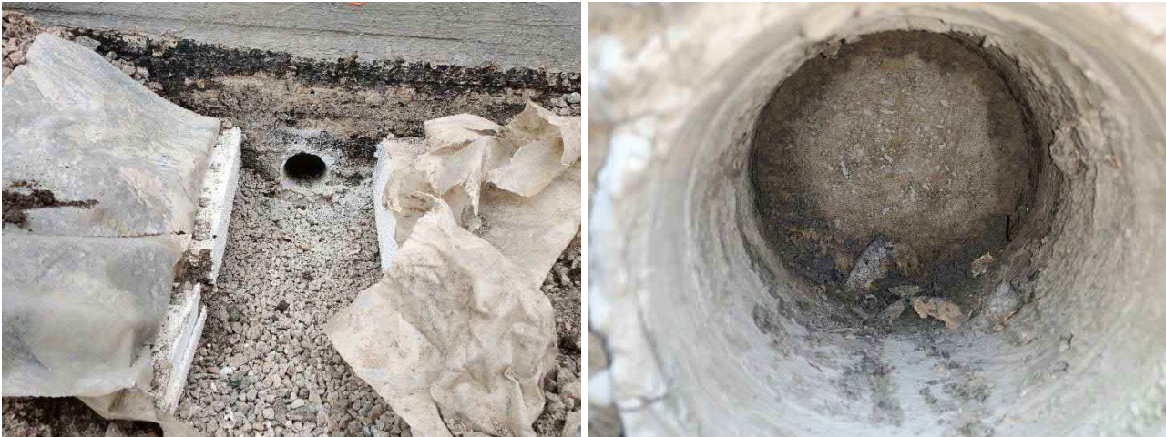
Kuva 37. Sokkelirakenteeseen SK1 tehty rakenneavaus SK1.1.
