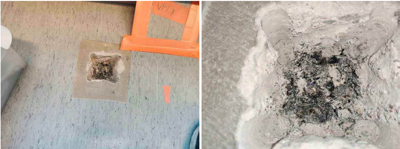
Kuva 96. Välipohjan VP1 rakenneavaus VP1.1.
