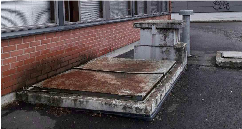
Kuva 129. Länsikyljellä [redacted] ulkoseinässä on paikallinen kosteusvaurio.
