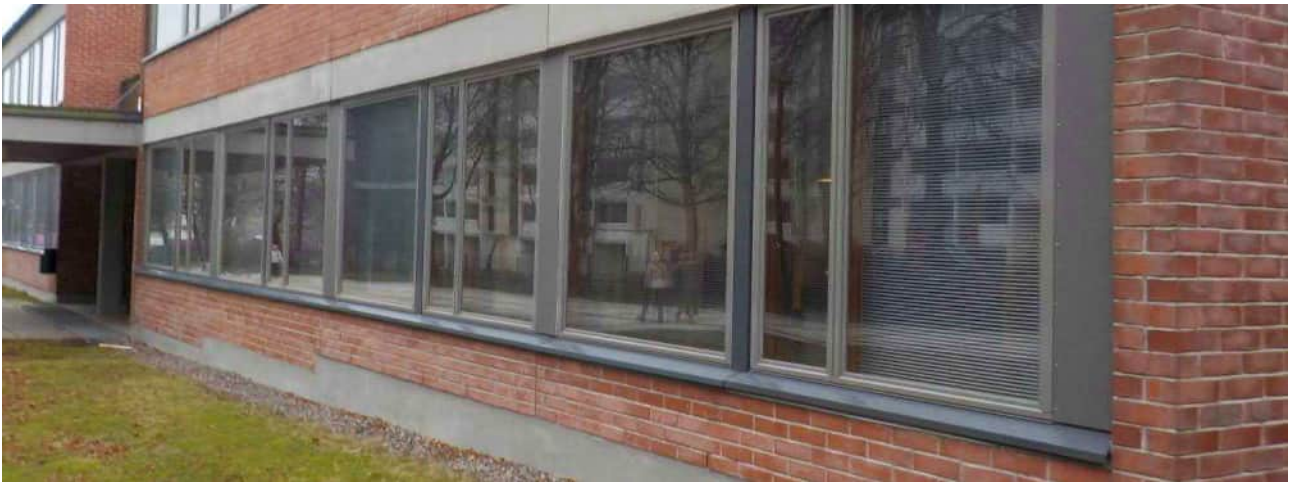
Kuva 134. Päärakennuksen pitkien sivujen ikkunat olivat hyväkuntoisia.
