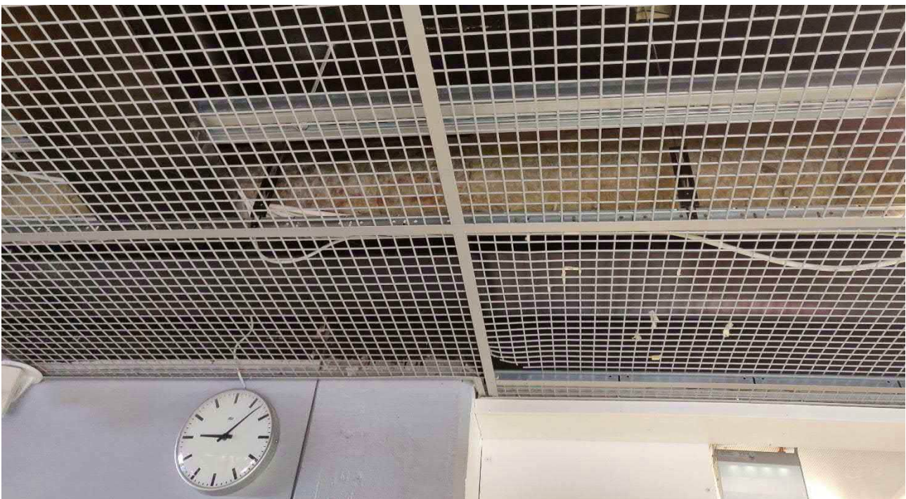
Kuva 164 Ruokalan edustalla villapintainen kanava rutiläkaton yläpuolella.
