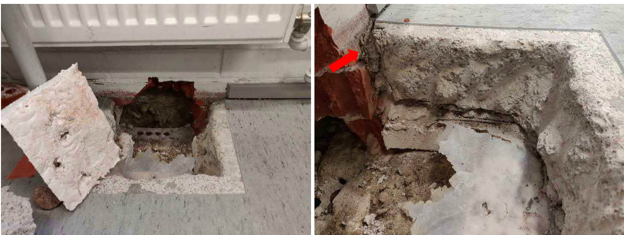
Kuva 97. Välipohjarakenteeseen VP11 tehty rakenneavaus VP11.1. Valuerotuspaperi merkattuna punaisella nuolella.
