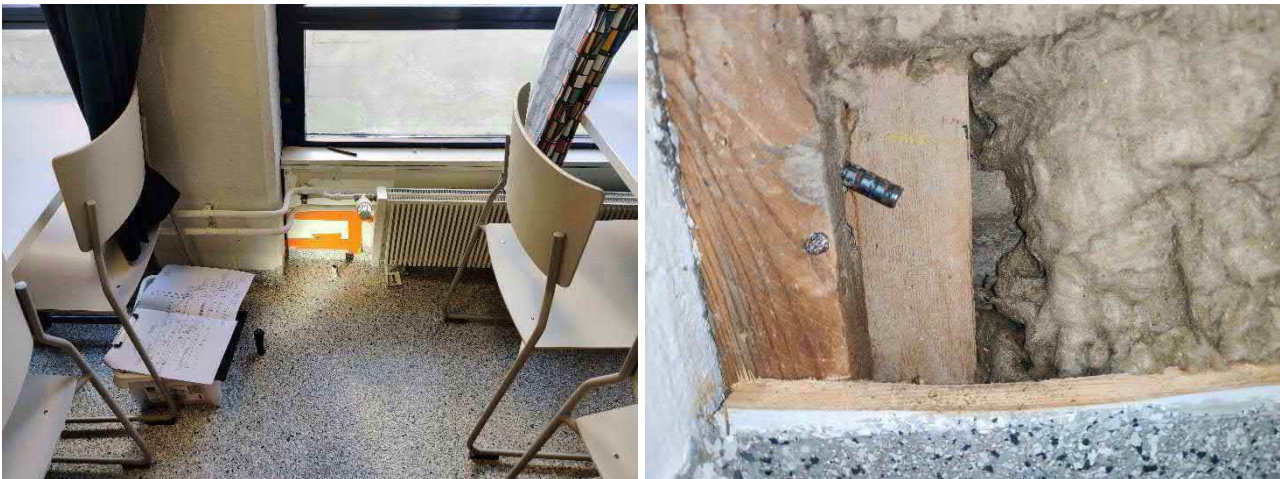
Kuva 120. Ruokalan pohjoispäädyn ikkunan alle tehty rakenneavaus US1.4.
