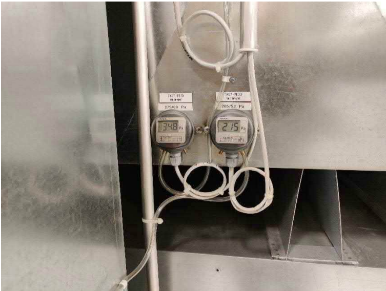
Kuva 185. TK7 tutkimusten aikainen tulopaine (348 Pa) ylitti selvästi paineanturin yläpuolella esitetyn paineasetuksen (275 Pa).
