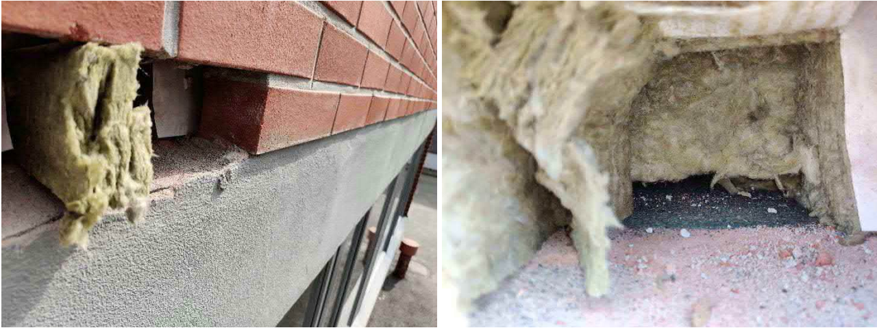
Kuva 125. Ulkoseinärakenteeseen US1 tehty rakenneavaus US1.9.
