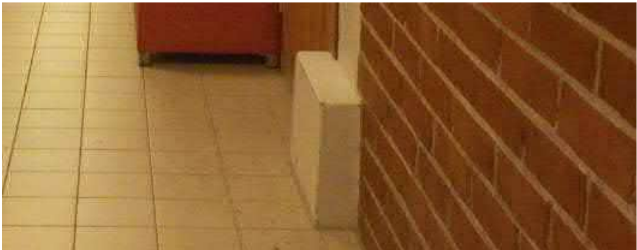
Kuva 74. Päärakennuksen kellarikerroksen pilarien anturat näkyvissä käytävällä. Kuva kohdekäynniltä 2020.
