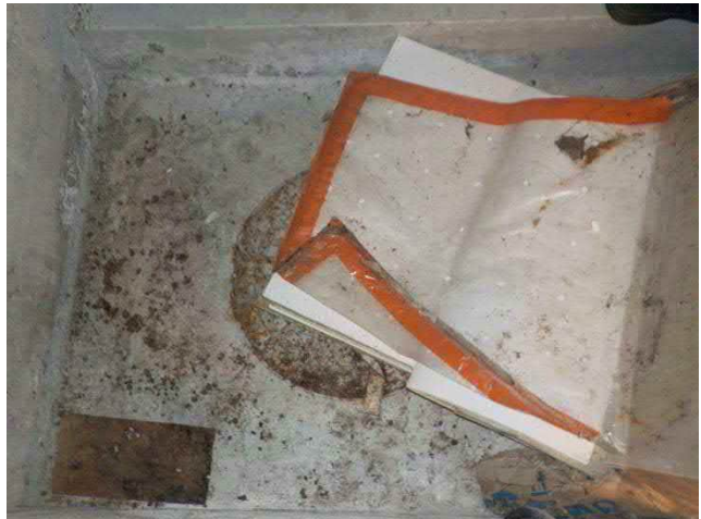
Kuva 62. Putkikanaalikäytävään 016b johtavan luukun takana havaittiin aistinvaraisesti mikrobivaurioitunutta rakennusjätettä.
