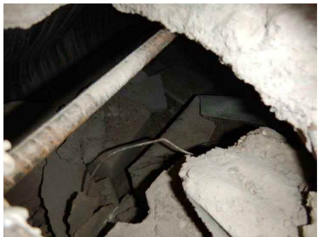
Kuva 64. Varaston 008 alapuolisessa putkikanaalissa havaittiin orgaanista ja epäorgaanista rakennusjätettä.
