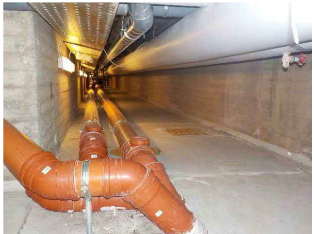
Kuva 63. B-osan kellaritilojen putkikanaalikäytävillä oli tutkimushetkellä kuivaa.
