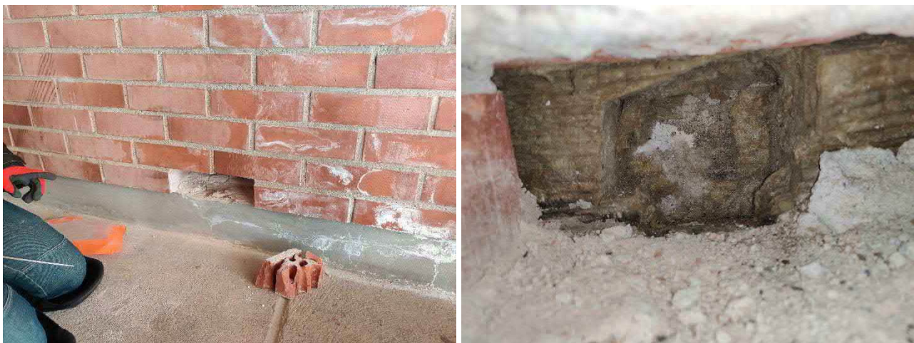
Kuva 122. Ulkoseinärakenteeseen US1 tehty rakenneavaus US1.6.
