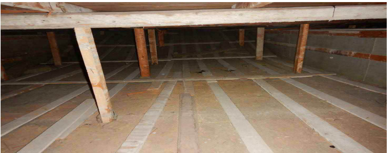
Kuva 155. Kuva yläpohjarakenteen YP6 välitilasta.
