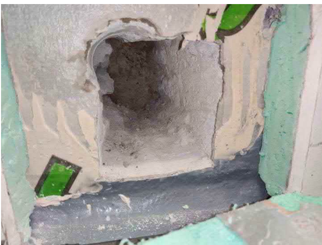
Kuva 24. Maanvastaiseen seinärakenteeseen MS2 tehtyjä avauksia.
