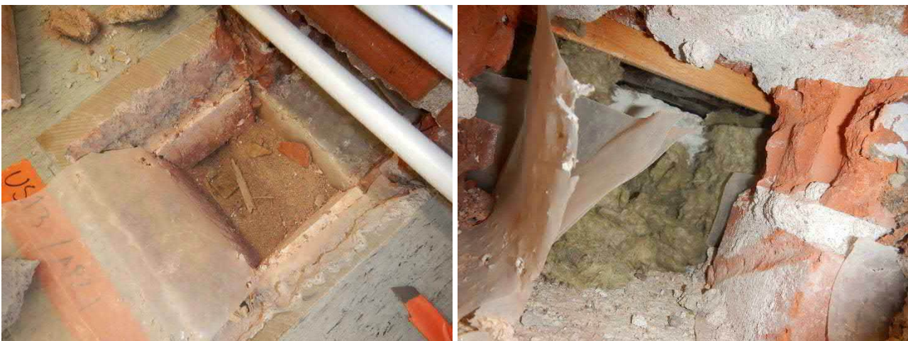
Kuva 59 Alapohjarakenteeseen AP2 tehty rakenneavaus AP2.1. Oikealla kuvassa näkyy ulkoseinäeristeet.
