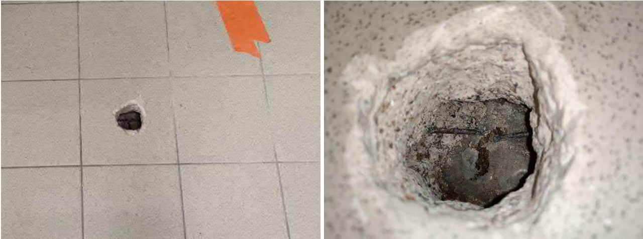
Kuva 58. Alapohjarakenteen AP1 rakenneavaus AP1.3. Avauksen kautta todettiin, että rakenne vastaa rakennetyypiä AP8.
