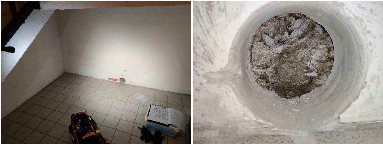
Kuva 163. Väliseinään VS3 tehty rakenneavaus VS3.1.
