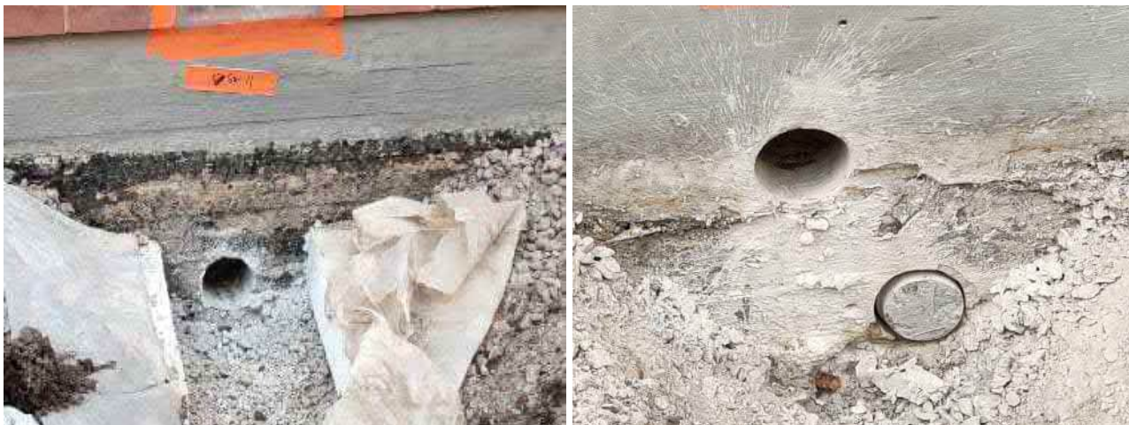
Kuva 32. Päärakennuksen nurmipäälysteisen osan sokkelien ulkopinnan ja maa-aineksen välissä vanha kosteussively, joka on rapistunut.
