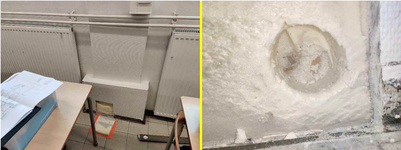
Kuva 78. Kellarin luokkatilan 054 pilarin rakenneavaus.
