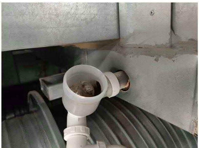
Kuva 173 TK1: tuloilmakammio. Kammiossa vesilukollinen viemärointi. Vesilukko on asennettu väärin.
