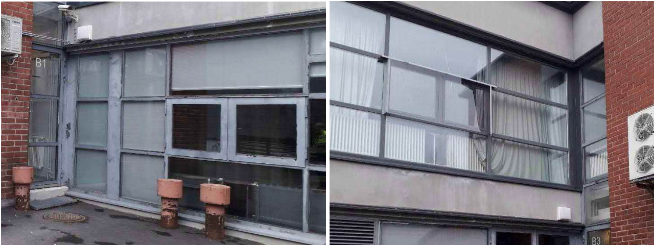
Kuva 132. Eteläpäädyn 1. kerroksen lasiseinä (vasemmalla) ja 2. kerroksen lasiseinä (oikealla).
