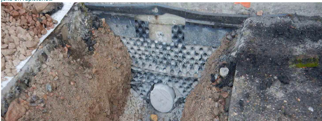
Kuva 33. Rakennuksen asfaltoiduilla osilla sokkelin ulkopinnalla on patolevyä.
