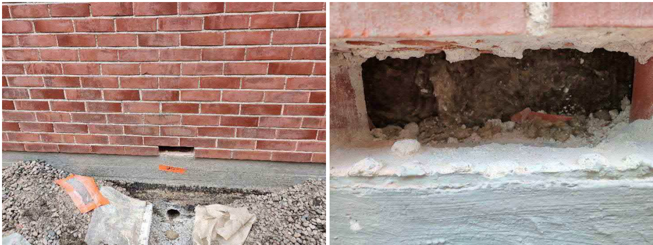
Kuva 121. Ulkoseinärakenteeseen US1 tehty rakenneavaus US1.5.
