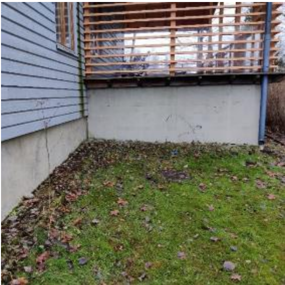
Kuva 13. Kuvassa on länsisivustaa. Maan pinta kallistuu voimakkaasti pois päin rakennuksesta.
