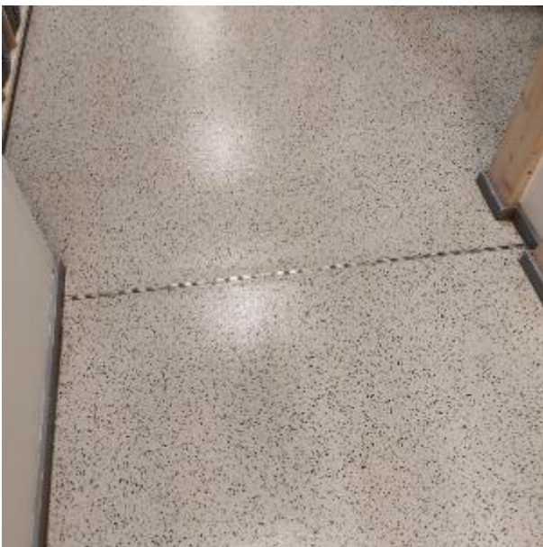
Kuva 62 a ja b. Liikuntasaumamat on toteutettu tiiviisti.
