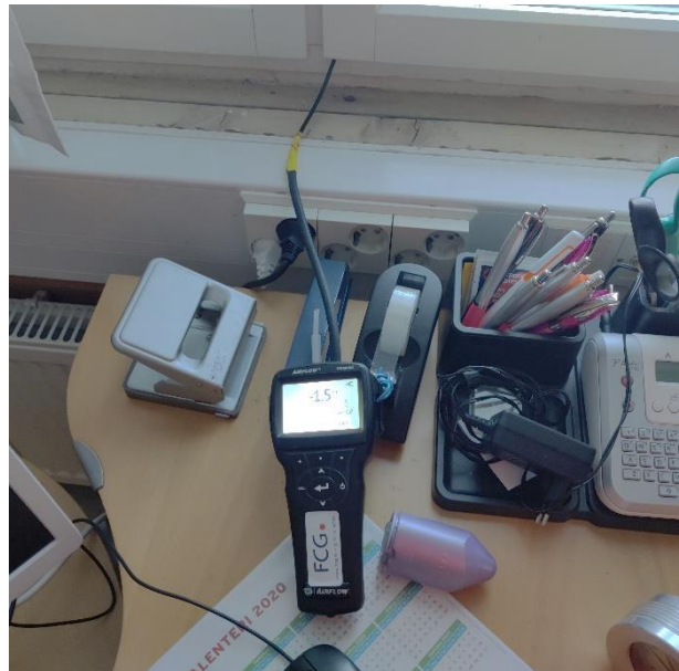
Kuva 34. Tilan 125 tehdyn hetkellisen paine-eromittauksen perusteella tila on alipaineinen.
