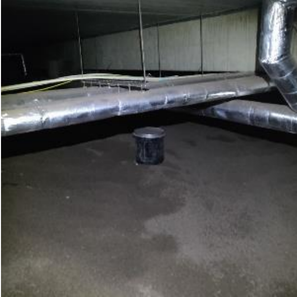
Kuva 19. Rakennuksen ryömintätilassa havaittiin salaojien tarkastuskaivoja.
