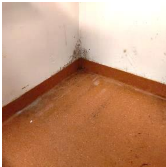
Kuva 28. Tila 011. Nurkassa on tummentumaa, ei poikkeavia pintakosteuden vertailulukemia. Muovimatto on hyvin kiinni alustassaan.
