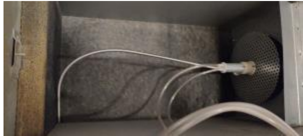
Kuva 121. Tulopäätelaitteiden liityntälaatikoiden äänenvaimenninpinnat on päällystetty kankaalla. Äänen- vaimennusosien päädyissä pieni alaisia avoimia pin- toja, joissa kova villapinta.
