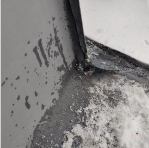
Kuva 79. Kattoläpiviennin reunakääntöjä on tiivistetty massalla.
