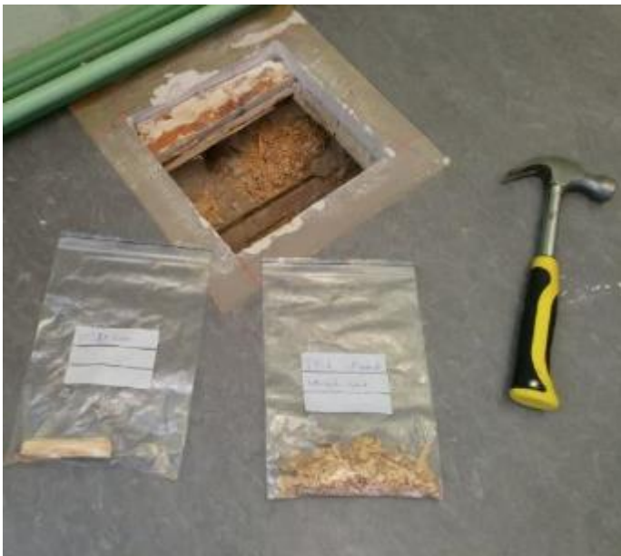
Esimerkkikuva. Rakennusmateriaalinäytteenotto suoraviljelyanalyysiä varten (FCG Oy).
