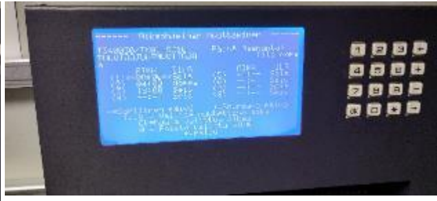
Kuva 108. Tulotaajuusmuuttajan TK1/SC10 nopea käynti alkaa ohjausjärjestelmän mukaan klo. 4:00 ja poistopuhaltimen nopea käynti alkaa klo. 6:00.
