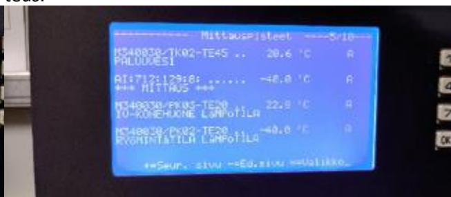
Kuva 118. Anturi PK2-TE20 ilmoittaa ryömintätilan lämpötilaksi -40 °C.
