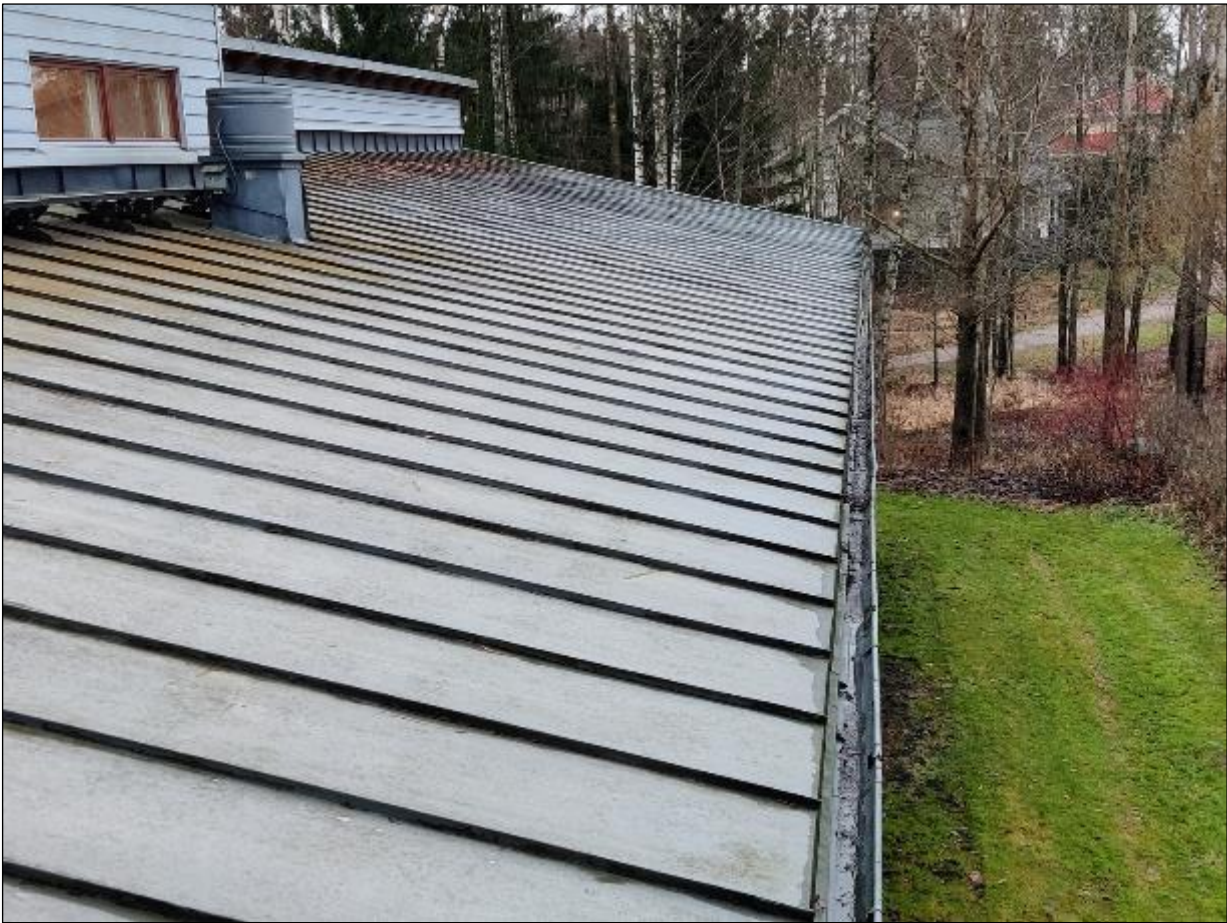
Kuva 76. Rivipeltikate on hyväkuntoinen.
