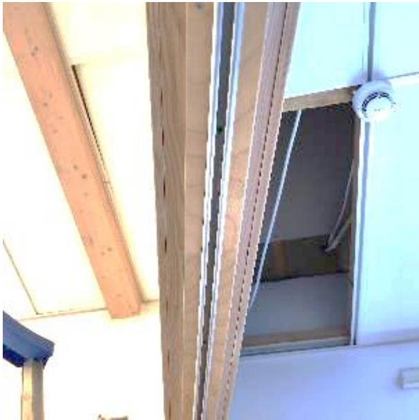
Kuva 86. AK3 avaus tilan 121 kohdalla.
