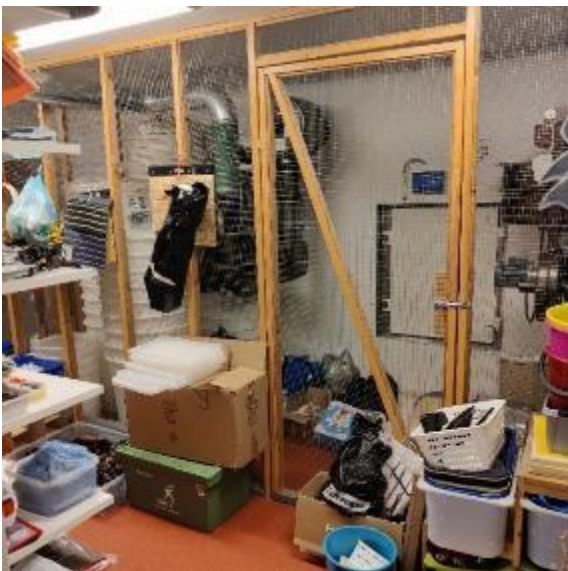
Kuva 27. Kellari tila 011. Maanpaineseinäelementeissä ei havaittu rakoja tai halkeamia.
