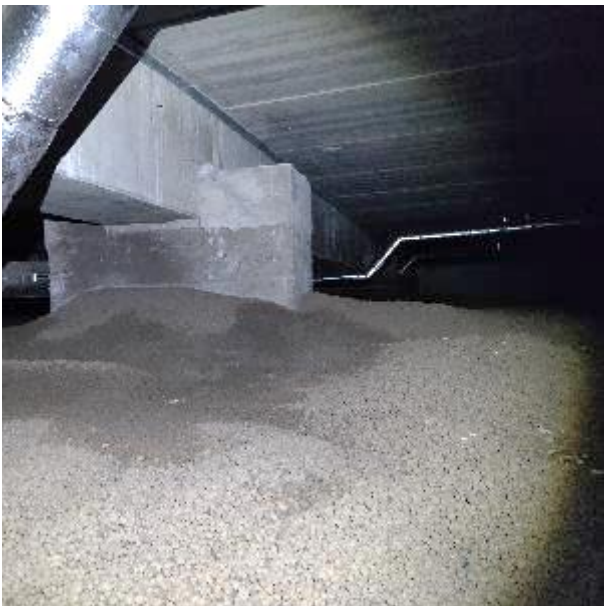
Kuva 41. Yleiskuvaa AP1 ryömintätilasta. Alapohja oli siistin näköinen.
