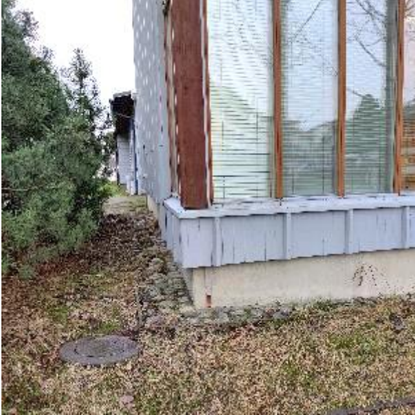
Kuva 15. Salaojan korkeus mitattiin pohjoiskulmasta.
