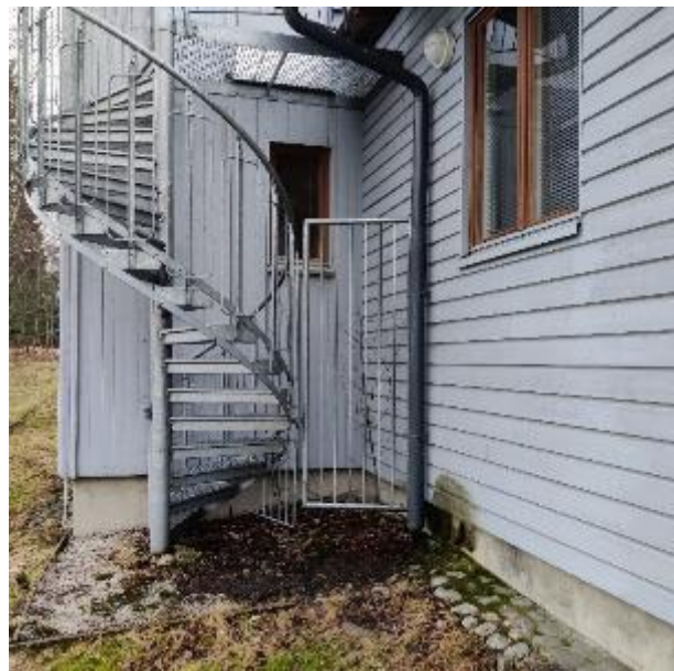
Kuva 22. Pohjoisen sivustalla sadevesiä ohjautuu rakennuksen vierustalle.
