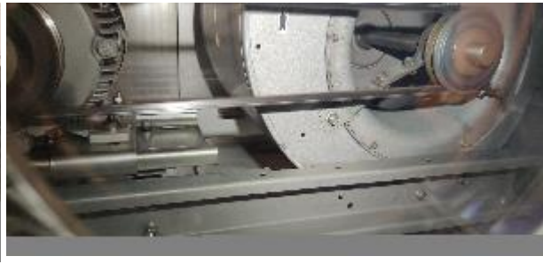
Kuva 106. Koneen hihnavetoisen puhaltimen toiminnassa ei havaittu puutteita.
