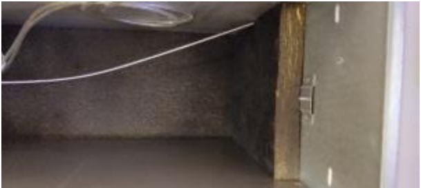
Kuva 121. Tulopäätelaitteiden liityntälaatikoiden äänenvaimenninpinnat on päällystetty kankaalla. Äänen- vaimennusosien päädyissä pieni alaisia avoimia pin- toja, joissa kova villapinta.
