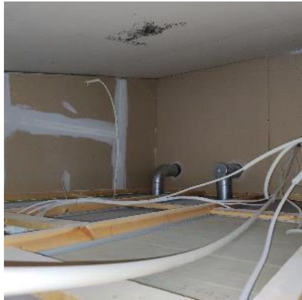
Kuva 87. Yläpuoliset tilat ovat siistin näköisiä, pölykertymää on vain vähän.
