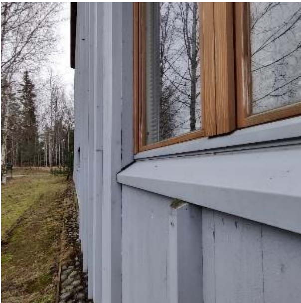
Kuva 68. Ikkunapellitysten kaadot ovat riittäviä ja hyväkuntoisia.
