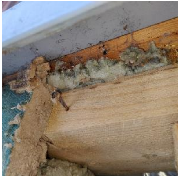
Kuva 69. Ikkunoiden tilkkeenä havaittiin olevan myös mineraalivillaa (IK1.1).
