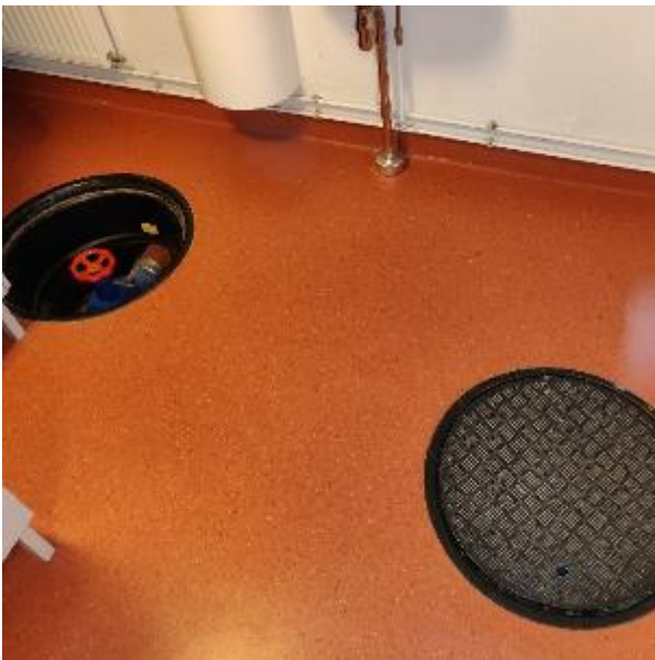
Kuva 17. Tilan 005 padotuskaivot.
