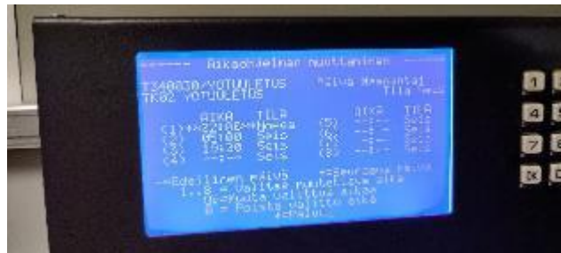
Kuva 112. TK2:n osalta ohjauksjärjestelmässä on mahdollisuus yötuuletukseen.
