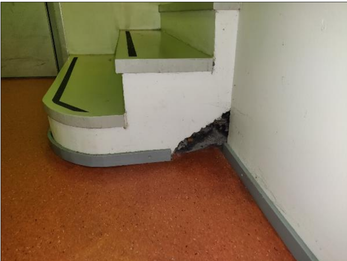
Kuva 61. Portaikon reunassa on ilmayhteys ryömintätilaan (tila 001).
