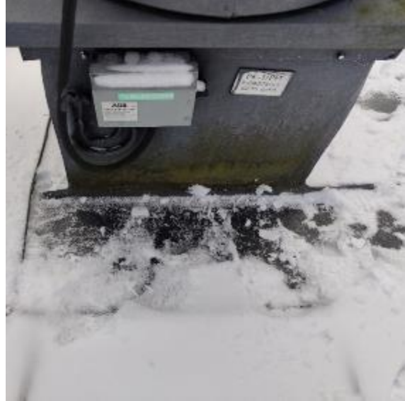
Kuva 80. Puhaltimen kattoläpiviennin kohdalla ei havaittu vuotokohtia.
