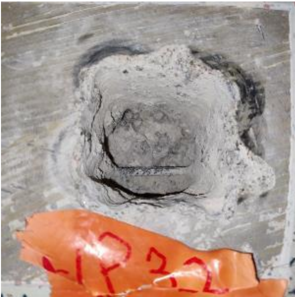
Kuva 57 a ja b. Rakenneavauksista tarkastettiin kosteuslukemien ja aistinvaraisten havaintojen lisäksi rakenteen suunnitelmien mukaisuus.
