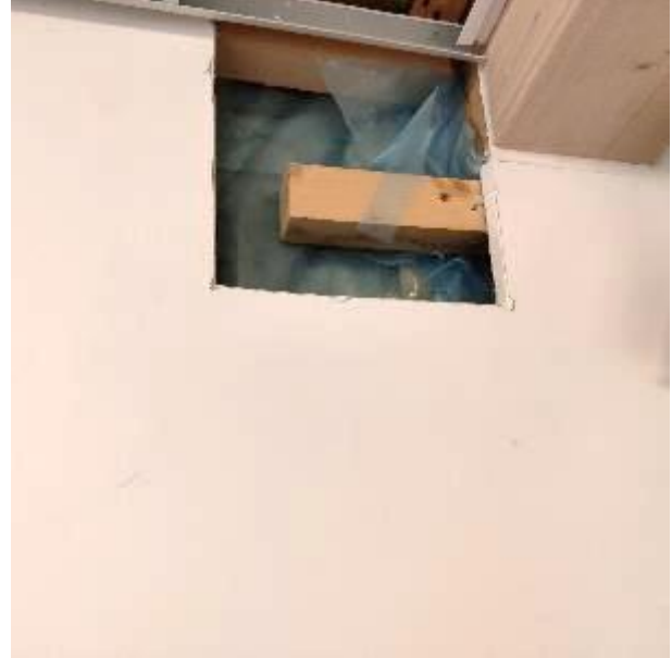
Kuva 53. US4.1 sisäpuolinen avaus kohta tehtiin palkin ulkoseinäliittymään (tila 104).
