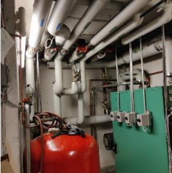
Kuva 50. Kellarin kantavaa väliseinää tarkasteltiin mm. LJH-tilan 002 puolta.
