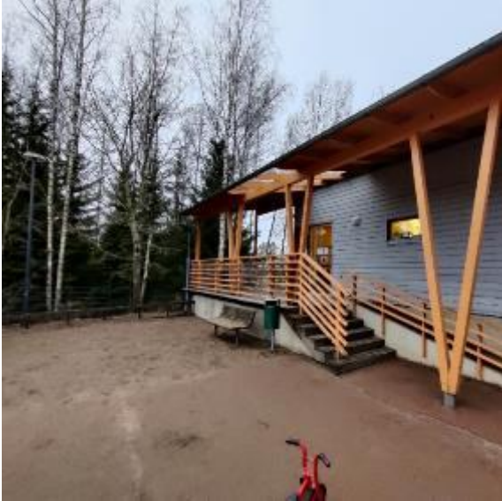
Kuva 11. Sisäpihalla kallistukset ovat kunnossa (eteläsivusta).
