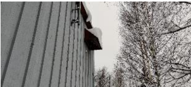
Kuva 101. TK1:tä ja TK2:ta palvelevan ulkoilmalaitteen yläpuolelle on rakennettu katos.
