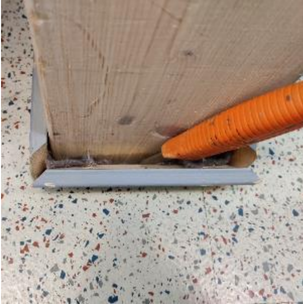
Kuva 52. Jalkalistan taustan tarkastaminen tilan 135 käytävällä. Puupilarin kautta on ilmayhteys eristetilaan.
