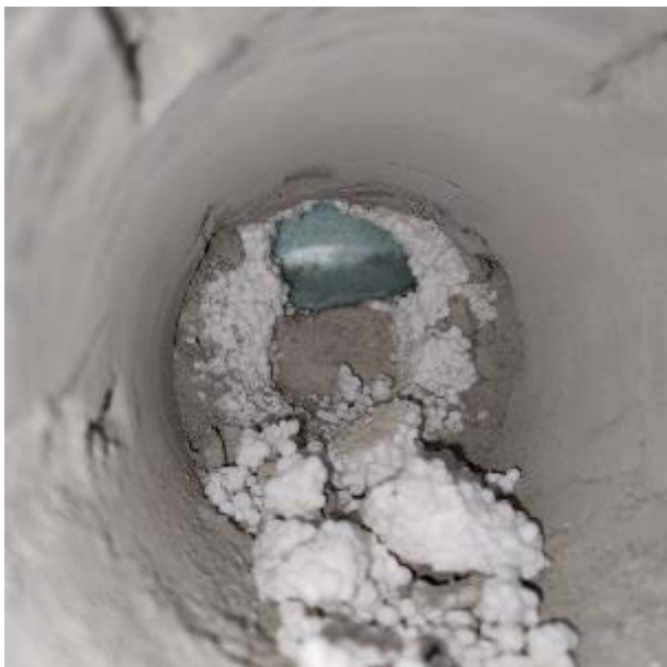
Kuva 35. Rakenneavauksesta näkyy seinän höyrynsulkumuovi ja sen kääntyminen ontelolaatan alapintaan. Kuva on avauksesta SK1.2 tilan 104 kohdalla.
