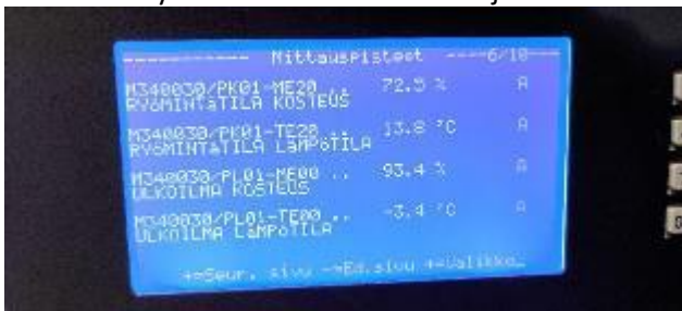
Kuva 115. Ryömintätilan olosuhteet.
