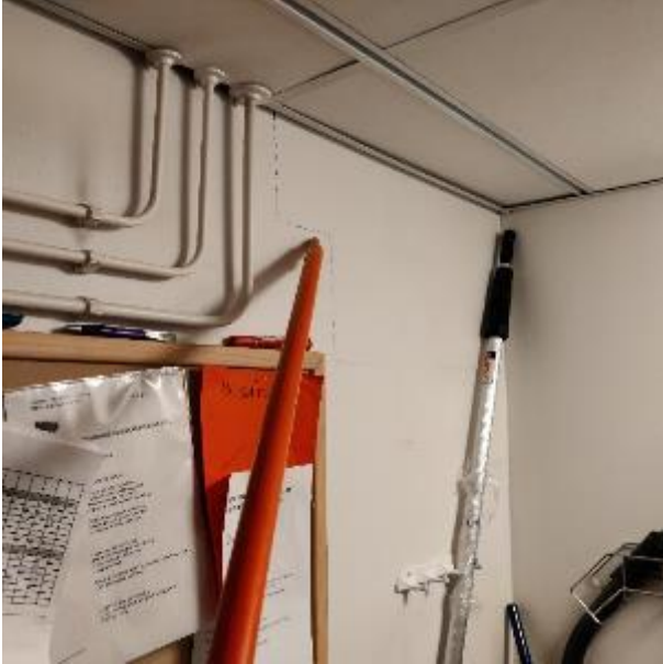
Kuva 43. AP1 ryömintätilan kautta merkkiainetta kulkeutui myös tilan 126 tiiliväliseinän halkeamien kautta sisäilmaan.
