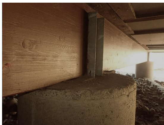
Kuva 7. Ryömintätalallinen osa rakennusta sijaitsee rakennuksen länsipäädyssä ja on perustettu betonipilareiden varaan. Betonipilareiden ja kantavien liimapuupalkkien välissä on bitumikermikaista.
