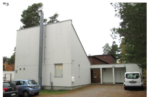
Kuva 2. Öljykattilan savupiippu ja öljysäiliön täyttöputki rakennuksen itäpäädyssä.
