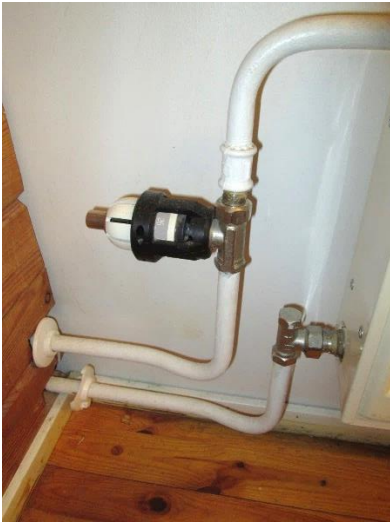
Kuva 7. Termostaatin säätöasento lukittu.
