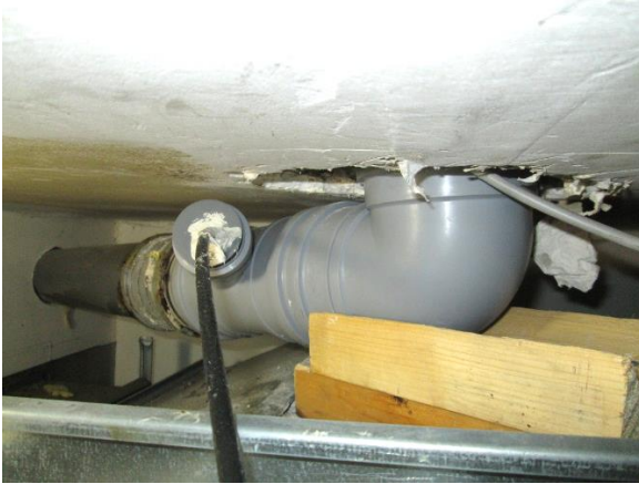
Kuva 51. IV-konehuoneen vesikatolla on vain yksi kattokaivo. Tätä kaivoa ja sadevesiviemäriä ei ole esitetty LVI-suunnitelmissa.
