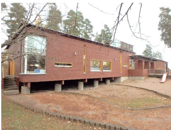
Kuva 7. Ryömintätalallinen osa rakennusta sijaitsee rakennuksen länsipäädyssä ja on perustettu betonipilareiden varaan. Betonipilareiden ja kantavien liimapuupalkkien välissä on bitumikermikaista.
