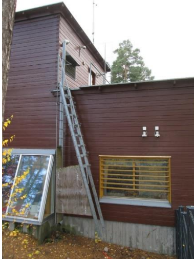
Kuva 11. Kulkureitti iv-konehuoneeseen. Tikkaan alaosa on poistettu kaide ja askelmat.
