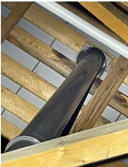
Kuva 35. Keittiön yläpuoleisesta yläpohjatilasta. Yläpohjan läpiviennin kohdalla puurakenteissa havaittiin kosteusjälkiä. Samalla kohtaa havaittiin kulkusillalla kosteusjälkiä.
