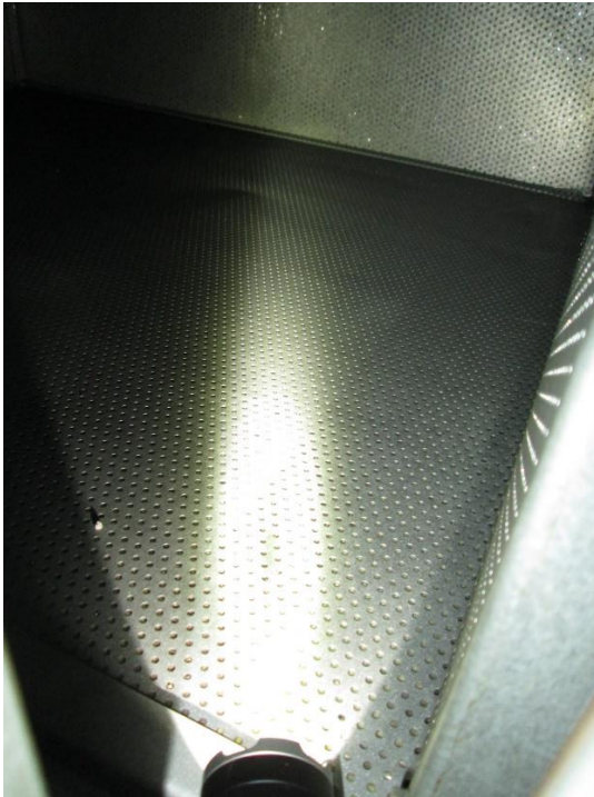
Kuva 26. TK1 tuloilmakammion sisäpinnoilla on reikäpellillä ja ohuella muovikalvolla päällystetty ÄV-verhous.
