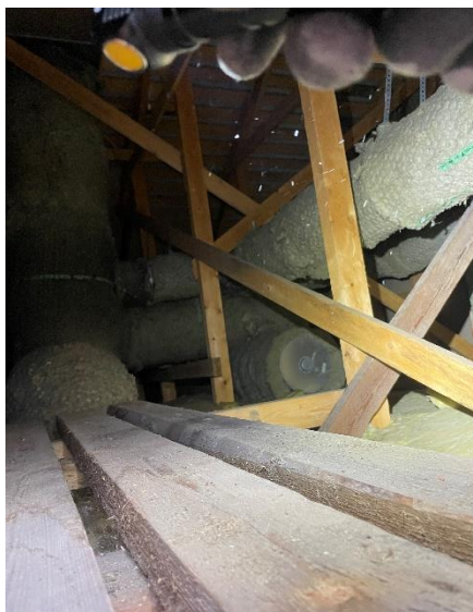
Kuva 35. Keittiön yläpuoleisesta yläpohjatilasta. Yläpohjan läpiviennin kohdalla puurakenteissa havaittiin kosteusjälkiä. Samalla kohtaa havaittiin kulkusillalla kosteusjälkiä.
