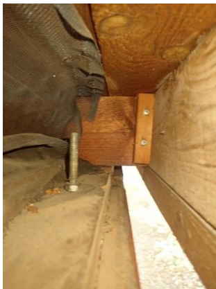
Kuva 45. Räystäään hyönteisverkossa on paikoin aukkoja, joista pieneläimet voivat päästä yläpohjatilaan.
