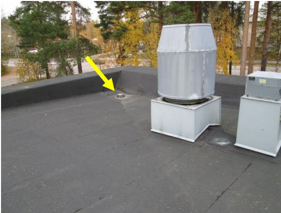
Kuva 51. IV-konehuoneen vesikatolla on vain yksi kattokaivo. Tätä kaivoa ja sadevesiviemäriä ei ole esitetty LVI-suunnitelmissa.
