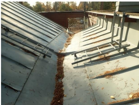
Kuva 46. Peltikateosan kattokaivoissa ei ole roskasihtejä ja kaivot ovat peittyneet havuista.
