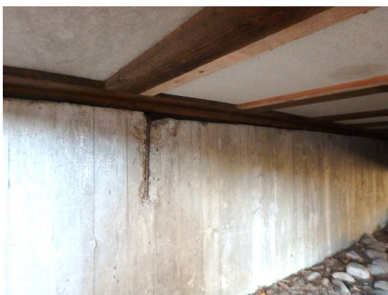
Kuva 8. Ryömintätalallinen osa rakennusta lähtee maanvaraisen osan sokkelin päältä. Sokkelin päällä on bitumikermikaista. Sokkelissa havaittiin yksittäinen paljas sokkeliteräs.
