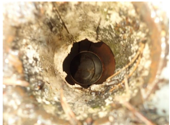
Kuva 46. Peltikateosan kattokaivoissa ei ole roskasihtejä ja kaivot ovat peittyneet havuista.
