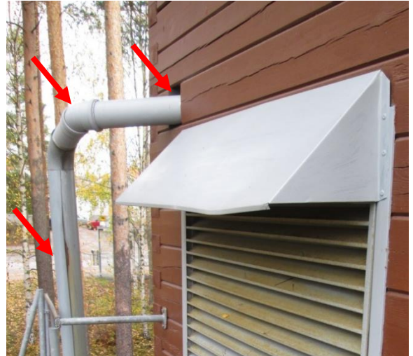
Kuva 54. IV-konehuoneen vesikaton sadevesiviemäri rakennuksen ulkoseinällä.
