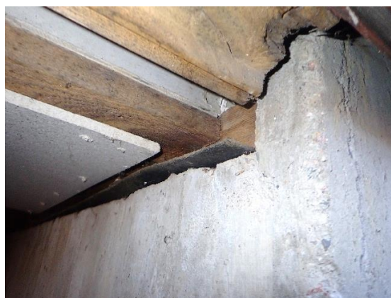
Kuva 8. Ryömintätalallinen osa rakennusta lähtee maanvaraisen osan sokkelin päältä. Sokkelin päällä on bitumikermikaista. Sokkelissa havaittiin yksittäinen paljas sokkeliteräs.
