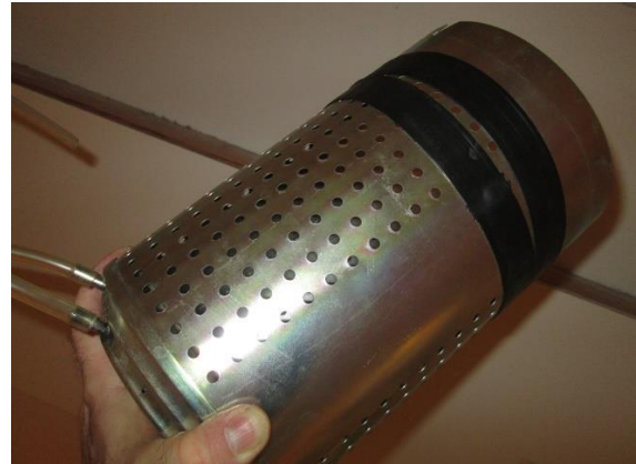
Kuva 50. Tilan 08 tuloilmalaitteiden säätöosassa 4/15 suutinriviä suljettuna.
