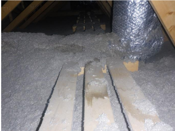
Kuva 18. Kosteusjälkiä lautojen pinnoilla ja puhallusvillassa.
