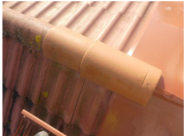
Kuva 21. Irrallisia kattotiiliä kattotikkaiden läheisyydessä.
