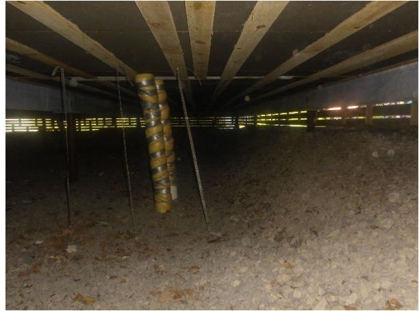
Kuva 9. Ryömintätila on hyvin tuulettuva ja siisti.
