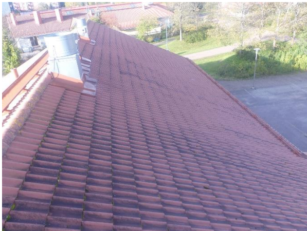
Kuva 20. Vesikaton tiilikatteessa likaa ja sammalkasvustoa.
