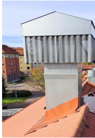
Kuva 38. TK1 raitisilmanottokatos vesikatolla. Raitisilmakatokseen on asennettu jälkikäteen erillinen katos.
