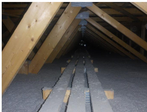
Kuva 15. Yläpohjan lämmöneristeenä on käytetty puhallusvillaa.
