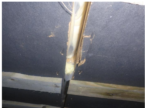
Kuva 13. Mineraalivilla tummentunut elementtisauman kohdalla.
