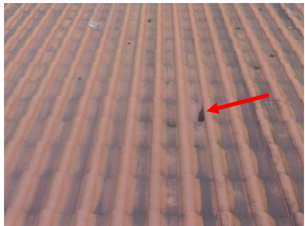
Kuva 21. Irrallisia kattotiiliä kattotikkaiden läheisyydessä.
