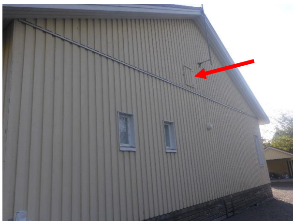
Kuva 14. Yläpohjatilaan oli kulku seinän yläosassa olevien luukkujen kautta.
