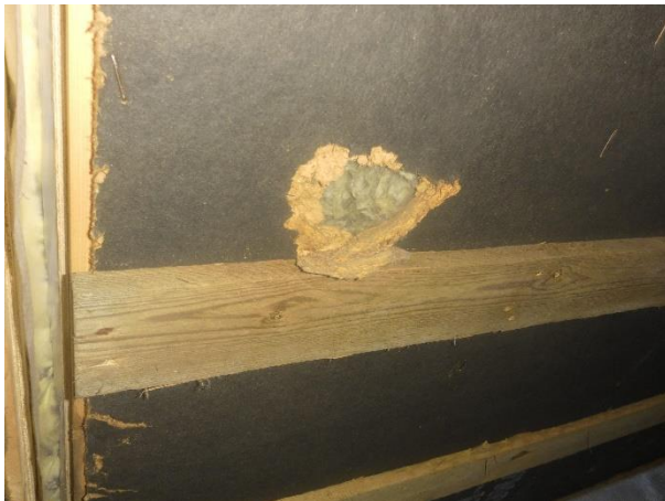
Kuva 10. Alapohjan alapinnassa on reikä
