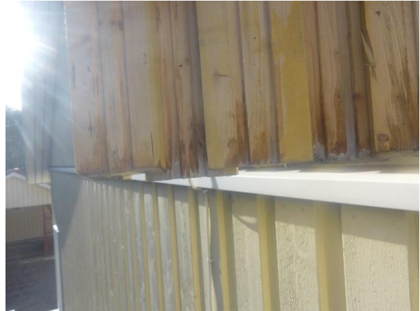
Kuva 19. Kosteusjälkiä kulkuluukun alareunassa.
