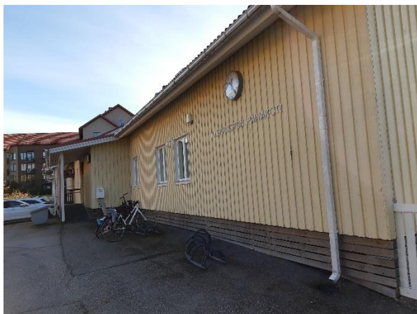
Kuva 6. Julkisivulaudoitus on pääosin puhdas ja hyväkuntoinen.
