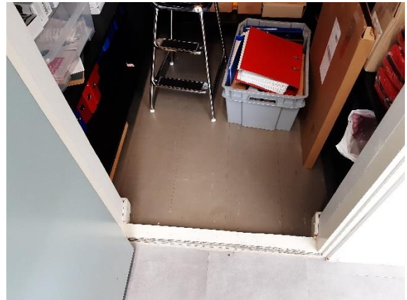
Kuva 32. Varasto 225:ssä on alkuperäinen vinyylilattia.
