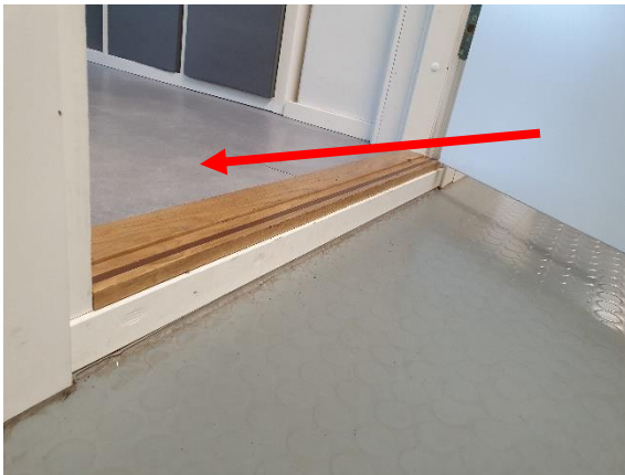
Kuva 29. Luokkatilojen lattiapäällysteet on uusittu.
