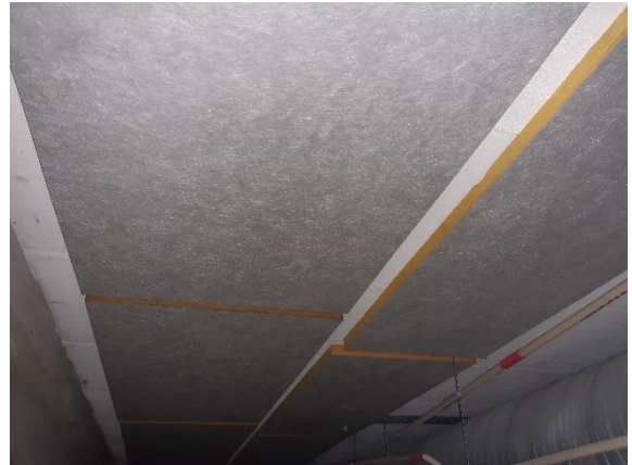
Kuva 41. Käytävällä 236 yläpohjan kevytbetonielementin alapintaan on asennettu akustolevy
