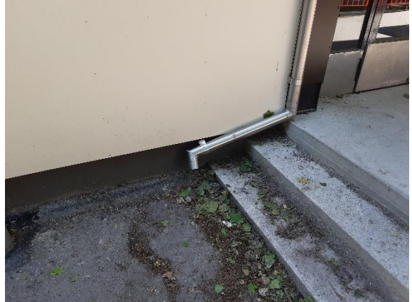
Kuva 45. Katoksen vedenpoisto on toteutettu syöksytorvella.
