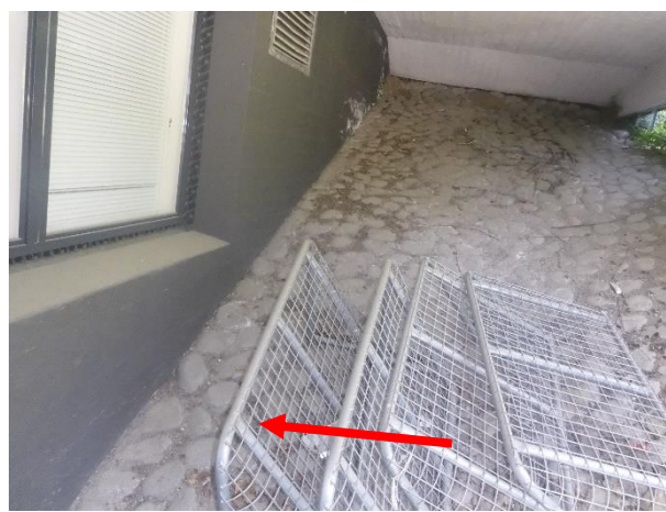
Kuva 2. Rakenneavaus tehtiin maanpinnan alapuoliselle osalle.
