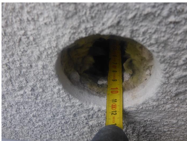
Kuva 11. RA-US7:n kohdalla mineraalivillan paksuus on n. 100 mm.
