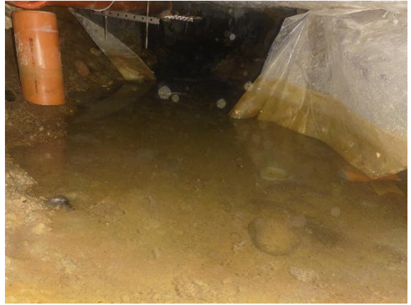
Kuva 6. Ryömintätilassa lammitettu vettä.
