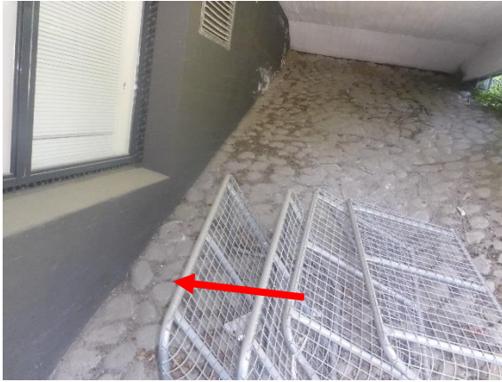
Kuva 21. Rakenneavaus RA-US1 on tehty maanpinnan alapuolelle.
