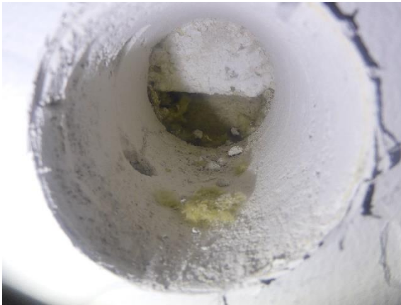
Kuva 23. Rakenneavaus RA-US11 on tehty sokkelin korkeudelle. Eristekerroksena EPS-eristettä ja mineraalivillaa.
