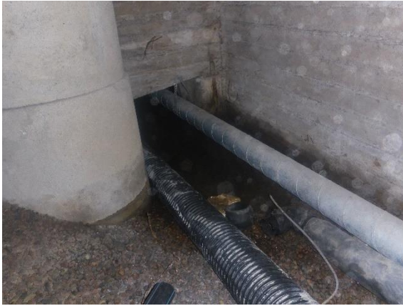
Kuva 5. Ryömintätilan reunaan lammitettu vettä.
