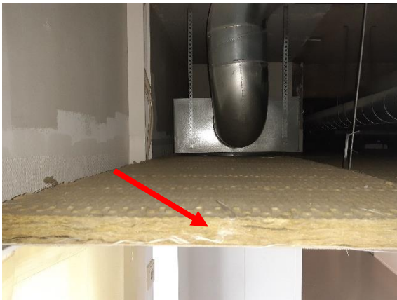
Kuva 42. Laskettujen alakattojen kattolevyt ovat sivuista ja yläpinnasta paljasta mineraalivillaa. Paljas leikkuspinta.
