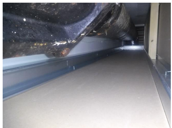
Kuva 36. Kotelon kipsilevyjen pinnoilla ei havaittu kosteusjälkiä.
