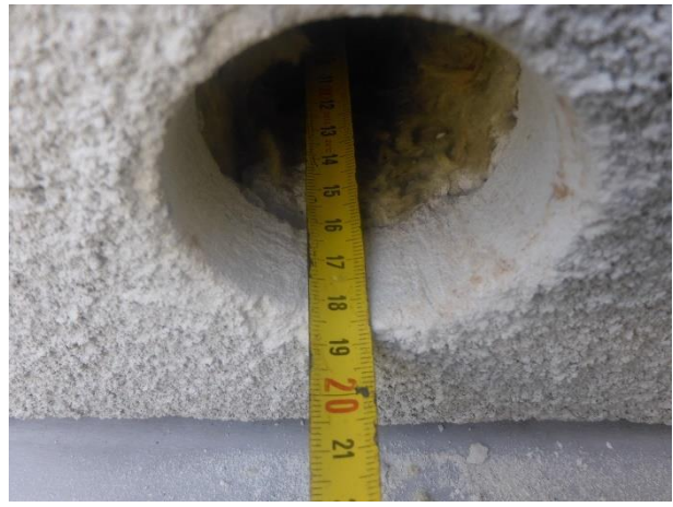
Kuva 10. RA-US5:n kohdalla mineraalivillakerros on paksumpi
