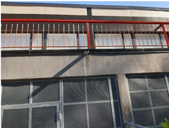
Kuva 50. Terassin vedenpoiston kohdalla valumajälkiä ulkoseinässä.
