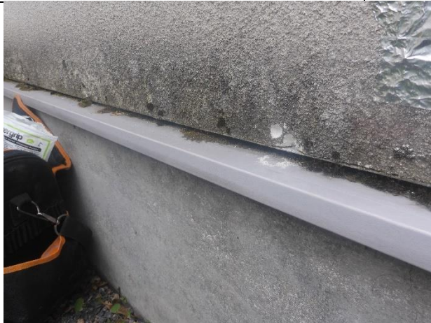
Kuva 7. Rappauskerroksen alapuolelle on kertynyt sammalkasvustoa.
