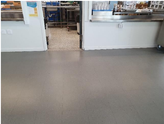
Kuva 31. Ruokalan lattiapäällysteenä on linoleumilaatta ja keittiössä akryylibetonit.
