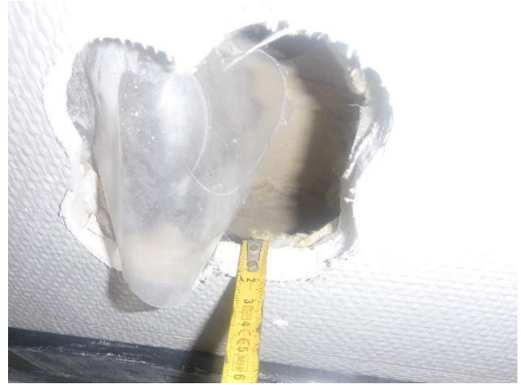
Kuva 22. Rakenneavaus RA-US1 ulotettiin kevytbetonikerrokseen.
