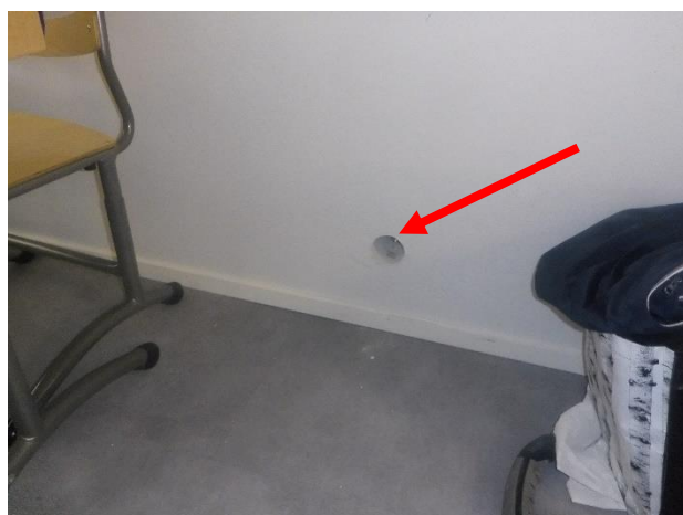
Kuva 12. Rakenneavaus tehtiin taukotilan ulkoseinän alareunaan.
