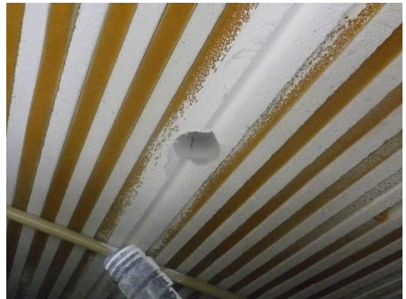
Kuva 43. Yläpohjan kevytbetonielementin kuntoa tutkittiin rakenneavauksin.
