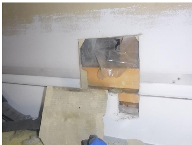
Kuva 18. Rakennus tehtiin ulkoseinään käytävän alaslasketun katon yläpuolelle.
