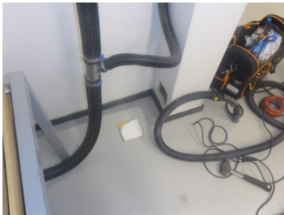
Kuva 33. Teknisen työn tilan putkikotelo avattiin alareunasta.
