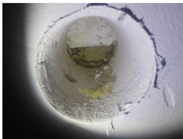
Kuva 13. Sokkelin eristeenä on käytetty mineraalivillaa ja yläpuolella EPS-eristettä.
