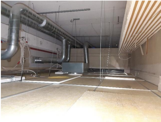
Kuva 40. Laskettujen alakattojen yläpuolinen tila on pääosin puhdas.
