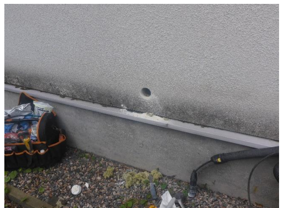
Kuva 26. RA-US4 tehtiin rapatun julkisivun alareunaan.
