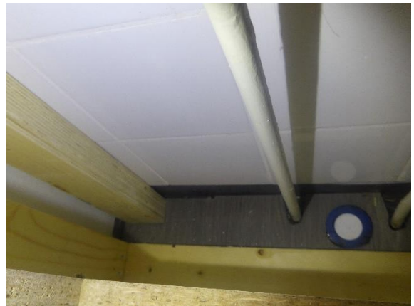
Kuva 38. Kirjavarasto 226:n kotelon sisäpinnoilla ei havaittu kosteusjälkiä.
