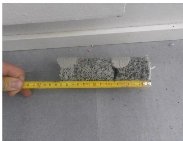
Kuva 17. Ulkoseinän sisäkuorena on maalattu kevytsojarahkko.
