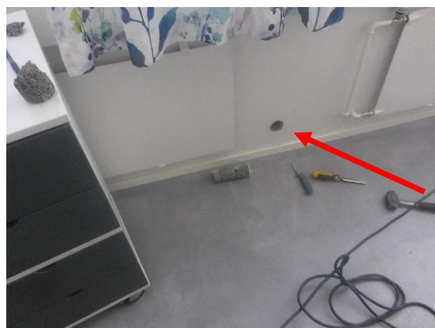
Kuva 16. Rakenneavaus tehtiin opetustilan ulkoseinän alareunaan.
