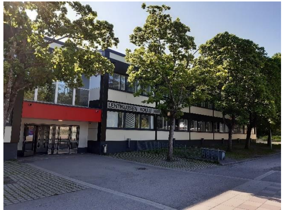
Kuva 47. Ulkoseinän vieressä on suuria lehtipuita.
