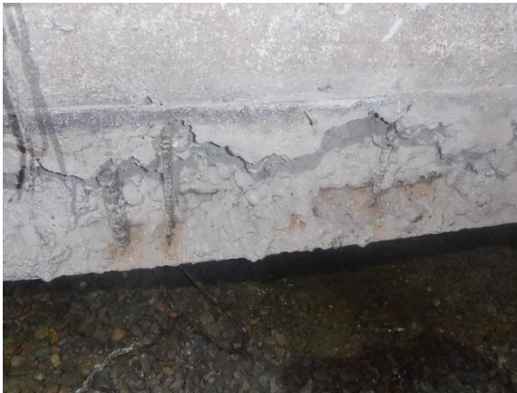
Kuva 7. Palkin harvavalua, jossa hakate-räkset esillä ja korroosiotilassa.
