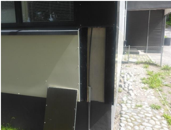
Kuva 17. Julkisivulevyjä irrotettiin rakennuksen eri puolilta.
