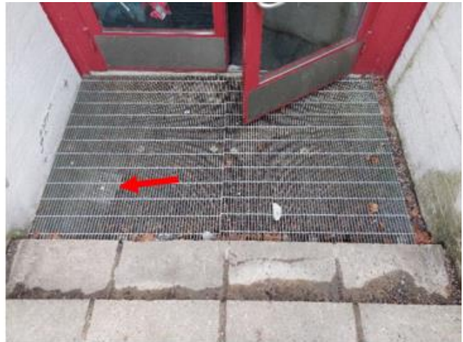
Kuvat 7 a ja b. Itäsivulla on porrassyvennys, jonka pohjalla on kaivo syvennykseen kulkeutuvan veden poistoon (punainen nuoli).
