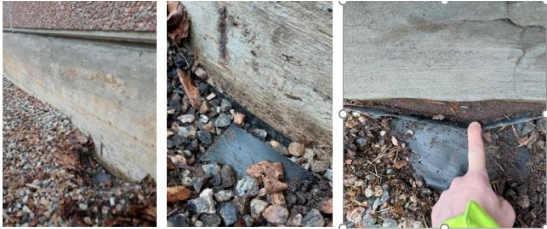
Kuvat 5 a...c. Perusmuurin ulkopinnalla havaittiin perusmuurilevy rakennuksen itäsivulla, reunalistaa ei havaittu (kuvat a ja b). Länsisivulla oli pohjoisen vastaisessa nurkassa näkyvissä muovikaista, joka vaikutti erotuskaistalta maa-ainesten välillä (kuva c).
