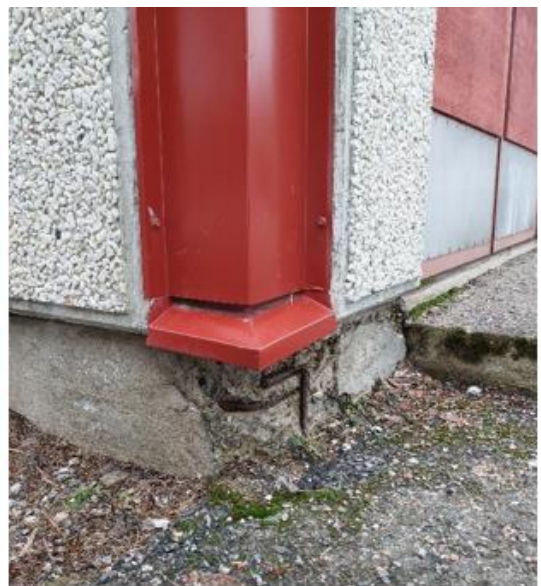
Kuvat 8 a ja b. Rakennuksen kattomuoto on tasakatto ja sadevedet on pääsääntöisesti johdettu kattokaivoihin. Itäsivulla yhden sisääntulokatoksen sadevedet on johdettu perusmuurin viereen asfaltille (punainen nuoli). Perusmuurissa havaittiin jonkin verran rapautumaa ja näillä kohdin esiin tulleita raudoitteita. Erityisesti rakennuksen nurkissa pellitys on ohjannut vesiä perusmuuriin ja näillä kohdin havaittiin systemaattisesti vaurioita (kuva b).
