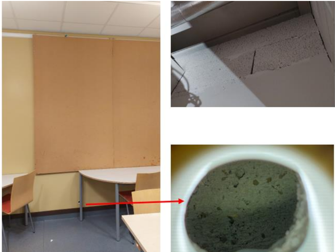
Kuva 21 a...c. C-osalla ns. laajennusosalla on paikoin harkkokuorimuuraus maanvastaisen seinän sisäpuolelle. Harkko- ja betoniseinän väliin on jätetty rako, joka tuulettuu seinän alaosassa olevien venttiilien sekä auki olevan yläosan kautta.
