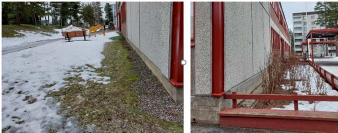
Kuvat 4 a ja b. Piha-alueiden pintakallistukset olivat pääosin melko tasaisia tai loivasti rakennuksesta poispäin, mutta pohjois-itänurkassa (kuva a) ja itäsivulla (kuva b) kallistukset olivat rakennukseen päin. Sokkeli on matala ja lattian yläpinta on lähellä maanpinnan tasoa.
