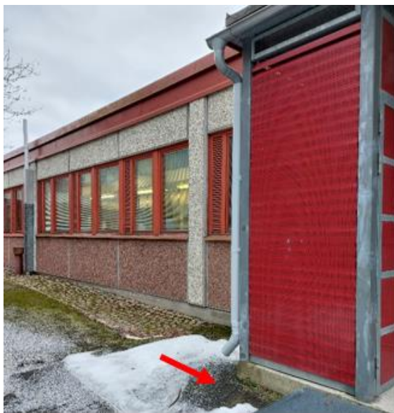
Kuvat 8 a ja b. Rakennuksen kattomuoto on tasakatto ja sadevedet on pääsääntöisesti johdettu kattokaivoihin. Itäsivulla yhden sisääntulokatoksen sadevedet on johdettu perusmuurin viereen asfaltille (punainen nuoli). Perusmuurissa havaittiin jonkin verran rapautumaa ja näillä kohdin esiin tulleita raudoitteita. Erityisesti rakennuksen nurkissa pellitys on ohjannut vesiä perusmuuriin ja näillä kohdin havaittiin systemaattisesti vaurioita (kuva b).
