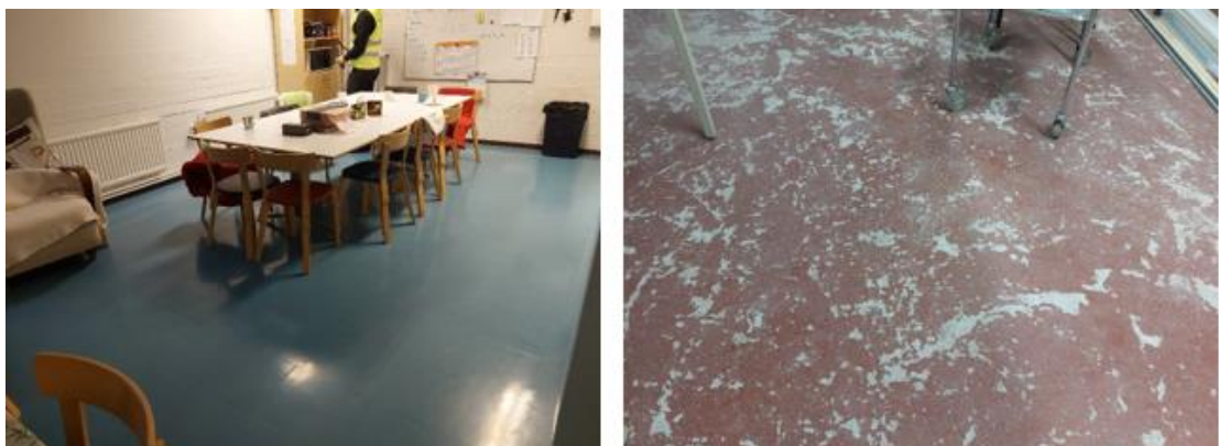
Kuvat 15 a ja b. Paikoin tiloissa on vanhoja lattiapäällysteitä, jotka ovat pääsääntöisesti pinnoistaan kuluneita.
