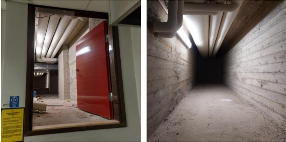
Kuva 23 a ja b. Putkikanaaliin on kulku tilasta 1040. Kanaalin lattia, katto ja seinät ovat betonipinnalla. Betonissa oli seinällä jäämiä muottilaudoituksesta.
