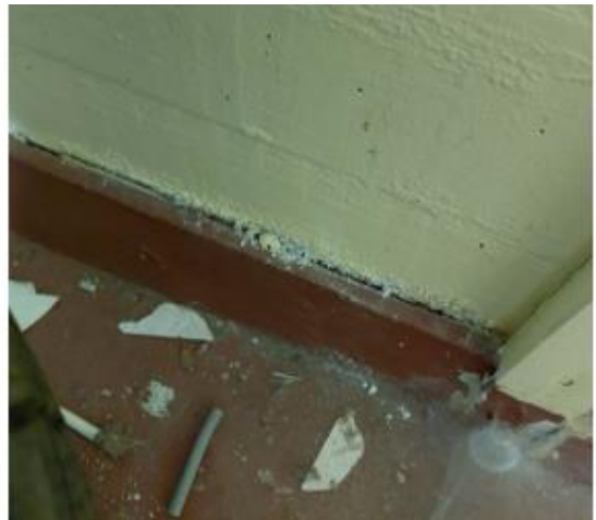
Kuva 20 a ja b. Seinien alaosissa havaittiin paikoin maalipinnan hilseilyä,
