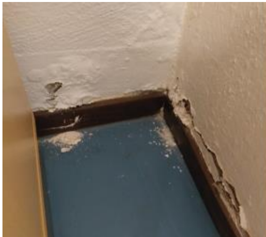
Kuva 20 a ja b. Seinien alaosissa havaittiin paikoin maalipinnan hilseilyä,
