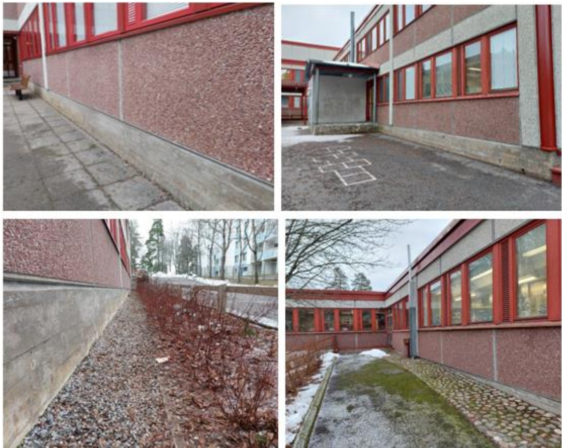
Kuvat 2 a...d. Rakennuksen perusmuurin vierustan pintamateriaali on pääosin joko a) betonilaatta, b) asfaltti, c) sepeli tai d) kiveys.
