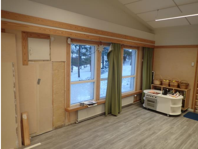
Kuvat 31 ja 32. Lepohuoneen 52 (01.35) rakennuskuva (RA8). Alaohjauspuun päältä otettu mineraalivillaaeristeenäyte oli mikrobiologisesti kunnossa. Ulkoseinän julkisivulaudoituksen alaosa oli kostea (23-25 p%).
