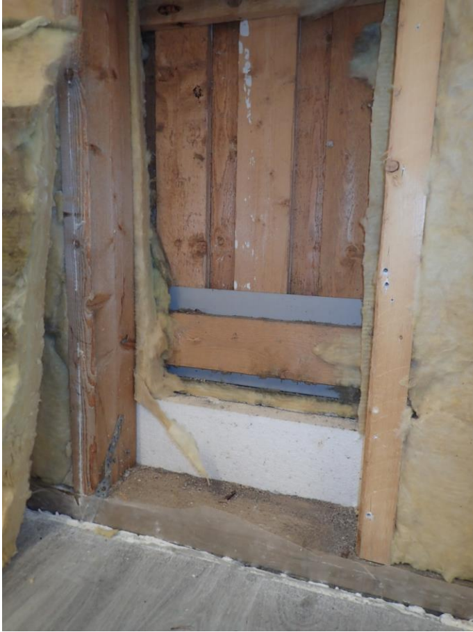
Kuvat 39 ja 40. Ryhmähuoneen 32 rakenneavauksessa (RA14) ei todettu vauriojälkiä runkorakenteissa eikä ikkunarakenteen apukarmin pinnoissa (kuva 40).
