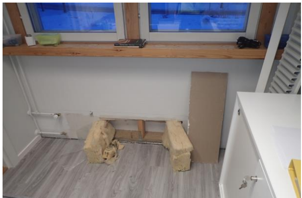
Kuvat 41, 42 ja 43. Lepohuoneiden 28 (01.22) ja 02 (01.15) sekä toimistohuoneen 17 (01.08) rakenneavauksissa (RA20, RA1, RA6) ei myöskään tehty poikkeavia aistinvaraisia havaintoja. Eristevillanäytteet olivat myös mikrobiologisesti kunnossa.
