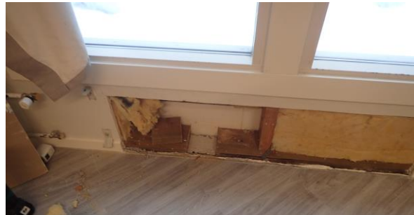
Kuvat 39 ja 40. Ryhmähuoneen 32 rakenneavauksessa (RA14) ei todettu vauriojälkiä runkorakenteissa eikä ikkunarakenteen apukarmin pinnoissa (kuva 40).
