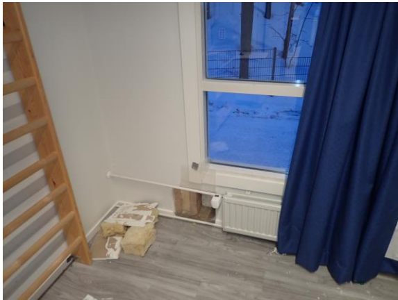
Kuvat 41, 42 ja 43. Lepohuoneiden 28 (01.22) ja 02 (01.15) sekä toimistohuoneen 17 (01.08) rakenneavauksissa (RA20, RA1, RA6) ei myöskään tehty poikkeavia aistinvaraisia havaintoja. Eristevillanäytteet olivat myös mikrobiologisesti kunnossa.
