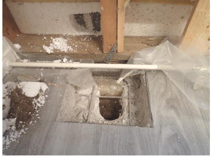
Kuvat 36 ja 37. Pihan puolella ”matalan sokkelirakenteen alueelle” toinen alapohjarakenteen rakenneavaus ja kolmas ulkoseinärakenteen rakenneavaus (RA12) tehtiin ryhmähuoneeseen 39 (01.24). EPS-eristeen pinnoilla todettiin mikrobikasvustoa, mutta muut näytteet kuten valusuoja olivat ns. puhtaita.
