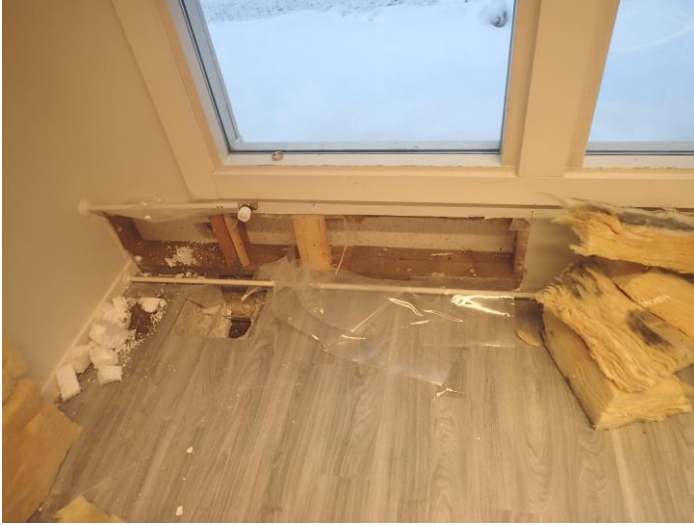
Kuvat 36 ja 37. Pihan puolella ”matalan sokkelirakenteen alueelle” toinen alapohjarakenteen rakenneavaus ja kolmas ulkoseinärakenteen rakenneavaus (RA12) tehtiin ryhmähuoneeseen 39 (01.24). EPS-eristeen pinnoilla todettiin mikrobikasvustoa, mutta muut näytteet kuten valusuoja olivat ns. puhtaita.
