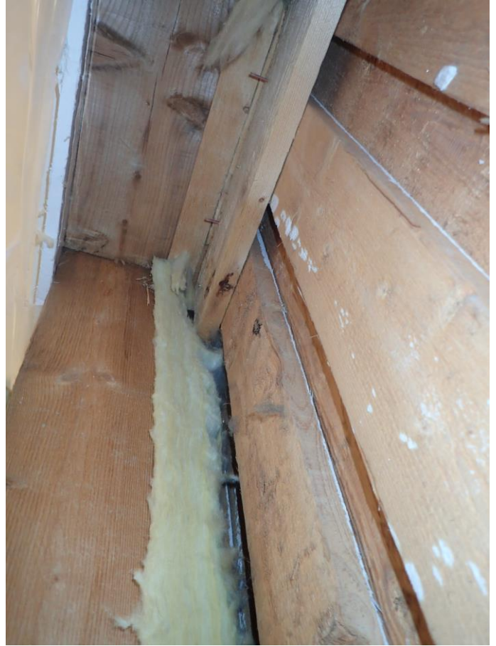
Kuvat 39 ja 40. Ryhmähuoneen 32 rakenneavauksessa (RA14) ei todettu vauriojälkiä runkorakenteissa eikä ikkunarakenteen apukarmin pinnoissa (kuva 40).
