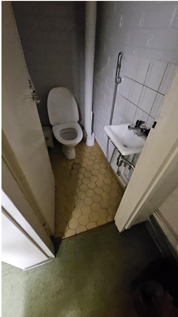
Kuva 9. A-osa. Alkuperäinen wc-tila. Laatoituksessa on käytön jälkiä ja se on ikääntynyt.
