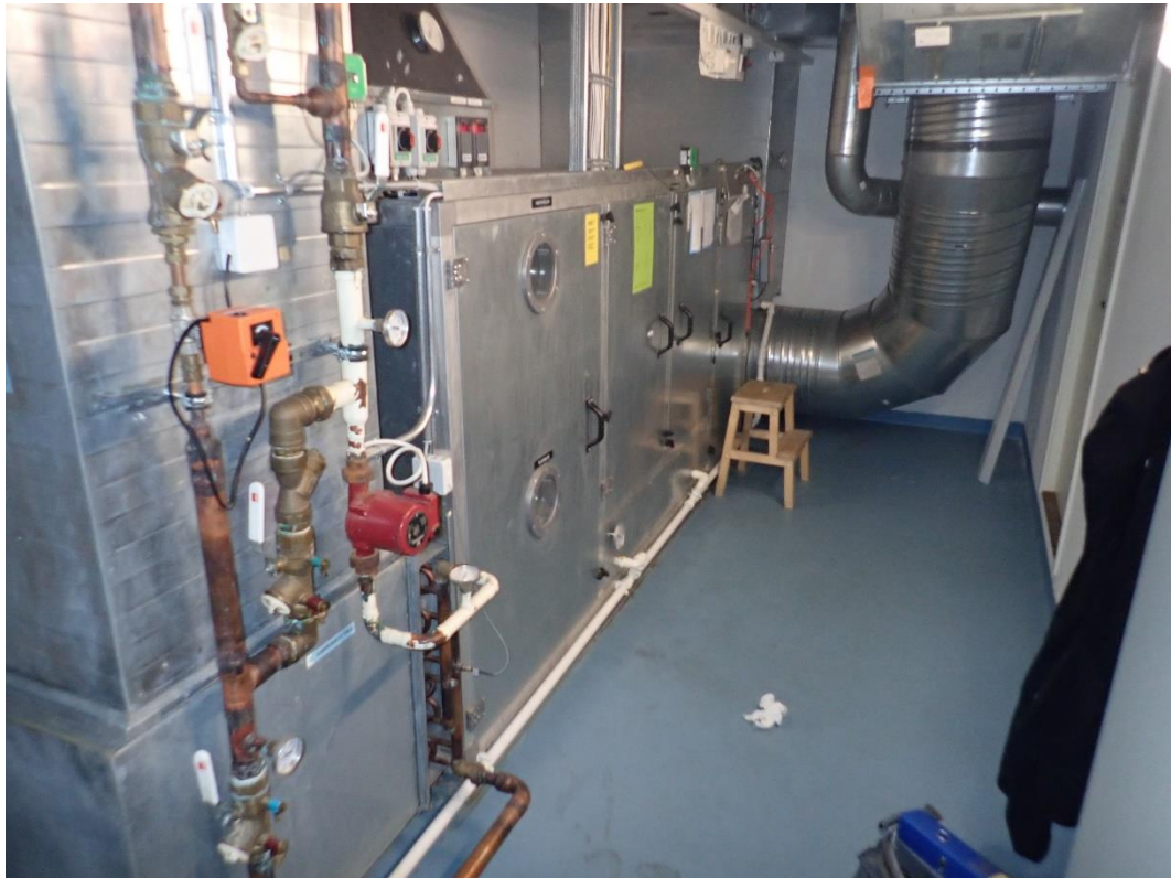
Kuva 32. Paviljonkirakennus. Ilmanvaihtokonehuoneessa lattiapäällysteenä on märkätilamuovimatto, jossa on seinille noin 10 cm ylösnostot. Tilassa oli lattiakaivo.
