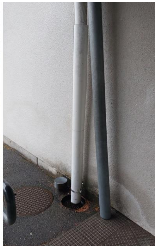
Kuva 6. Syöksytorvista roiskuva vesi kastelee sokkelia ja julkisivu. Kuvat: a) B-osa, b) C-osa.
