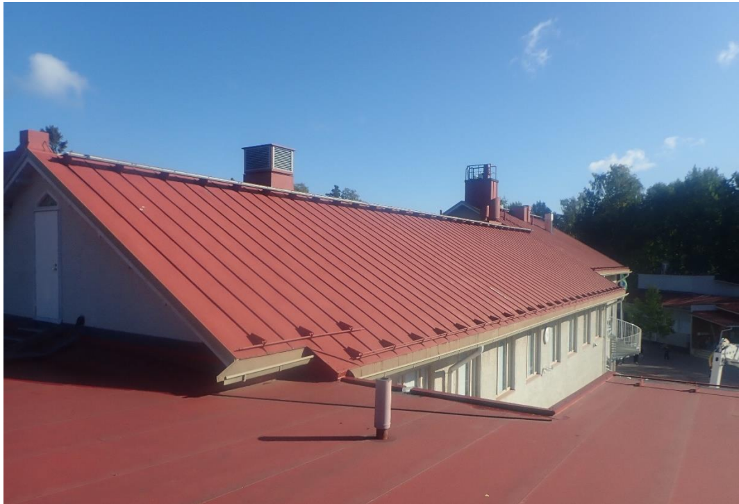
Kuva 38. B-osa. Vesikattona on jyrkkä saumattu peltikate. Räystäällä on pystysaumoihin puristuskiinnityksellä asennetut lumiesteet.
