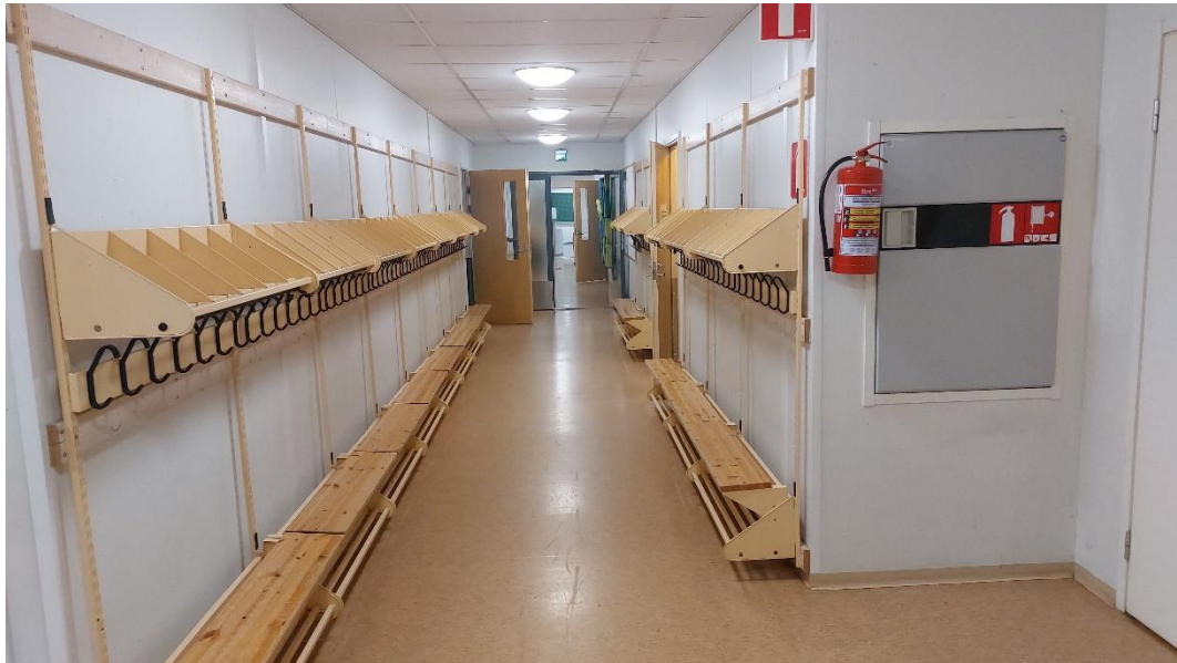
Kuva 14. Paviljonkirakennus. Yleiskuva käytävältä. Pintamateriaalit olivat yleisilmeeltään siistit, paikoin käytön aiheuttamaa normaalia kulumaa.
