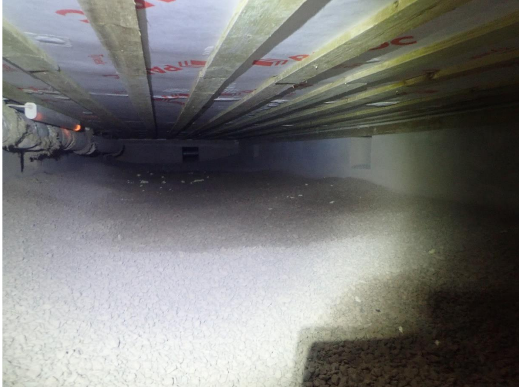
Kuva 27. Paviljonkirakennus. Yleiskuva. Sora paikoin tummaa/kosteata. Veden lammikoitumista ei havaittu. Laudoituksessa ei havaittu viitteitä haitallisesta kosteudesta.
