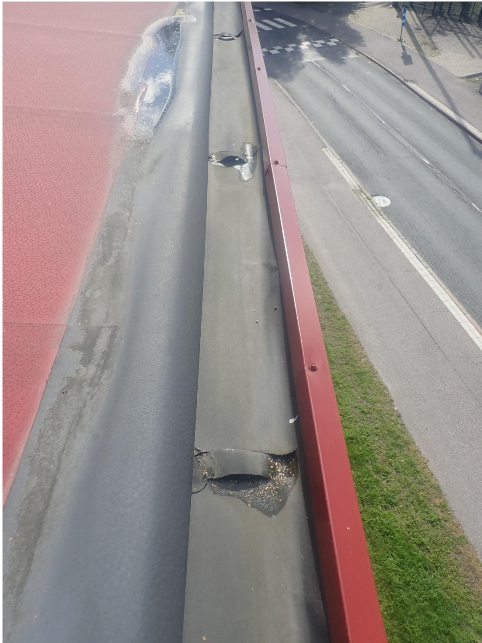
Kuva 45. A-osa. PVC-katteessa havaittiin vähäistä veden lammikoitumista räystäällä. Räystäskouruissa pvc-kate oli revennyt useammasta kohdasta.
