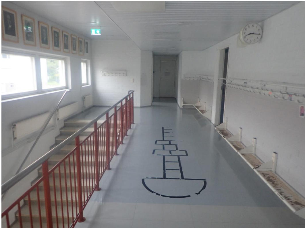
Kuva 31. C-osa, 2. kerros. Yleiskuva käytävältä. Pintamateriaalit olivat paikoin kuluneet, mutta yleisilmeeltään vielä siistit.
