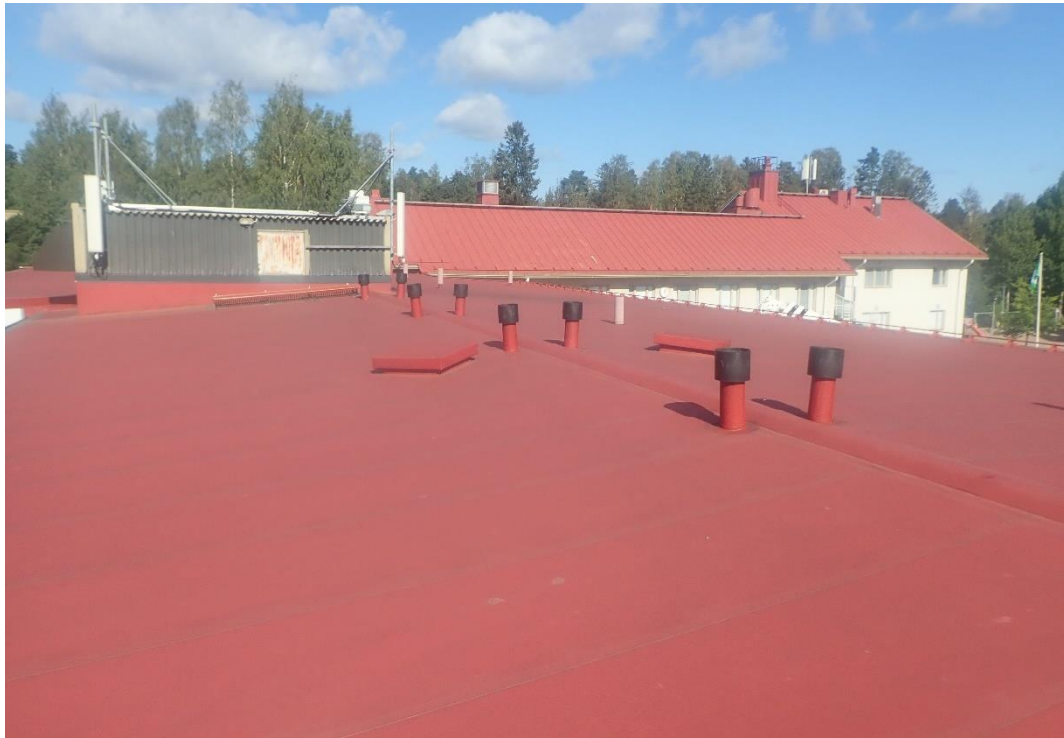
Kuva 41. A-osa. Vesikatteena on yksikerroksinen PVC-kate. Harjalla on alipainetuulettimet.
