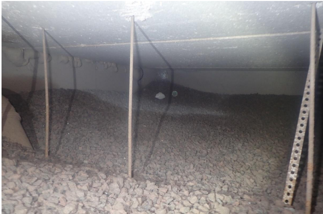
Kuva 24. Tarkastusluukku L6. Ryömintätila on yleisilmeeltään siisti. Sepelöinti oli monin paikoin tummaa/kostea. Veden lammikoitumista ei havaittu.
