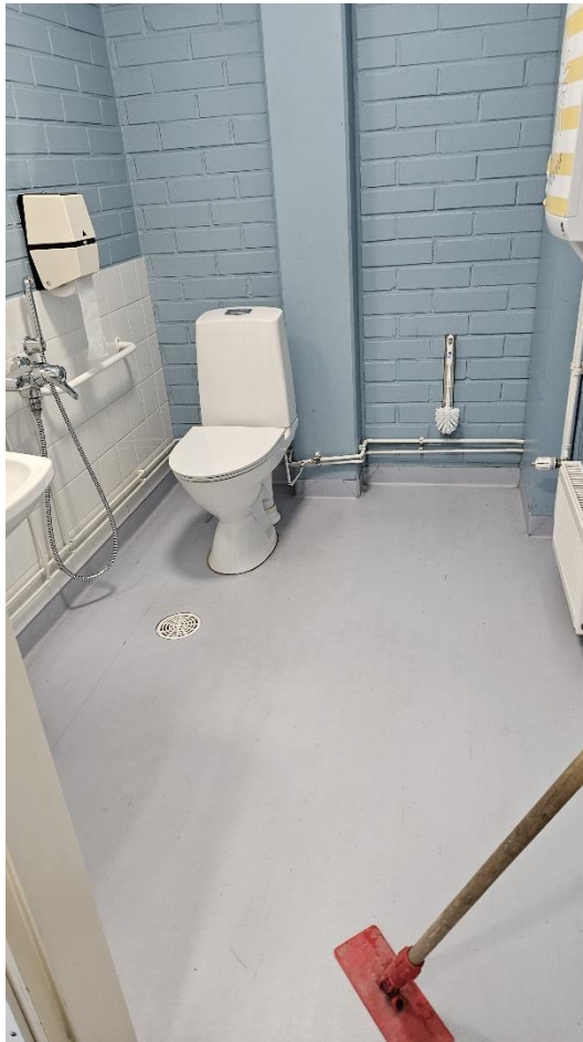
Kuva 12. C-osa. Yleiskuva wc-tilasta. Tilassa on lattiakaivo.
