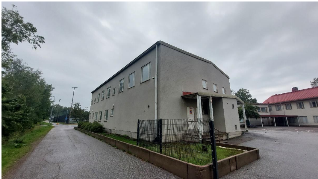
Kuva 3. C-osa. Rakennuksen sokkelin vieressä ei havaittu sepelikaistaa. sokkeli on kuitenkin varsin korkea.
