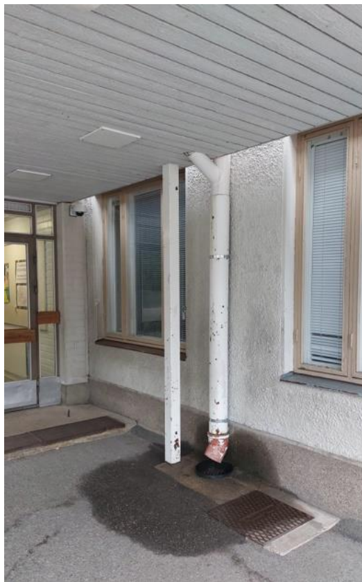
Kuva 6. Syöksytorvista roiskuva vesi kastelee sokkelia ja julkisivu. Kuvat: a) B-osa, b) C-osa.
