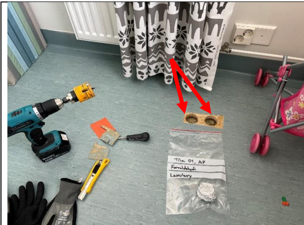
Kuva 10. Tila 01 lastulevynäytteen ottokohta.
