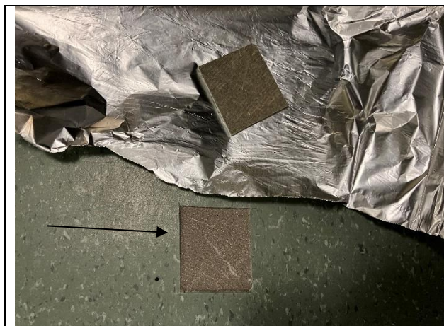
Kuva 16. Tila 2.092 näytteen MVOC 1 ottokohta.
