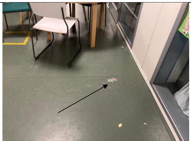
Kuva 17. Tila 2.046 näytteen MVOC 2 ottokohta
