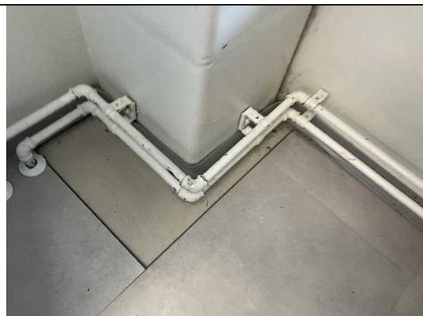
Kuva 6. Tilan 2.088 lattian päällysteen taustan tarkastuskohta. Vinyylilankun alla on tasoite.
