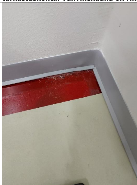
Kuva 9. Tilan 2.051 lattian päällysteen taustan tarkastuskohta. Ei poikkeavaa.
