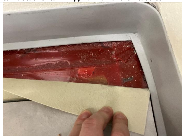
Kuva 8. Tilan 2.040 lattian päällysteen taustan tarkastuskohta. Ei poikkeavaa.
