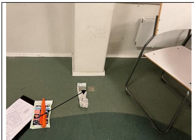
Kuva 18. Tila 2.036 näytteen MVOC 3 ottokohta.
