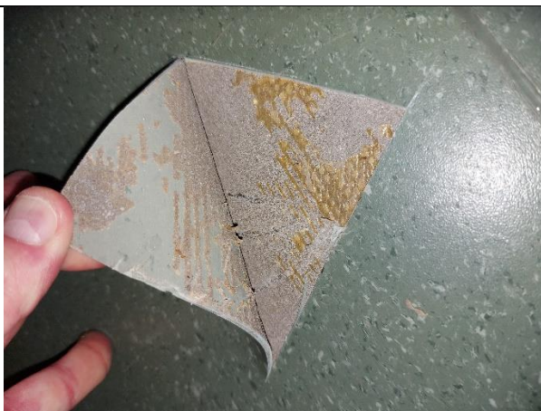
Kuva 9. Tilan 2.071 (VM7) muovimaton liimakerros. Muovimaton alla voimakas liiman haju.
