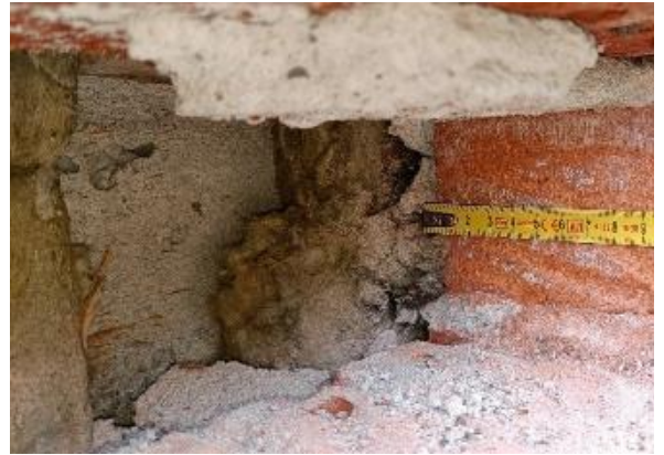
Kuva 94 Leukapalkin yläpuolella olevan tiilimuurauksen takana on mineraalivillaeriste.
