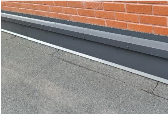
Kuva 161 Uudisosan ulkoseinälle tehty ylösnosto on asianmukainen.
