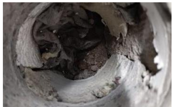
Kuva 59 Rakenneavauksen AP4 perusteella alapohjarakenteet on uusittu rakennesuunnitelmien mukaisesti.
