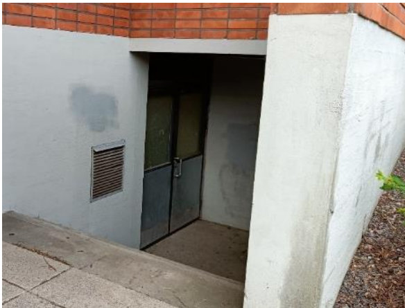
Kuva 174 Varaston B064 kohdalla ulkoseinässä on säleikkö.
