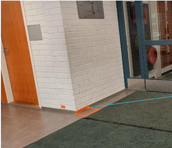
Kuva 54 Rakenneavaus AP2 käytävälle B035 kosteaksi todetun väliseinän (vanha ulkoseinälinja viereen).
