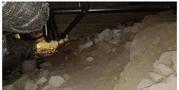
Kuva 63 Alkuperäinen ryömintätilallinen alapoh- jarakenne AP2.
