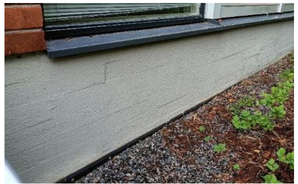
Kuva 85 Sokkeleihin on lisätty patolevyjä pohjois- ja itäjulkisivuille.
