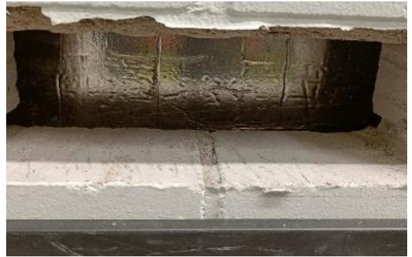
Kuva 118 Väliseinäksi laajennusosaa vasten jääneen vanhan maanpaineseinän lämmöneristeet on uusittu.
