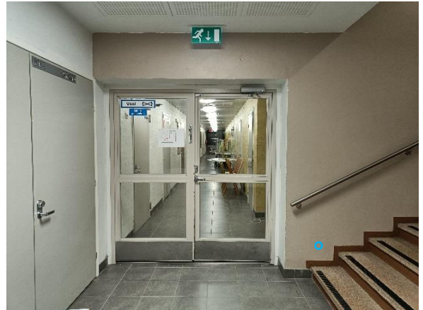
Kuva 133 Porrashuoneen B063 väliseinässä ei havaittu vuotokohtia (MA16) (kaasun-syöttöpiste ympyrän kohdalla seinän toisella puolella).
