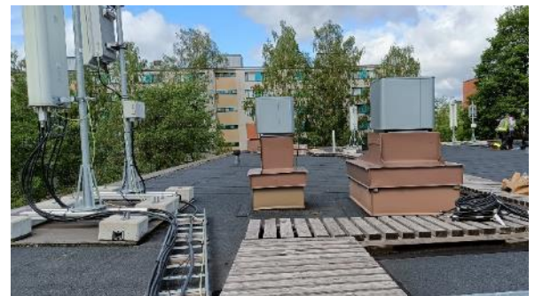
Kuva 147 Näkymä F-osan vesikatolle.
