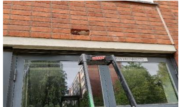
Kuva 90 Kuva Teknisen työn tilan kohdalle tehdystä rakenneavauksesta.
