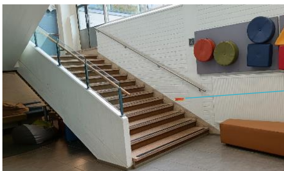
Kuva 21 Kuorimuurattu maanpaineseinä käytävällä B035 (rakenneavaus MP4).
