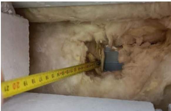
Kuva 91 Rakenneavaus peltipinnoitteisessa ulkoseinän osassa. Rakenneavausten perusteella peltiverhotut seinäosuudet on uusittu koko rakennuksen alueella.
