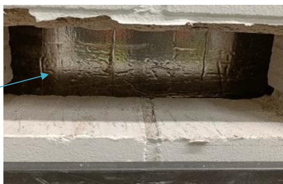
Kuva 24 Rakenneavauksen perusteella laajennusosaa vasten olevan seinäneristämateriaalit on uusittu ja korvattu XPS-eristeellä.
