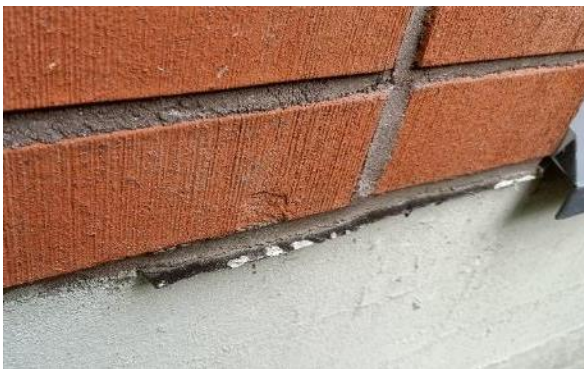
Kuva 84 Sokkelin ja ulkoseinän tiilimuurauksen välissä on bitumikermikaista.
