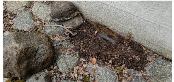
Kuva 26 Sisäpihan maanpaine seinässä on suunnitelmien mukaisesti lisätty patolevyt.
