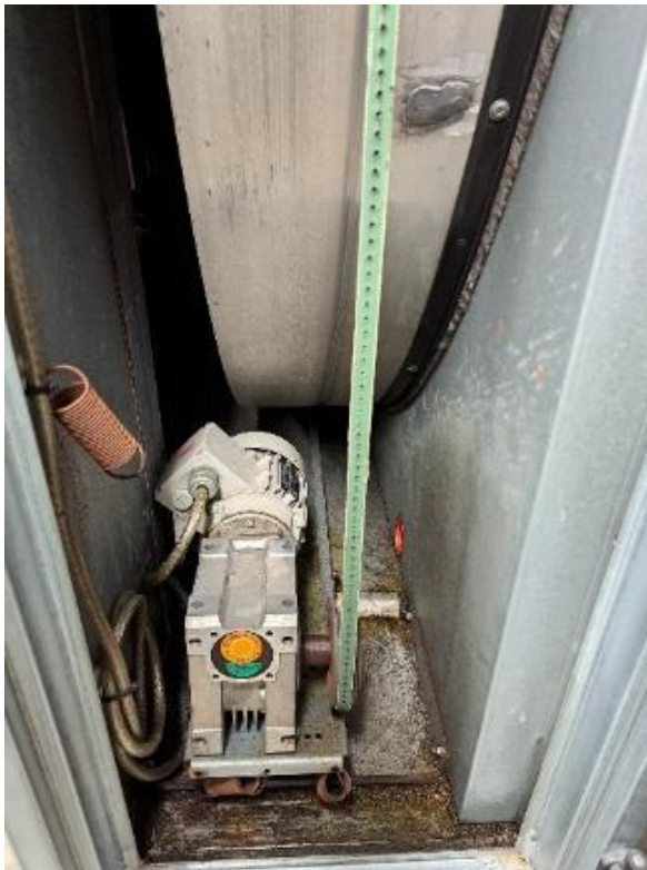
Kuva 193 Pyörivä lämmöntalteenottolaite koneessa TK06.
