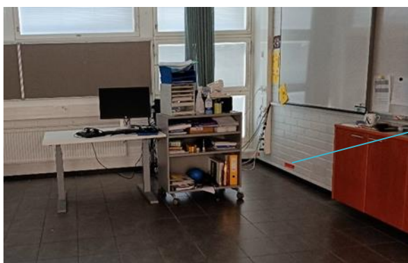
Kuva 23 Luokkatila B001. Rakenneavaus VS1 tehtiin laajennusosaa vasten olevaan, aiemmin maanvastaisena seinänä toimineeseen seinään.
