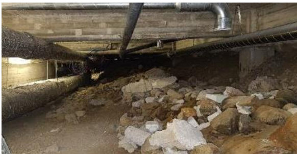
Kuva 62 Alkuperäinen ryömintätilallinen alapoh- jarakenne AP2.
