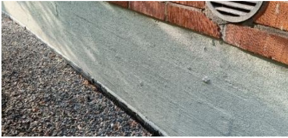
Kuva 25 F-osan maanpaine seinässä on patolevyt.
