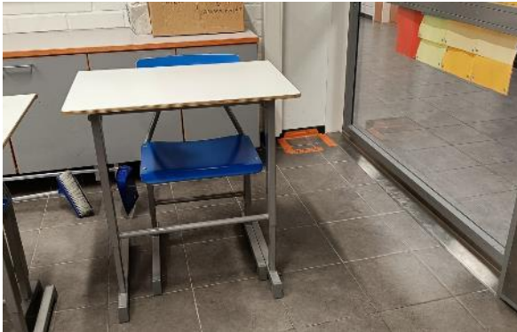
Kuva 60 Rakenneavauspiste AP5 opetusväli- nevarastossa B016.
