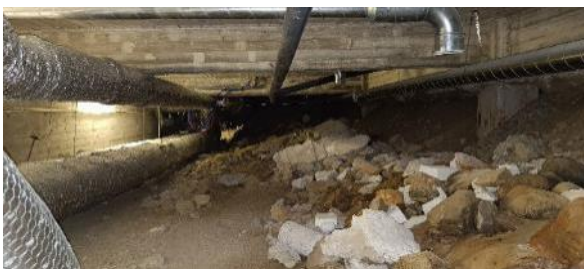
Kuva 167 Näkymä putkikanaaliin/ ryömintätilalliseen alapohjarakenteeseen.
