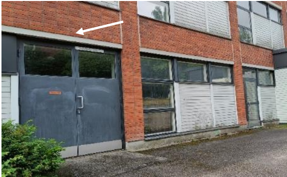
Kuva 89 Kaksi rakenneavausta tehtiin leukapalkkien yläpuolelle.
