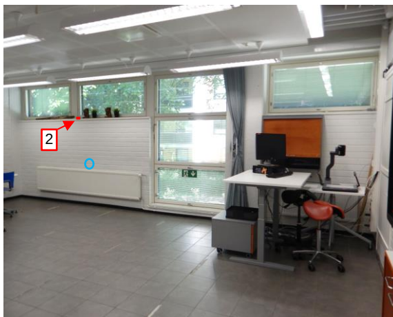
Kuva 97 Luokkahuoneen B038 ilmavuutopaikat (MA4).
