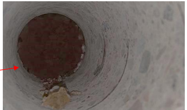
Kuva 18 Betonirakenteinen maanpaineeseinä sosiaalitylilasta B016. Rakenteessa ei ole lämpö- tai vedeneristystä.
