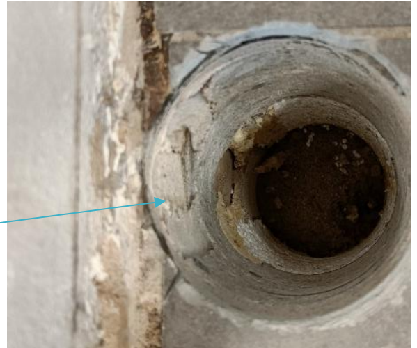
Kuva 55 Rakenneavauksen AP2 perusteella käytävän alapohjarakenne on uusittu.
