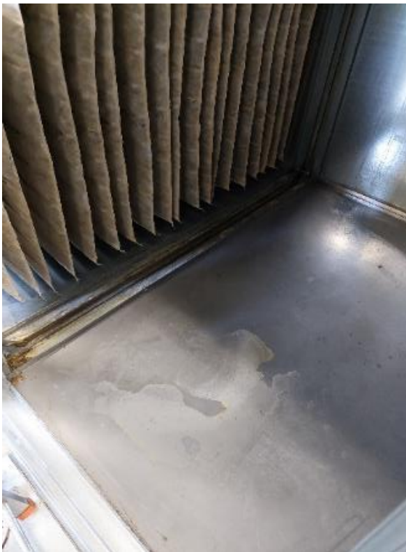
Kuva 195 TK05 poistosuodattimien jälkeinen kammi.
