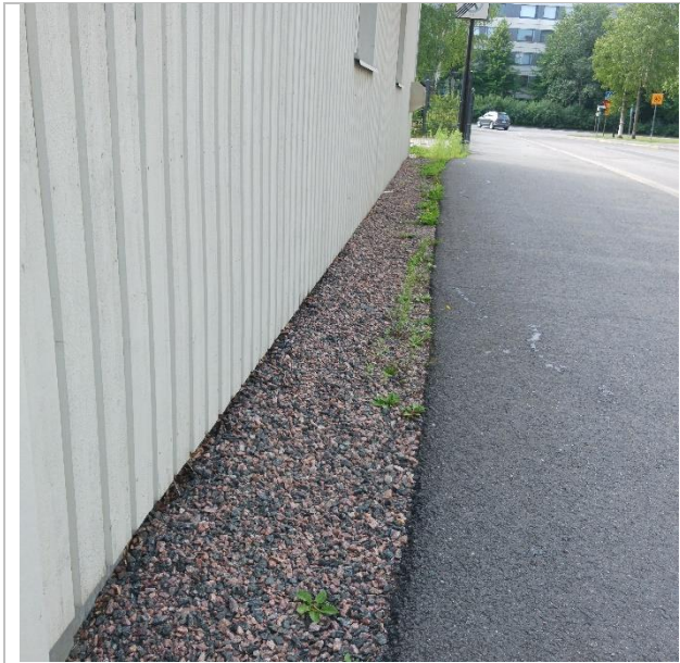
Kuva 53. Rakennuksen vierustalla on pääosin noin puoli metriä leveä sorakaista.
