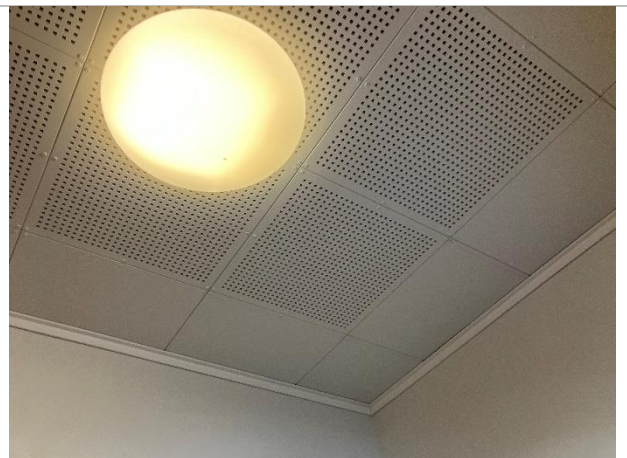
Kuva 39. Muun muassa käytävillä yläpohjan sisäverhoiluna on kipsilevyisiä alaslaskettuja kattoja.
