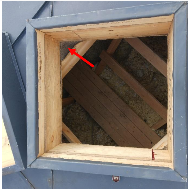
Kuva 48. Käynti yläpohjan tuuletustilaan on vesikatolla olevien luukkujen kautta. Luukun kohdalla havaittiin bitumihuopakermiä saumapeltikatteiden alla (merkattu nuolella).
