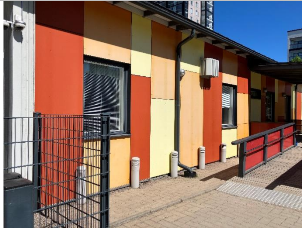
Kuva 32. Rakennuksen ikkunat ovat kolmelasisia puu-alumiini-ikkunoita.
