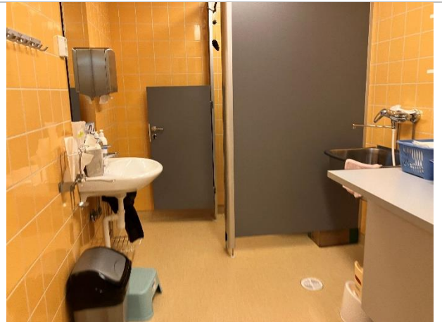
Kuva 7. Märkätilojen lattiapäällysteenä on muo- vimatto.
