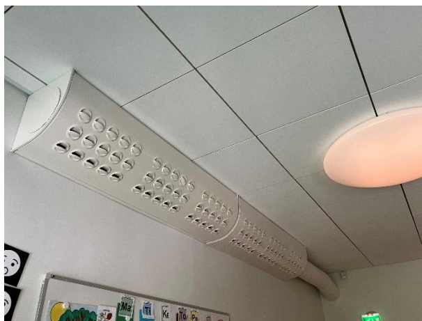
Kuva 38. Yläpohjan sisäverhoiluna on mm. ryhmätiloissa kipsilevyn alapintaan asennetut akustiikkalevyt.
