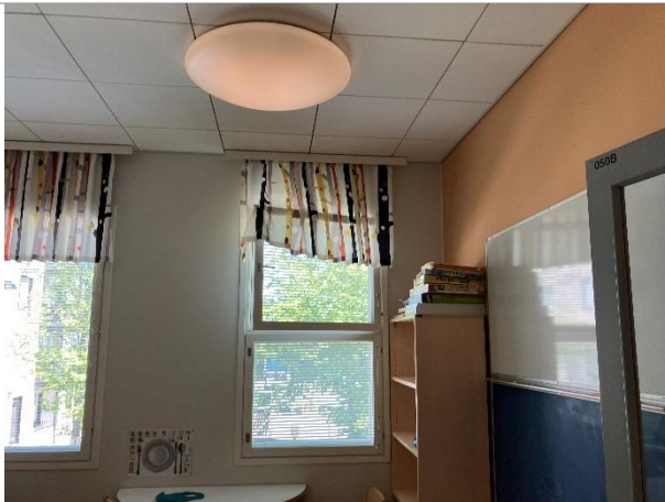
Kuva 28. Ulko- ja väliseinät ovat kuivien tilojen osalta kipsilevyverhoiltuja ja maalipinnoitteisia.
