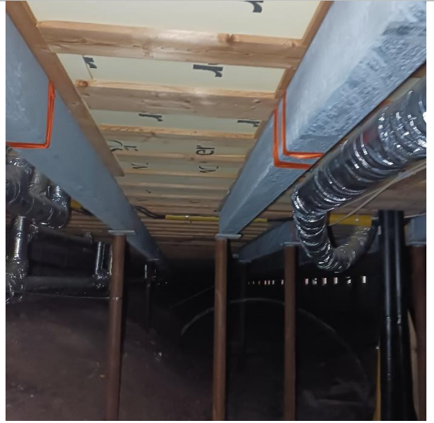
Kuva 9. Alapohjan ryömintätila tuulettuu riittävästi aistinvaraisesti arvioiden. Ryömintätila on pääosin yli 800 mm korkea.
