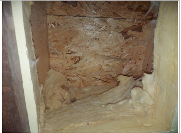
Kuva 16. RA2-AP. Avauksen kohdalta ei havaittu poikkeavaa.
