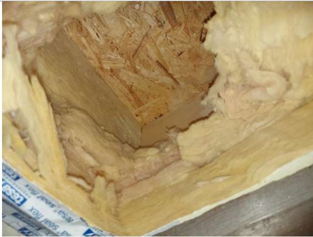
Kuva 15. RA1-AP. Alapohjarakenteen lämmöneristeenä on mineraalivilla. Avauksen kohdalta ei havaittu poikkeavaa.
