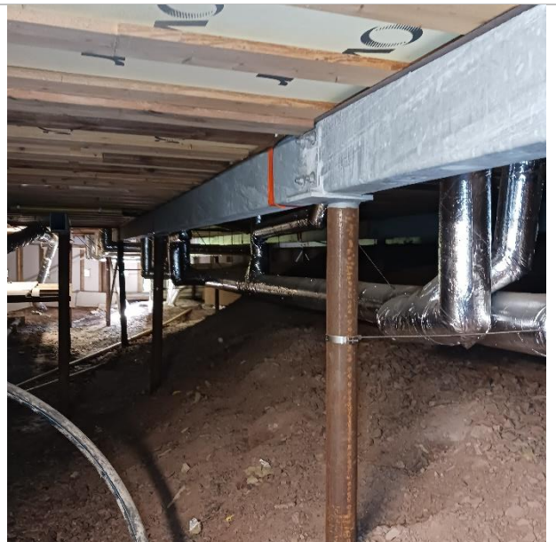
Kuva 9. Alapohjan ryömintätila tuulettuu riittävästi aistinvaraisesti arvioiden. Ryömintätila on pääosin yli 800 mm korkea.
