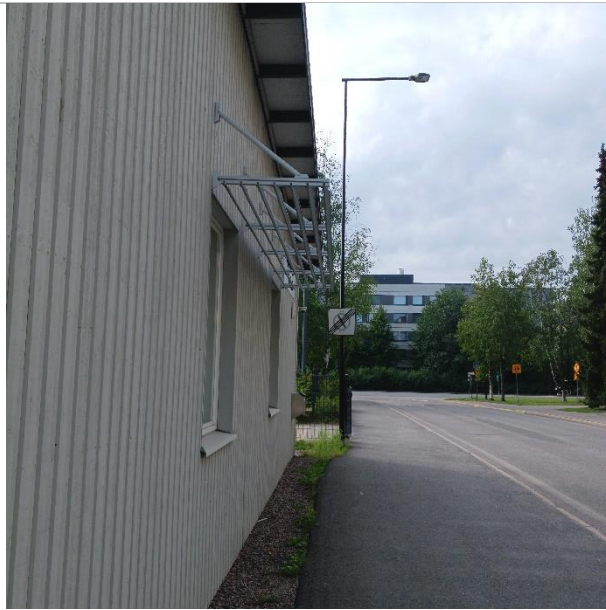
Kuva 36. Ikkunoiden vesipeltien asennuksissa ei pääosin havaittu poikkeavaa.
