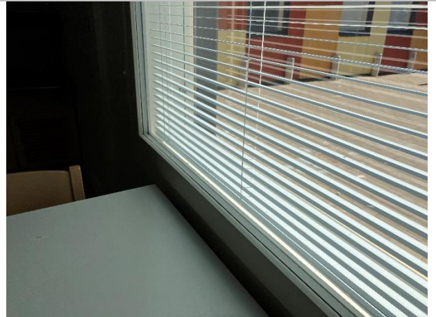
Kuva 33. Lähikuva ikkunoiden tyypistä. Ikkunat ovat avattavia.
