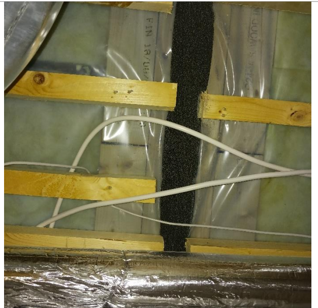
Kuva 43. Käytävä 009 kohdalla oleva tilaelementtien liitoskohta yläpohjarakenteessa on tiivistetty paisuvalla saumanauhalla.
