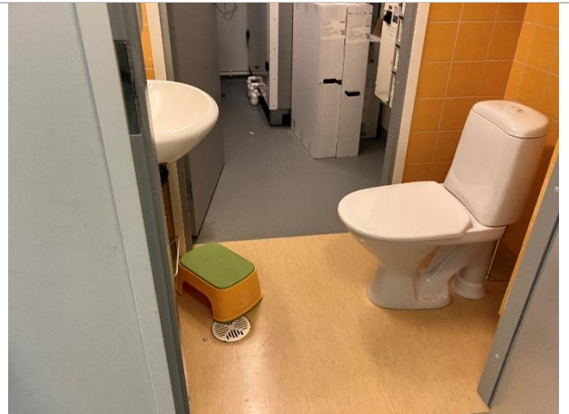
Kuva 29. Märkätilojen ja kosteiden tilojen sekä eteisten seinien pintamateriaalina on keraaminen laatoitus. Kuvassa on WC.
