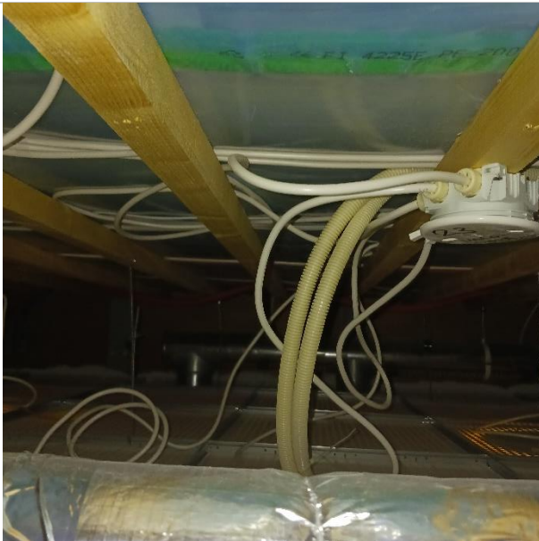
Kuva 42. Höyrynsulkumuovin liimitys on tiivistetty teippaamalla.
