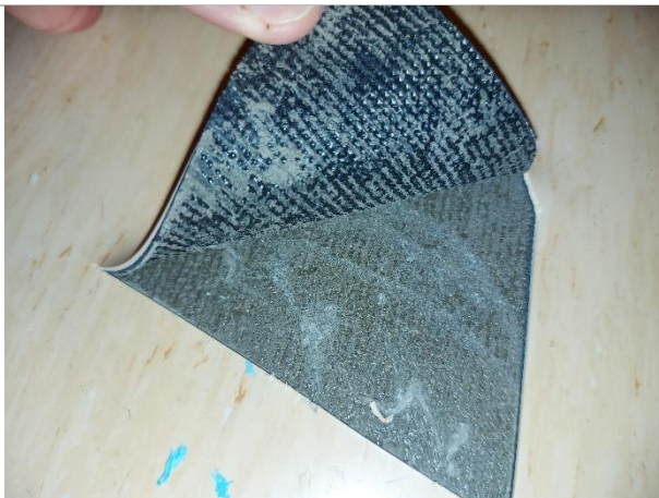
Kuva 20. VM3. Muovimaton taustalla ei havaittu poikkeavaa.
