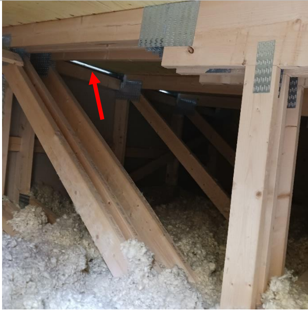
Kuva 44. Rakennuksen naulalevyristikkorakenteisen yläpohjan lämmöneristeenä on käytetty puhallusvillaa. Nuolella on merkattu räystäään tuuletusväli pulpettikaton yläosassa.
