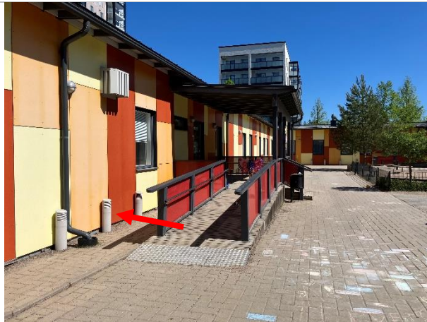
Kuva 12. Sisäpihan puolella ryömintätilan tuuletus on järjestetty tuuletuspaaluilla.
