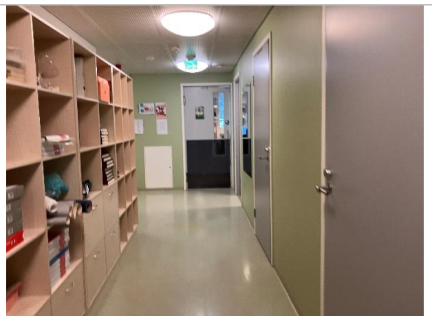
Kuva 35. Väliovet ovat pääosin puurunkoisia umpi- sekä lasiovia.
