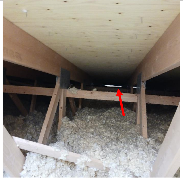
Kuva 45. Nuolella on merkattu räystäään tuuletusväli pulpettikaton alaosa.
