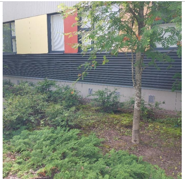
Kuva 52. Rakennuksen vierustoilla on paikoin kasvillisuutta. Kuva on otettu pohjoissivulta.
