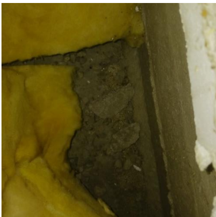
Kuva 67. RA28-YP. Ullakkotilasta tehtiin avaus Nilcon-laatan lämmöneristekerrokseen, josta ei havaittu poikkeavaa. Pohjalla on vähäisiä määriä betonin paloja.
