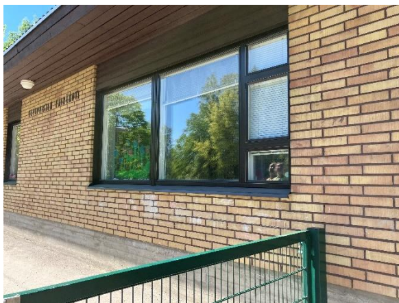
Kuva 43. Rakennuksen ikkunat ovat kolmelasisia puu-alumiini-ikkunoita.
