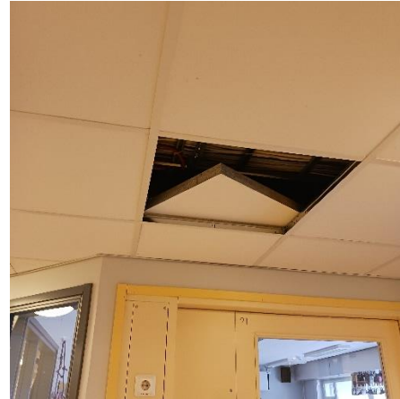
Kuva 60. Muun muassa käytävillä yläpohjan sisäverhoiluna on mineraalivillalevyisiä alaslaskettuja kattoja.
