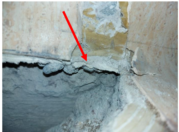
Kuva 4. Alapohjalaatan ja ulkoseinän/sokkelin liitoskohta on tiivistetty kittimassalla muovimaton ylösnoton alta. Merkattu nuolella.
