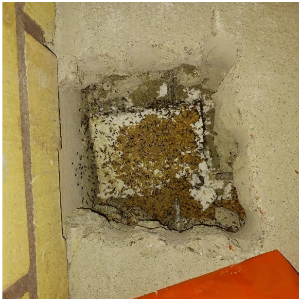
Kuva 1. Rakenneavaus tehtiin alapohjarakenteeseen vanhan ulkoseinän liittymään.
