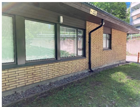
Kuva 30. Julkisivut ovat laudoitettuja mm. ikkunoiden yläpuolelta.
