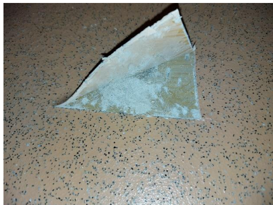
Kuva 18. VM 2. Muovimaton taustalla ei havaittu poikkeavaa.
