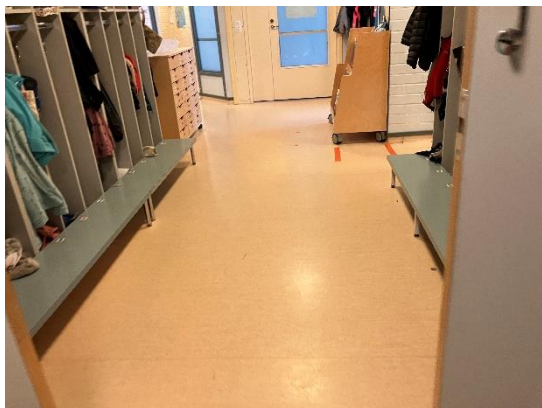
Kuva 7. Lattiapäällysteissä ei havaittu aistinvaraisesti kosteuden aiheuttamia jälkiä.
