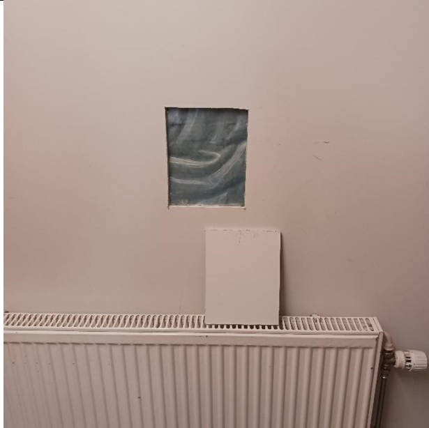
Kuva 1. Rakenneavaus tehtiin ulkoseinään.
