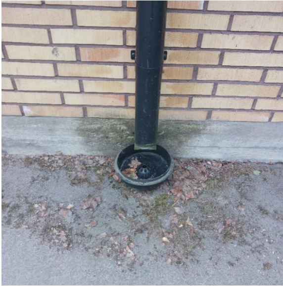
Kuva 76. Syöksytorven lyhyt ulosheittäjä on kastellut sokkelin pintaa.
