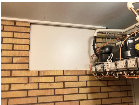
Kuva 56. Laajennusosassa vanha ulkoseinä on jätetty väliseinäksi.
