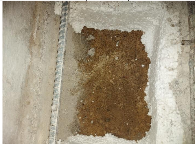
Kuva 2. Lähikuva rakenneavauksesta. Alustäyttö on kapillaarista hiekkaa/moreenia, jonka havaittiin olevan kosteaa.
