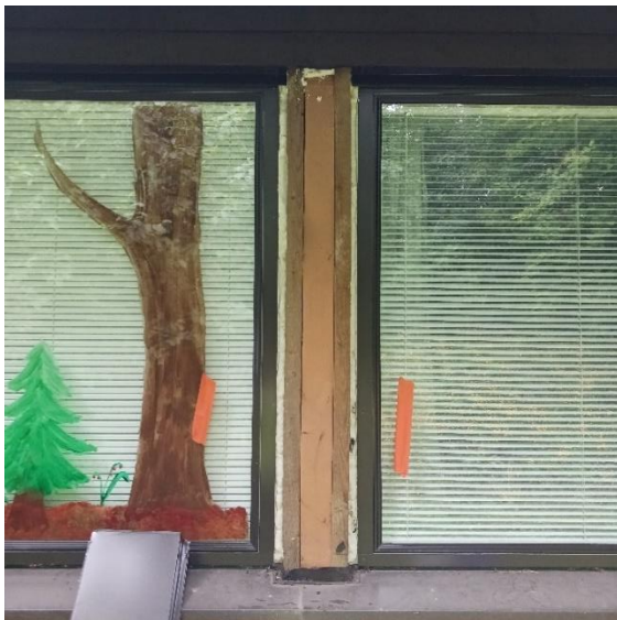
Kuva 1. Rakenneavaus tehtiin ikkunoiden väliseen ulkoseinän osaan.
