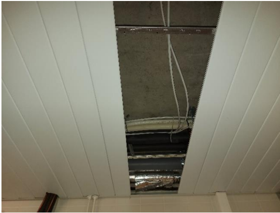
Kuva 61. Keittiössä peltielementtiverhoiltu alaslaskettu katto.
