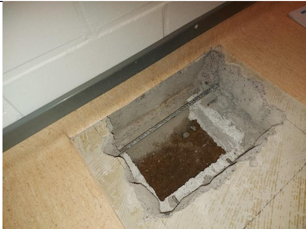
Kuva 1. Rakenneavaus tehtiin alapohjarakenteeseen ulkoseinän liittymään.
