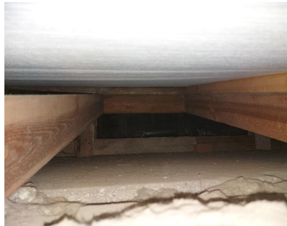
Kuva 72. RA5-YP. Kuvaa rakenneavauksesta.
