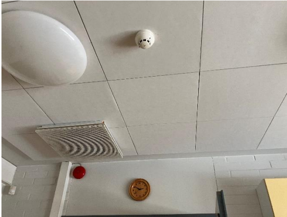
Kuva 59. Yläpohjan sisäverhoiluna on pääosin Nilcon-laatan alapintaan asennetut akustiikkalevyt.
