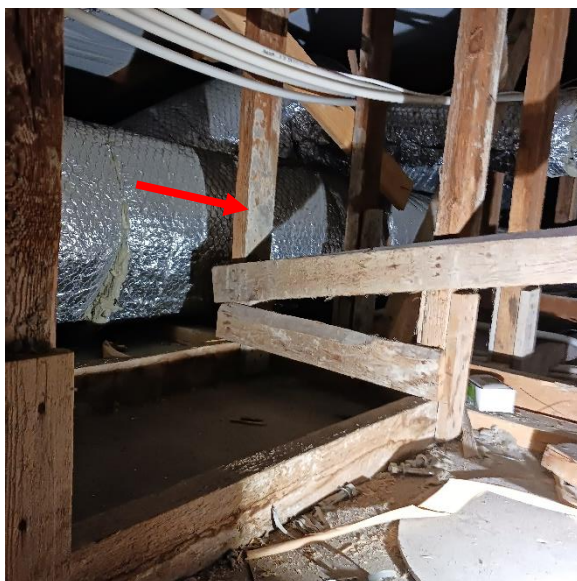
Kuva 65. Vesikaton puurakenteita on todennäköisesti käytetty aiemmin muottilaudoituksina.
