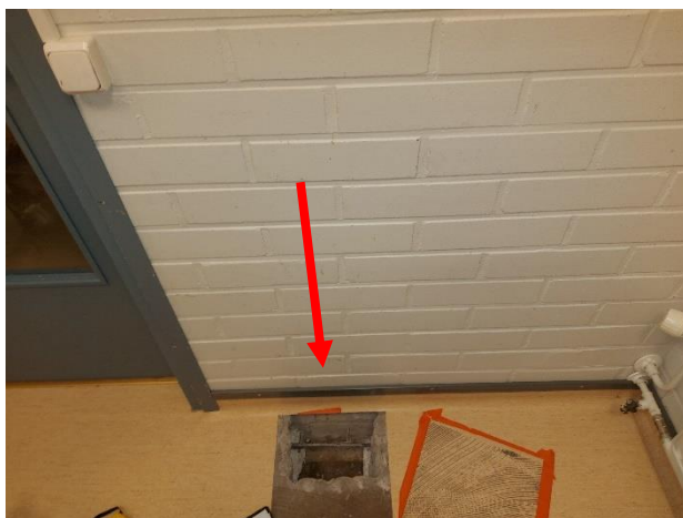
Kuva 1. Rakenneavaus tehtiin alapohjarakenteeseen väliseinän liittymää
