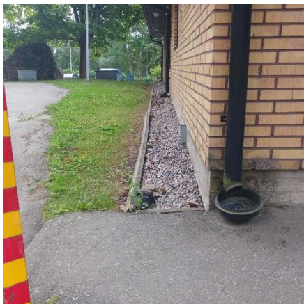
Kuva 80. Rakennuksen vierustalla on sorastusta.
