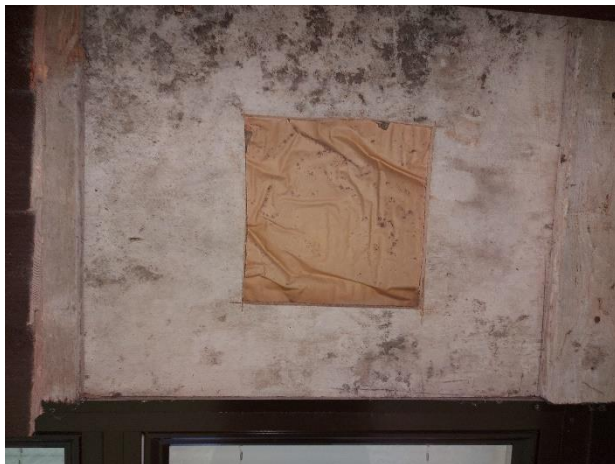
Kuva 1. Rakenneavaus tehtiin ikkunan yläpuolelle puuverhoiltuun ulkoseinän osaan.
