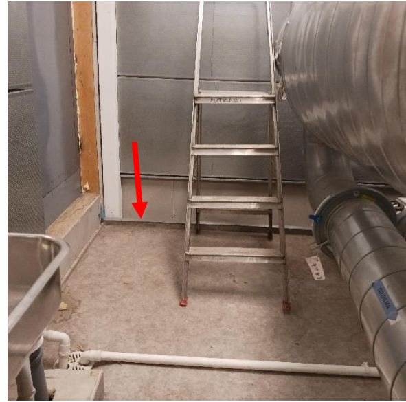
Kuva 50. Lattian muovimatto on nostettu seinälle.
