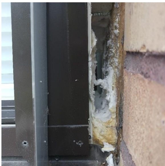
Kuva 46. RA20-Ikkunaväli. Tilkeraon eristämateriaali on uretaanivaahdosta.
