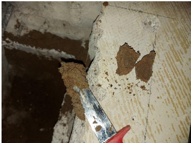
Kuva 3. Alustäytön alla noin 120 mm syvyydessä on perusmaa, jonka havaittiin olevan märkää.
