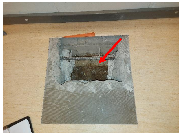
Kuva 2. Lähikuva rakenneavauksesta. Kantava väliseinä lähtee noin 230 mm betonilaatan yläpinnan alapuolelta oman anturan päältä.
