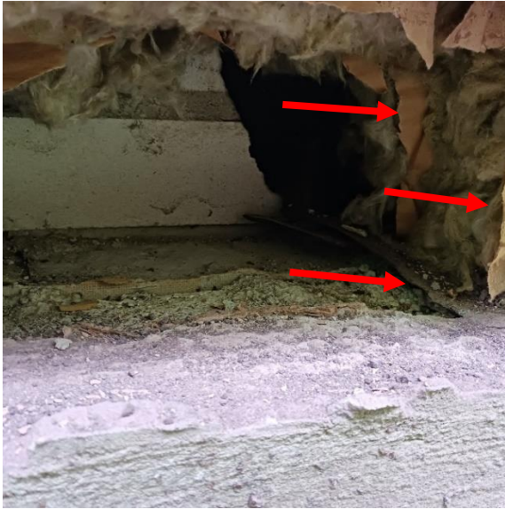
Kuva 35. RA12-US/SOK. Mineraalivillojen (kaksi kerrosta) ulkopinnoissa on rakennuspaperit. Sokkelin päällä on bitumikermi ja bitumikermi on nostettu ylös kalkkiahiekkatiilimuurauksen ulkopinnalle.
