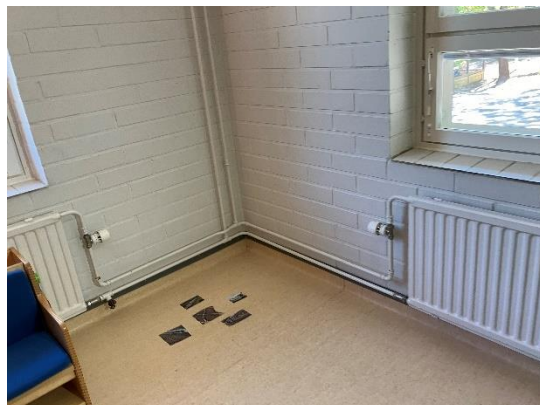
Kuva 10. Muovimatto on nostettu seinälle n. 100 mm korkeudelle.
