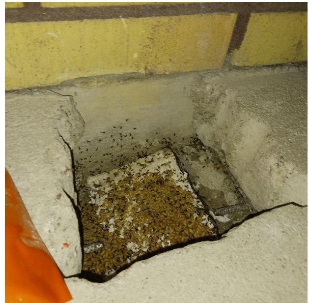
Kuva 2. Lähikuva rakenneavauksesta. Avauksen kohdalla havaittiin runsaasti hyönteisiä mm. muurahaisia.
