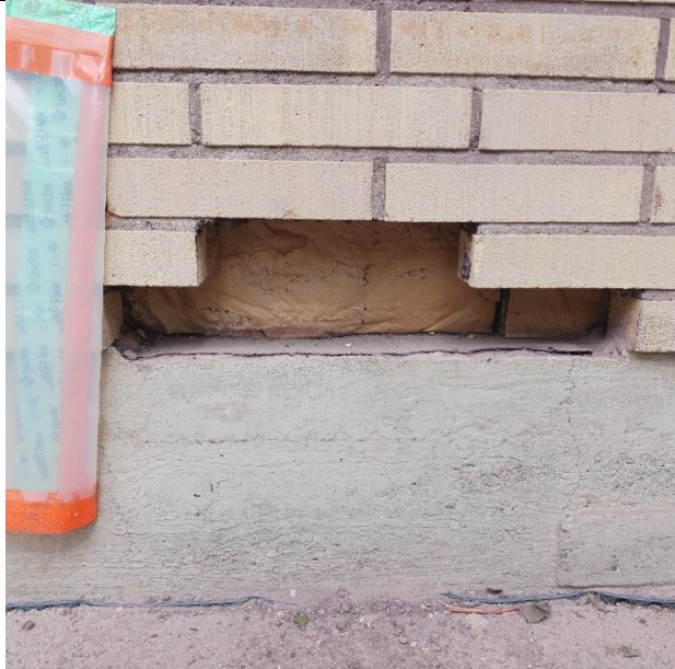
Kuva 1. Rakenneavaus tehtiin ulkoseinän alaosaan sokkelin yläpinnan tasalle.
