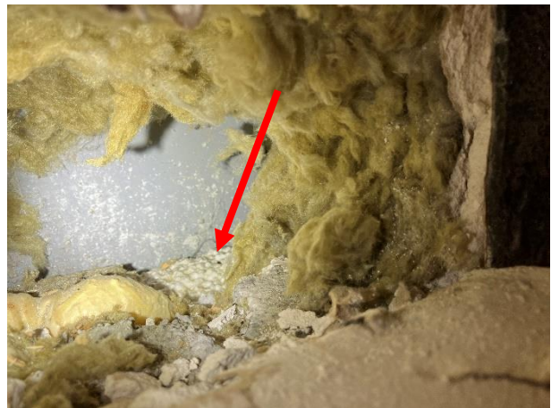
Kuva 4. Ulkoseinän alaosassa on EPS-lämmöneristellä eristetty sokkelipalkki-elementti.
