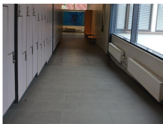
Kuva 55. Yhdyskäytävällä 218 lattiamateriaalina on keraaminen laatta.
