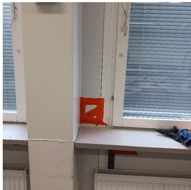
Kuva 1. Yleiskuvaa rakenneavauksesta tilassa L112. Rakenneavaus tehtiin ikkunan ja pilarin väliin rakenteeseen.
