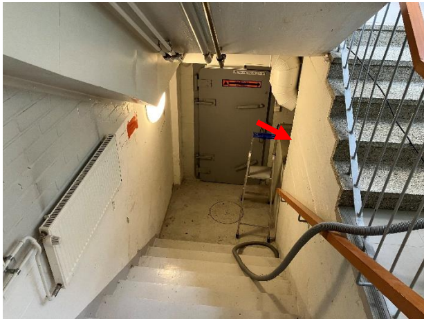
Kuva 1. Yleiskuvaa portaista tilassa K66. Rakenneavaus tehtiin porrastasanteen alapuolelta tiilimuuraukseen.
