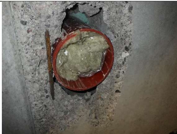
Kuva 18. Yksittäinen käyttämätön läpivienti / varaus, joka on tiivistetty mineraalivillalla.
