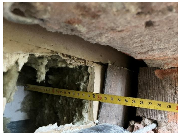
Kuva 2. Tuulensuojakipsilevyn ja tiilimurauksen liittymässä on kumibitumikaistale.
