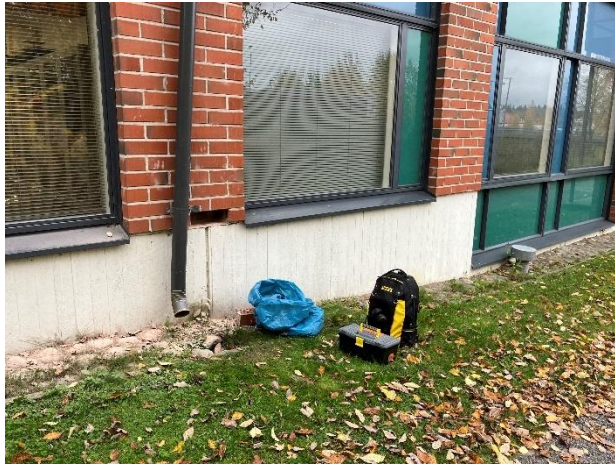
Kuva 1. Yleiskuvaa rakenneavauksesta tilan 116 ulkopuolelta.
