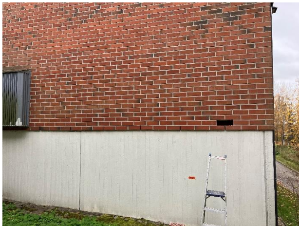
Kuva 1. Yleiskuvaa rakenneavauksesta tilan 118 ulkopuolelta.
