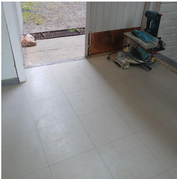
Kuva 14. Porrashuoneessa K66 lattiämateriaalina on vinyylilaatta.
