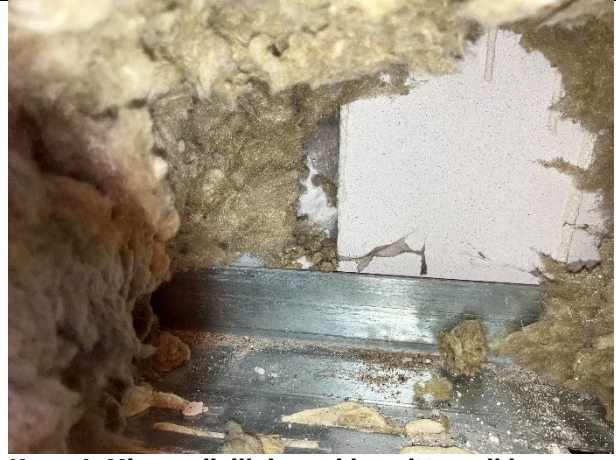
Kuva 4. Mineraalivilloissa ei havaittu poikkeavaa.
