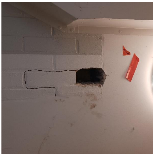
Kuva 1. Yleiskuvaa maanvastaiseseinän rakenneavauksesta tilassa K66.
