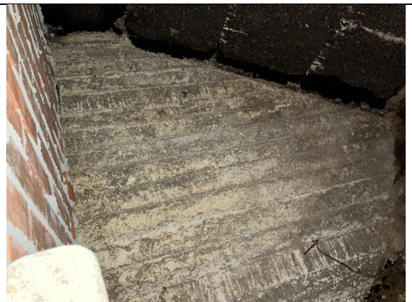
Kuva 23. Alustilassa portaiden alapintaan on kiinnitetty korkkilevy. Alustilan pohja on hiekkaa ja soraa.
