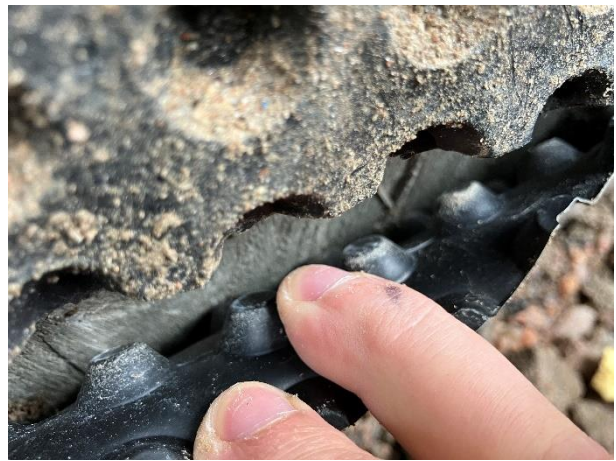
Kuva 6. Perusmuurilevyn taustalla ei havaittu poikkeavaa.
