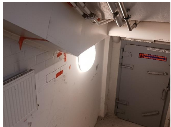
Kuva 37. Porrashuoneen K66 maanvastaiseseinärakenteen sisäpintana oli pääosin tiilimuuraus ja betoni.
