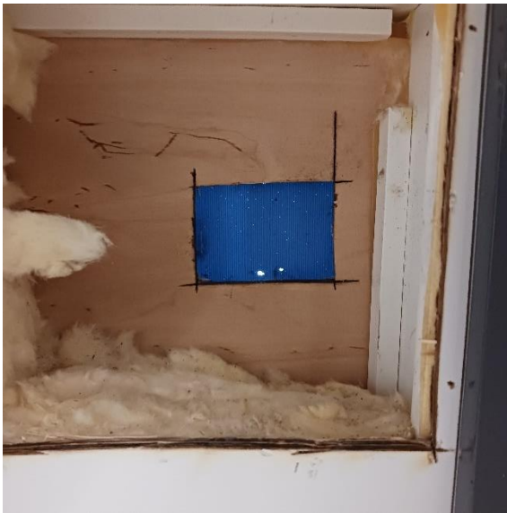
Kuva 45. RA1-US. Rakenneavaus tehtiin ikkunan alapuoliseen rakenteeseen.
