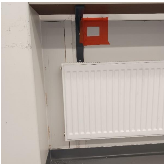
Kuva 1. Yleiskuvaa rakenneavaus kohdasta tilassa L112. Rakenneavaus tehtiin ikkunanapenkin alle.
