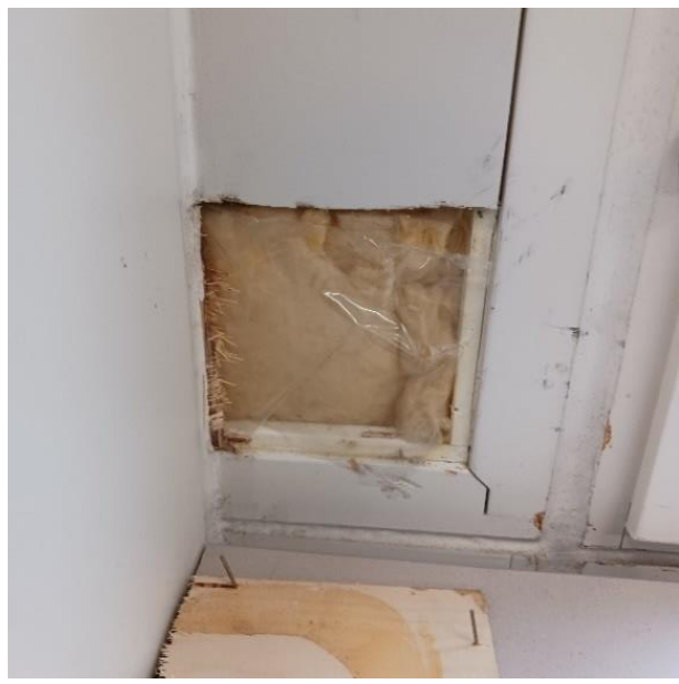
Kuva 2. Ikkunoiden välisessä rakenteessa on käytetty ikkuna-aukkojen karmirunkoa.
