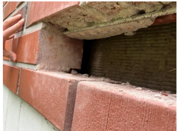
Kuva 2. Lähikuva rakenneavauksesta. Rakenneavauskohdassa on tuulensuojaeriste.
