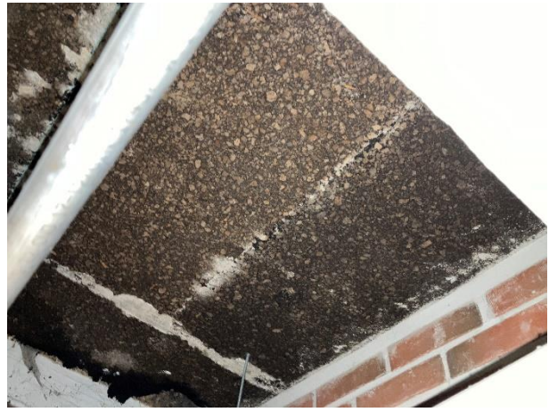
Kuva 2. Porrastasanteen alapinnassa on korkkieristettä.
