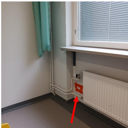
Kuva 1. Yleiskuvaa rakenneavaus kohdasta tilassa L112.
