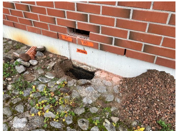
Kuva 2. Ulkoseinään tehtiin rakenneavaus poistamalla tiili ja sokkelin vierustalle tehtiin koekuoppa.
