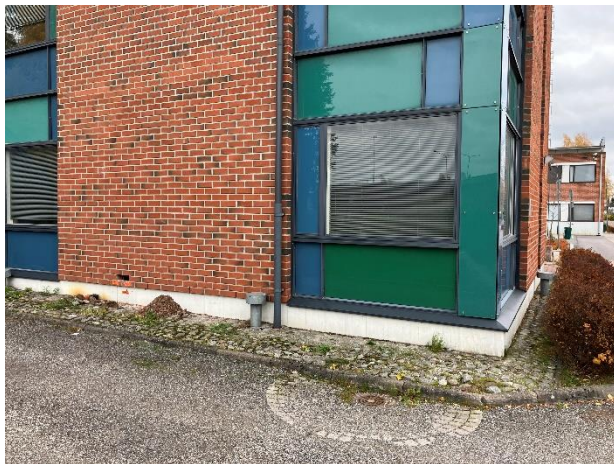
Kuva 1. Yleiskuvaa rakenneavauksesta tilan 106 ulkopuolelta.
