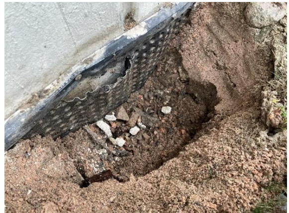
Kuva 50. Perusmuurin ulkopinnassa on perusmuurilevy. Perusmuurilevyn taustalla oleva elementtisauma on elastinen.
