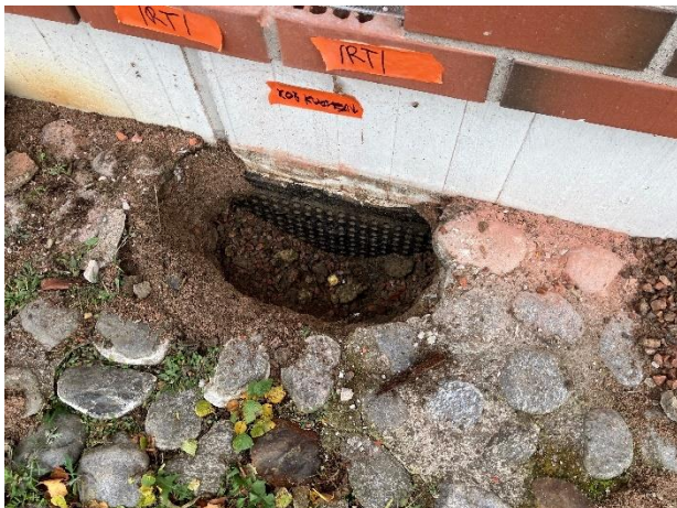
Kuva 5. Perusmuurilevyn ja sen kiinnityslista ovat hyväkuntoisia.
