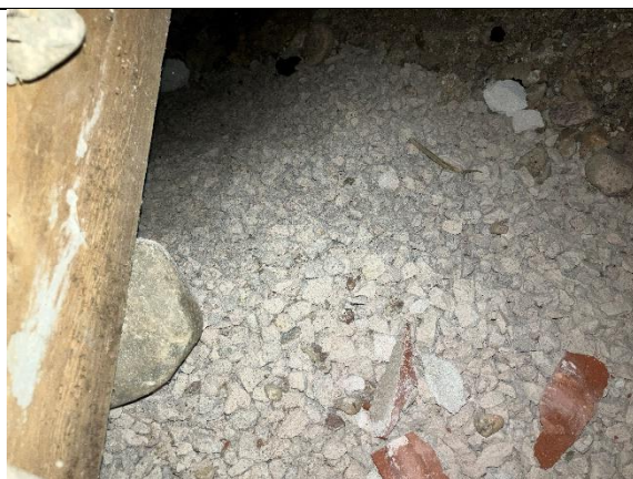
Kuva 24. Alustilan pohja on sora/hiekka pintainen. Tilassa on yksittäisiä muottilautoja.
