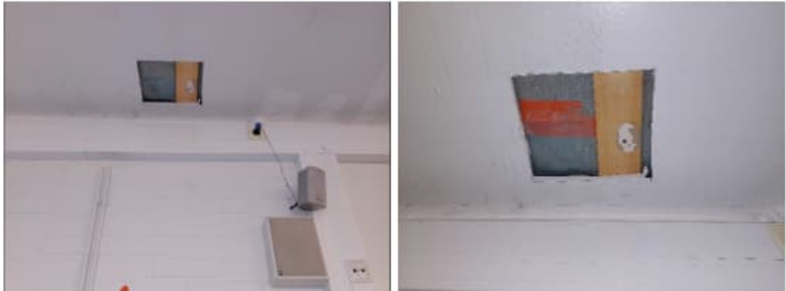
Kuva 94. a-b. Tilan 1099 yläpohjarakenne tarkastettiin rakenneavauksella RA15. Materiaalinäytteet otettiin heti höyrynsulkumuovin takaa yläpohjan selloeristeestä MN7.
