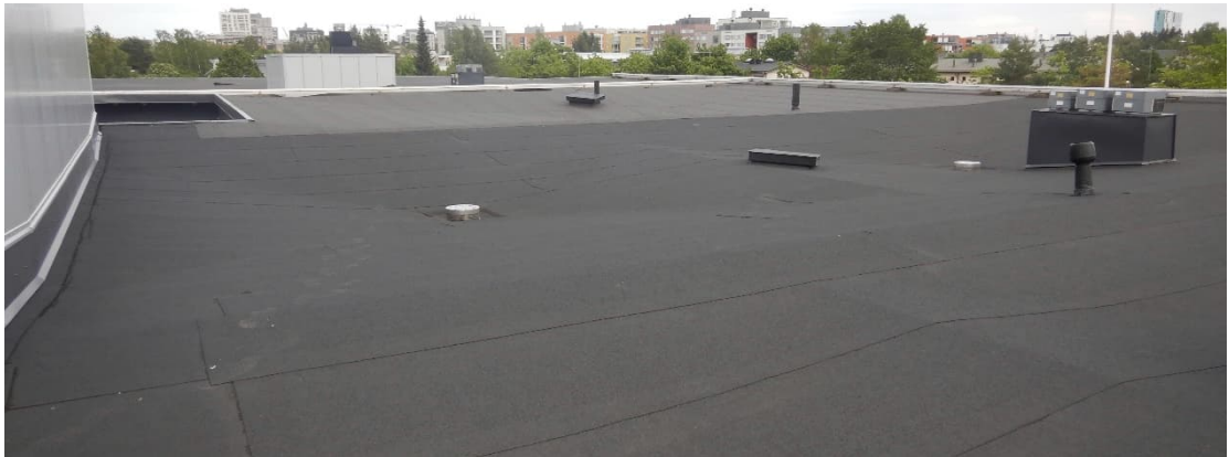
Kuva 89. Yleiskuva B-osan vesikatosta. Vesikatossa ei havaittu puutteita ja sen yleiskunto on hyvä.
