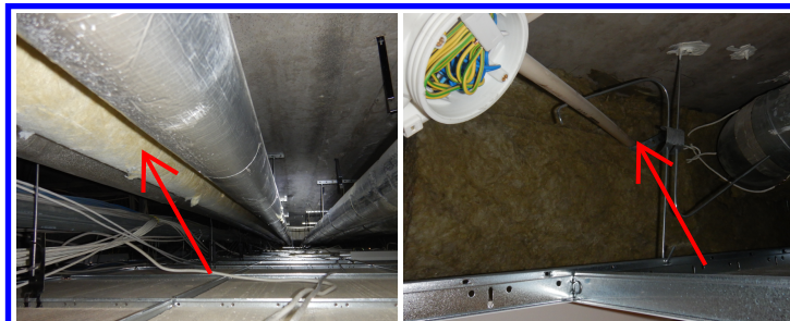
Alakattotilojen tarkastus, avointen mineraalivillapintojen poisto tai pinnoitus (maali). Kaikki 1.kerroksen tilat
