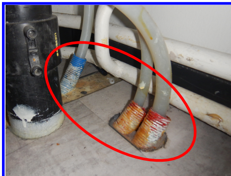
Alapohjan putkiläpivientien tiivistyskorjaukset. Kaikki 1.kerroksen tilat
