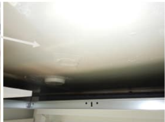
Kuva 81 a-b. Opettajienhuoneen tilojen 1097 yläpohjan alapinta ja rakenneliittymät on tiivistetty mahdollisesti TKR-pinnoitteella. Ulkoseinä-yläpohjaliittymien tiivistyksissä havaittiin ulkoseinän merkkiainekokeissa paikallisia puutteita.
