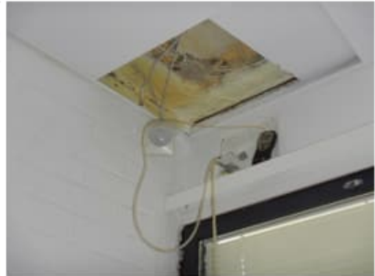
Kuva 81 a-b. Opettajienhuoneen tilojen 1097 yläpohjan alapinta ja rakenneliittymät on tiivistetty mahdollisesti TKR-pinnoitteella. Ulkoseinä-yläpohjaliittymien tiivistyksissä havaittiin ulkoseinän merkkiainekokeissa paikallisia puutteita.
