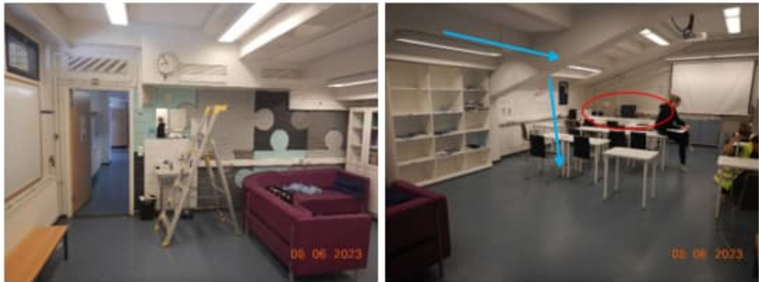
Kuva 99 a-b. Yleiskuva opetustilasta 1013. Tilaan ei tehty merkkisavukoetta. Havaintojen perusteella tuloilmasuihku osuu auditorion kantaviin rakenteisiin (nuolet) ja opettajan pöydän ympäristöön muodostuu katvealue, jota tuloilma ei huuhtelee tehokkaasti.
