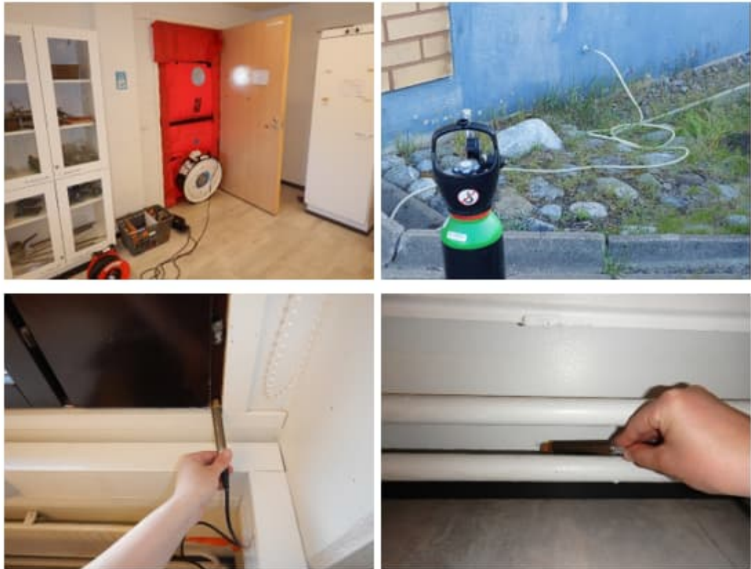
Kuva 63 a-d. Merkkiainekoe MK1, tila fysiikka-kemia 1058, paine-ero -15 Pa. Tila alipaineistettiin oveen asennettavalla Blowerdoor -
