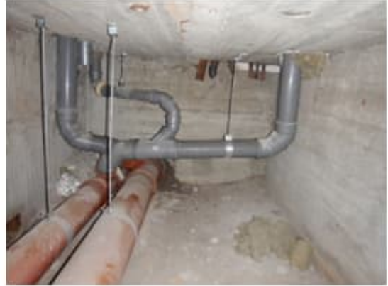
Kuva 19. a-b. Tekniikkakanaalissa on avoimia mineraalivilloja sekä vanhoja läpivientejä. Kanaalissa havaittiin myös jonkin verran rakennusjätettä, poikkeavia hajuja ei kanaalista havaittu.
