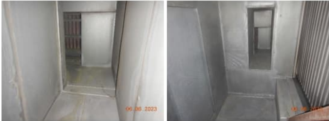
Kuva 105 a-b. A-osan IV-konehuoneen yhteinen raakailmakammio. Kammiossa on jonkin verran havaittuna siitepölyä. Kuitulähteitä ei havaittu ja yleisesti kammio on siisti.
