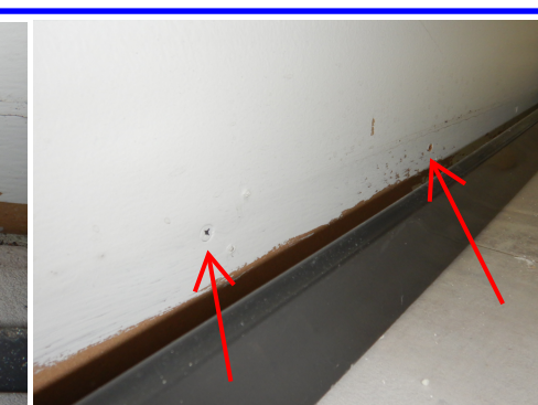
Ulkoseinälinjoilla olevien kipsilevyruuvien ja naulareikien tiivistyskorjaukset. Jalkalistan takaisin liimaus, EI NAULAUS. Kaikki 1.kerroksen tilat
