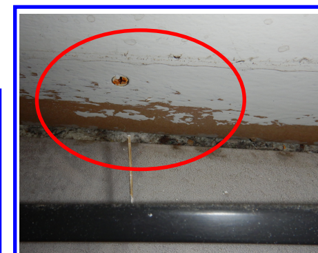
Ulkoseinälinjoilla olevien kipsilevyruuvien ja naulareikien tiivistyskorjaukset. Jalkalistan takaisin liimaus, EI NAULAUS. Kaikki 1.kerroksen tilat
