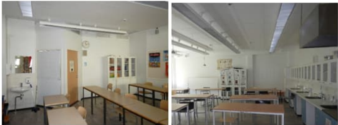
Kuva 72 a-b. Sisätilojen seinäpinnat ovat pääosin hyväkuntoisia, maalattuja kipsilevyseiniä tai maalattuja muurattuja seiniä.
