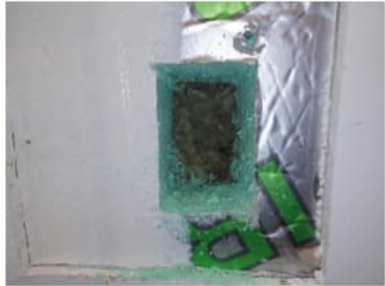
Kuva 58. a-b. Tilan 2047 ulkoseinärakenne tarkastettiin ikkunan alapuolelta sisäpuolen rakenneavauksella RA12. Alumiinipintaisen SPU-eristelevyn takana olevasta mineraalivillasta otettiin materiaalinäyte MN13, näytteessä ei todettu mikrobikasvua.
