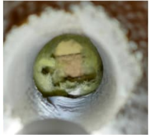
Kuva 61. a-b. Tilan 2026 ulkoseinärakenne tarkastettiin seinän alaosaan rakennearvauksella RA16. Tiili-villa-tiilirakenteen mineraalivillaeristeestä otettiin materiaalinäyte MN18.
