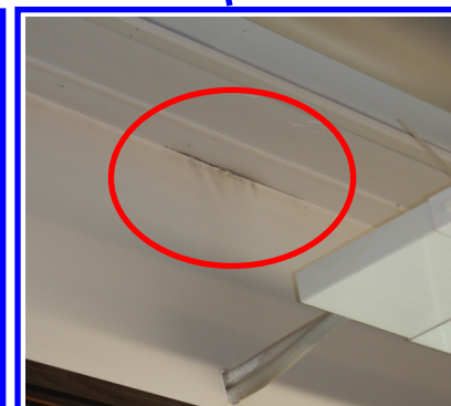
Ulkoseinä-kattoliittymän halkeaman tiivistyskorjaus. Tila 1132.
