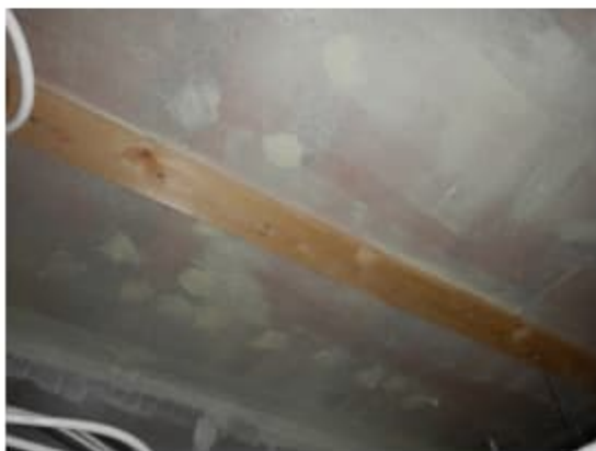
Kuva 82 a-d. 2.kerroksen tiivistyskorjattujen opetustilojen ja käytävien kattopinnat on akustiikkalevyjen takaa tiivistetty pistokokeenomaisesti tarkasteltuna kauttaaltaan TKR-pinnoitteella. Pinnoituksia on tehty
