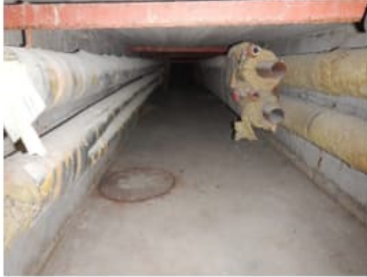
Kuva 19. a-b. Tekniikkakanaalissa on avoimia mineraalivilloja sekä vanhoja läpivientejä. Kanaalissa havaittiin myös jonkin verran rakennusjätettä, poikkeavia hajuja ei kanaalista havaittu.
