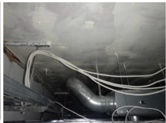
Kuva 82 a-d. 2.kerroksen tiivistyskorjattujen opetustilojen ja käytävien kattopinnat on akustiikkalevyjen takaa tiivistetty pistokokeenomaisesti tarkasteltuna kauttaaltaan TKR-pinnoitteella. Pinnoituksia on tehty
