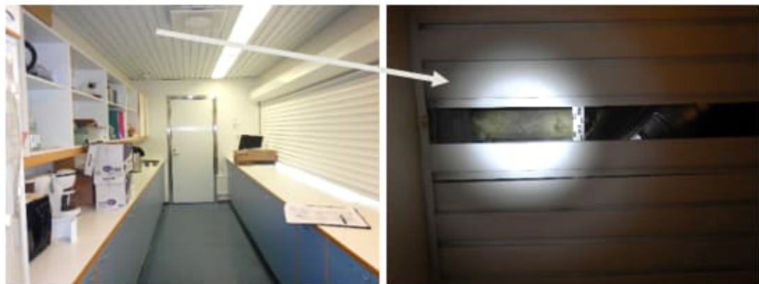
Kuva 26. a-b. Tilan 1032 välipohjan kattopinnassa, metallisen alakaton takana on eristettyjä putkia ja avoimia mineraalivillapintoja.
