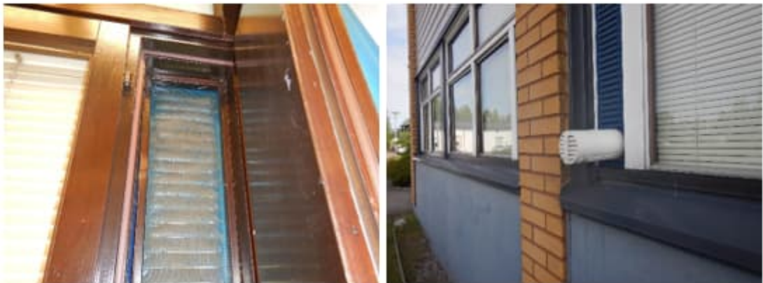
Kuva 41. a-b. 1.kerroksen ikkunoiden ulkopuutteista oli havaintojen mukaan useita auki. Vesipeltien kaadot olivat pääosin riittävät.
