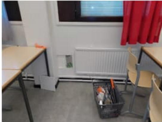
Kuva 58. a-b. Tilan 2047 ulkoseinärakenne tarkastettiin ikkunan alapuolelta sisäpuolen rakenneavauksella RA12. Alumiinipintaisen SPU-eristelevyn takana olevasta mineraalivillasta otettiin materiaalinäyte MN13, näytteessä ei todettu mikrobikasvua.
