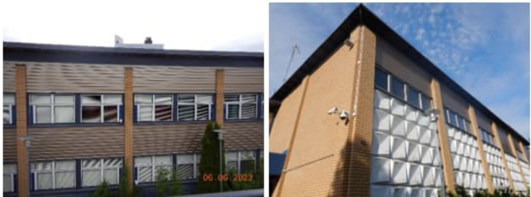
Kuva 36. a-b. Ulkoseinien ulkopinnat ovat pääosin siistit eikä niissä havaittu poikkeavaa. Auditorion julkisivun Minerit-kasetteja on uusittu paikoin vastaavilla lasikuituisilla levyillä.
