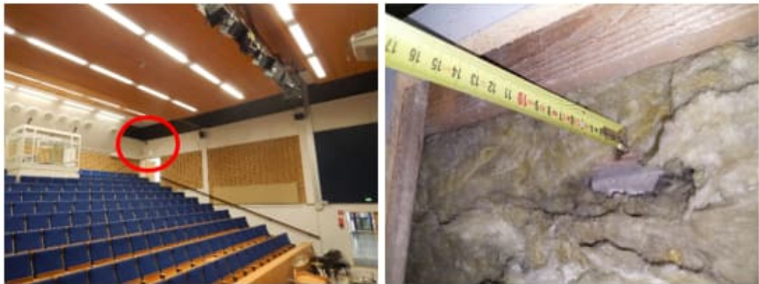
Kuva 76. a-b. Auditorion väliseinärakenne tarkastettiin portaiden yläosasta sisäpuolen rakenneavauksella RA13, läheltä väliseinän ja yläpohjan liitoskohtaa. Mineraalivillasta otettiin materiaalinäyte MN14.
