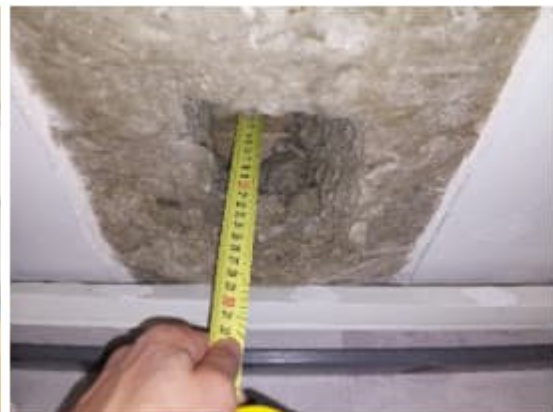
Kuva 59 a-b. Auditorion ulkoseinärakenne tarkastettiin portaiden alaosaan sisäpuolen rakenneavauksella RA14. Rakenteessa ei avauksen kohdalla havaittu höyrynsulkua ja mineraalivillaa havaittiin rakenteessa yhteensä 225 mm. Mineraalivillasta otettiin materiaalinäyte MN15 n. 100 mm
