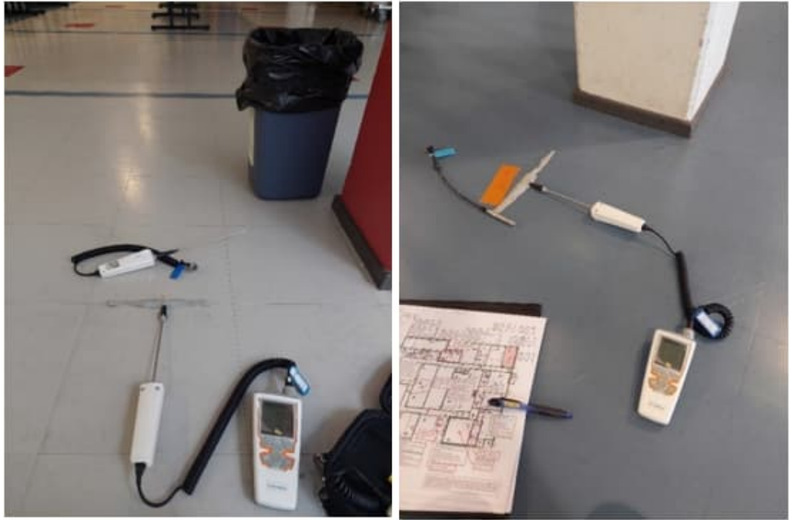
Kuva 20. a-b. Lattiapäällysteen alapuolinen viiltokosteusmittaus V2 tilassa 1053 ja V3 tilassa 1030. Viiltomittaustulokset olivat vain lievästi koholla (75,7 %RH ja 73,2 %RH). Päällyste oli kohtalaisen heikosti kiinni alustassaan.
