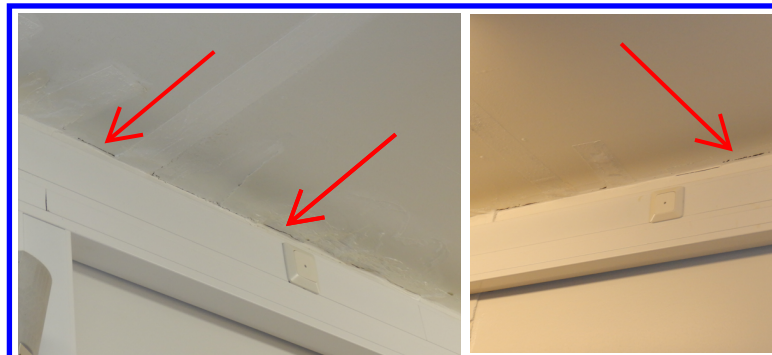
Yläpohjaliittymien vaurioituneiden tiivistyskorjausten purku- ja uusiminen. Tilat 1099, 1100, 1103,1111, 1119
