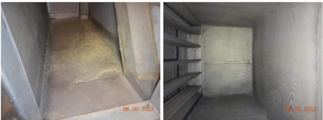
Kuva 106 a-b. IV-konehuoneissa on säilytyslaatikot uusille suodattimille, mutta laatikot olivat auki. IV-konehuoneissa on runsaasti avoimia villapintoja ja aistinvaraisesti arvioituna ilmassa on runsaasti irtokuituja.
