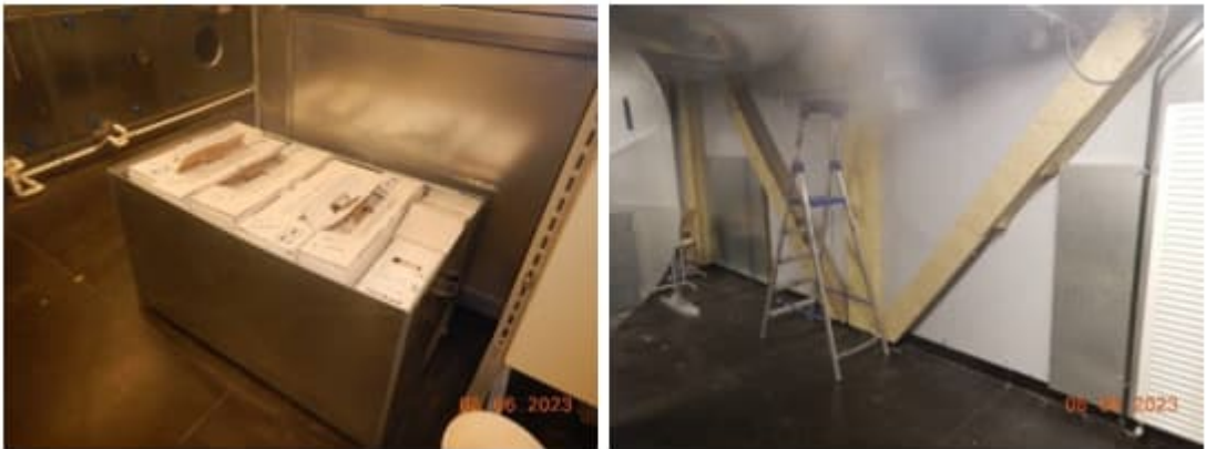
Kuva 106 a-b. IV-konehuoneissa on säilytyslaatikot uusille suodattimille, mutta laatikot olivat auki. IV-konehuoneissa on runsaasti avoimia villapintoja ja aistinvaraisesti arvioituna ilmassa on runsaasti irtokuituja.
