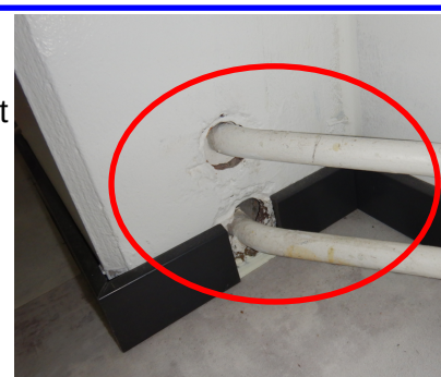
Kuulujen pohjien puhdistus + porraskäytävää vastaisen tiiliseinän ja ovien rakenneliittymien tiivistyskorjaukset (porraskäytävän puolelta). Kuulut.
