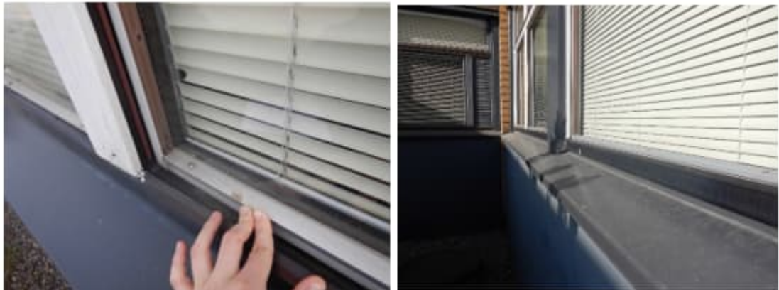
Kuva 41. a-b. 1.kerroksen ikkunoiden ulkopuutteista oli havaintojen mukaan useita auki. Vesipeltien kaadot olivat pääosin riittävät.
