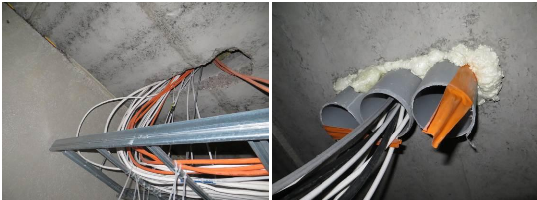
Kuvat 9a ja 9b. Vasemmalla tiivistämätön sähköläpivienti ruokasali 1019 alla. Oikealla kuvassa sähkönousukeskuksen 1018 kohdalla sähköputkitusläpivienti on tiivistetty sivuilta, mutta putki on keskeltä tiivistämättä, korkealla putken yläpinnassa on vuorivillaa tukkeena.
