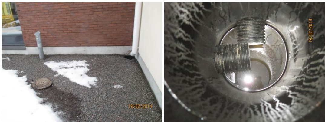
Kuvat 13a ja 13b. Tarkastettu salaojan tarkastuskaivo, joka on etäällä rakennuksesta läh. neu. 1085.
