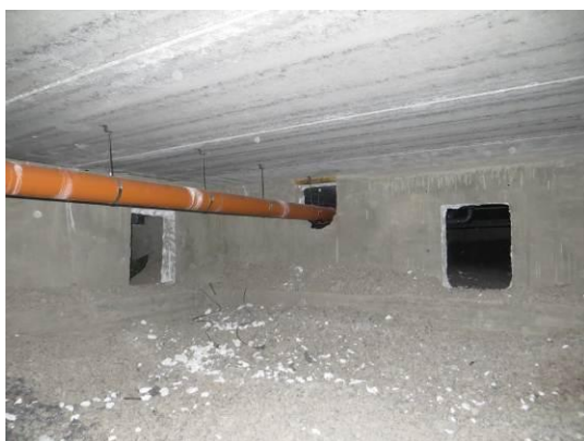
Kuvat 3a ja 3b. Kulkuaukkoja ryömintätilojen välisissä perusmuureissa. Perusmuuria vasten oleva lämmöneristys salin sivulla pukuhuoneen 1017 alla vasten perusmuuria, jonka takana on paikallavalulaatta väestönsuojan kohdalla. Ryömintätilassa on vielä rakennusjätettä.
