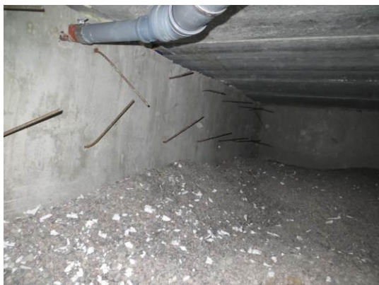
Kuvat 4a ja 4b. Vasemmalla perusmuurin sidosteräksiä kulkuaukon vierellä. Oikean puoleisessa kuvassa on sähkö- ja viemäriputket varten tehty aukko salin 1004 alla, jossa on jäänyt valuvaiheessa nk. rotankolo.
