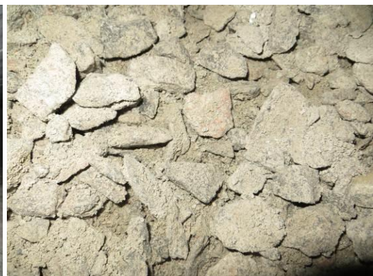
Kuvat 1a ja 1b. Tyypillistä alustatilaa, ryhmähuone 1077 alla, korkeus 1200–1400 mm. Maapohjana on hienoaineksia sisältävää mursketta.
