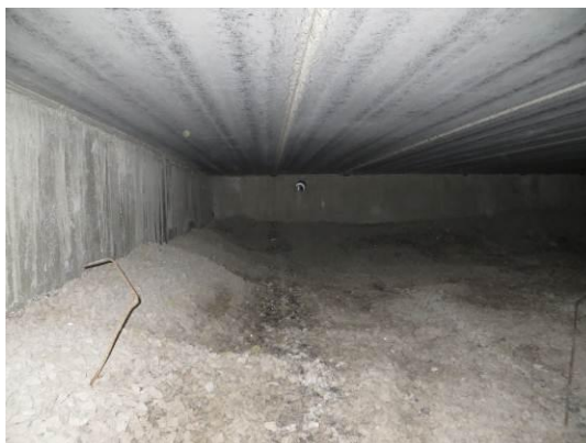
Kuvat 1a ja 1b. Tyypillistä alustatilaa, ryhmähuone 1077 alla, korkeus 1200–1400 mm. Maapohjana on hienoaineksia sisältävää mursketta.
