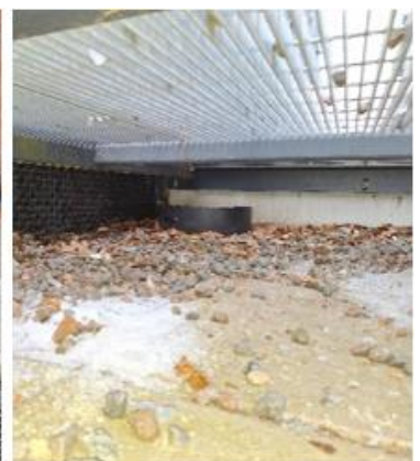
Kuva 21 a-c. Käytävään 1001 johtavan ulko-oven edustalla sade- ja sulamisvesien syöksytorvi ei ulotu sadevesikaivoon saakka, vaan jää selkeästi ylemmäs kaivosta. Sadevesikaivo on metalliritelikön alla.
