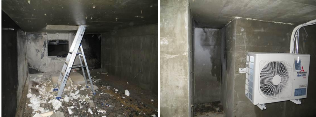
Kuvat 12a ja 12b. Betonipinnat ovat kastuneet todennäköisesti kondenssin takia vaunuvarasto 1090 alla. Lastaussillan ontelotilan huurtunut seinä kenno, joka oi kastellut betonia ja maata.
