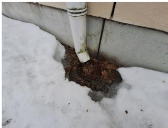
Kuva 20 a-c. Syöksytorvien asemointia on parannettu. Paikoin kuitenkin syöksytorvet eivät osu kunnolla sadevesisuppiloon tai suppilo on miltei tukossa. Sokkelipinnalla on nähtävillä kosteuden aiheuttamia jälkiä.
