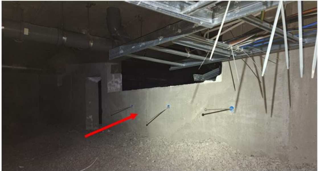
Kuva 19. Perusmuurissa ollut valupuute on korjattu.
