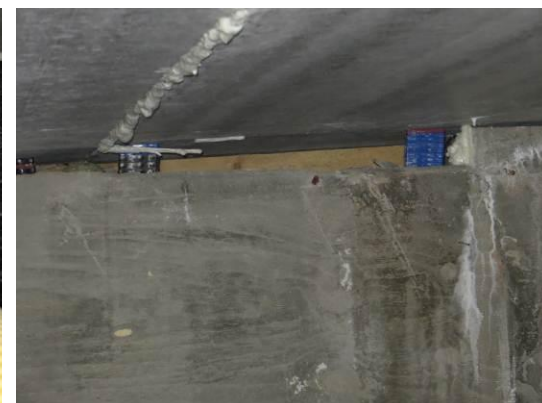
Kuvat 12a ja 12b. Tästä on läpivientireikien kautta ilmayhteys koulun kellarikäytävälle. Koulun päätyseinän alla oleva rako, josta pilkottaa vaneri. Onteloiden alla ei ole saumavalua.
