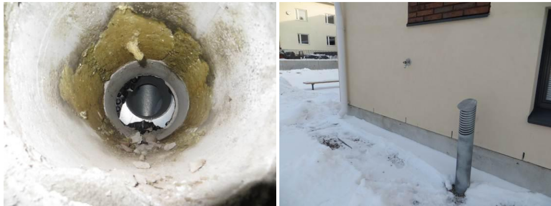
Kuvat 5a ja 5b. Tuuletusputken pää sokkelipalkin läpi ryömintätilaan. Tuuletusputki nousee riittävästi maan pinnan yläpuolelle. Ritiöistä pääsee tuiskulunta.
