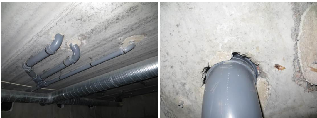
Kuvat 7a ja 7b. Vasemmanpuoleisessa kuvassa tiiviiltä vaikuttavia viemäriläpivientejä ja oikean puoleisessa kuvassa epätiivis täyttövalu viemäriputken läpiviennissä.
