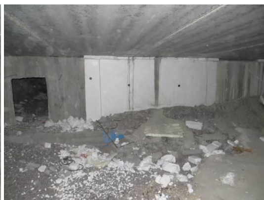
Kuvat 3a ja 3b. Kulkuaukkoja ryömintätilojen välisissä perusmuureissa. Perusmuuria vasten oleva lämmöneristys salin sivulla pukuhuoneen 1017 alla vasten perusmuuria, jonka takana on paikallavalulaatta väestönsuojan kohdalla. Ryömintätilassa on vielä rakennusjätettä.
