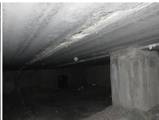
Kuvat 10a ja 10b. Sokkelielementin sauma on valamatta, tila 1046 kohdalla. Ontelolaatan saumavalussa on halkeilua ruokasalin 1019 sivulla.
