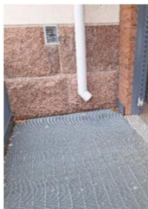
Kuva 21 a-c. Käytävään 1001 johtavan ulko-oven edustalla sade- ja sulamisvesien syöksytorvi ei ulotu sadevesikaivoon saakka, vaan jää selkeästi ylemmäs kaivosta. Sadevesikaivo on metalliritelikön alla.
