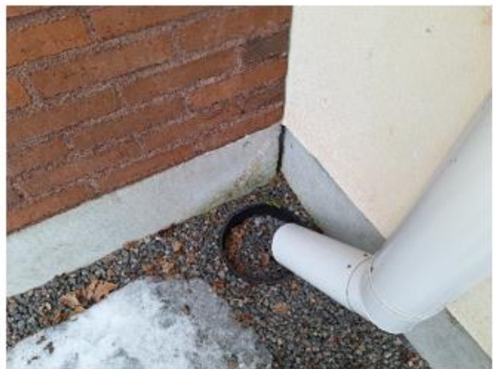
Kuva 20 a-c. Syöksytorvien asemointia on parannettu. Paikoin kuitenkin syöksytorvet eivät osu kunnolla sadevesisuppiloon tai suppilo on miltei tukossa. Sokkelipinnalla on nähtävillä kosteuden aiheuttamia jälkiä.
