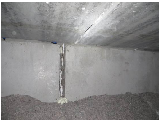
Kuvat 10a ja 10b. Sokkelielementin sauma on valamatta, tila 1046 kohdalla. Ontelolaatan saumavalussa on halkeilua ruokasalin 1019 sivulla.
