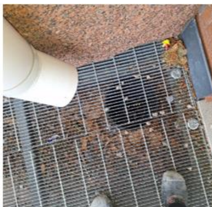
Kuva 21 a-c. Käytävään 1001 johtavan ulko-oven edustalla sade- ja sulamisvesien syöksytorvi ei ulotu sadevesikaivoon saakka, vaan jää selkeästi ylemmäs kaivosta. Sadevesikaivo on metalliritelikön alla.
