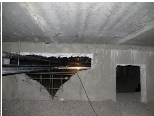
Kuvat 4a ja 4b. Vasemmalla perusmuurin sidosteräksiä kulkuaukon vierellä. Oikean puoleisessa kuvassa on sähkö- ja viemäriputket varten tehty aukko salin 1004 alla, jossa on jäänyt valuvaiheessa nk. rotankolo.
