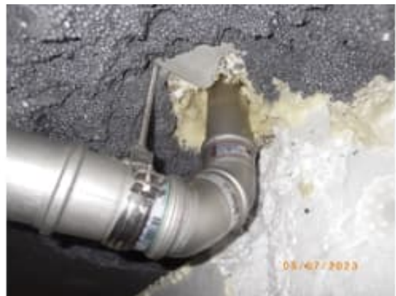
Kuva 10. Yleiskuva rakennuksen viemäriputkista. Putket ovat eristämättömiä. Putket ovat pääasiassa muovisia, mutta keittiön alueella putket ovat HST-terästä.
