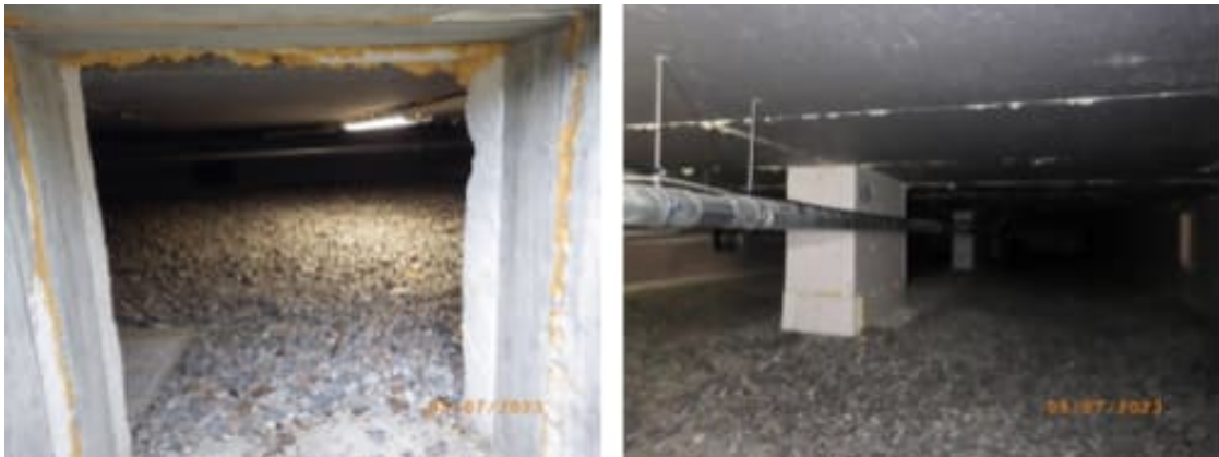
Kuva 8. Yleiskuva ryömintätilasta. Maatäyttö on toteutettu karkealla sepelillä. Ryömintätilan yleisilme on siisti eikä normaalista poikkeavia hajuja todettu.
