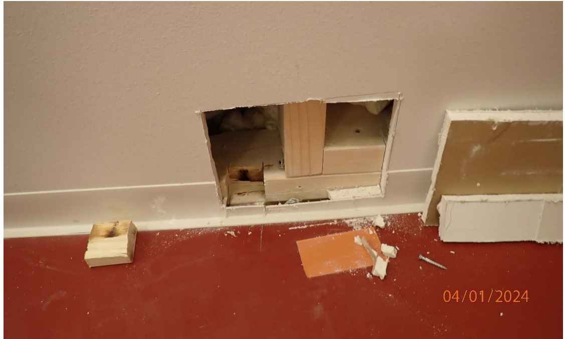
Kuva 60. Rakennearaus RA17 tehtiin tilaan 229 leikki seinän koteloon. Rakennearauksen perusteella väliseinärakenne on pääasiassa suunnitelmien mukainen. Kipsilevyseinän alalaidasta otettiin materiaalinäyte MN19. Näytteessä ei todettu mikrobikasvua. Rakenteessa ei havaittu normaalia poikkeavia hajuja.
