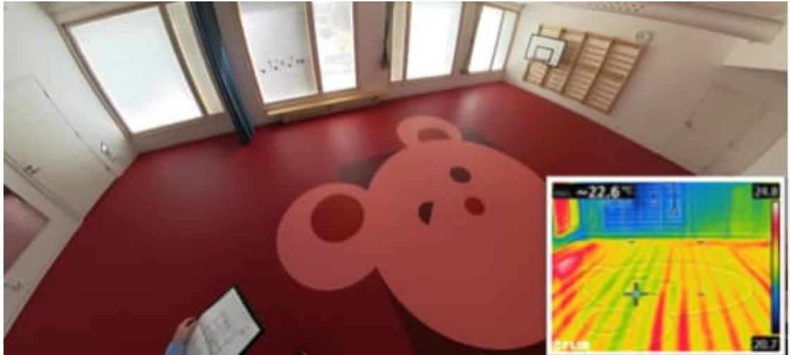
Kuva 15. Kuvassa on tila 122 liikuntasali. Tilassa on siisti massalattia. Tila koetaan talvisin niin kylmäksi, että sitä ei juuri haluta käyttää. Tutkimusten yhteydessä tehdyn lämpökamerakuvauksen perusteella lattialämmitysputket lämpenevät.
