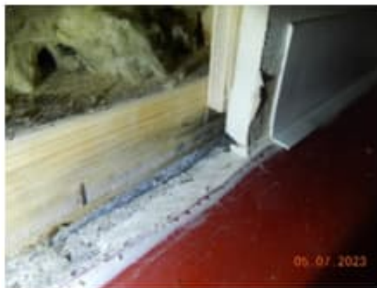
Kuva 50. Rakennus RA4 tehtiin tilaan 103 keskusvarasto. Rakennuksen kautta voitiin havaita, että tilan 103 keskusvarasto kosteusvahinkokorjaukset, eivät ole olleet riittävän laajat. Alaohjauspuussa ja muissa puurakenteissa on selkeää tummentumaa ja mustia pilkkuja. Metalliset nitojan nitit ovat ruostuneita. Mineraalivillasta otettiin
