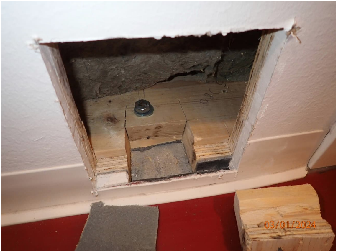
Kuva 54. Rakenneavaus RA10 tehtiin tilaan 107 käytävä. Alaohjauspuun alapinnasta otettiin materiaalinäyte MN12.2 ja mineraalivillasta MN12.1. Materiaalinäytteissä ei todettu mikrobikasvusta. Rakenteessa ei todettu kohonneita kosteusarvoja (p%) piikkimittarilla. Rakenteessa ei havaittu normaalia poikkeavia hajuja.
