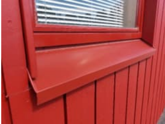
Kuva 30. Ikkunoiden vesipellit kallistuvat hyvin poispäin rakennuksesta.
