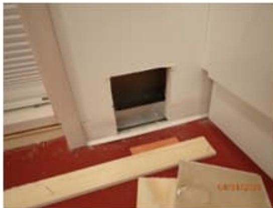
Kuva 61. Rakennearaus RA18 tehtiin tilaan 229 leikki väliseinään. Rakennearauksen perusteella väliseinärakenne on pääasiassa suunnitelmien mukainen. Materiaalinäyte MN20 otettiin kuitenkin rakennearauksen viereisen väliseinän ikkunan alalaidasta. Näytteessä ei
