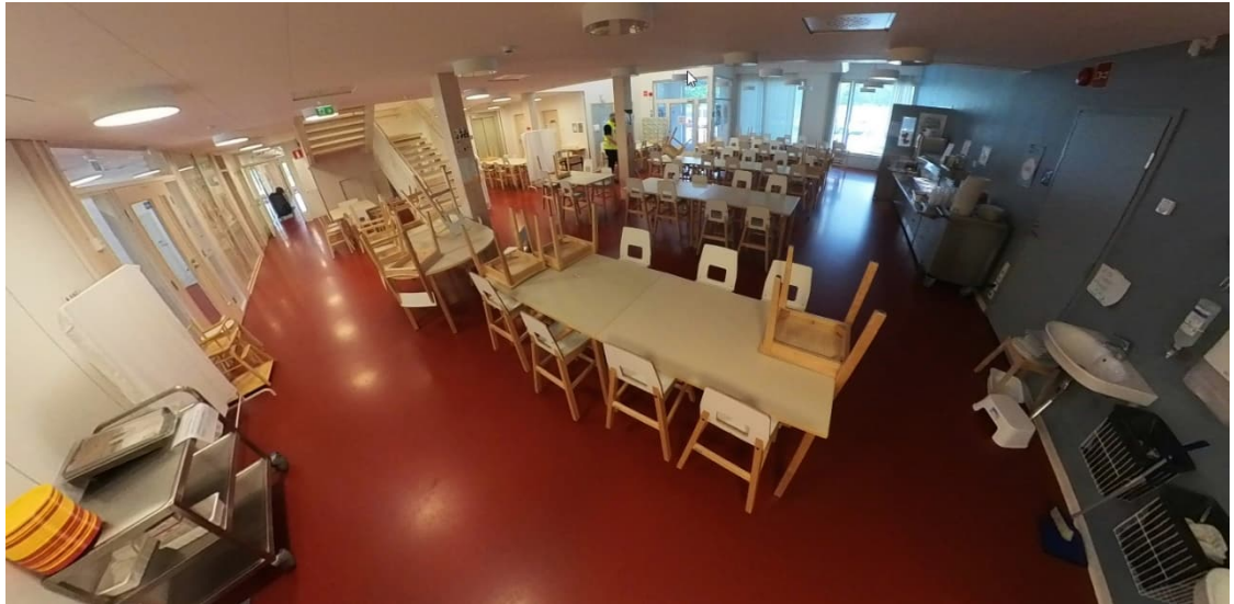
Kuva 13. Rakennuksessa on käytetty useissa tiloissa massalattiapinnoitetta 1. kerroksen alueella. Kuvassa on päiväkodin tila 117 ruokailutila.
