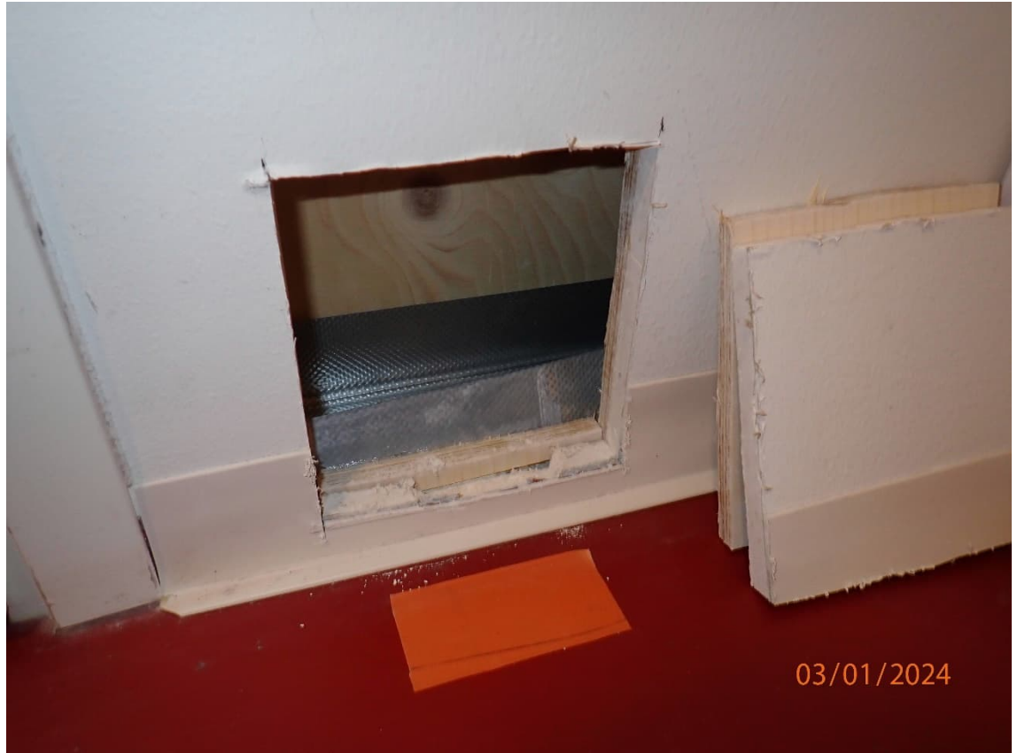
Kuva 57. Rakenneavaus RA13 tehtiin tilaan 107 käytävä. Väliseinä on metallirankainen. Seinälevytyksen alaosa otettiin materiaalinäyte MN15. Materiaalinäytteessä ei todettu mikrobivaurioita. Rakenteessa ei havaittu normaalia poikkeavia hajuja. Rakenne todettiin suunnitelmien mukaiseksi.
