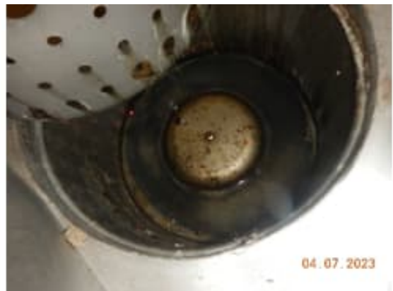
Kuva 20. Tilassa 120 työpaja on lattiakaivo, jossa on karkealle lialle likasihti. Kaivossa ja sihdissä on likaa ja kaivo haisee todella voimakkaasti.
