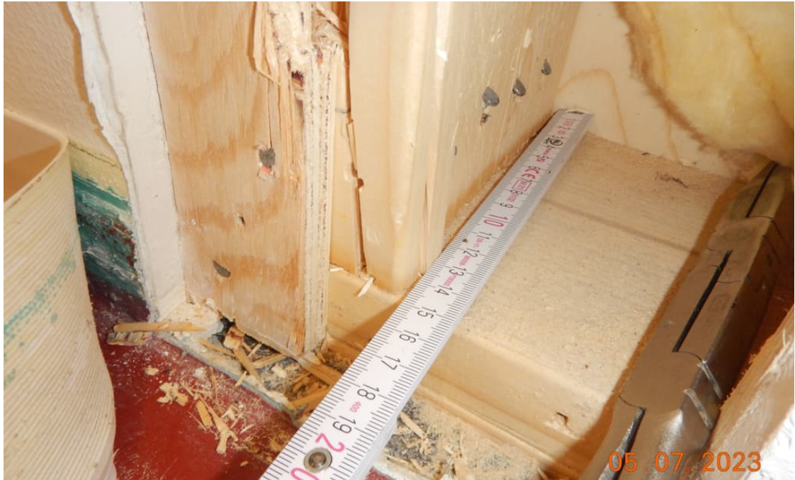
Kuva 49. Rakennus RA3 tehtiin tilaan 124 leikki. Rakennuksen perusteella väliseinärakenne on suunnitelmien mukainen. Mineraalivillasta otettiin materiaalinäyte MN3. Materiaalinäytteessä ei havaittu mikrobikasvua, eikä rakenteessa normaalia poikkeavaa hajua.
