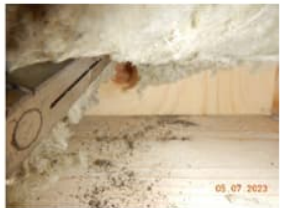
Kuva 50. Rakennus RA4 tehtiin tilaan 103 keskusvarasto. Rakennuksen kautta voitiin havaita, että tilan 103 keskusvarasto kosteusvahinkokorjaukset, eivät ole olleet riittävän laajat. Alaohjauspuussa ja muissa puurakenteissa on selkeää tummentumaa ja mustia pilkkuja. Metalliset nitojan nitit ovat ruostuneita. Mineraalivillasta otettiin
