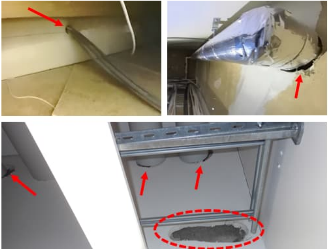
Kuva 48. Paikallisesti todettiin alaslaskutilojen kautta, että väliseinien läpiviennissä on rakenteellista epätiiviyyttä. Kuvassa on esitetty esimerkkejä havaituista epätiiveyksistä tiloista 201 lepo, 107 käytävä ja 101 tekninen tila.
