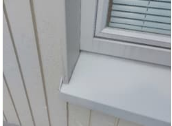
Kuva 30. Ikkunoiden vesipellit kallistuvat hyvin poispäin rakennuksesta.
