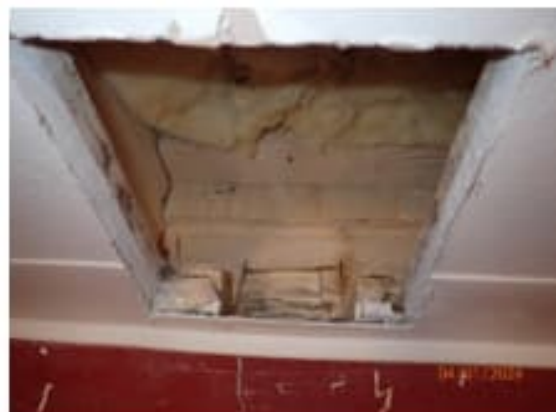
Kuva 58. Rakenneavaus RA14 tehtiin tilan 229 leikki väliseinään lähelle vuotanutta lattialämmityspotkea. Rakenneavauksen perusteella väliseinärakenne on pääasiassa suunnitelmien mukainen. Lattiavalu on
