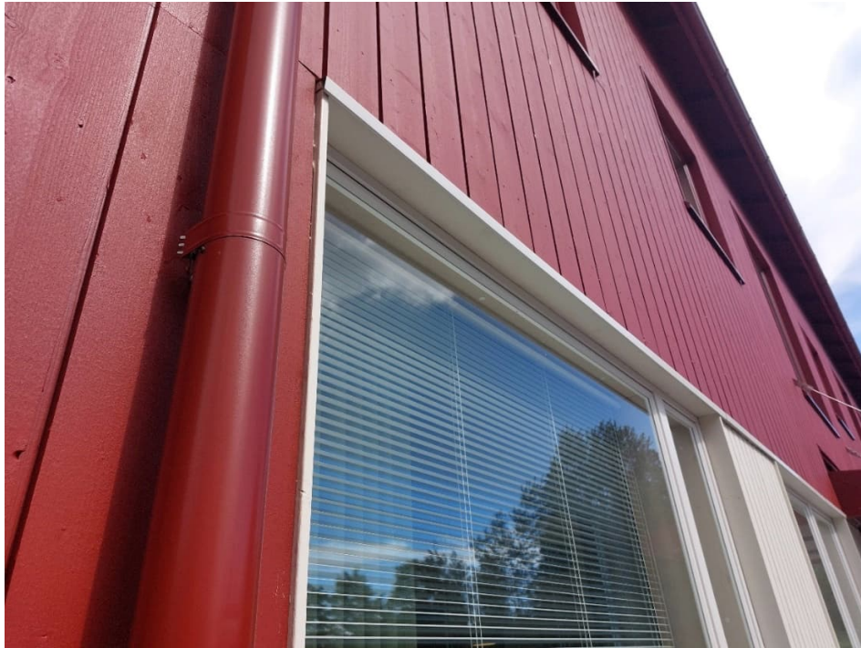
Kuva 28. Yleiskuva rakennuksen julkisivusta ja ikkunaliittymistä.
