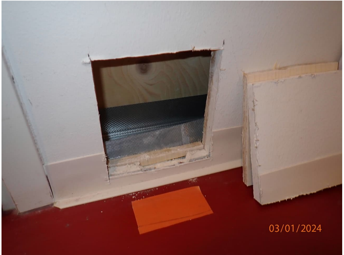
Kuva 55. Rakennus RA11 tehtiin tilaan 107 käytävä. Väliseinä on metallirankainen. Seinälevytyksen alaosa otettiin materiaalinäyte MN13. Materiaalinäytteessä ei todettu mikrobivaurioita. Rakenteessa ei havaittu normaalia poikkeavia hajuja. Rakennus todettiin suunnitelmien mukaiseksi.
