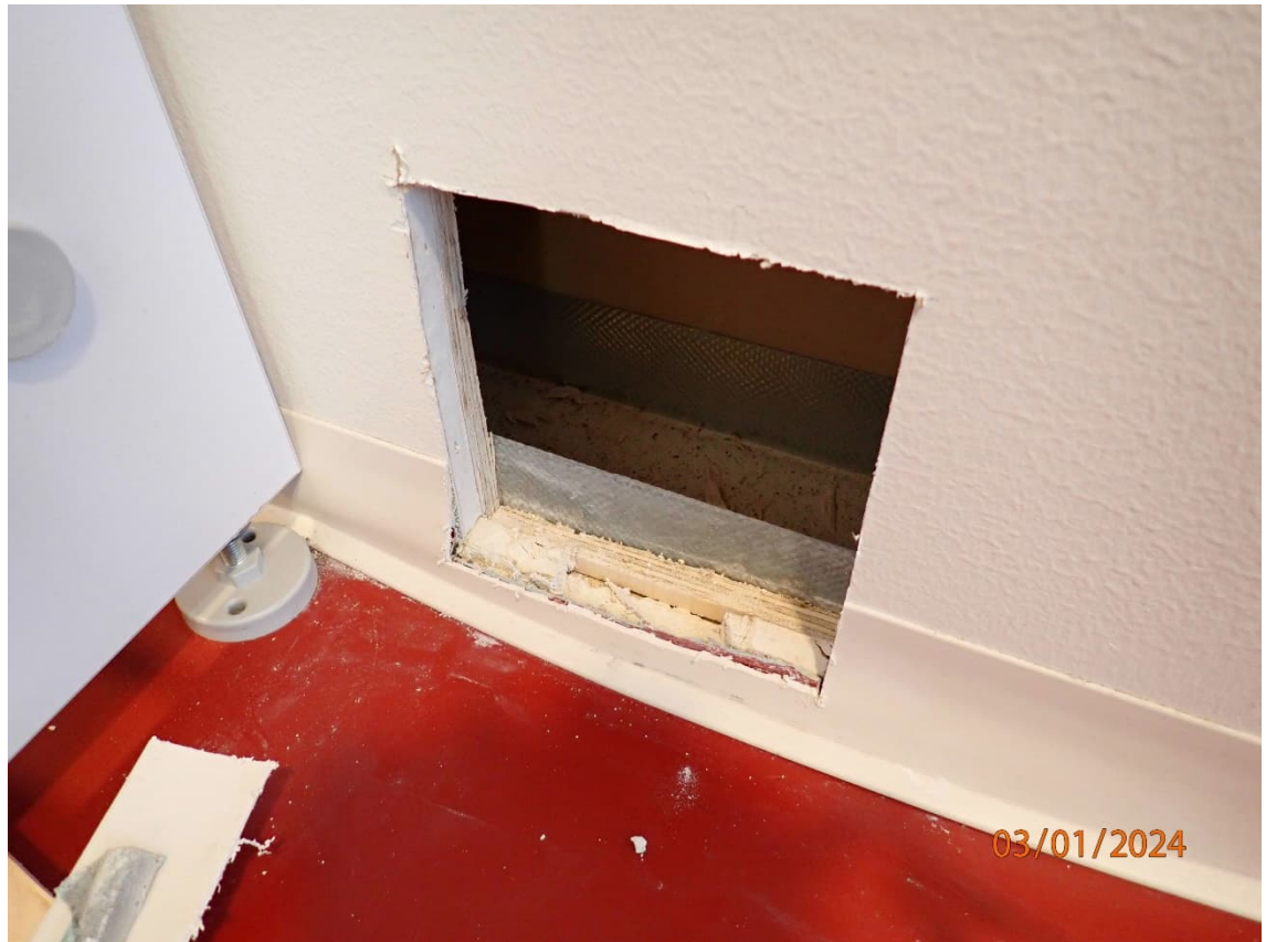
Kuva 56. Rakenneavaus RA12 tehtiin tilaan 107 käytävä. Väliseinä on metallirankainen. Seinälevytyksen alaosa otettiin materiaalinäyte MN14. Materiaalinäytteessä ei todettu mikrobivaurioita. Rakenteessa ei havaittu normaalia poikkeavia hajuja. Rakenne todettiin suunnitelmien mukaiseksi.
