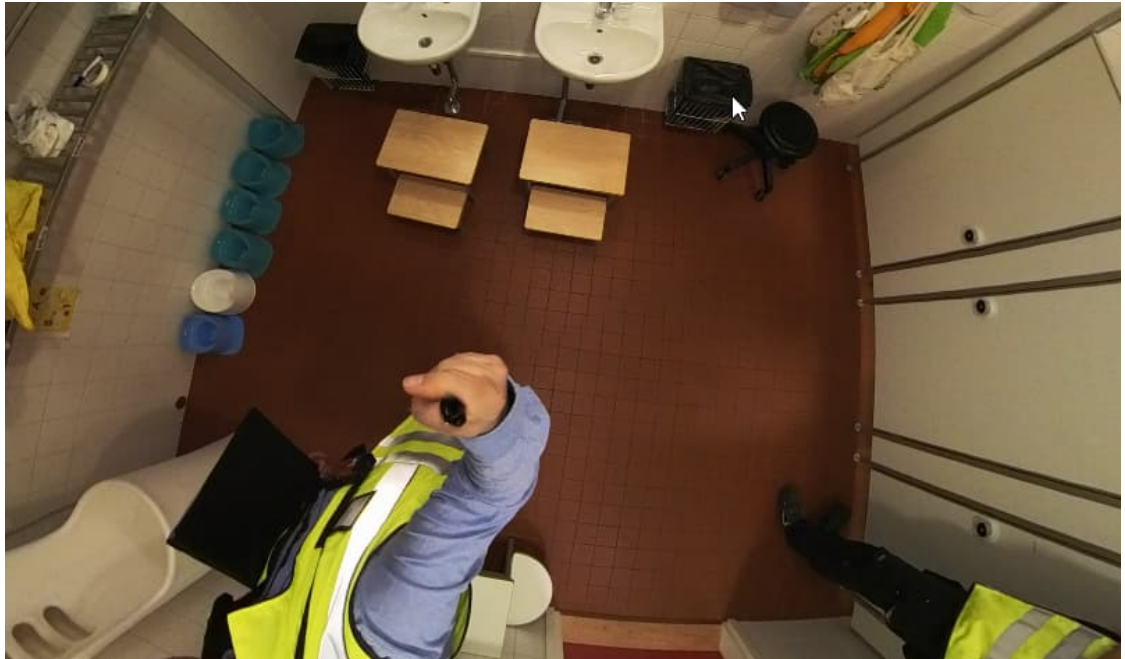
Kuva 21. Märkätilojen laatoitetut lattiapinnat ovat siistejä ja hyvässä kunnossa.
