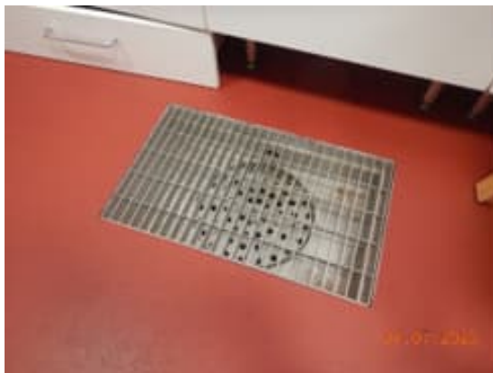
Kuva 20. Tilassa 120 työpaja on lattiakaivo, jossa on karkealle lialle likasihti. Kaivossa ja sihdissä on likaa ja kaivo haisee todella voimakkaasti.
