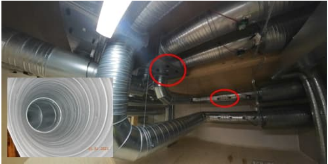
Kuva 75. 3. kerroksessa avattiin ilmanvaihtokanaviston tarkistusluukkuja ja tutkittiin aistinvaraisesti kanaviston puhtautta. Kanavistot vaikuttivat melko puhtailta.
