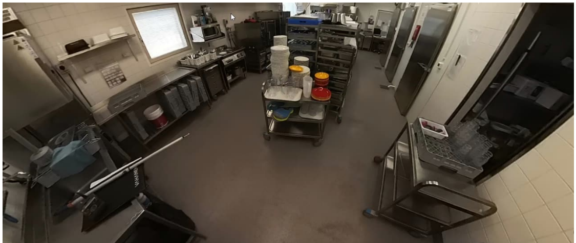
Kuva 14. Tilassa 116 keittiö on lattiapinnoitteena akryylibetoni. Lattiapinta vaikutti aistinvaraisesti havaittuna siistiltä ja toimivalta.
