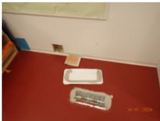
Kuva 58. Rakenneavaus RA14 tehtiin tilan 229 leikki väliseinään lähelle vuotanutta lattialämmityspotkea. Rakenneavauksen perusteella väliseinärakenne on pääasiassa suunnitelmien mukainen. Lattiavalu on
