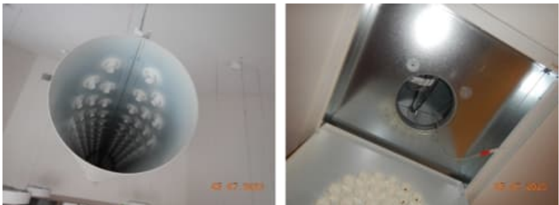
Kuva 76. Ilmanvaihdon päätelaitteita tutkittiin aistinvaraisesti niin 1. kuin 2. kerroksessa. Päätelaitteiden havaintojen perusteella ilmanvaihtokanavat ja niiden päätelaitteet vaikuttivat melko puhtailta.
