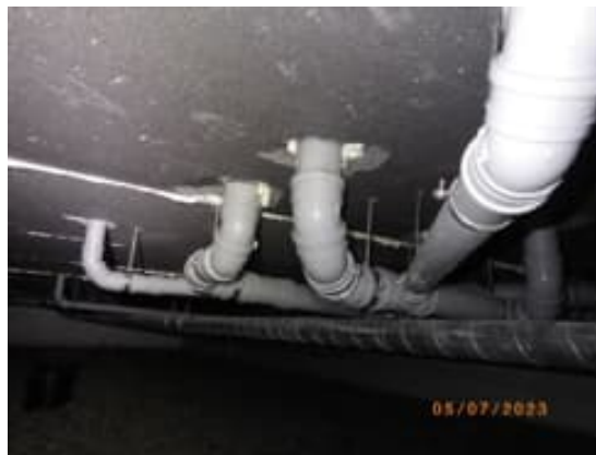
Kuva 10. Yleiskuva rakennuksen viemäriputkista. Putket ovat eristämättömiä. Putket ovat pääasiassa muovisia, mutta keittiön alueella putket ovat HST-terästä.
