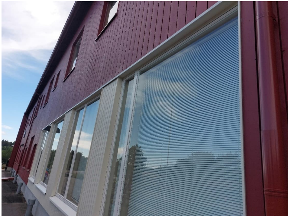
Kuva 29. Yleiskuva rakennuksen julkisivusta ja ikkunaliittymistä.
