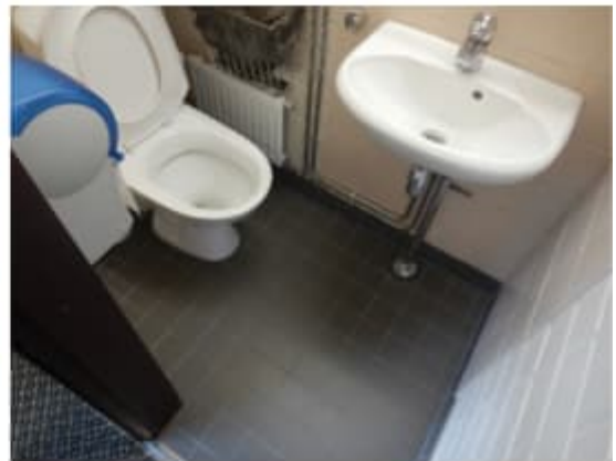
Kuva 56. a-b. Porrashuoneiden lattiapinnat mosaiikkibetonia ja märkätilat keraamista laattaa. Pinnoitteet olivat hyväkuntoisia.
