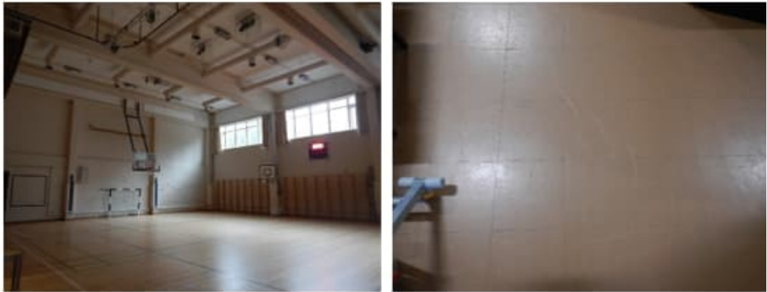
Kuva 25. a-b. Liikuntasalin lattia on puukoolattu. Varastotiloissa on havaintojen mukaan yhä vanha, peruskorjauksen edeltävä vinyylilaatta, joka oli selvästi kulunut.
