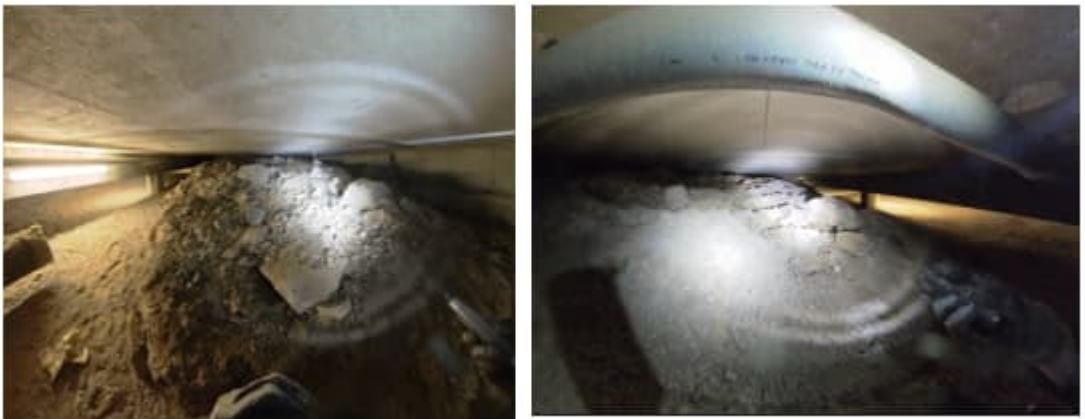
Kuva 31. a-b. Keskiosalla alustatilaa on kalliopinnan kohouma mikä nousee lähes alapohjan alapinnan tasolle.
