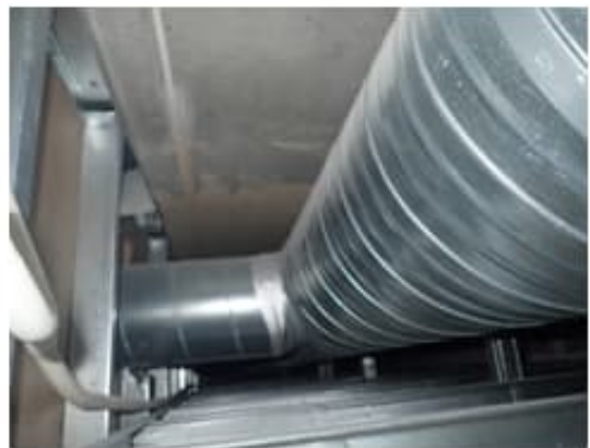
Kuva 169 a-b. Yleiskuva peruskorjauksen yhteydessä uusitusta kanavistosta.
