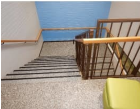
Kuva 56. a-b. Porrashuoneiden lattiapinnat mosaiikkibetonia ja märkätilat keraamista laattaa. Pinnoitteet olivat hyväkuntoisia.
