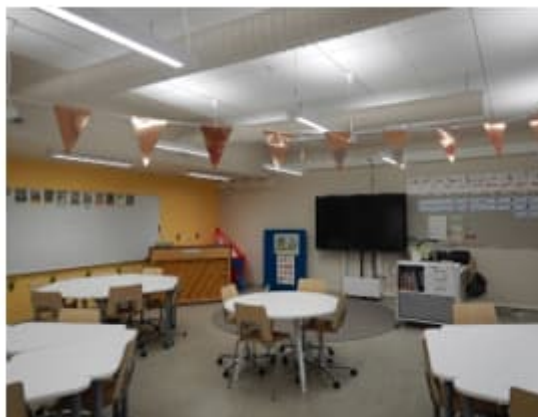
Kuva 57. a-b. Välipohjien alapinnat luokkatilojen osalla maalattuja ontelolaattapintoja joiden pintaan on liimattu pinnoitetut akustiikkalevyt
