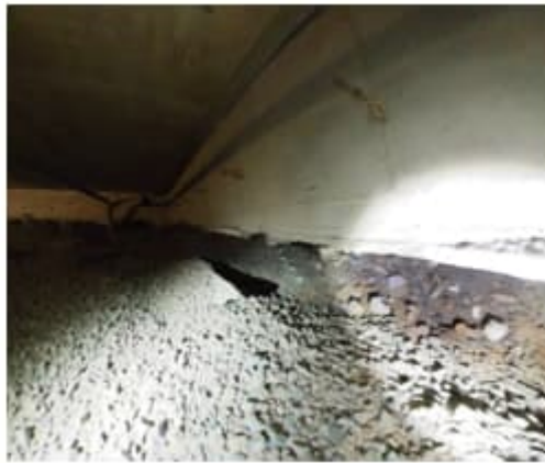
Kuva 33. a-b. Ulkoseinien vierustoilla maaperän havaittiin olevan myös märkää.
