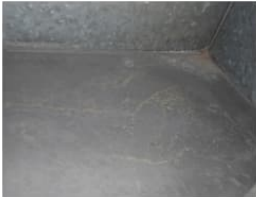
Kuva 162 a-b. Suodatinkammiossa havaittiin siitepölyä, pölyä ja vanhoja kosteusjälkiä.
