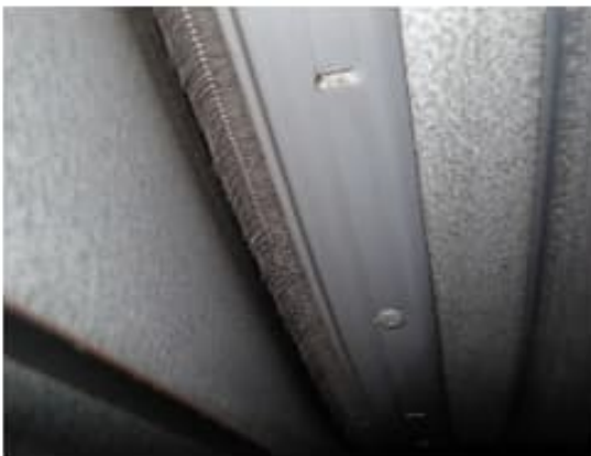
Kuva 164 a-b. LTO-kiekon harjatiivisteet ovat kuluneet.
