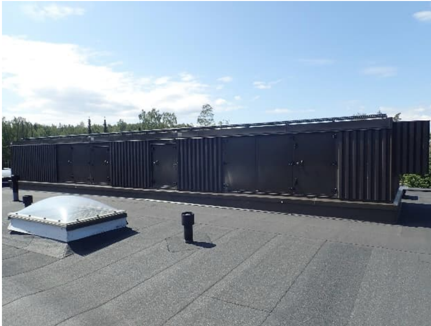
Kuva 127. Yleiskuva ilmanvaihtokonehuoneesta, jossa TK TF ja PF02 sijaitsevat.
