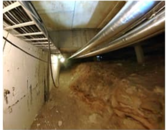
Kuva 36. a-b. 1.kerroksen luokkahuoneiden ja keittiön / ruokalan alapuolisen alustatila on pääosin kalliopinnalla.
