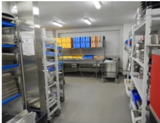
Kuva 55. a-b. Keittiön pintabetonilaatta on uusittu peruskorjauksen yhteydessä ja pinnoitteeksi on asennettu akryylibetonipinnoite. Pinnoite oli havaintojen mukaan ehjä mutta paikoin pinttyneen likainen.
