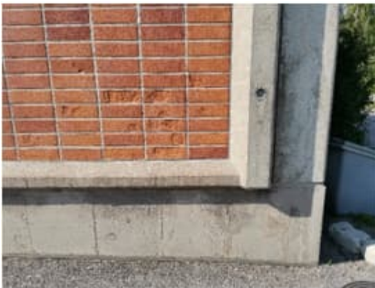
Kuva 67. a-b. Rapautuneita tiiliä havaittiin niin rakennuksen seinien yläosissa kuin alaosissa. Myös isohko ja syvä rakenneaurio tiilipinnassa rakennuksen pohjoissivulla.
