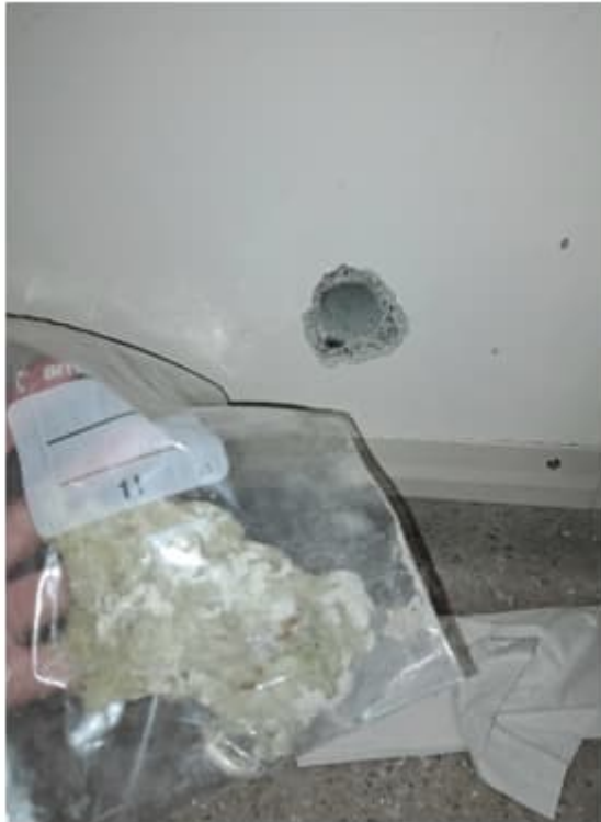
Kuva 87 a-b. Rakenneavaus RA14 tilan 119 ulkoseinän alaosaan. Avauksessa ei havaittu poikkeavaa hajua. Mineraalivillasta otettiin materiaalinäyte MN2 (liite 9) mikrobianalyysiä varten. Näytteessä todettiin mikrobikasvua.
