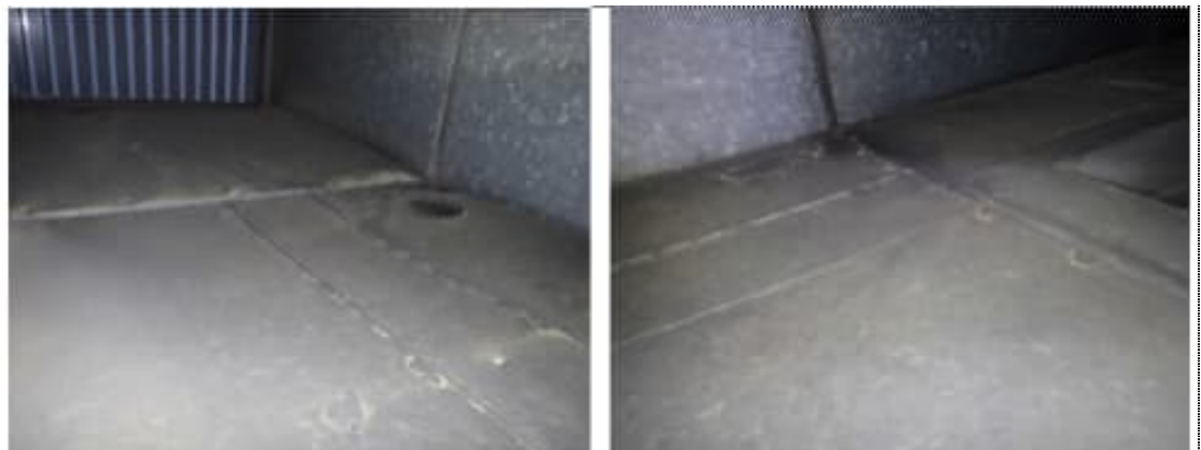
Kuva 134 a-b. TK03, TK04 ja TK05 yhteisessä raitisilmakammiossa havaittiin siitepölyä ja kosteusjälkiä. Raitisilmakammiossa ei ole viemärointipistettä.
