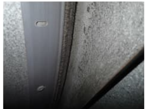
Kuva 164 a-b. LTO-kiekon harjatiivisteet ovat kuluneet.
