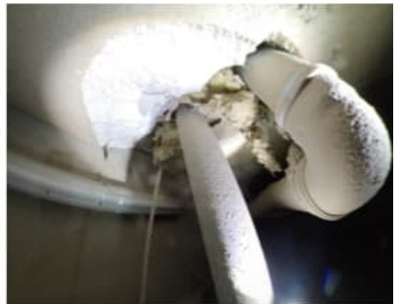
Kuva 34. a-b. Alapohjan lävistävät läpiviennit on tukittu mineraalivillalla.
