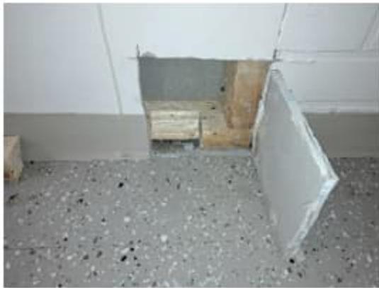
Kuva 106. Rakenneseavaus RA22 tilan 030 väliseinän levyrakenteeseen. Väliseinän alaohjauspuusta otettiin näyte N15 mikrobialalyysiä varten. Näytteessä ei todettu mikrobikasvua.
