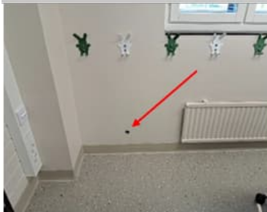
Kuva 84 a-b. Rakennusaukukset RA11 tilan 007 ulkoseinän alaosaan. Avauksesta betonista havaittiin lievä imelä haju, kuten itse tilassa. Mineraalivillasta otettiin materiaalinäyte N11 mikrobianalyysiä varten. Näytteessä todettiin mikrobikasvua.
