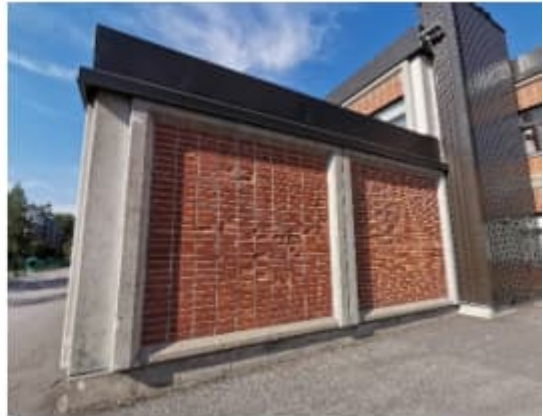
Kuva 66. a-b. Sandwich-elementtien tiilipinnat olivat pääosin siistit, mutta eriasteista pakkasvaurioon viittaavaa rapautumaa havaittiin lähes kaikilla rakennuksen julkisivuilla.
