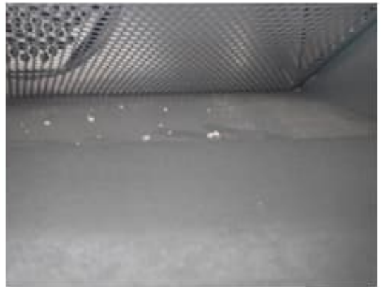
Kuva 175 a-b. Tuloilmapäätelaitteissa havaittiin pölykertymää ja mahdollisesti peruskorjauksen aikaista raskaampaa rakennusaikaista jätettä.
