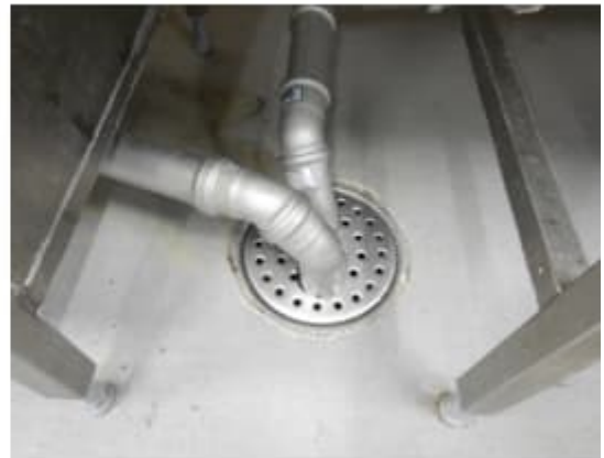
Kuva 55. a-b. Keittiön pintabetonilaatta on uusittu peruskorjauksen yhteydessä ja pinnoitteeksi on asennettu akryylibetonipinnoite. Pinnoite oli havaintojen mukaan ehjä mutta paikoin pinttyneen likainen.
