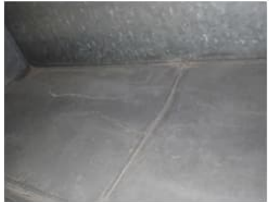
Kuva 162 a-b. Suodatinkammiossa havaittiin siitepölyä, pölyä ja vanhoja kosteusjälkiä.
