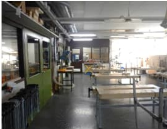
Kuva 23. a-b. Teknisentilan lattiapinnoitteena on kolikkokuvioinen muovimatto ja keramiikkatilassa epoksinnoite. Pinnoitteet olivat pääosin hyväkuntoisia.
