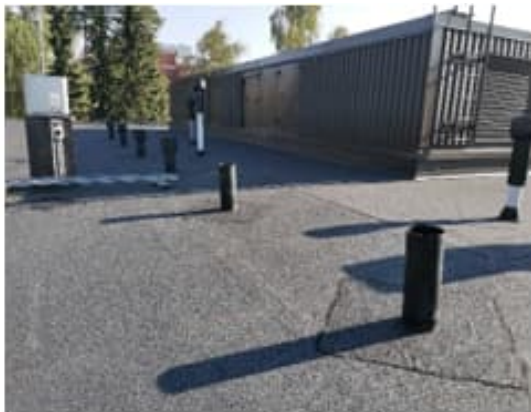
Kuva 117 a-b. Alipaintuulettimien hattuja oli havaintojen mukaan irrotettu / irronnut useita.
