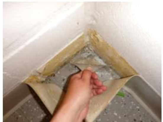
Kuva 20. a-b. Opetustilojen kvartsivinyylilaattapinnoitteet olivat siistit. Muovijalkalistaa avattiin tilasta 043 ja tarkastettiin alapohjaliittymiin vuoden 2013 sisäilmakorjausten yhteydessä asennetut tiivistyskaistat. Erillistä butyyliinauhalla tiivistyskaistaa ei havaittu. Liittymässä havaittiin elastinen massa alapohjan ja ulkoseinän liittymässä.
