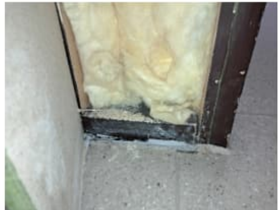
Kuva 106. Rakenneseavaus RA22 tilan 030 väliseinän levyrakenteeseen. Väliseinän alaohjauspuusta otettiin näyte N15 mikrobialalyysiä varten. Näytteessä ei todettu mikrobikasvua.
