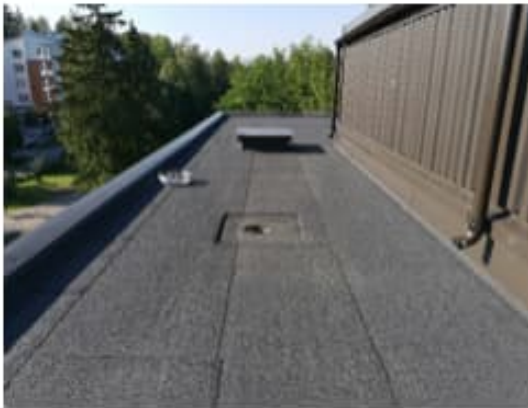
Kuva 119 a-b. Myös kattokaivojen lehtisihtejä oli irronnut kovan tuulen vaikutuksesta.
