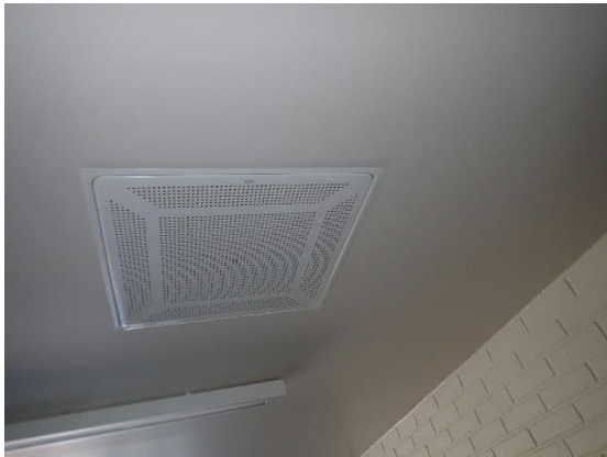
Kuva 174. Yleiskuva poistoilmapäätelaitteesta.
