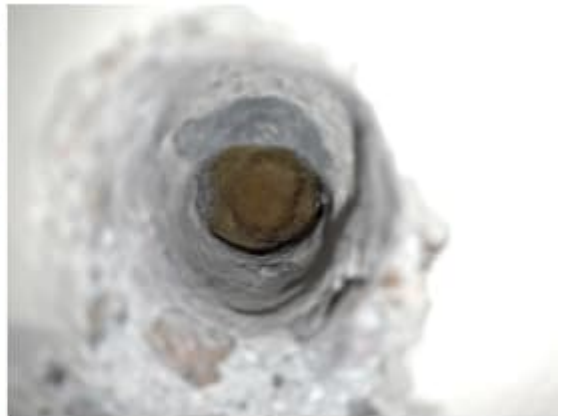
Kuva 79 a-b. Rakenneavaus RA6 tilan 108 ulkoseinän alaosaan. Avauksessa ei havaittu poikkeavaa hajua. Mineraalivillasta otettu materiaalinäytteessä N2 ei havaittu mikrobikasvua materiaalissa.
