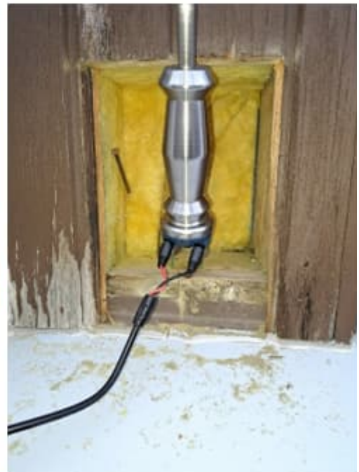
Kuva 87 a-b. Rakenneavaus RA14 tilan 119 ulkoseinän alaosaan. Avauksessa ei havaittu poikkeavaa hajua. Mineraalivillasta otettiin materiaalinäyte MN2 (liite 9) mikrobianalyysiä varten. Näytteessä todettiin mikrobikasvua.
