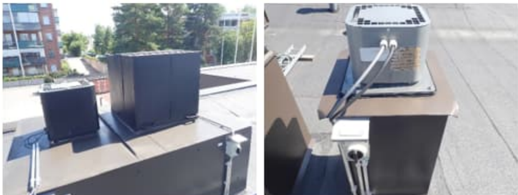
Kuva 168 a-b. Yleiskuvia vesikatolla sijaitsevistä huippuimureista.
