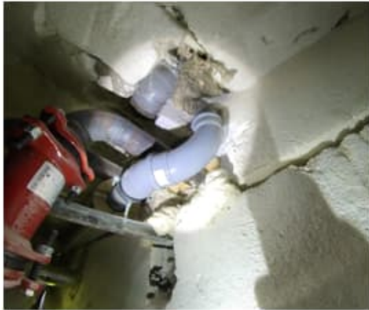
Kuva 40. a-b. Alapohjan läpiviennit oli myös paikoin tukittu mineraalivillalla. Myös alapohjan alapuolisessa Styrox-levyssä havaittiin kauttaaltaan kellastumaa ja likaisuutta.
