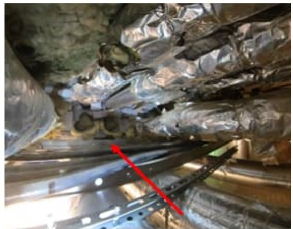
Kuva 39. a-c. Maanvastaisen seinän ulkopinnassa on havaintojen mukaan bitumisively. Seinän läpiviennit olivat paikoin avoinna, paikoin tukittu mineraalivillalla ja paikoin uretaanilla.
