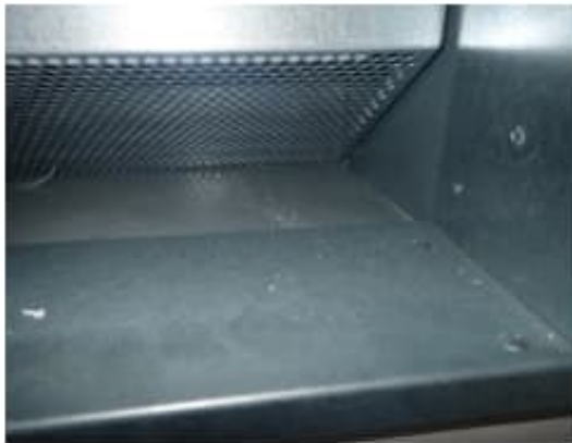
Kuva 175 a-b. Tuloilmapäätelaitteissa havaittiin pölykertymää ja mahdollisesti peruskorjauksen aikaista raskaampaa rakennusaikaista jätettä.
