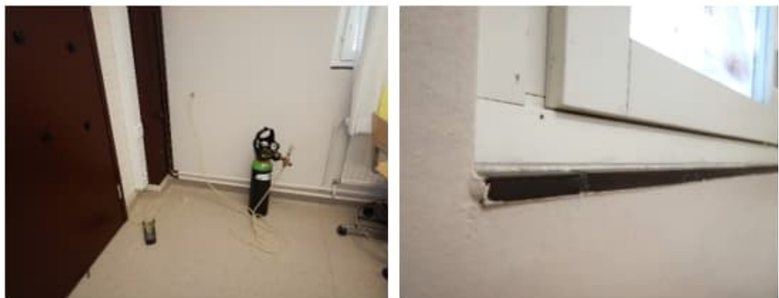
Kuva 92. a-b. Merkkiainekoe MK5 tilan 153 ulkoseinärakenteeseen. Ilmavuotoja ei havaittu.
