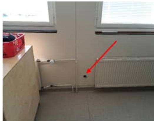
Kuva 80 a-b. Rakenneavaus RA7 tilan 109 ulkoseinän alaosaan. Avauksessa ei havaittu poikkeavaa hajua. Mineraalivillasta otettu materiaalinäytteessä N3 ei havaittu mikrobikasvua materiaalissa.
