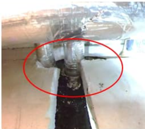
Kuva 39. a-c. Maanvastaisen seinän ulkopinnassa on havaintojen mukaan bitumisively. Seinän läpiviennit olivat paikoin avoinna, paikoin tukittu mineraalivillalla ja paikoin uretaanilla.
