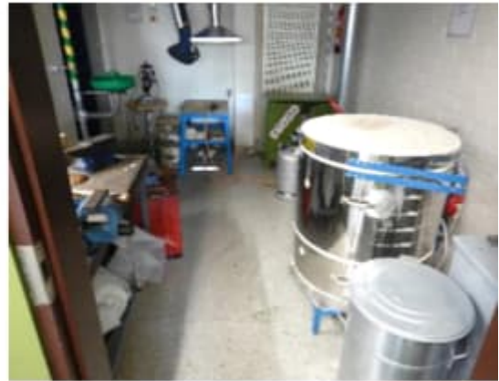
Kuva 23. a-b. Teknisentilan lattiapinnoitteena on kolikkokuvioinen muovimatto ja keramiikkatilassa epoksinnoite. Pinnoitteet olivat pääosin hyväkuntoisia.
