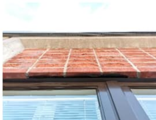
Kuva 67. a-b. Rapautuneita tiiliä havaittiin niin rakennuksen seinien yläosissa kuin alaosissa. Myös isohko ja syvä rakenneaurio tiilipinnassa rakennuksen pohjoissivulla.
