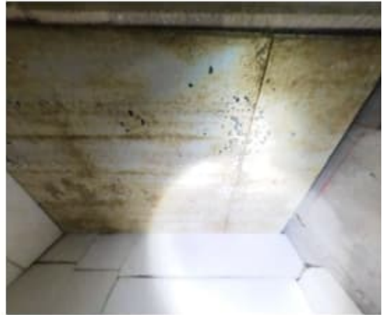
Kuva 40. a-b. Alapohjan läpiviennit oli myös paikoin tukittu mineraalivillalla. Myös alapohjan alapuolisessa Styrox-levyssä havaittiin kauttaaltaan kellastumaa ja likaisuutta.
