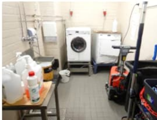
Kuva 24. a-b. Märkätiloissa oleva keraaminenlaatoitus oli havaintojen mukaan siisti. Keraamisten laattojen alla vuoden 2016 peruskorjauksen yhteydessä asennettu Ardex-vedeneriste. Pukuhuoneiden 059 ja 068 vastaisten pesuhuoneiden ovien edustalla havaittiin paikallisesti kohonneita pintakosteusilmaisimen vertailuarvoja n. 2 m x 2 m kokoiselta alueelta.
