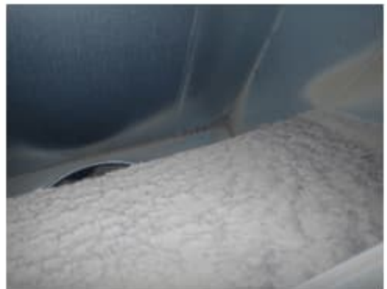
Kuva 176 a-b. Poistoilmapäätelaitteissa havaittiin runsaasti pölykertymää
