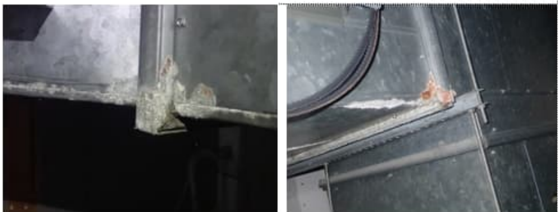
Kuva 134 a-b. TK03, TK04 ja TK05 yhteisessä raitisilmakammiossa havaittiin siitepölyä ja kosteusjälkiä. Raitisilmakammiossa ei ole viemärointipistettä.
