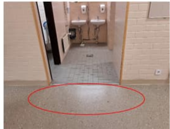
Kuva 24. a-b. Märkätiloissa oleva keraaminenlaatoitus oli havaintojen mukaan siisti. Keraamisten laattojen alla vuoden 2016 peruskorjauksen yhteydessä asennettu Ardex-vedeneriste. Pukuhuoneiden 059 ja 068 vastaisten pesuhuoneiden ovien edustalla havaittiin paikallisesti kohonneita pintakosteusilmaisimen vertailuarvoja n. 2 m x 2 m kokoiselta alueelta.
