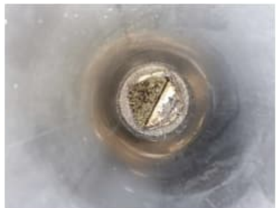
Kuva 117 a-b. Alipaintuulettimien hattuja oli havaintojen mukaan irrotettu / irronnut useita.
