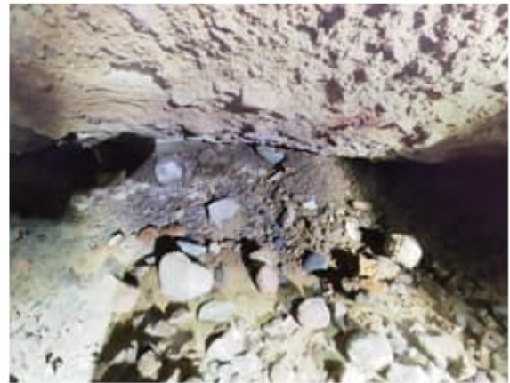
Kuva 33. a-b. Ulkoseinien vierustoilla maaperän havaittiin olevan myös märkää.
