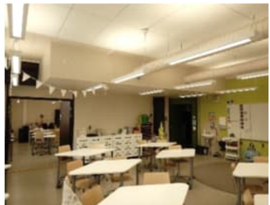
Kuva 57. a-b. Välipohjien alapinnat luokkatilojen osalla maalattuja ontelolaattapintoja joiden pintaan on liimattu pinnoitetut akustiikkalevyt
