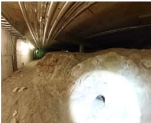
Kuva 37. a-b. Alustatilat olivat pääosin siistit. Tila pääsee kauttaaltaan tuulettumaan, eikä kallio nouse alapohjan alapinnan tasoon kuten liikuntasalin osalla.
