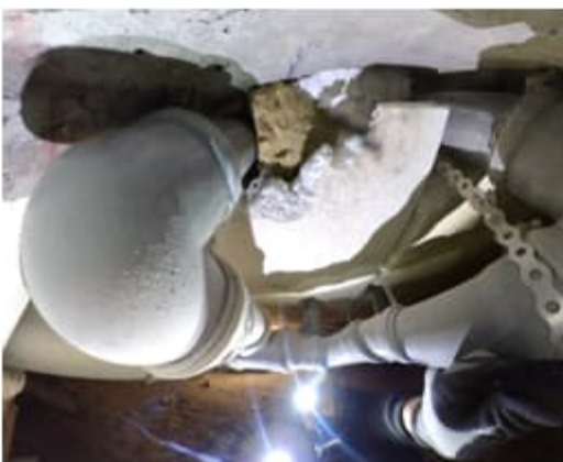
Kuva 35. a-b. Alapohjan lävistävät läpiviennit vaikuttivat alhaalta tarkasteltuna epätiivailtä. Lisäksi viemärit on kannakoitu puutteellisesti reikänauhalla.
