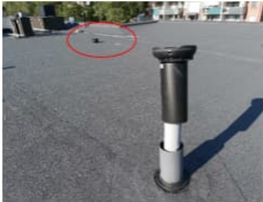
Kuva 118 a-b. Yhden alipainetuuletin oli osittain irti mahdollisen ilkivallan seurauksena. Katolla havaittiin myös paikoin pellettimäisiä aktiivihiilirakeita.
