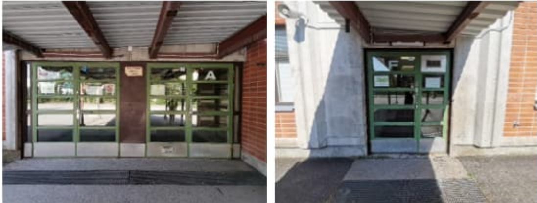
Kuva 75. a-b. Teräsrakenteisten ulko-ovien maalipinnat olivat pääosin tyydyttävässä kunnossa. Lasituksissa ei havaittu vaurioita tai puutteita.
