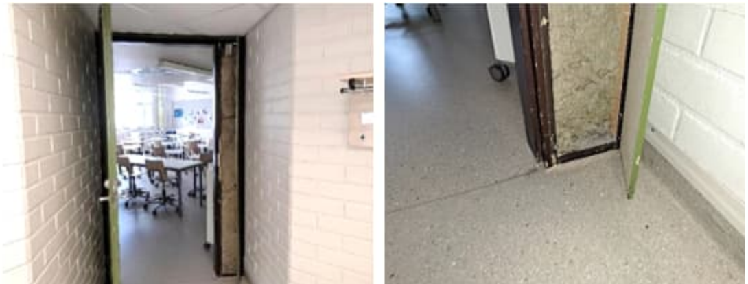
Kuva 101 a-b. Rakenneavaus RA17 tilan 107 oven viereiseen kotelointiin. Eristeenä olevasta mineraalivillasta otettiin materiaalinäyte N4 mikrobianalyysiä varten. Näytteessä ei todettu mikrobikasvua.
