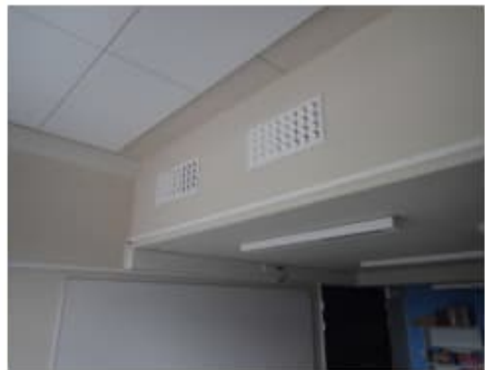
Kuva 173 a-b. Yleiskuvia tuloilmapäätelaitteista.
