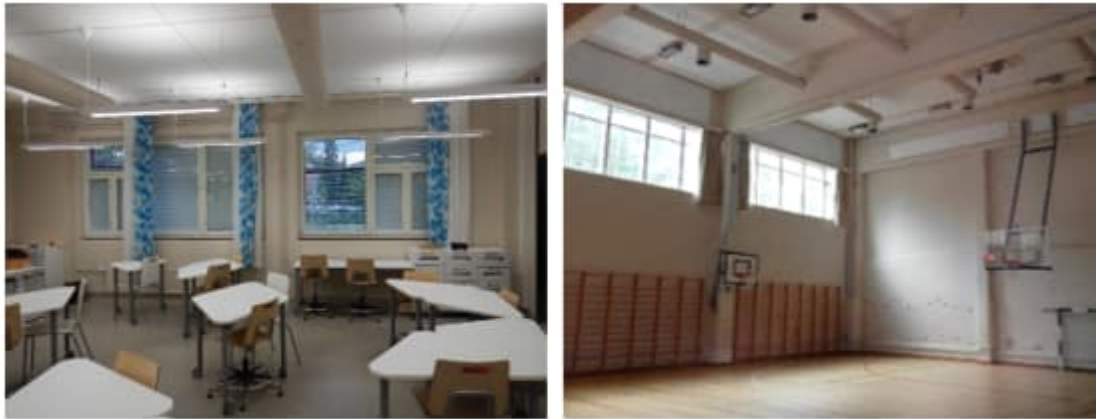
Kuva 64. a-b. Seinien sisäpinnat ovat pääosin tasoitettu ja maalattuja. Sisäpinnoissa ei havaittu aistinvaraisesti vaurioita tai viitteitä kosteusrasituksesta.
