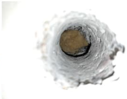
Kuva 85 a-b. Rakennusaukukset RA12 tilan 030 ulkoseinän alaosaan. Avauksessa ei havaittu poikkeavaa hajua. Mineraalivillasta otettu materiaalinäyte N14 ei havaittu mikrobikasvua materiaalissa.
