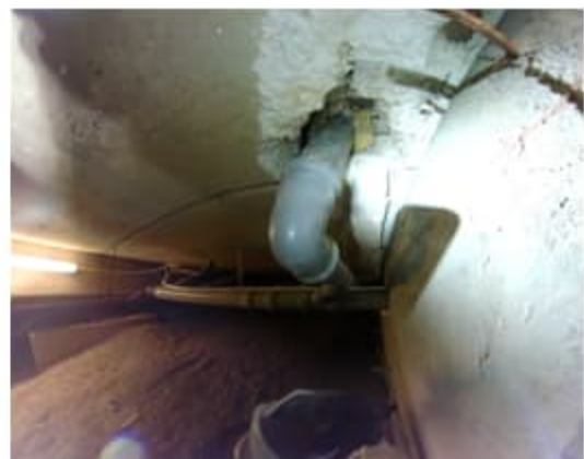
Kuva 35. a-b. Alapohjan lävistävät läpiviennit vaikuttivat alhaalta tarkasteltuna epätiivailtä. Lisäksi viemärit on kannakoitu puutteellisesti reikänauhalla.
