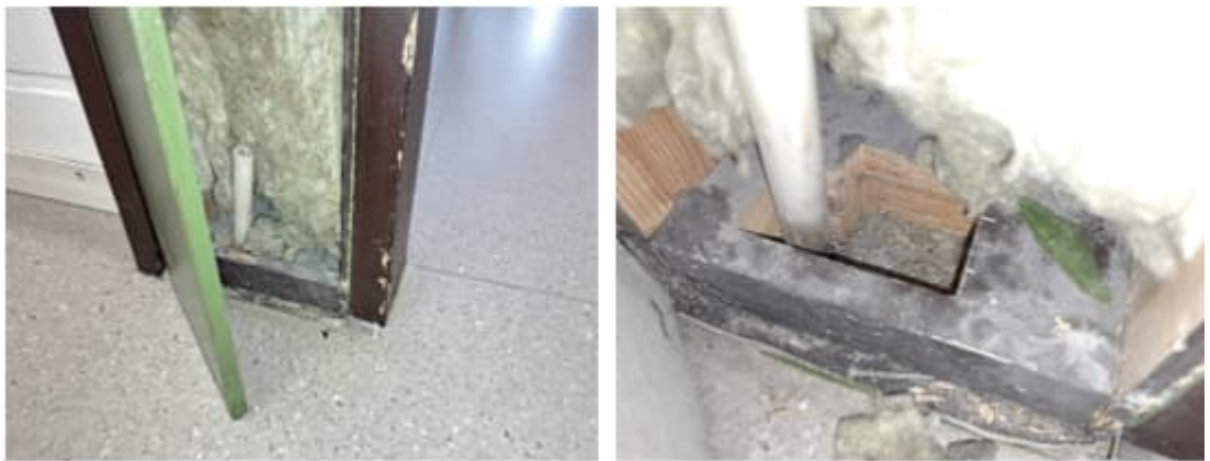
Kuva 101 a-b. Rakenneavaus RA17 tilan 107 oven viereiseen kotelointiin. Eristeenä olevasta mineraalivillasta otettiin materiaalinäyte N4 mikrobianalyysiä varten. Näytteessä ei todettu mikrobikasvua.
