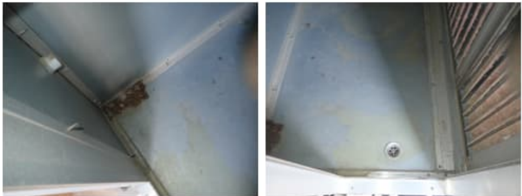
Kuva 122 a-b. Raitisilmakammiossa havaittiin kuolleita hyönteisiä, siitepölyä ja kosteusjälkiä.
