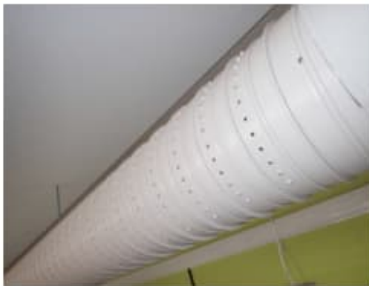
Kuva 173 a-b. Yleiskuvia tuloilmapäätelaitteista.
