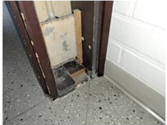
Kuva 105 a-b. Rakenneseavaus RA21 tilan 008 oven viereiseen kotelointiin. Eristeenä olevasta mineraalivillasta otettiin materiaalinäyte N13 mikrobialalyysiä varten. Näytteessä todettiin mikrobikasvua.
