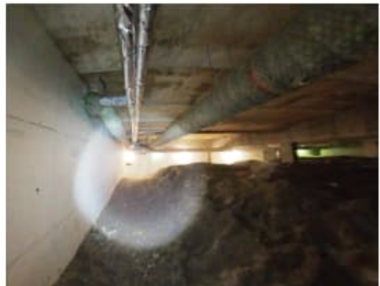
Kuva 37. a-b. Alustatilat olivat pääosin siistit. Tila pääsee kauttaaltaan tuulettumaan, eikä kallio nouse alapohjan alapinnan tasoon kuten liikuntasalin osalla.
