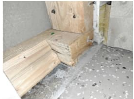
Kuva 106. Rakenneseavaus RA22 tilan 030 väliseinän levyrakenteeseen. Väliseinän alaohjauspuusta otettiin näyte N15 mikrobialalyysiä varten. Näytteessä ei todettu mikrobikasvua.
