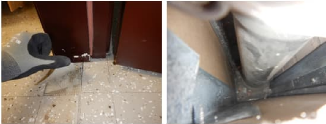
Kuva 21. a-b. Tilojen 043 ja 044 välisen oven jalkalistan alla ei havaitu ilmayhteyksiä alapohjaan. Lista oli kiinnitetty liimaamalla. Myöskään pistokokeenomaisesti tarkastetussa viemäriläpiviennin koteloinnin alaosassa ei havaittu selviä ilmayhteyksiä alapohjarakenteeseen.
