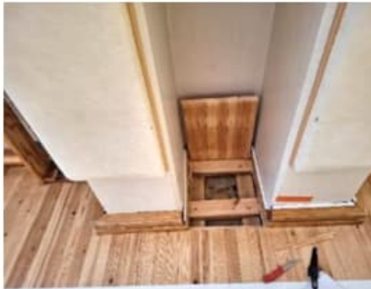
Kuva 28. a-b. Porareikämittaukset liikuntasalin alapohjaan. Mittapisteet alapohjaan (B7: 67,6 %RH ja B8: 69,2 %RH)
