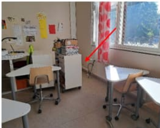
Kuva 78 a-b. Rakenneavaus RA5 tilan 107 ulkoseinän alaosaan. Avauksessa ei havaittu poikkeavaa hajua. Mineraalivillasta otettu materiaalinäytteessä N1 ei havaittu mikrobikasvua materiaalissa.
