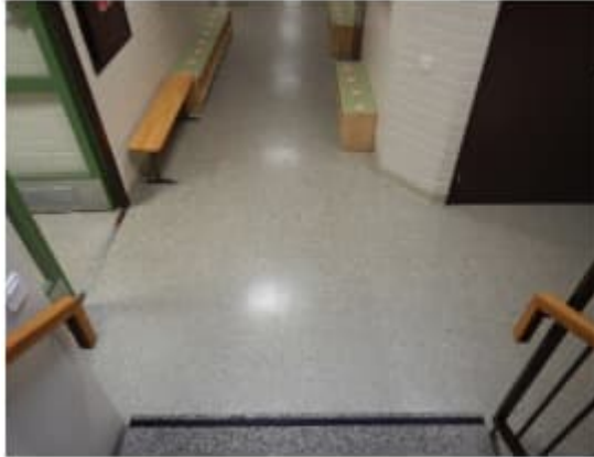
Kuva 19. a-b. Pohjakerroksen kvartsivinyylilaatta pinnoitteet olivat havaintojen mukaan siistit. Kohonneita vertailuarvoja havaittiin pintakosteusilmaisimella vain paikallisesti käytävän osalta (90–115).
