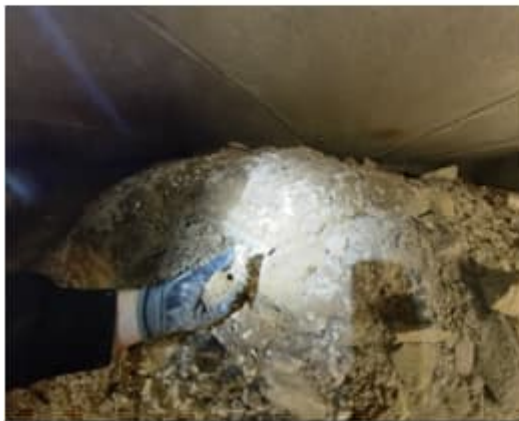
Kuva 32. a-b. Kalliopinnan kohouman päällä oleva maa-aines on selvästi märkää ja pinnalla kasvaa valkoista sienikasvustoa ja yksittäisiä kuivuneita sieniä.
