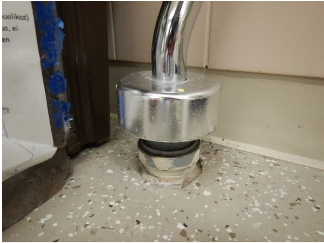
Kuva 46. a. Alapohjan läpivienteihin on asennettu elastinen massaus, ja läpiviennit olivat aistinvaraisten havaintojen mukaan tiiviitä.
