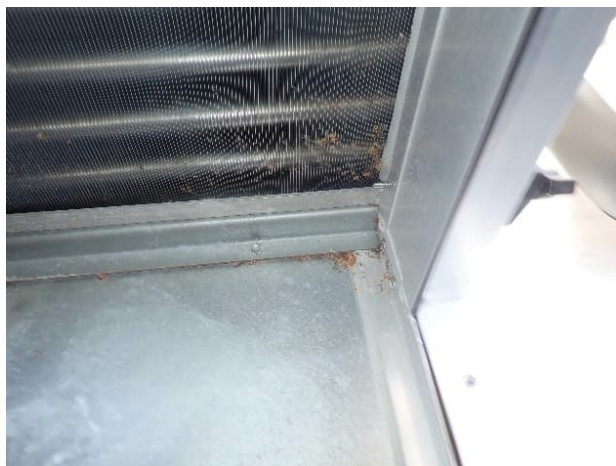
Kuva 122 a-b. Raitisilmakammiossa havaittiin kuolleita hyönteisiä, siitepölyä ja kosteusjälkiä.
