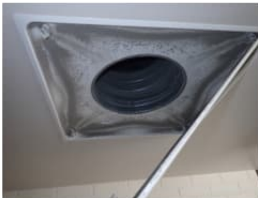
Kuva 176 a-b. Poistoilmapäätelaitteissa havaittiin runsaasti pölykertymää
