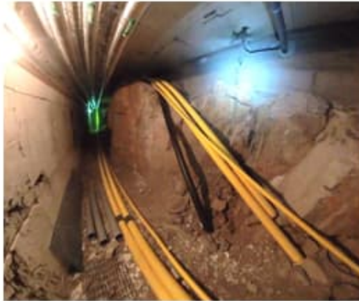
Kuva 36. a-b. 1.kerroksen luokkahuoneiden ja keittiön / ruokalan alapuolisen alustatila on pääosin kalliopinnalla.
