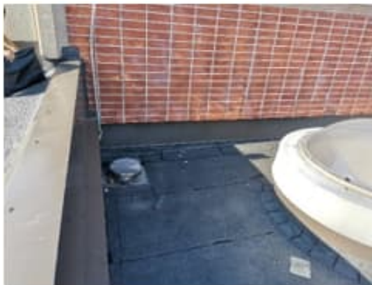
Kuva 119 a-b. Myös kattokaivojen lehtisihtejä oli irronnut kovan tuulen vaikutuksesta.
