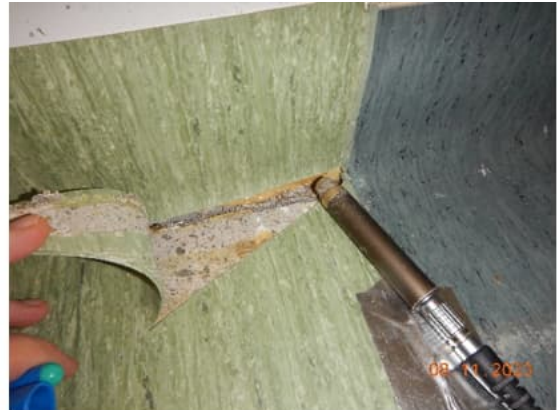
Kuva 29. Alapohjaliittymässä havaittiin runsasta vuoto maton ylösnoston nurkasta, joka johtuu epätiiviyistä alapohjaliittymästä.
