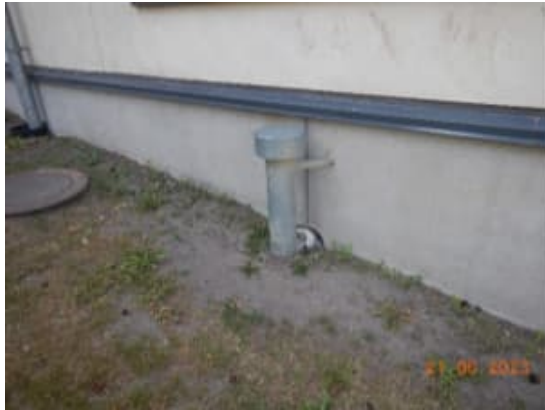
Kuva 42. Rakennuksen eteläseinustalla on läpivienti sokkelirakenteisiin. Läpiviennin rakenneliittymä on epätiivis.
