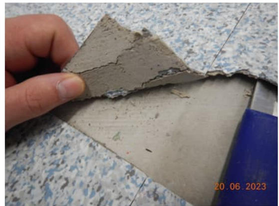
Kuva 16. Pääosin lattiapinnoitteena oleva muovilaatta irtosi paikoin alustastaan eri puolilla rakennusta 1. kerroksen kohdalla. Irtoavien palojen pohjaan jää tasoitekerrosta ja muovilaatan alapinnassa on vahamainen haju. Hajua ei ole materiaalin yläpinnassa. Muovilaatta on irtoavalta alueelta haurasta ja murenevaa.
