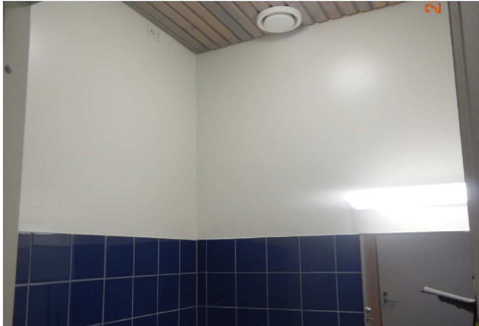
Kuva 31. Kellarin seinäpinnat ovat maalattuja tai laatoitettuja. Seinäpinnat ovat siistit ja hyväkuntoiset.
