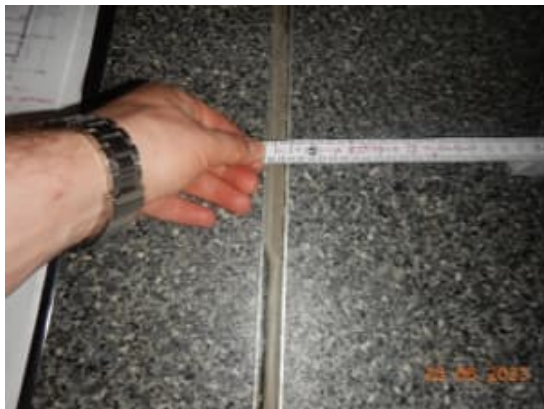
Kuva 53. Tilassa 238 Kokous on lattiassa liikuntasauva, jonka leveys on tutkitulla kohtaa noin 20 mm. Saumassa oleva elastinen saumamassa on osin irti ja painunut syvälle liikuntasaumaan.
