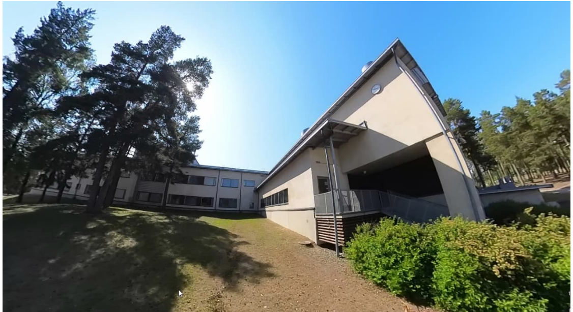
Kuva 37. Rajakylän koulun julkisivu takapihan puolelle itään. Julkisivu on pääosin rapattu. Seinällä on nähtävillä nauhamaisia ikkunoita, jotka sijoittuvat 1. ja 2. kerroksen luokkahuoneiden kohdalle.
