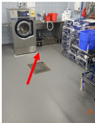
Kuva 12. Tilan 014 Siivouskeskus lattiakaivon ja lattiapinnan rakenneliitokseen on levitetty paksusti mustaa teippiä.
