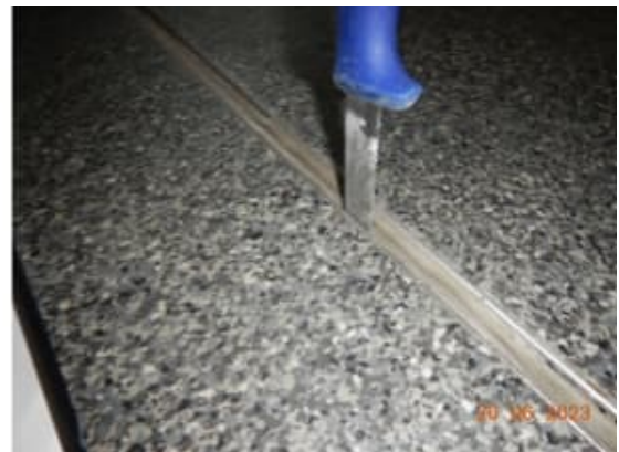
Kuva 53. Tilassa 238 Kokous on lattiassa liikuntasauva, jonka leveys on tutkitulla kohtaa noin 20 mm. Saumassa oleva elastinen saumamassa on osin irti ja painunut syvälle liikuntasaumaan.
