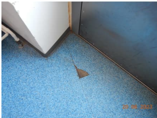
Kuva 16. Pääosin lattiapinnoitteena oleva muovilaatta irtosi paikoin alustastaan eri puolilla rakennusta 1. kerroksen kohdalla. Irtoavien palojen pohjaan jää tasoitekerrosta ja muovilaatan alapinnassa on vahamainen haju. Hajua ei ole materiaalin yläpinnassa. Muovilaatta on irtoavalta alueelta haurasta ja murenevaa.
