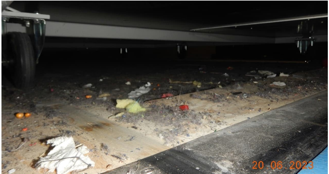
Kuva 54. Liikuntasalin näyttämön alla on säilytystila. Säilytystilassa on pitkät kelkat, joiden kyytiin on varastoitu liikuntasalissa käytettäviä tavaroita. Kelkkojen alla on todella paljon roskaa ja pölyä.
