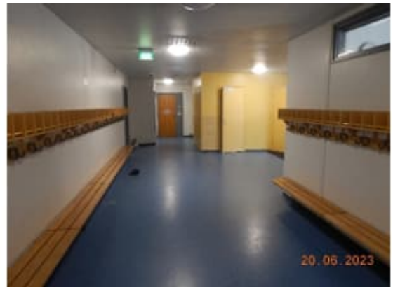
Kuva 52. Yleiskuva 2. kerroksen käytävään sekä luokkatilaan. Tilojen lattioissa on käytetty harmahtavaa ja sinistä muovilaattaa.
