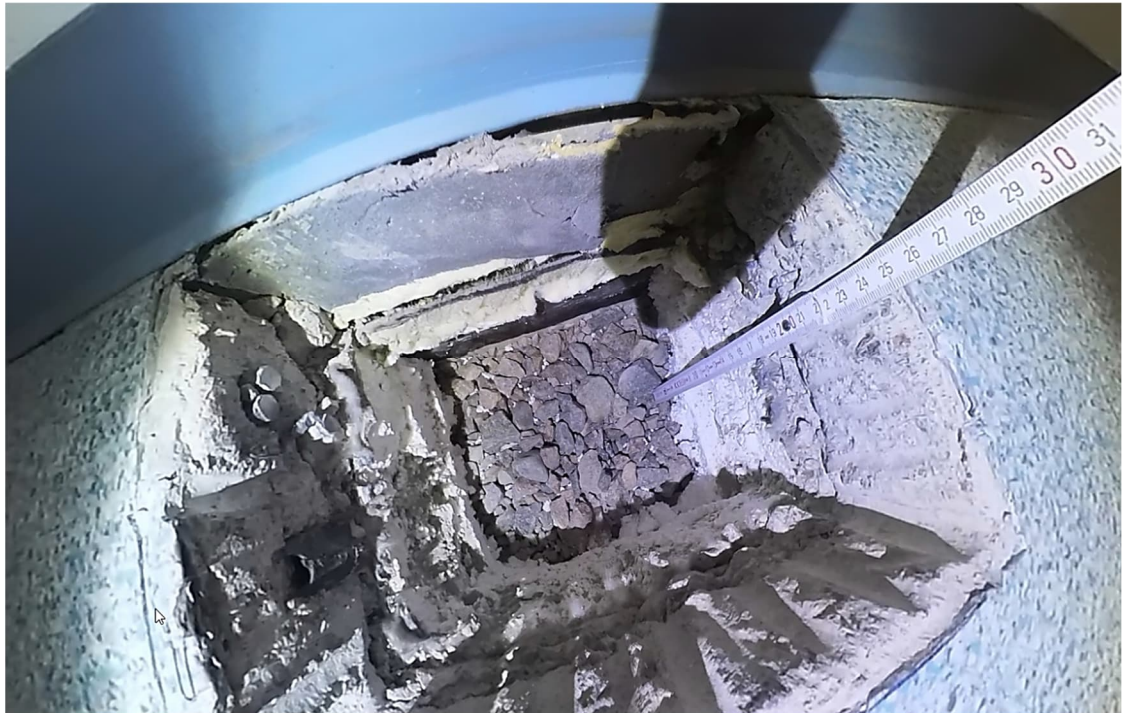
Kuva 23. Rakenneavaus RA2 tehtiin tilan 127 lattiarakenteeseen. Rakenneavaus ulotettiin aina alapohjan sepelikerrokseen saakka. Avauksen perusteella rakenne on suunnitelmien mukainen. Avauksesta ei todettu normaalista poikkeavaa hajua.
