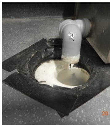
Kuva 12. Tilan 014 Siivouskeskus lattiakaivon ja lattiapinnan rakenneliitokseen on levitetty paksusti mustaa teippiä.
