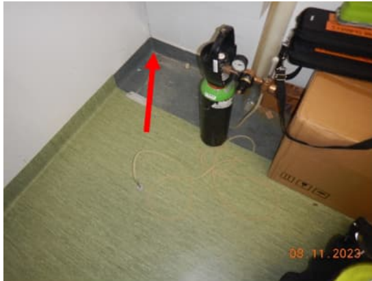
Kuva 29. Alapohjaliittymässä havaittiin runsasta vuoto maton ylösnoston nurkasta, joka johtuu epätiiviyistä alapohjaliittymästä.
