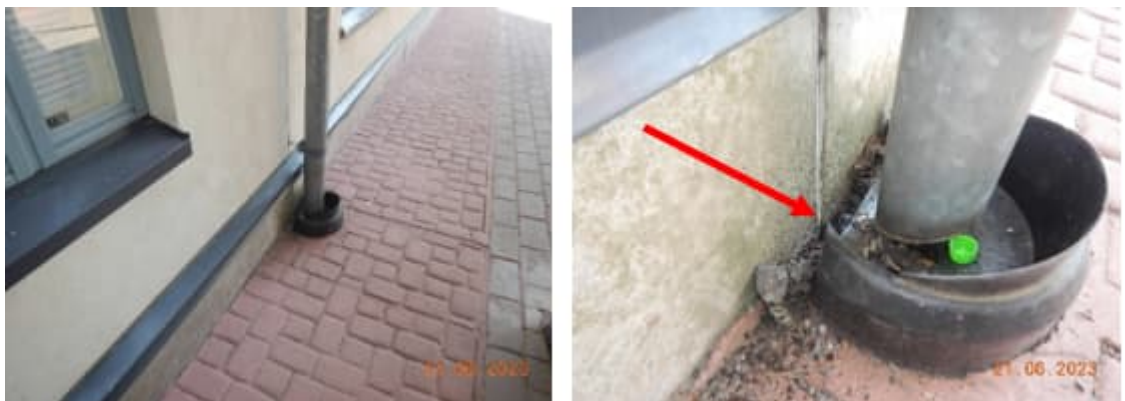
Kuva 7. Ruokalan sisäänkäynnin edustalla oleva sadevesikaivo ohjaa suuren osan sadevesistä sokkelirakenteeseen.
