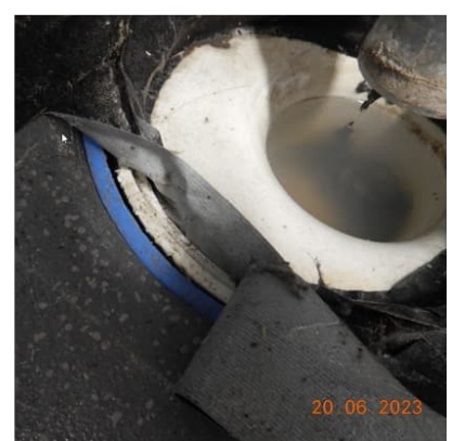
Kuva 12. Tilan 014 Siivouskeskus lattiakaivon ja lattiapinnan rakenneliitokseen on levitetty paksusti mustaa teippiä.
