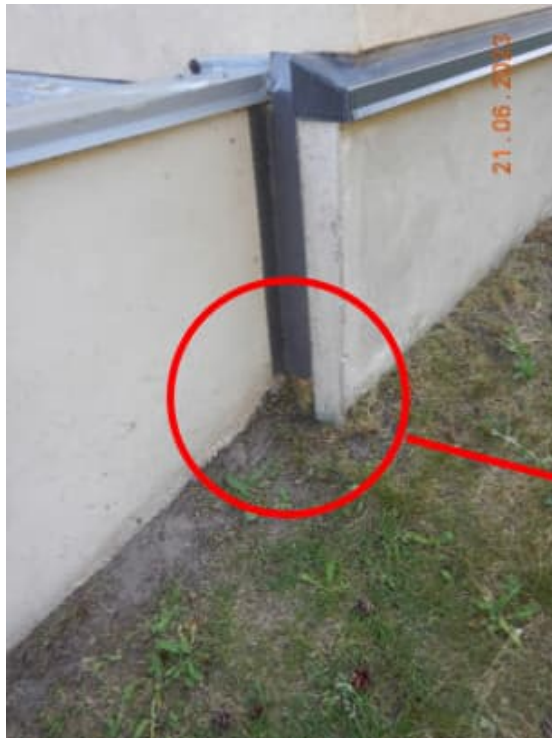
Kuva 43. Rakennuksen pohjoissivulla on näkyvissä ulkoseinärakenteen eristetila. Eristetilaa on suojattu pellityksellä, mutta pellitys ei jatku riittävän alas. Maanpinnan alapuolelta tilannetta ei tässä tutkimuksessa tutkittu, mutta voi olla mahdollista, että eristetila on avoin myös maan alla.
