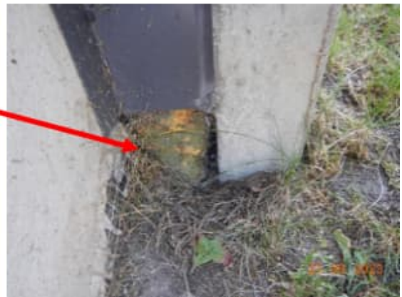
Kuva 43. Rakennuksen pohjoissivulla on näkyvissä ulkoseinärakenteen eristetila. Eristetilaa on suojattu pellityksellä, mutta pellitys ei jatku riittävän alas. Maanpinnan alapuolelta tilannetta ei tässä tutkimuksessa tutkittu, mutta voi olla mahdollista, että eristetila on avoin myös maan alla.
