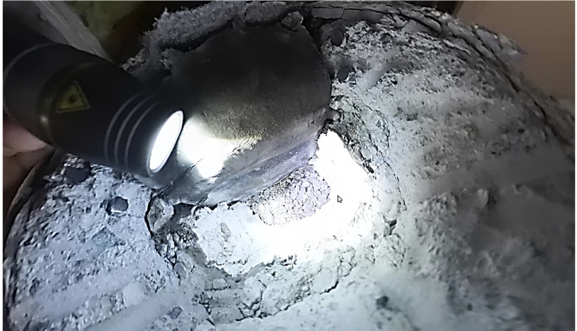
Kuva 22. Rakenneavaus RA1 tehtiin tilan 126 lattiarakenteeseen.
