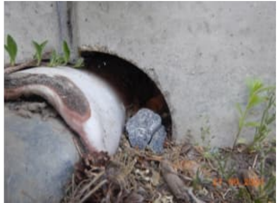
Kuva 42. Rakennuksen eteläseinustalla on läpivienti sokkelirakenteisiin. Läpiviennin rakenneliittymä on epätiivis.
