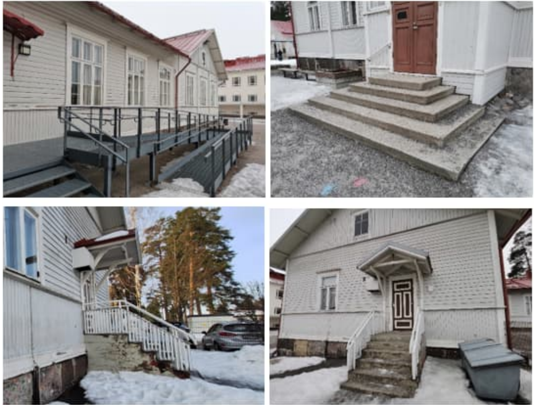
Kuva 6. Kirjaston pääsisäänkäynniksi on vuonna 2014 asennettu metallirakenteinen luiska ja porras -yhdistelmä sekä vuonna 2001 uusittu pääsisäänkäynnin edustalle betoniportaikko. Molemmat rakenteet olivat havaintojen mukaan hyväkuntoisia. Idänpuoleisen sisäänkäynnin betoniportaissa havaittiin maalipinnan hilseilyä, yleistä kulumaa sekä tasopinnoille kasaantunutta jäätä, joka hankaloittaa portaiden käyttöä.
