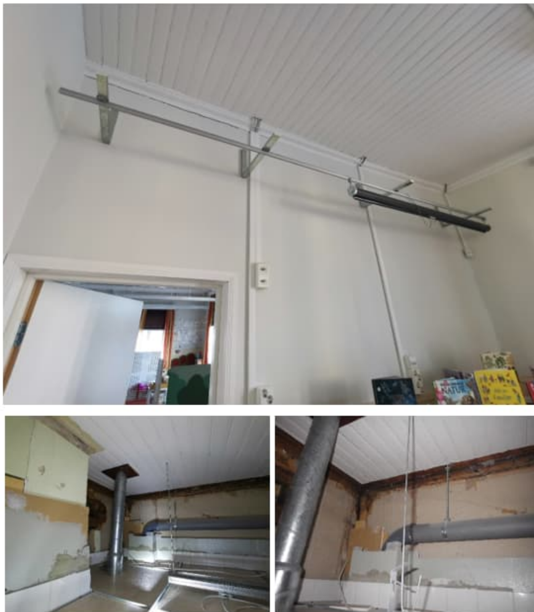
Kuva 38. Tilojen 103P ja 105P välinen väliseinä on ollut ennen laajennusosan rakennusta ulkoseinä. Wc-tilan 104P alaslaskutilan taakse, seinien yläosiin on jätetty näkyviin vanhat pintamateriaalit sekä hirsiseinät ja hirsien väliset rive-eristeet.
