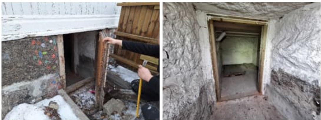
Kuva 21. Ryömintätilassa on lisäksi erillinen kellari, johon on kulku ulkokautta. Kellarin luukku oli ruuvattu kiinni ja luukun edessä oli sisäänkäyntisyvennyksen peittävä puuritelikkö. Kellarissa ei havaittu ylimääräistä kosteutta tai merkittäviä hajuja. Kellarista on tuuletusputki ulos luonnonkiviperusmuurin läpi.
