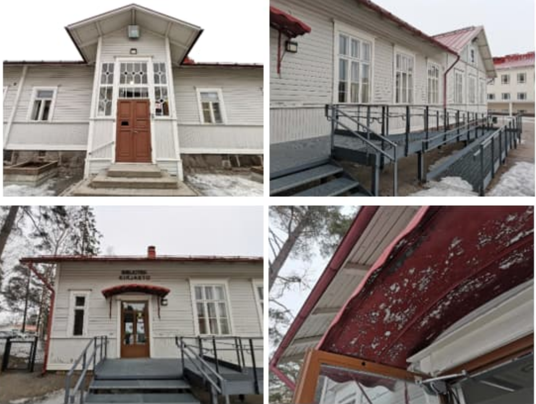
Kuva 24. Yleiskuvia rakennuksen julkisivusta. Rakennuksen julkisivu ovat paneloitu, ikkunat ja ovet ovat pääosin puurakenteiset. Rakennuksen ikkunat ovat lähtötietojen mukaan alkuperäiset. Kirjaston ulko-ovi on metallirakenteinen, automaattisesti avautuva. Ulko-oven metallirakenteisen katoksen maalipinta hilseilee.
