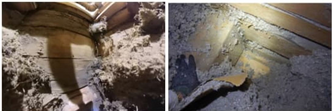
Kuva 23. Seinän hirsirunko vaikutti pääosin lujalta alapohjan rakenneavausten ja yläpohjan aistinvaraisten tarkistusten perusteella. Lahovaurioita todettiin ainoastaan paikallisesti.
