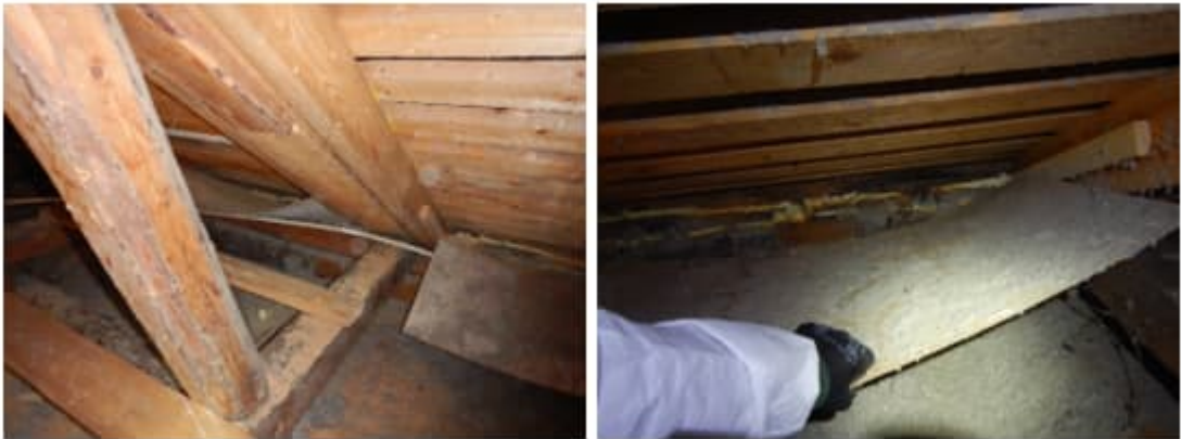
Kuva 48. Yläpohjatila ei tuuletu räystäiltä. Räystäillä on kuitenkin asennettuna kattotuolien välille tuulenohjaimet ohuesta kuitulevystä.
