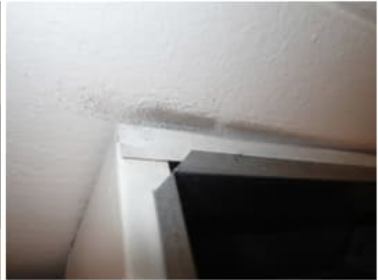
Kuva 75. Vanhemmanmallisesta tuloilmasäleiköstä puuttuu tiivisteet, josta aiheutuu ilmavuotoa.
