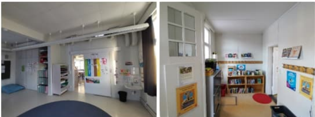
Kuva 36. Tiloissa, joissa ei seinissä ole puolipanelointia, on käytetty maalattua puukuitulevyä tai lastulevyä.
