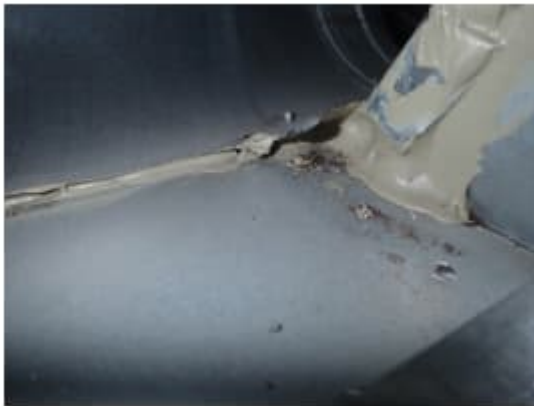
Kuva 76. Tuloilmapäätelaitteiden sisässä havaittiin pölykertymää ja kuolleita hyönteisiä.
