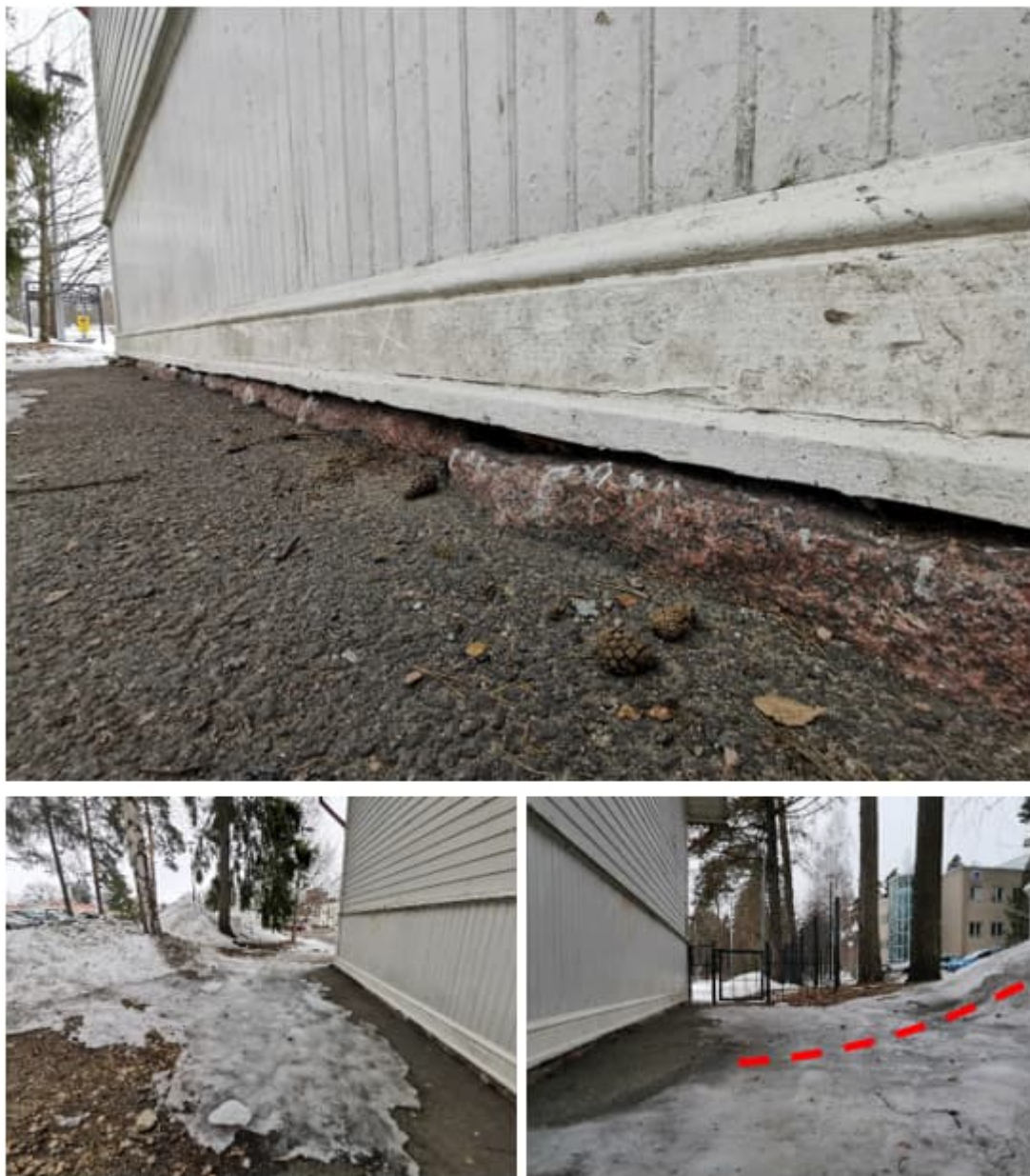
Kuva 5. Rakennuksen pohjoisjulkisivulla asfaltoitu maanpinta on lähes luonnonkiviperusmuurin yläpinnan rajalla ja on rakennuksen vierustalta melko tasainen. Vieressä olevan viheralueen maanpinta nousee selvästi piha-aluetta ylemmäs.
