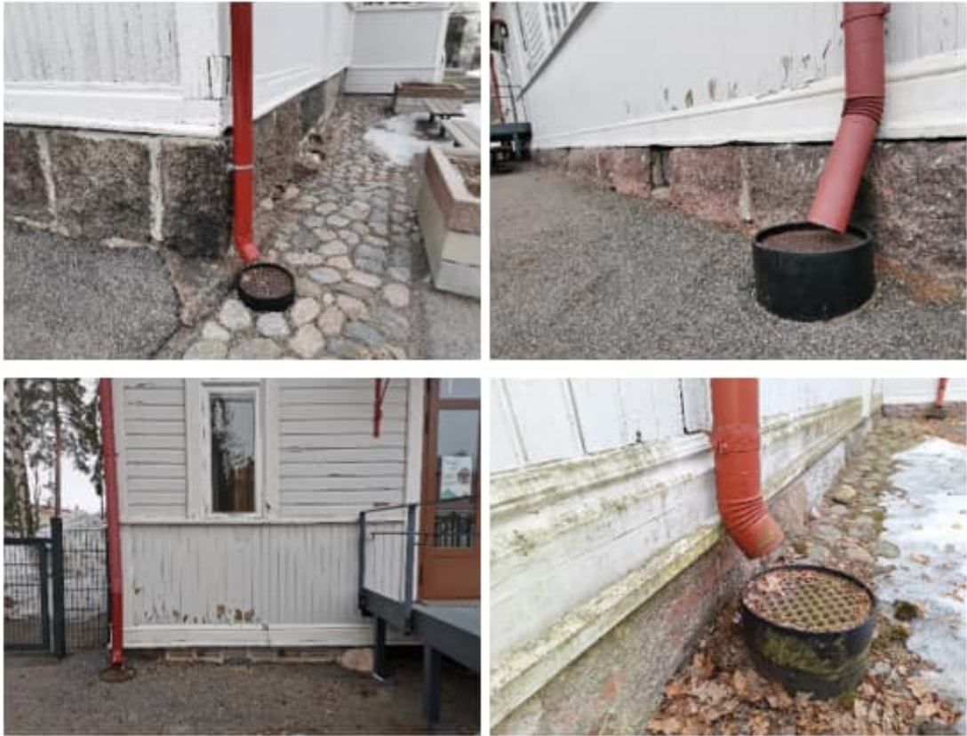
Kuva 4. Sadevesi on johdettu katolta räystääskourujen ja syöksytorvien kautta sadevesikaivoihin. Syöksytorvien etäisyydet suhteessa kaivoihin vaihtelevat, mutta ovat pääosin riittävät.
