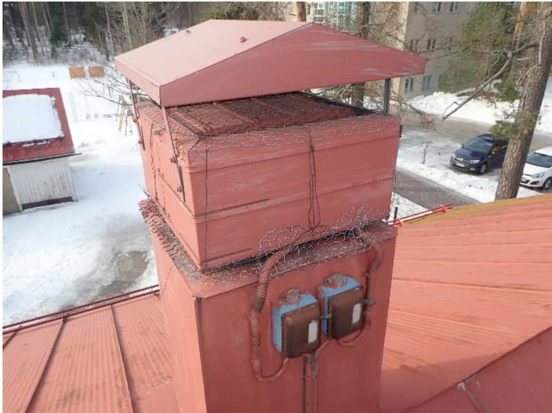
Kuva 69. Yleiskuva vesikatolla sijaitsevasta käytöstä poistetusta huippuimurista.
