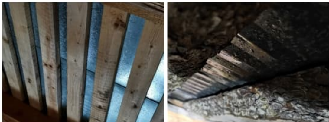
Kuva 48. Yläpohjatila ei tuuletu räystäiltä. Räystäillä on kuitenkin asennettuna kattotuolien välille tuulenohjaimet ohuesta kuitulevystä.
