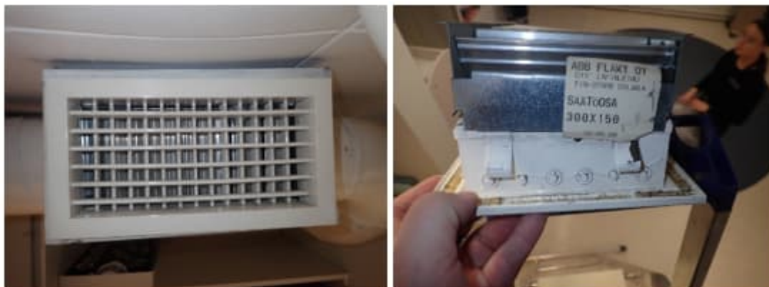
Kuva 74. Yleiskuva vanhemmasta (valmistusvuosi 2000) tuloilmasäleiköstä.
