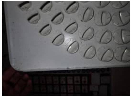
Kuva 76. Tuloilmapäätelaitteiden sisässä havaittiin pölykertymää ja kuolleita hyönteisiä.
