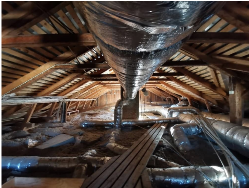
Kuva 42. Yleiskuva yläpohjatilasta. Lämmöneristeet on uusittu selluvillaan vuonna 2014 iv-järjestelmän uusimisen yhteydessä.
