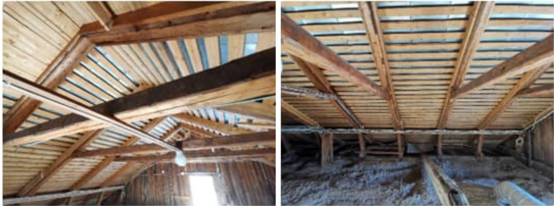
Kuva 45. Puurakenteet ovat havaintojen mukaan pääosin hyväkuntoiset. Vesikaton peltikatteen alla ei ole erillistä aluskatetta koko rakennuksen osalla. Aluskatetta on asennettu pakoin pääsisäänkäynnin puoleisen julkisivun kohdalle, varsinkin jiirirakenteen läheisyyteen.
