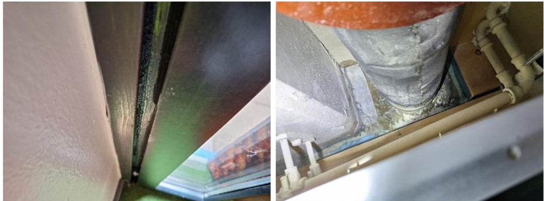
Kuva 48. Luokan 1222 atriumpihan vastaisen seinän liitoksia on tiivistetty lattia-seinäliitoksen ja ikkuna-/oviliitosten osalta. Luokassa on pintamateriaalina keraaminen laatoitus, jonka päälle on asennettu tekstiilimatto.
