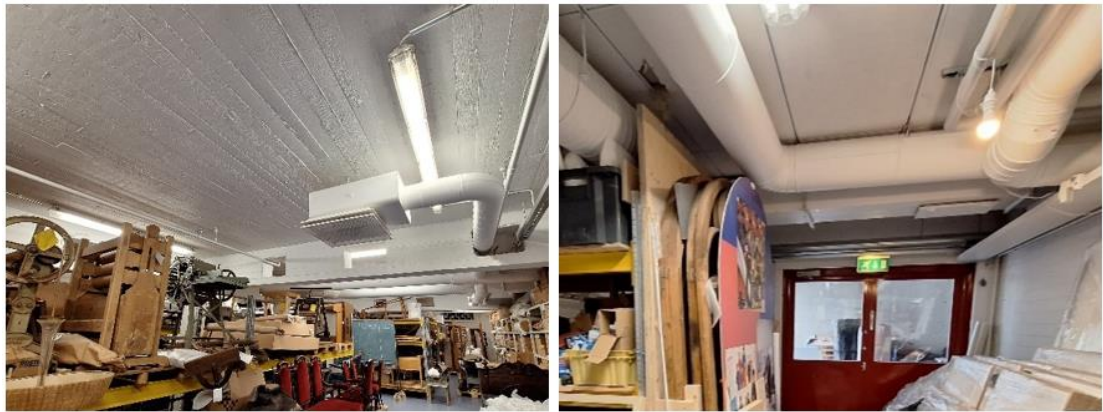
Kuva 35. Tilojen kattopinnat ovat yleisesti maalatulla betonipinnalla. Tiloissa 0104 ja 0103 katossa on akustiikkalevytys.
