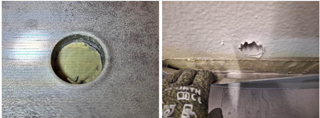
Kuva 47. Luokan 1416 alapohjaan on asennettu epoksi lattian vinyylilankun alle ja epoksointi on nostettu atriumpihan vastaiselle seinälle.
