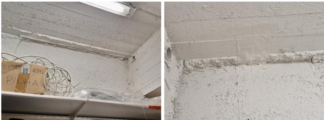
Kuva 26. Betonirakenteisten maanvastaisten seinärakenteiden sisäpinnasta on poistettu vanhat solupolystyreenilevytykset ja vedeneristys, kun tilat on muutettu täyttämättömästä alustilasta käyttötiloiksi. Styrox-eristeiden muodot näkyvät seinä- ja kattorakenteiden betonivalun pinnassa.
