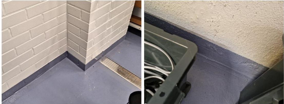
Kuva 27. Osa kuorimuuratuista seinälinjoista on ylivedetty TKR-pinnoitteella. Lisäksi kuorimuurattujen sekä betonirakenteisten maanvastaisten seinien lattia-seinäliitoksia on tiivistetty. Tiivistykset ovat pääasiassa hyväkuntoisia.
