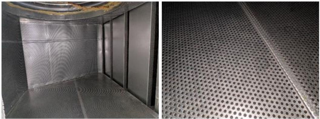
Kuva 32. Tuloilmakammiot ovat siistit. Kammion seinämissä on todennäköisesti mineraalivillaa vaimennusmateriaalina reikäpellin takana. Villa on suojattu lasikuitumatolla. Lasikuitumatto on ehjä.
