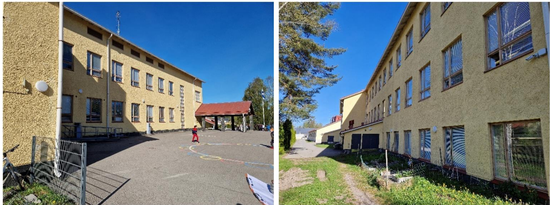
Kuva 3. Yleiskuva rakennuksen koillispuolelta asfaltoidusta sisäpihasta, jossa maanpinta viettää rakennuksesta tyydyttävästi poispäin (vasen). Yleiskuva rakennuksen lounaispuolelta, jossa maanpinta ei nykyohjeistuksiin verraten vietä riittävän hyvin rakennuksesta poispäin (oikea). Osalla lounaispuolta maanpinta viettää lievästi rakennukseen päin.
