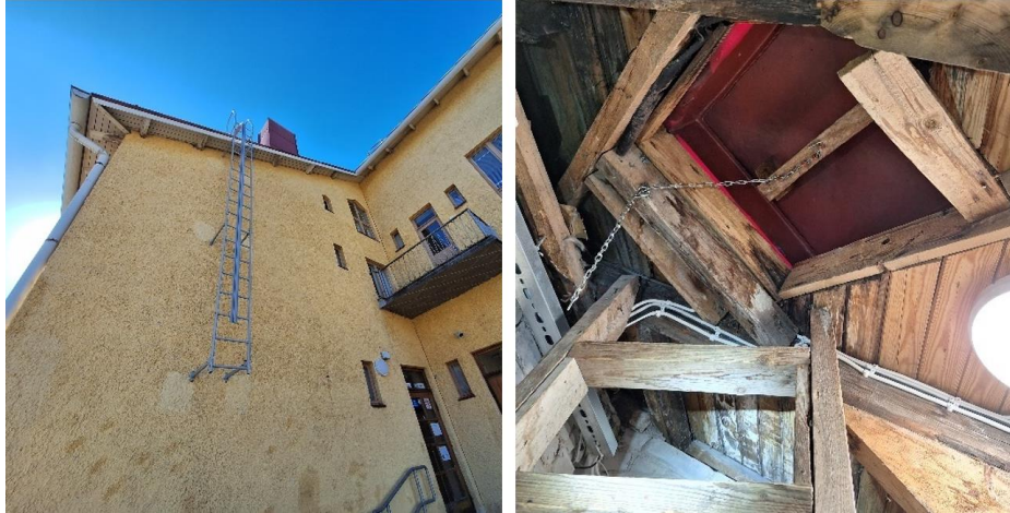
Kuva 48. Kulku vesikatolle on järjestetty talotikkailla sekä ullakolla olevalla kulkuluukulla.
