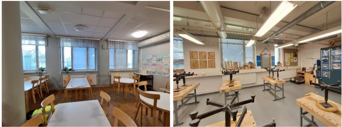
Kuva 22. Yleiskuvia rakennuksen luoteissivun pohjakerroksen seinistä ruokalasta 014 ja puutyöluokasta 033, joissa maanpinnan taso on hieman ikkunoiden alapinnan alapuolella.
