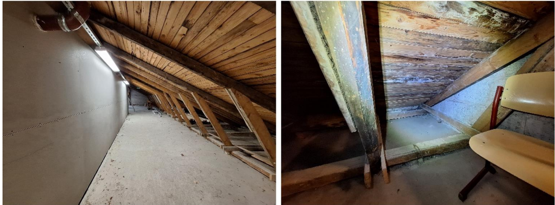
Kuva 56. Vasemmalla yleiskuva ullakkotilasta. Oikeanpuoleisessa kuvassa näkyy paikoin havaittuja heikkokuntoisempia aluslautoja.
