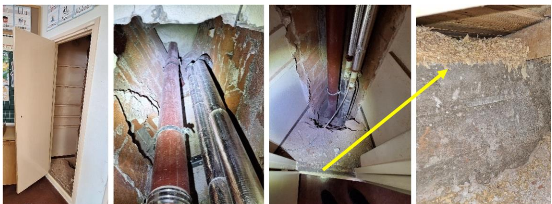
Kuva 36. Rakennuksen lounaissivun luokkahuoneissa vanhat nurkan komerot on muutettu talotekniikan kuiluiksi. Osa kuiluista on avoinna
