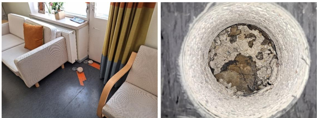
Kuva 44. Rakenneavaus RA16 opettajienhuoneessa 233. Betonikannellisissa välipohjissa on useimmilla alueilla tervapaperi täyttökerroksen ja laatan betonivalun välissä. Täyttö oli pääasiassa epäorgaanista laasti-/tiilimujua, mutta kaikissa avauksissa havaittiin myös vähäisesti kutterilastua tai muuta puuainesta. Useista välipohjien avauksista havaittiin PAH-yhdisteisiin viittaavaa hajua, jonka lähteenä on rakenteen tervapaperi.
