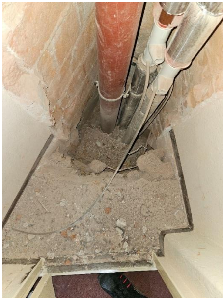
Kuva 86. Luokan 213 puolelta ei kuilusta havaittu ilmavuotoja.
