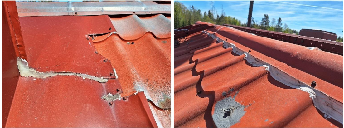
Kuva 53. Yleiskuvia pellitysten ja lävistysten sivelyistä ja massauksista.
