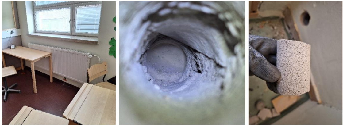
Kuva 30. Luokan 112 ulkoseinän avaus RA9 ja timanttikoralla irrotettu pala ulkoseinän kevytbetonista luokan 221 avauksesta RA20. Ulkoseinissä havaittiin vain kalkkihiekkatiilimuurausta ja kevytbetonia. Lattianrajasta viistosti poratuista rei'istä ei havaittu kehäpalkin takaista lämmöneristettä (sementtilastuvilla tai korkki).
