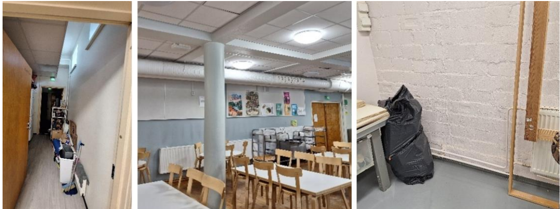
Kuva 23. Yleiskuvia rakennuksen kaakkoissivun pohjakerroksen seinistä välitilasta 013 (vasen) ja ruokalasta 014 (keski). Lisäksi kuva konesalin 032 kuorimuuratusta seinästä, jossa muurausta ei ole tasoitettu. Seinälinjalla maanpinta on noin pohjakerroksen katon tasolla.
