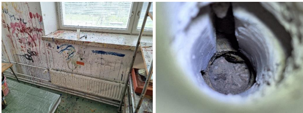
Kuva 26. Maalaustilan 035 seinän avaus sokkelin tasolta, jossa seinä on maanvastainen (RA2). Seinän kalkkiahiekkatiilimuurauksen ja sokkelin
