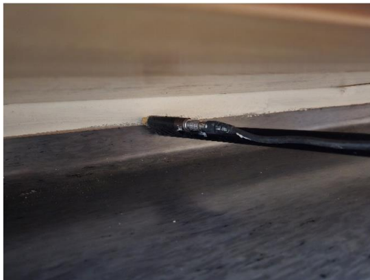
Kuva 70. Maton ylösnostosta päätyseinän kaapiston alla havaittiin useista kohdin vähäistä viivamaista ilmavuotoa.
