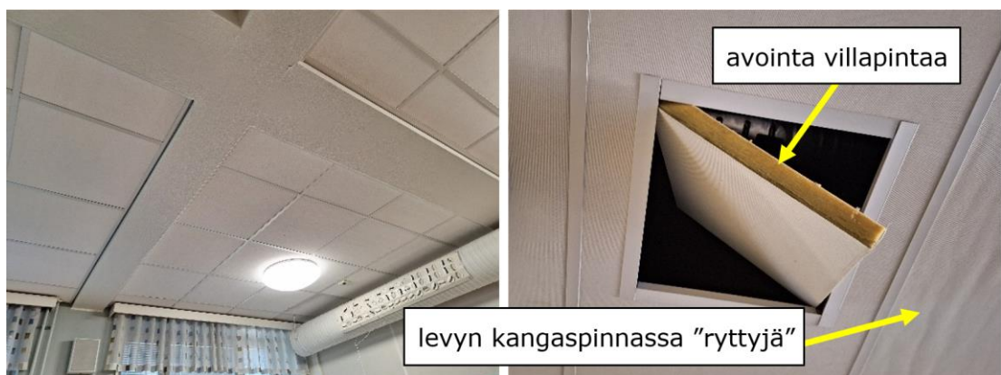
Kuva 42. Käytävien ja ruokalan alakaton levykiskojärjestelmä, jossa villalevytyksen reunat ovat avoimella villapinnalla. Alakattojärjestelmiä on havaintojen perusteella rakennuksessa ainakin kahdenlaisia. Käytävien levytyksen pinnassa on ns. ryttyjä, jossa levyn kangaspinta on todennäköisesti alkanut irrota vastepinnaltaan ja villa vaikuttaa ikääntyneeltä.
