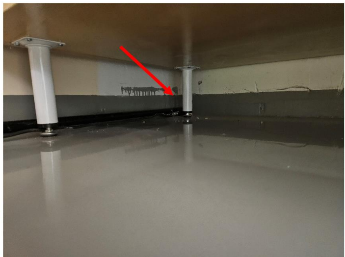
Kuva 61. Valmiiden töiden varaston puolelta, väliseinän ja lattian liitoksesta havaittiin merkittävää viivamaista ja pistemäistä ilmavuotoa.
