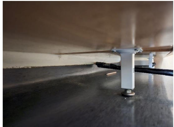
Kuva 70. Maton ylösnostosta päätyseinän kaapiston alla havaittiin useista kohdin vähäistä viivamaista ilmavuotoa.
