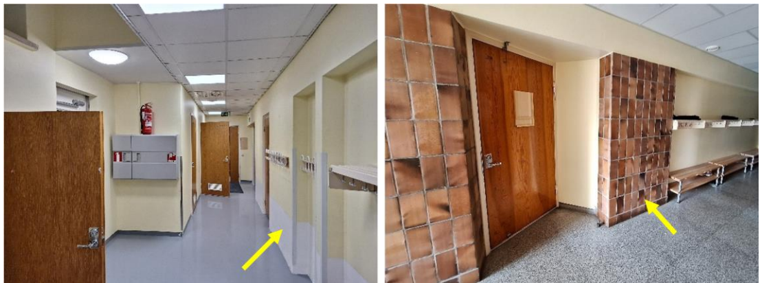
Kuva 35. Yleiskuvia rakennuksen väliseinistä käytävistä 018 ja 214. Kuvissa näkyy luokkaosan keskialueen pilarirakenteet väliseinälinjalla, jotka kellarikerroksessa ovat tasoitettuja ja maalattuja ja ylemmissä kerroksissa laatoitettuja. Pilarirakenteet ovat muuta seinää paksumpia.
