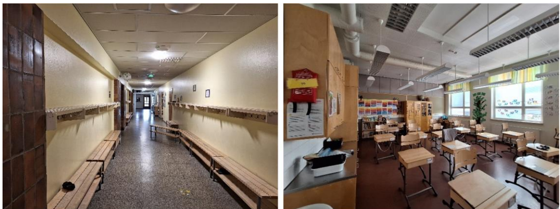
Kuva 40. Yleiskuvia rakennuksen välipohjista käytävältä 115 ja luokasta 112.
