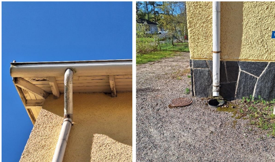
Kuva 49. Sadevedenpoistojärjestelmissä ei havaittu merkittäviä puutteita. Vasemmanpuoleisessa kuvassa on nähtävissä vesien valumajälkiä syöksytorven ulkopinnassa.
