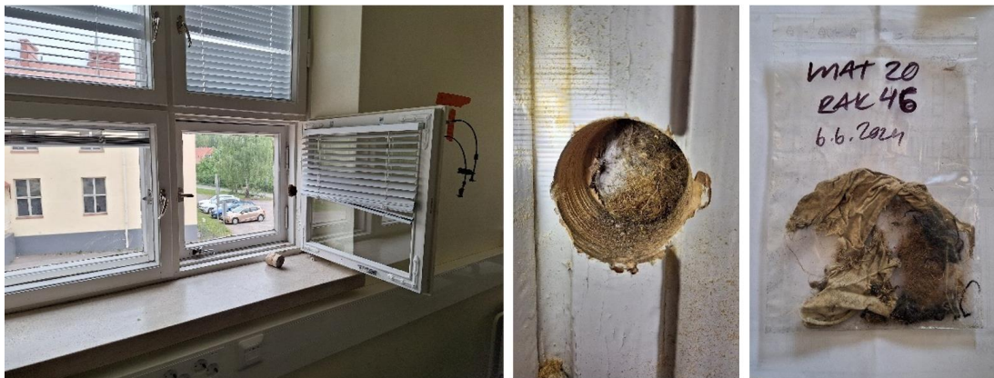
Kuva 33. Ikkunoiden karmin ja ulkoseinän väliset tilketilat on täytetty pellavariveellä. Yhdessä ikkunan rakenneavauksessa havaittiin lisäksi kangasta ja yhdessä ei havaittu tilkettä ollenkaan. Ikkunatilkkeestä ei havaittu poikkeavaa hajua. Karmit on upotettu seinärakenteeseen.
