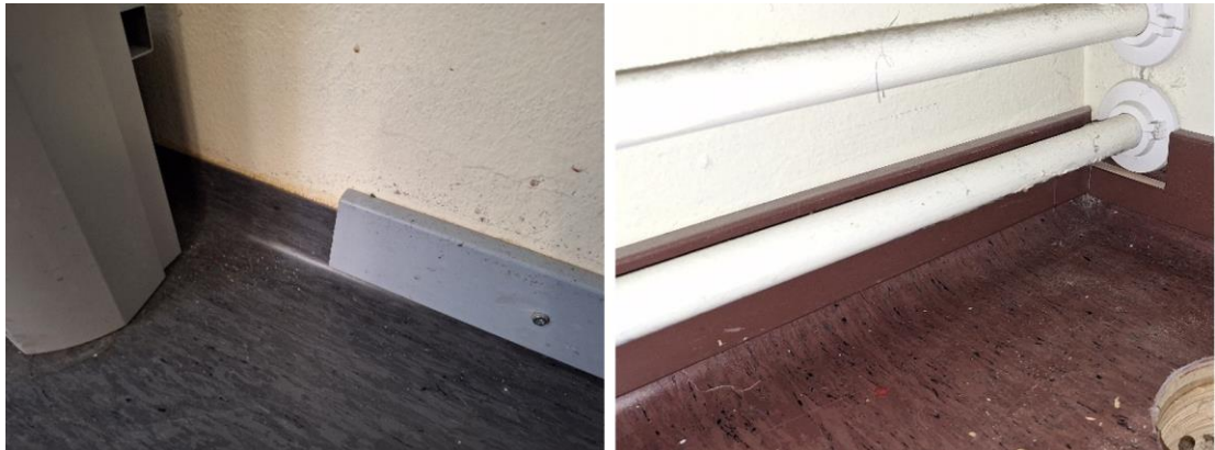
Kuva 41. Lattioiden muovimatto on nostettu ja liimattu seinäpinnalle ja seinän ja maton reunaan on ruuvattu jalkalista. Keraamisen laatoituksen kohdilla matto on jätetty laatoituksen taakse. Jalkalistat on asennettu hieman lattiapintaa ylemmäs.
