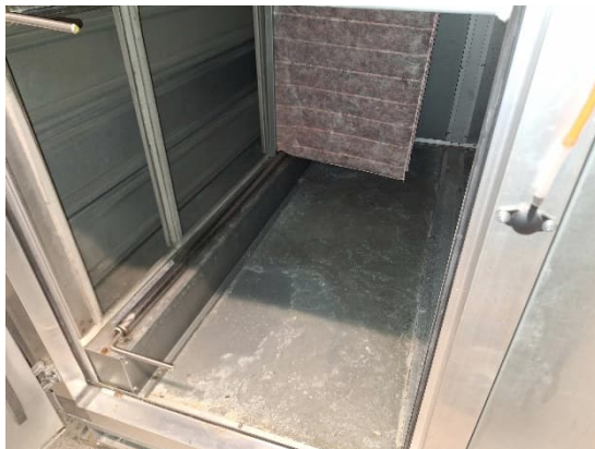
Kuva 68. Yleiskuvat suodatinkammioista. Kammion pohjalla ja seinämissä kosteusjälkiä.
