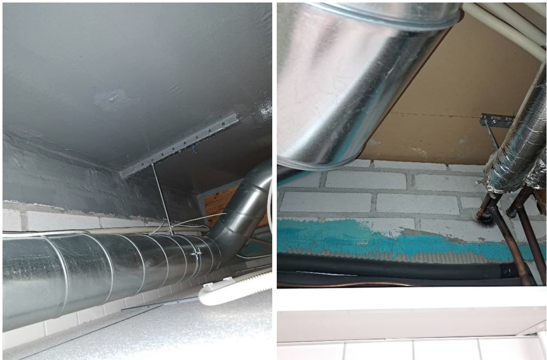
Kuva 47 a-b. Tiiliseinien yläosat on pääosin tiivistetty kaikkien tilojen osalta lukuun ottamatta palvelukeittiön sekä IV-konehuoneen kattoliittymiä.
