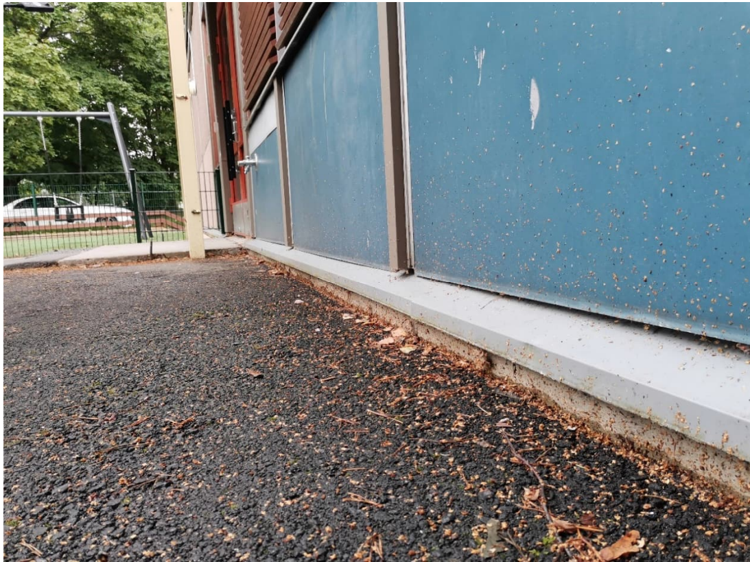
Kuva 4. Maanpinnan asfaltointi on rakennuksen vierustalta melko tasainen ja nousee lähelle sokkelin yläreunan tasoa.
