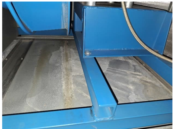
Kuva 71. Yleiskuvat tuloilmapuhaltimesta. Puhallinkammiossa havaittiin likaa sekä vanhoja kosteusjälkiä.
