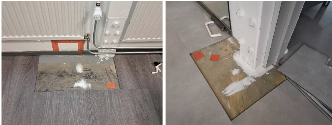
Kuva 16 a-b. Lattiapinnoitteiden alla havaittiin suunnitelmien mukainen höyrynsulkusively ja TKR-pinnoitteella tiivistetyt lattia-ulkoseinä- ja lattia-pilarirakenneliittymät.
