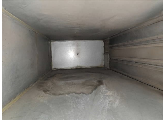
Kuvat 67. Yleiskuvat ilmanvaihtokoneen raitisilmakammioista. Kammiossa ja huoltoluukussa ei havaittu epätiiveyttä tai ohivuotoja. Kammion pohjalla on vanhoja kosteusjälkiä.
