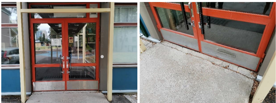
Kuva 40 a-b. Metallirakenteiset ulko-ovet olivat hyväkuntoiset ja toimivat.
