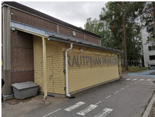
Kuva 8 a-c. Koillisseinustan mukulakiveys on myös painunut ja osin kasvillisuuden peittämä. Maanpinta melko tasainen tai kallistaa loivasti rakennukseen.
