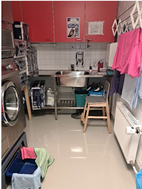
Kuva 19 a-b. Vaatehuollon ja siivouskeskuksen lattiapinnan epoksi on hyvässä kunnossa. Myös keittiön lattian massapinnoite on pääosin hyväkuntoinen.
