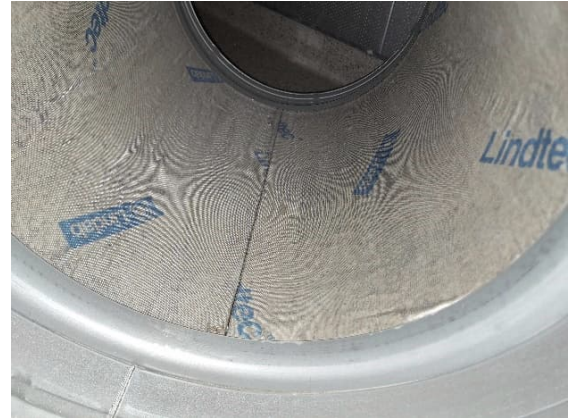
Kuva 74. Yleiskuvat ilmanvaihtokoneelta lähtevistä ilmanvaihtokanavista, jossa on äänenvaimentimia. Äänenvaimennusmateriaalina on käytetty polyesteria, eikä kuitulähteitä ole havaittu.
