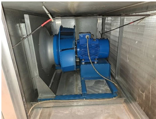
Kuva 71. Yleiskuvat tuloilmapuhaltimesta. Puhallinkammiossa havaittiin likaa sekä vanhoja kosteusjälkiä.
