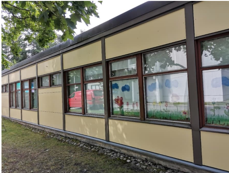
Kuva 8 a-c. Koillisseinustan mukulakiveys on myös painunut ja osin kasvillisuuden peittämä. Maanpinta melko tasainen tai kallistaa loivasti rakennukseen.
