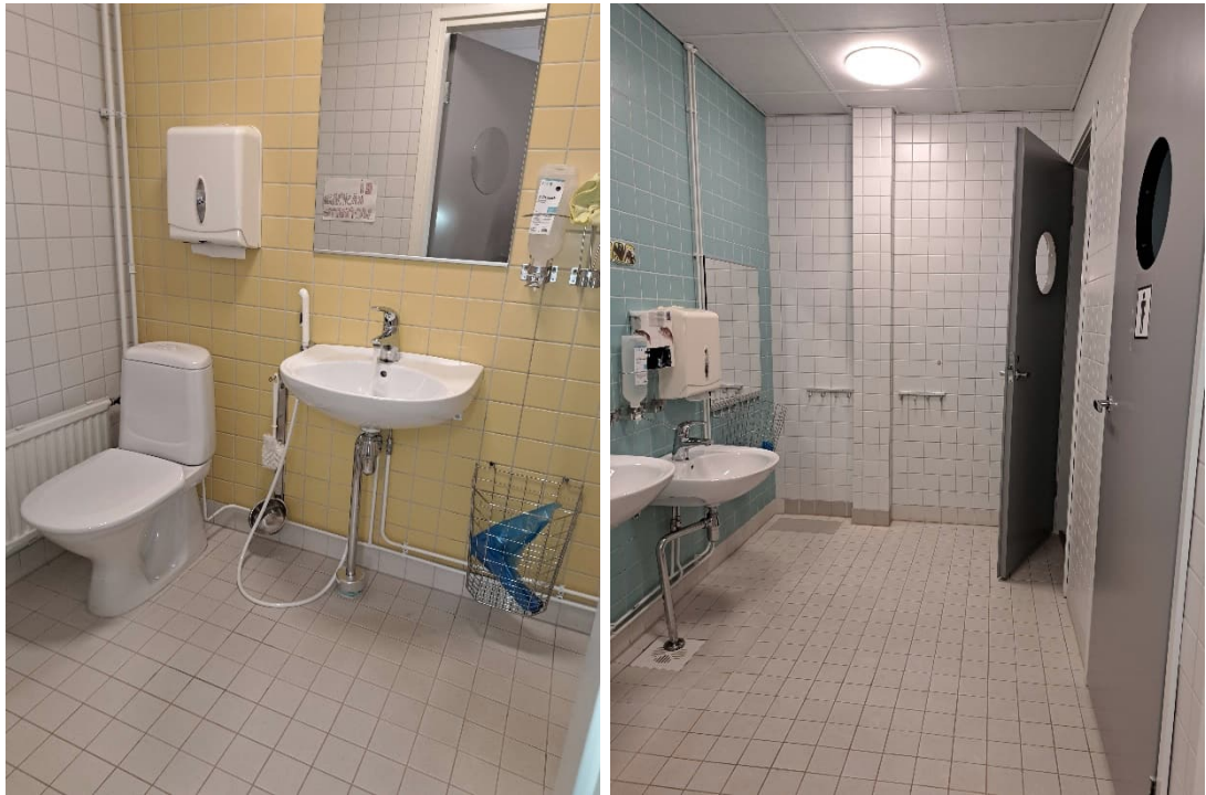
Kuvat 17 a-b. Wc- ja suihkutiloissa on käytetty pääosin hyväkuntoista keraamista laattaa.
