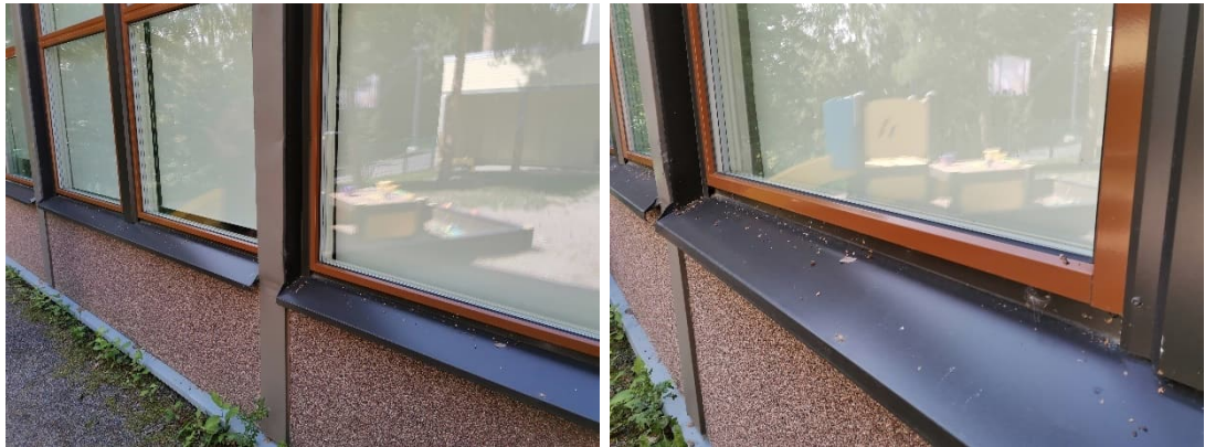
Kuva 38 a-b. Uusitut metalliset elementti-ikkunat olivat havaintojen mukaan hyväkuntoiset ja pellitykset uusitut.
