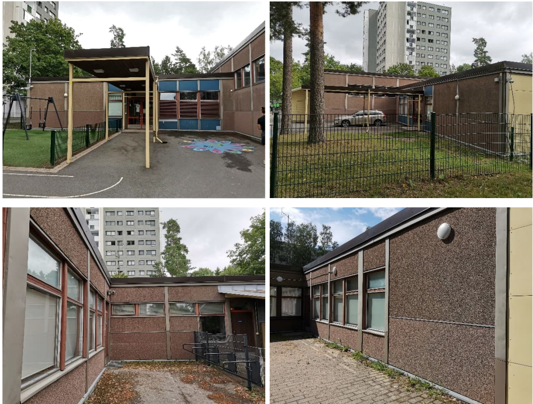
Kuva 28 a-b. Yleiskuvia rakennuksen julkisivusta. Alkuperäinen karaattilaattaulkoverhous on uusittu paikoin keltaisiin julkisivulevyihin. Yleisilme julkisivusta on pääosin siisti.
