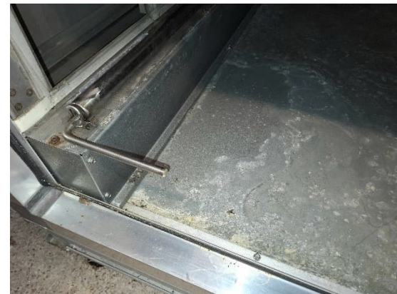
Kuva 68. Yleiskuvat suodatinkammioista. Kammion pohjalla ja seinämissä kosteusjälkiä.
