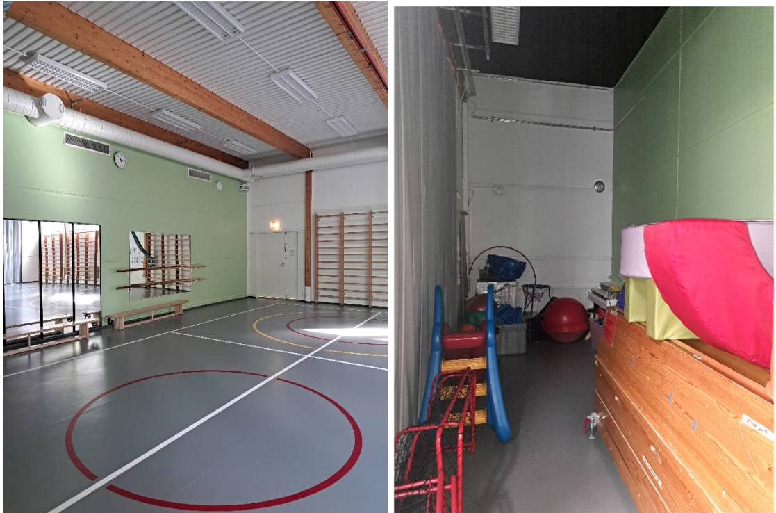
Kuva 20 a-d. Liikuntasalin lattiapinnoite on uusittu vuoden 2020 korjauksissa ja oli havaintojen mukaan hyväkuntoinen.
