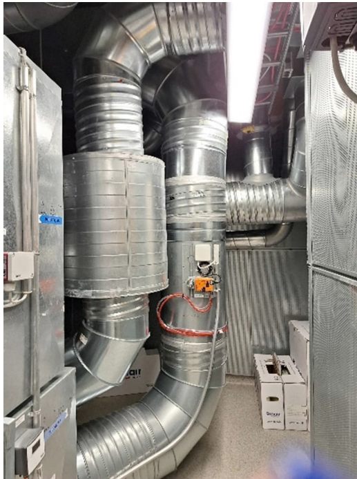
Kuva 74. Yleiskuvat ilmanvaihtokoneelta lähtevistä ilmanvaihtokanavista, jossa on äänenvaimentimia. Äänenvaimennusmateriaalina on käytetty polyesteria, eikä kuitulähteitä ole havaittu.
