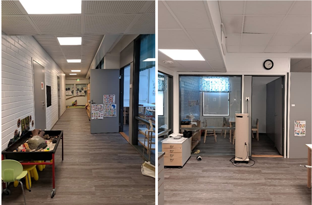
Kuva 45 a-b. Yleiskuvia väliseinistä. Tilojen väliseininä pääosin maalattu tiili- tai levyrakenne. Levyrakenteisissa seinissä pääosin suurehkoja lasiaukkoja / ovia.
