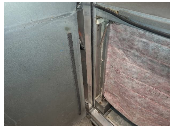
Kuva 69. Yleiskuvat tuloilmasuodattimien kehikosta. Kehikossa havaittiin epätiiveyttä ja paikoin repeytyneitä tiivisteitä.
