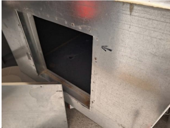
Kuvat 67. Yleiskuvat ilmanvaihtokoneen raitisilmakammioista. Kammiossa ja huoltoluukussa ei havaittu epätiiveyttä tai ohivuotoja. Kammion pohjalla on vanhoja kosteusjälkiä.
