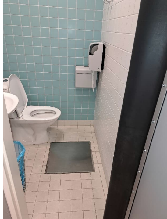
Kuvat 18 a-b. Läpiviennit sekä alapohjan tarkastusluukut on havaintojen mukaan tiivistetty TKR-massalla myös kotelointien sisältä.
