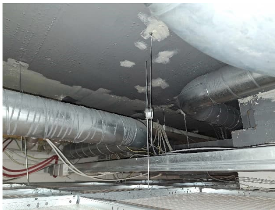
Kuva 75. Yleiskuvat ilmanvaihtokanavistosta. Kanavat kulkevat osin näkyvillä ja osin alakaton sisällä piilossa.
