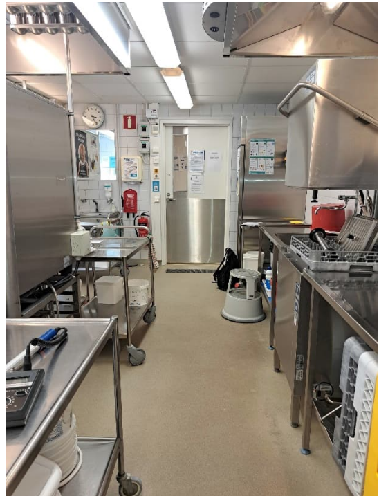
Kuva 19 a-b. Vaatehuollon ja siivouskeskuksen lattiapinnan epoksi on hyvässä kunnossa. Myös keittiön lattian massapinnoite on pääosin hyväkuntoinen.
