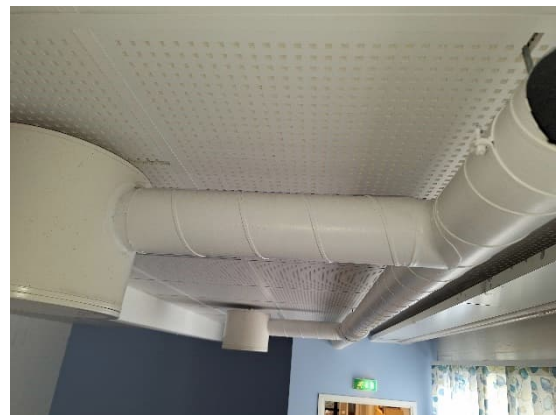
Kuva 75. Yleiskuvat ilmanvaihtokanavistosta. Kanavat kulkevat osin näkyvillä ja osin alakaton sisällä piilossa.
