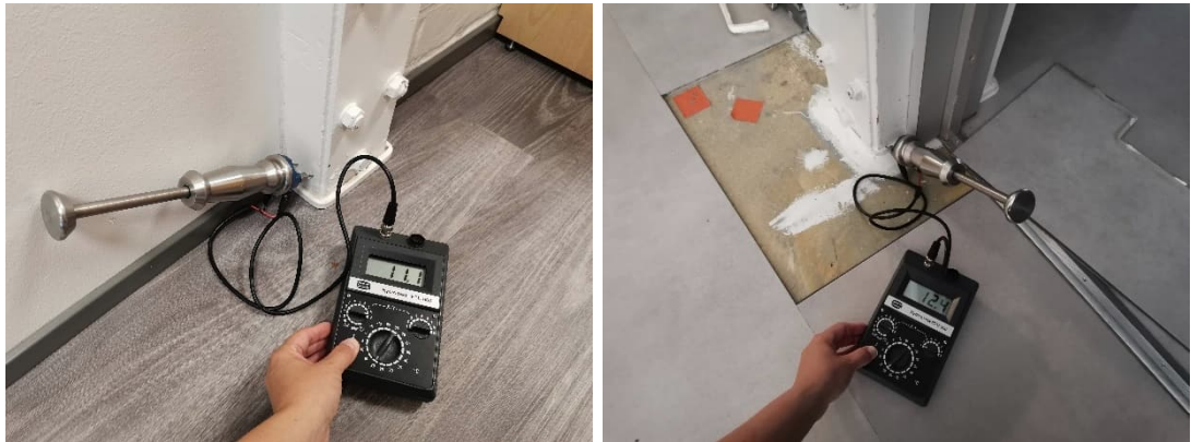
Kuva 46 a-b. Pilareiden alaosien kosteutta tarkasteltiin piikkimittarin avulla. Kohonneita kosteusarvoja ei tarkasteltujen pilareiden osalta havaittu.
