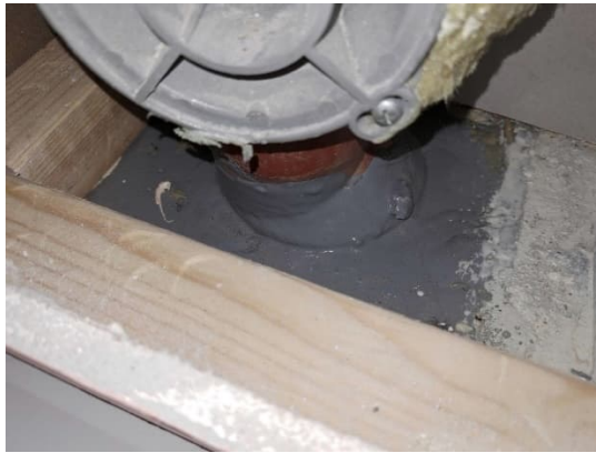
Kuvat 18 a-b. Läpiviennit sekä alapohjan tarkastusluukut on havaintojen mukaan tiivistetty TKR-massalla myös kotelointien sisältä.
