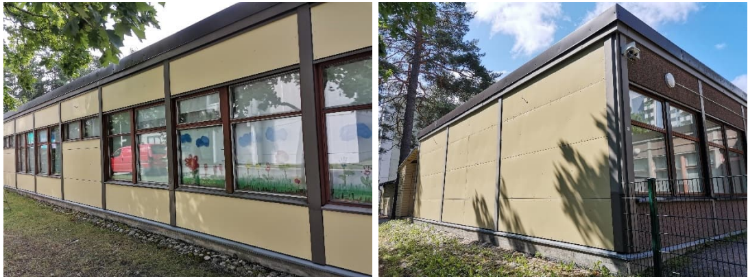
Kuva 30 a-b. Aiemmin uusitut keltaiset julkisivulevytykset on kertaalleen uusittu kesällä 2024. Uusitut levyt olivat havaintojen mukaan siistit.
