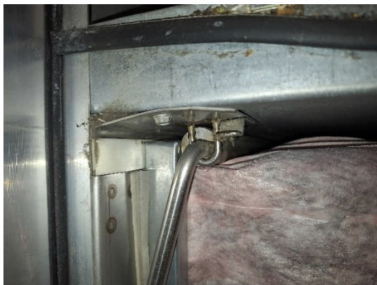
Kuva 69. Yleiskuvat tuloilmasuodattimien kehikosta. Kehikossa havaittiin epätiiveyttä ja paikoin repeytyneitä tiivisteitä.
