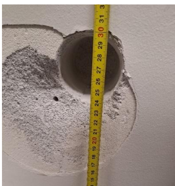
Kuva 49 Ulkoseinän avaus US11
