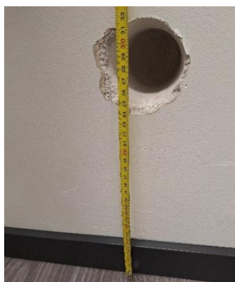
Kuva 45 Ulkoseinän avaus US10 tehtiin noin 255...315 mm korkeudelle lattiapinnasta.
