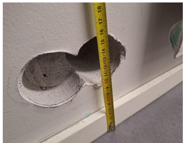
Kuva 20 US1 lattiapinnasta noin 100...160 mm.
