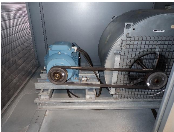
Kuva 73 Tuloilmapuhallin.
