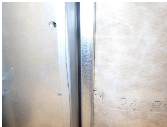
Kuva 62 Raitisilmakammiota ei ole viemäröity lattiakaivolle asti.
