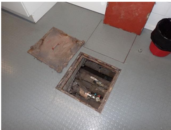
Kuva 40 Kaasutiivis luukku tekniikkakanaaliin 1. kerroksessa.
