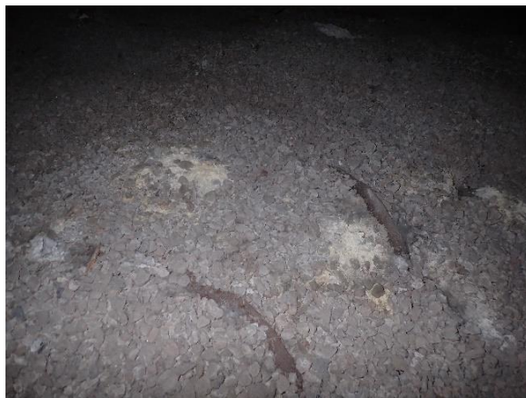
Kuva 10 Sorastuksen pinnalle on monin paikoin kasvustoa.
