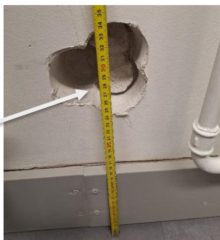
Kuva 28 Ulkoseinän avaus US5. Näyte 0...40 mm otettiin noin 245...305 mm lattiapinnasta. Syvempi 40...90 mm näyte otettiin noin 260...320 mm lattiapinnasta.
