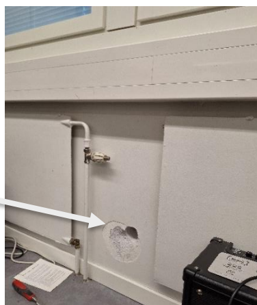
Kuva 48 Ulkoseinän avaus US11 tehtiin tilaan 158 noin 240...300 mm lattiapinnasta.
