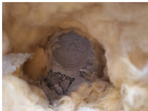
Kuva 30 Levyseinän ja lisälämmöneristyksen takana on kevytbetoniseinä.
