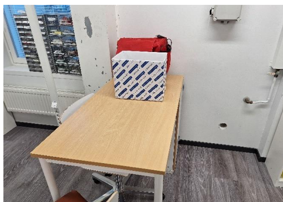
Kuva 44 Ulkoseinän avaus US10 seinän alaosaan.
