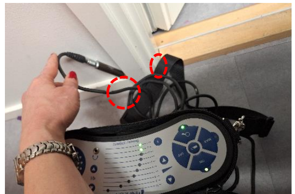
Kuva 37 Pistemäisiä vuotokohtia oli oven molemmin puolin sekä kynnyksen kohdalla.
