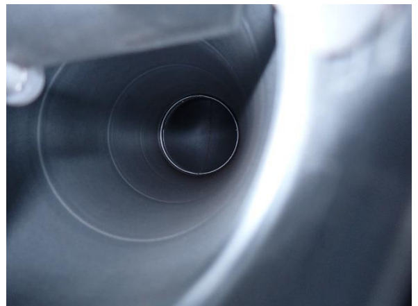
Kuva 99 Tuloilmapäätelaitteesta kuvattuna tuloilmanakanava on puhdas.
