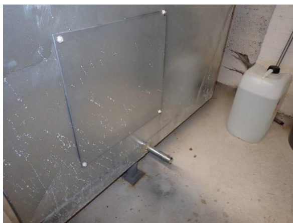
Kuva 62 Raitisilmakammiota ei ole viemäröity lattiakaivolle asti.
