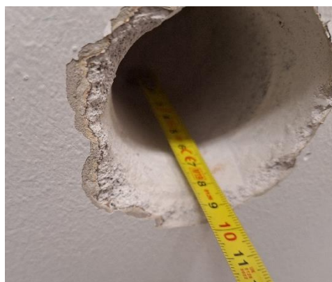
Kuva 46 Ulkoseinän avaus US10 oli yhteensä 90 mm syvä.
