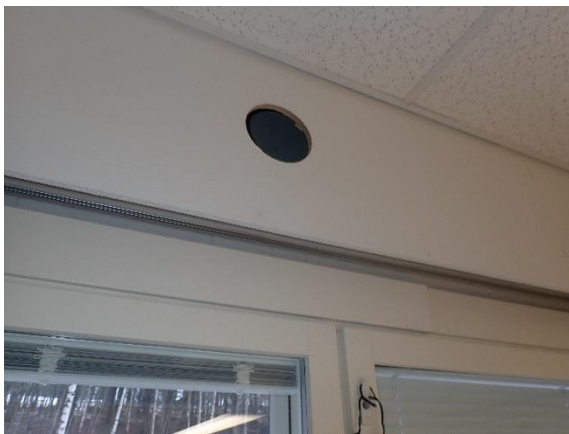
Kuva 63 Verhokoteloon tehty rakenneavaus.
