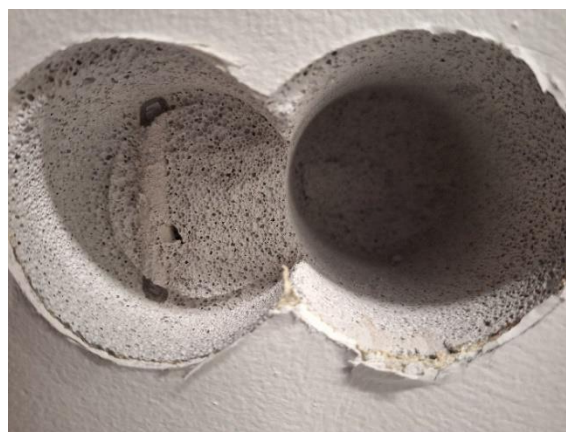
Kuva 28 Kevytbetoniseinän poraus tilassa 247.
