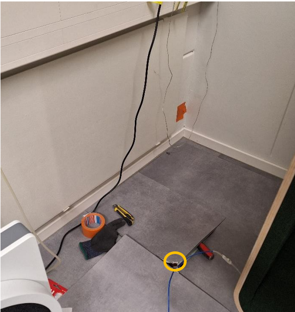
Tila 223 ja syöttökohta.
