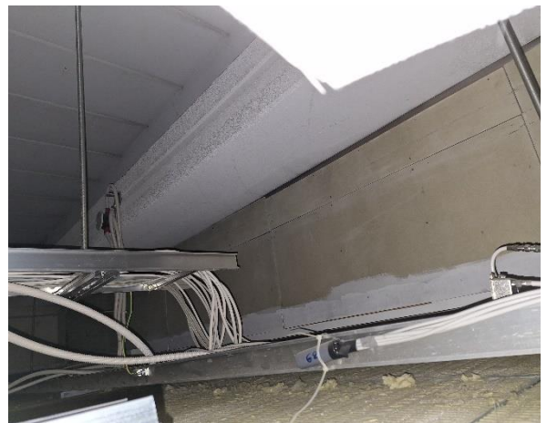
Kuva 60 Rakenneavauskohta käytävällä 257 sijaitsevan alakattojen yläpuolella. Levyssä ei aistinvaraisia viitteitä kosteusvaurioista.
