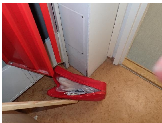
Kuva 45 1. kerroksen pukuhuonetilassa on kosteusvaurioitunut putkikotelointi.
