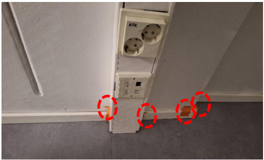
Selviä vuotoja alapohjan ja väliseinän liittymässä neljässä pisteessä.
