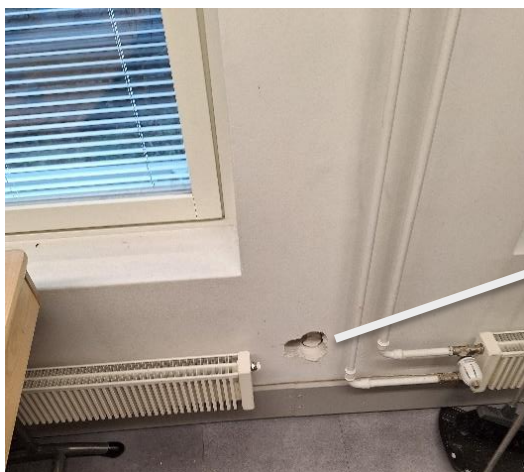
Kuva 27 Tilan 126 avauskohta US5.
