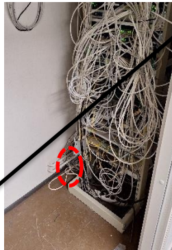
Selvää vuotoa varastotilan lattialiittymistä sekä kohtalaista vuotoa johtojen takaa lattialiittymästä.
