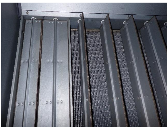
Kuva 81 Lämmöntalteenotto.
