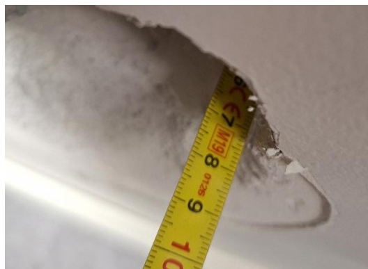
Kuva 50 Ulkoseinän avaus US11 oli noin 75 mm syvä.
