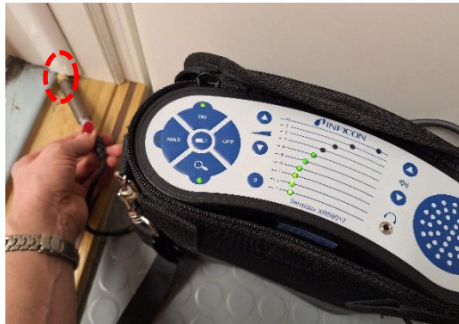
Selvää vuotoa oven kynnyksen kohdalla.
