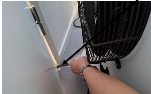
Lievää vuotoa tilojen välisen oven liitoskohdassa.
