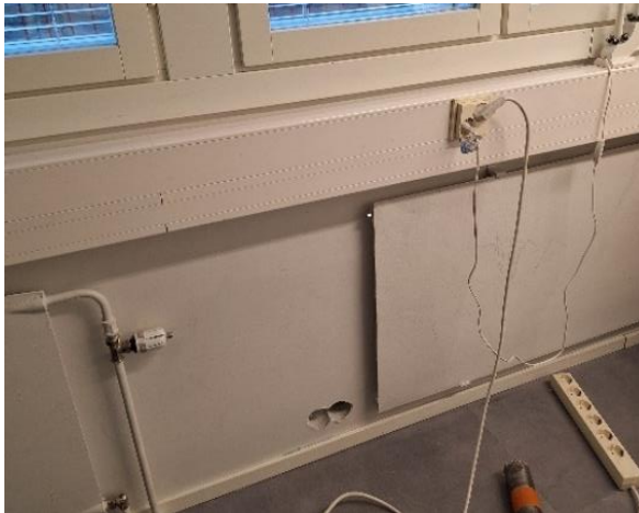
Kuva 17 Ulkoseinän avaus US1 tilaan 247.
