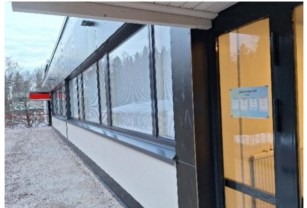
Kuva 18 Tilat 261 ja 247 ulkopuolelta.
