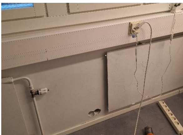
Kuva 27 Esimerkki kevytbetoniseinän porauksesta tilassa 247.
