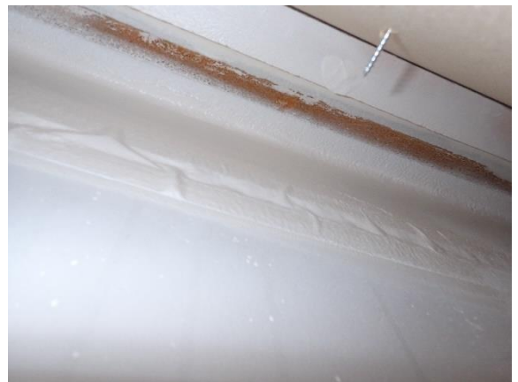
Kuva 66 Yläpohjaliittymään on toteutettu tiivistys.
