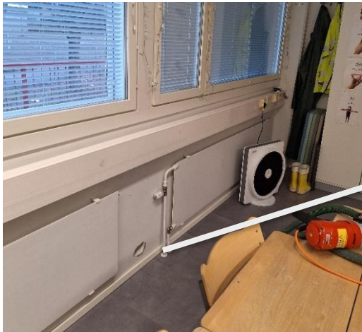
Kuva 25 Ulkoseinän avaus US4 tilaan 207.
