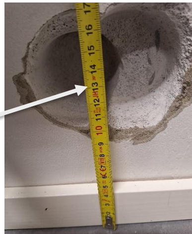
Kuva 26 Ulkoseinän avaus US4 noin 110...170 mm lattiapinnasta.
