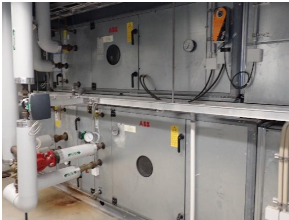
Kuva 71 TK-2 ja PK-2.1 yläpuolella.
