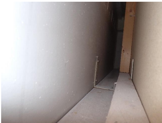
Kuva 65 Verhokotelossa ei havaittu viitteitä kosteusvaurioista
