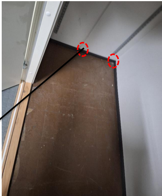
Tila 147, toisella puolella tilaa on serverikone.
