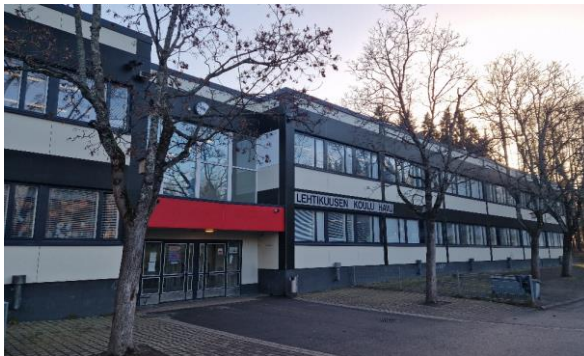
Kuva 2 Yleiskuva lännen puoleiselta julkisivulta.
