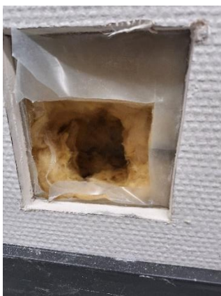
Kuva 29 Tilan 155 rakenneavaus US12 lattiapinnan lähelle.
