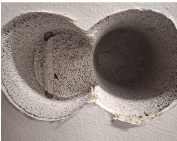
Kuva 19 Ulkoseinän avaus US1 tilaan 247.
