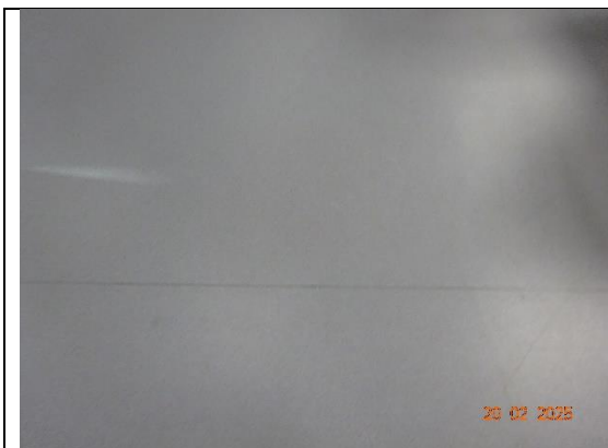
Kuva 4. Lattiapinnoite ja sen sauma (opetustila 2221).
