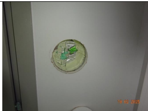
Kuva 1. Yleiskuva rakenneavauksesta tilassa 2201.
