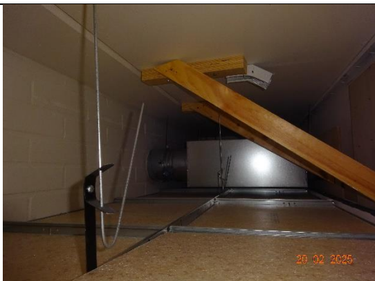
Kuva 12. Biologian luokan 2222 alakaton päällistä tilaa.
