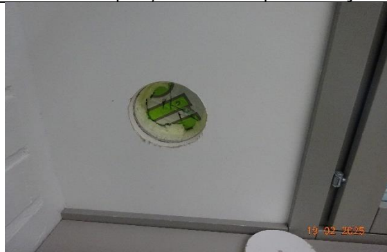
Kuva 1. Yleiskuvaa rakenneavauksesta tilassa 2206.
