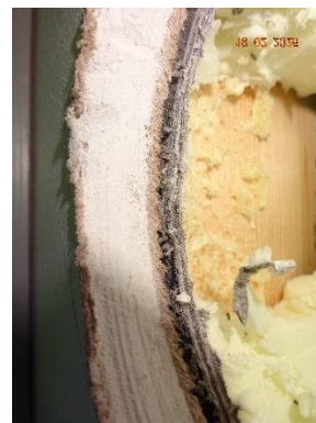
Kuva 4. Uretaanilevyt oli tiivistetty uretaanivaahdolla ikkunan apukarmiin.
