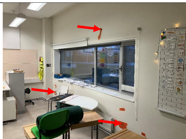
Kuva 23. Yleiskuva ulkoseinästä, johon toteutettiin rakenneavaukset. Nuolilla merkattu avauskohdat.
