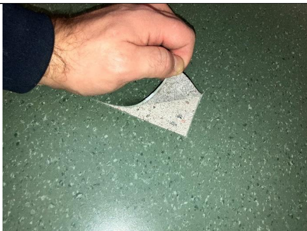
Kuva 11. Tilan 2.024 (VM1) muovimatto on liimattu pintabetonin päälle. Ei havaittu muuta poikkeavaa.
