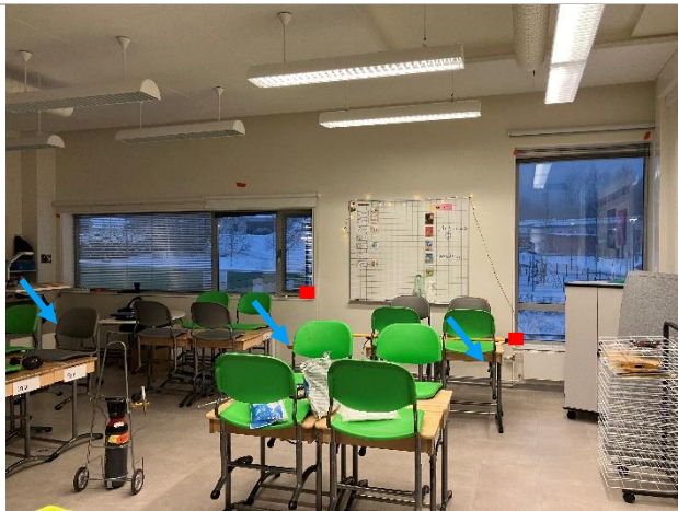
Kuva 28. Merkkiaineen syöttökohdat on merkattu kuvaan nuolella ja vuotokohdat ilman alipaineistusta on merkitty punaisella.
