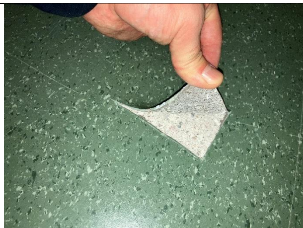
Kuva 12. Tilan 2.023 (VM 3) muovimatto on liimattu pintabetonin päälle. Ei havaittu muuta poikkeavaa.
