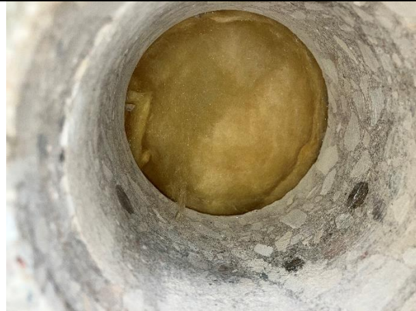
Kuva 25. Rakenneavaus RA2-US ikkunan alapuolella pilarin vierellä. Avauksen kohdalla ei havaittu aistinvaraisesti poikkeavaa.
