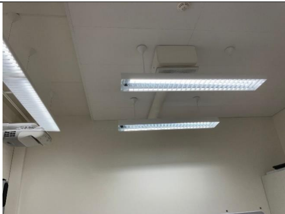
Kuva 22. Luokkatilojen maalatut pinnat ja akustiikkalevyt on hyväkuntoisia.
