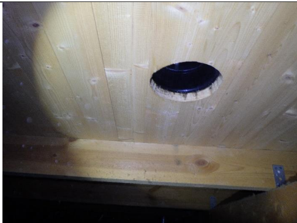
Kuva 15. Yläpohjatile on tuulettuva. Vesikattorakenteet ovat puurakenteisia.
