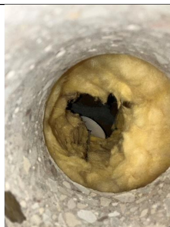
Kuva 24. Rakenneavaus RA1-US ikkunan alapuolella. Avauksen kohdalla ei havaittu aistinvaraisesti poikkeavaa.
