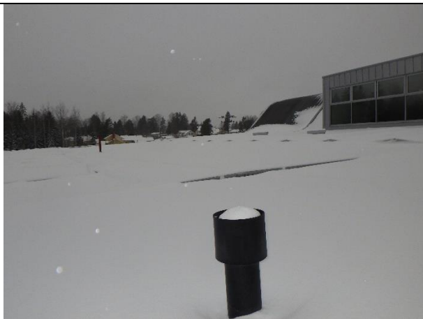
Kuva 13. Yleiskuva vesikatolta. Tarkastushetkellä katolla oli lunta.
