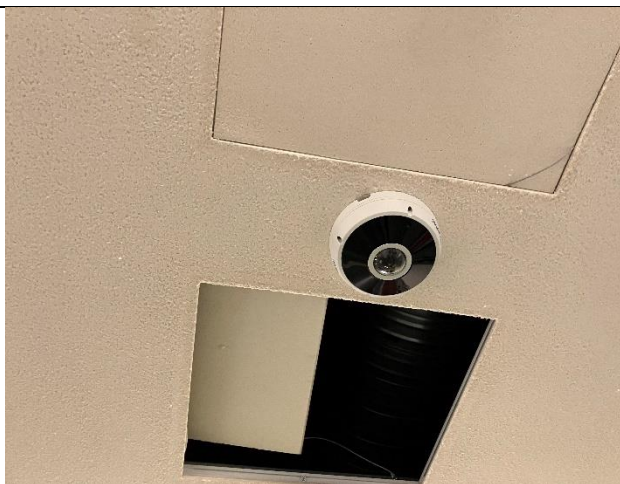
Kuva 18. Käytävillä on alaslaskettu katto.
