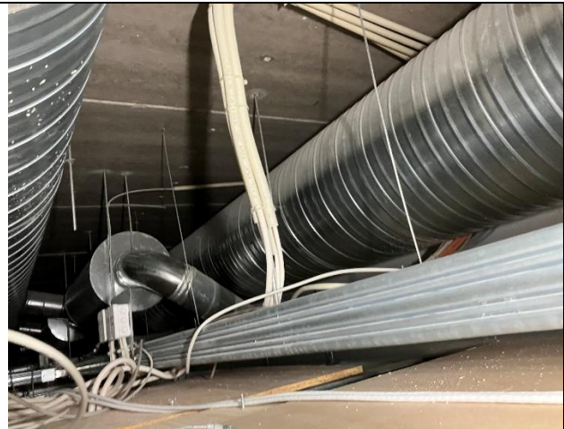
Kuva 21. Tilan 2.097 edustalla käytävän alakaton yläpuolista tilaa.
