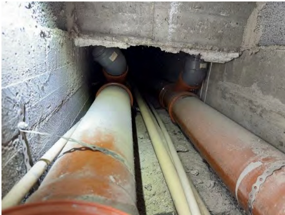
Kuva 20. Putkikanaalissa on jonkin vähäisesti likaa ja rakennusjätettä.
