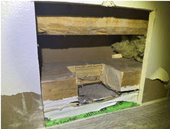
Kuva 51. Rakenneavaus RA-VS 3 tilojen 129 ja 129A väliseen kantavaan väliseinään. Kantavan väliseinän alasidepuun alla on bitumikermikaista. Alapohjan tiivistyskäsittely on nostettu alasidepuuta vasten ja liitoksessa on höyrynsul-kuteippi / valkoinen massaus.
