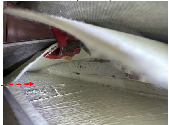
Kuva 19. Tulppaus ei ollut näkyvissä, mutta alapohjan tiivistyskäsittely on ulotettu viemärin yli, eikä kohdalla havaittu poikkeavia hajuja.
