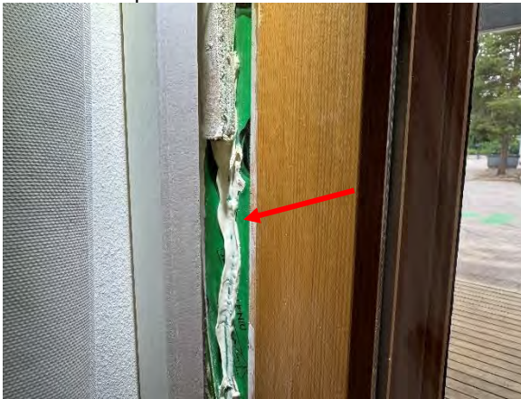
Kuva 36. Vuonna 2023 tehdyt ikkunoiden tiivistyskorjaukset on toteutettu höyrynsulkuteipin ja tiivistysmassan avulla. Höyrynsulkuteippi on paikoitellen irronnut alustastaan. Kuva tilasta 109.
