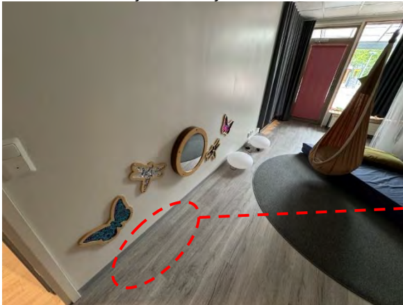
Kuva 18. Tilan 110 seinän vierustalta on tulpattu vanha viemäri. Vanhan viemärin kohta tarkastettiin.
