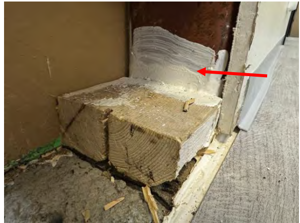
Kuva 52. Rakenneavaus RA-VS 4 kantavaan väliseinään aulassa / ruokailutilassa 138. Alasidepuun lisäksi kantava teräspilari on tiivistys-käsitelty.
