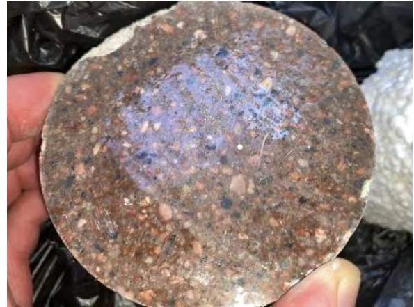
Kuva 17. Rakenneavaus RA-AP 7 ryhmähuoneeseen 132. Yksittäisten tilojen lattiat on tiivistyskäsittely kauttaaltaan jo ennen vuotta 2023 kirkkaalla tiivistyskäsittelyllä.
