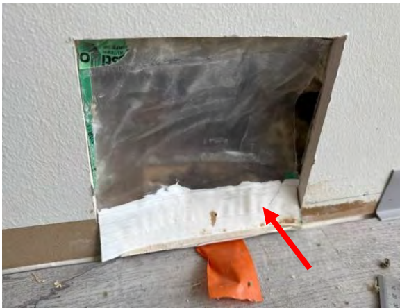
Kuva 34. Rakenneavaus RA-US 11. Alapohjan tiivistyskäsittely on ulotettu höyrynsulkumuovin sisäpinnalle.
