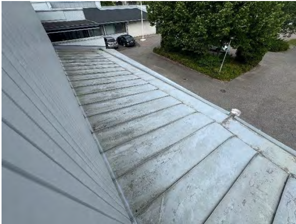
Kuva 78. Kylmien varastojen peltikate on alkuperäinen. Kate on ehjä, mutta siinä on likaker-tymää.
