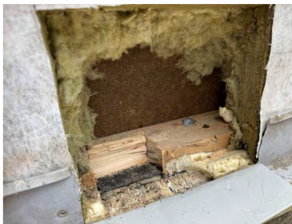
Kuva 32. Rakenneavaus RA-US 3. Alasidepuun alla on bitumihuopakaista ja sen alla mineraalivillakasta. Sisäpuolen höyrynsulku-muovi ja kipsilevytys on seinän alaosasta uusittu noin 300 mm korkeudelta lattiapinnasta.
