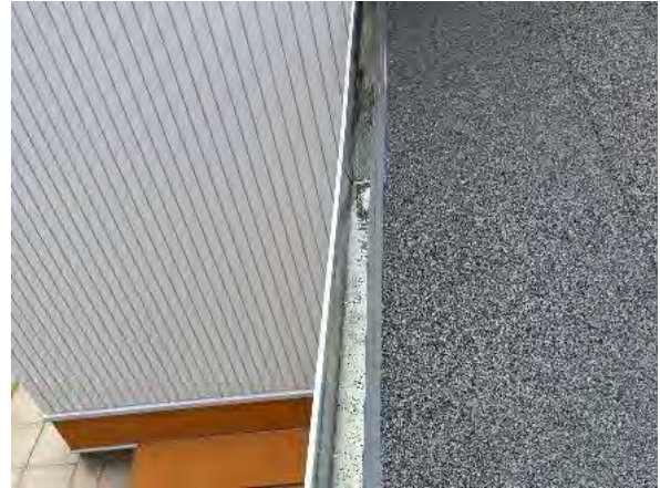
Kuva 75. Räystäskourut ovat siistit.
