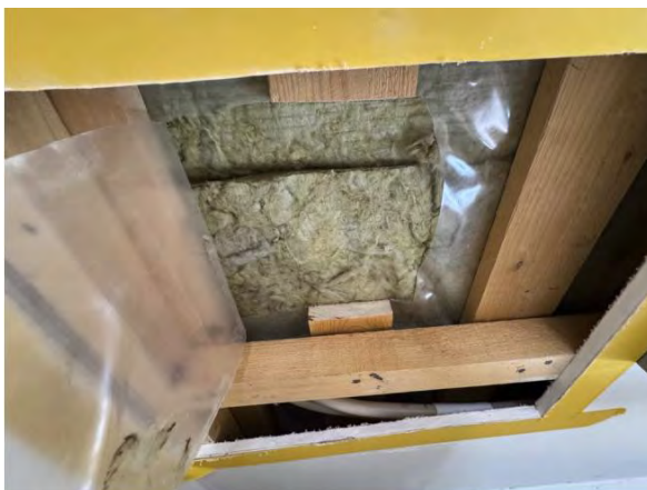
Kuva 62. Rakenneavaus RA-YP 6. Yläpohjarakenteet ovat mineraalivillalla eristettyjä, höyrinsulullisia puurakenteita.
