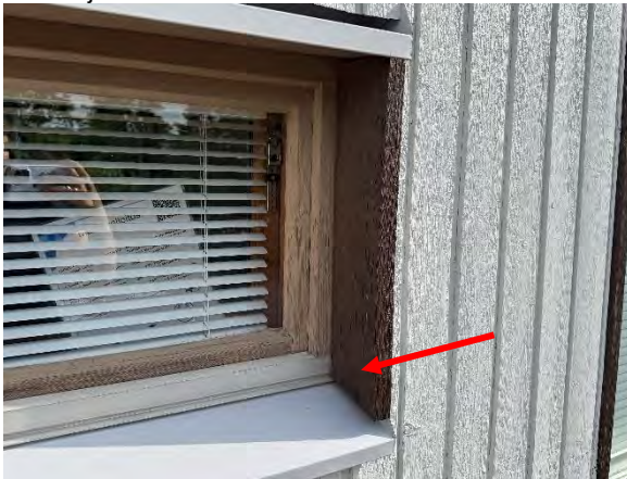
Kuva 42. Suurimassa osassa ikkunoita vesipellityksen päälle on asennettu erillinen peitelauta siten, ettei vettä pääse kulkeutumaan liitoksesta suoraan ulkoseinärakenteen sisään.
