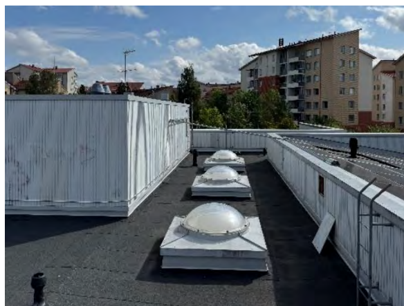
Kuva 71. Yleiskuva kattoikkunoiden kohdalta. Kattoikkunoiden liitoksissa ei aistinvaraisesti havainnoituna todettu vesitiiviyspuutteita.
