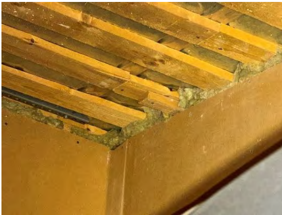
Kuva 83. Alakatossa on pinnoittamatonta mineraalivillaa ryhmä- / lepohuoneessa 110.
