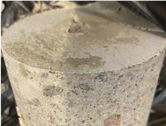
Kuva 16. Rakenneavaus RA-AP 2 lepohuoneeseen 129A. Suurimassa osassa tiloissa pintalaatan yläpintaan on toteutettu kauttaaltaan valkoinen tiivistyskäsittely vuonna 2023.
