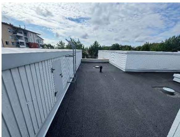
Kuva 70. Päävesikattot ovat yleisilmeeltään siistit ja hyväkuntoiset, eikä katoilla havaittu lammikoituvia alueita.
