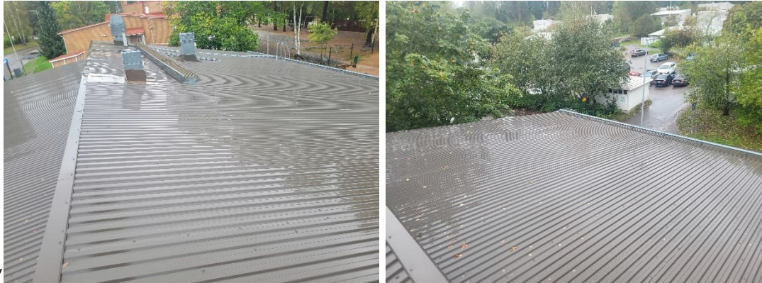
Kuva 37. Vesikatteena on profiilipeltikate. Vesikatteessa ei havaittu erityisiä puutteita tai vikoja, mahdollinen huoltomaalaus tulevana vuotena.
