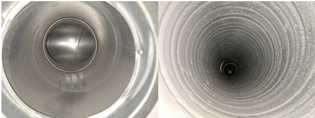
Kuva 61. Yleiskuvat ilmanvaihtokanavien sisäosista. Poistoilmakanavistossa havaittiin pölyä. Tuloilmakanavistossa havaittiin lievää pölykertymää.
