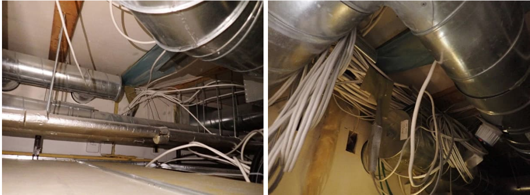
Kuva 46 Alakattotilat ovat IV-putkien ja sähköjohtojen täyttämät.
