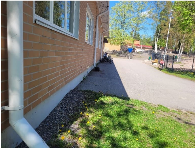
Kuva 3. Asfaltoitu piha-alue rajoittuu tontin itäpuolella aidattuun leikkialueeseen. Viettokaltevuudet rakennuksen vierillä ovat hyvät.
