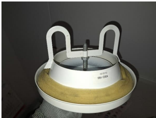
Kuva 64. Yleiskuva poistoilmaventtiilistä. Poistoilmaventtiilit ovat melko puhtaita.
