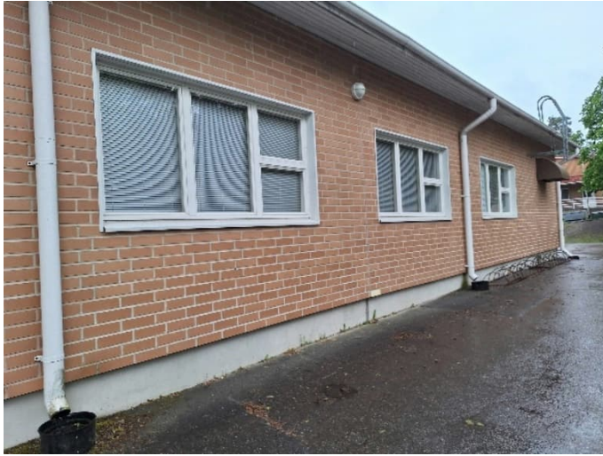
Kuva 2. Kattovedet ohjataan syöksitorvien ja sadevesikaivojen kautta pois rakennuksen lähetyviltä. Rakennuksen vierustat ovat asfaltoituja tai nurmialuetta.
