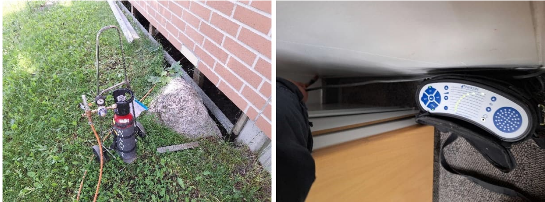
Kuva 18. Merkkiainetta syötettiin ryömintätilan kautta alapohjan eristetilaan. Merkkiainevuodot havainnoitiin sisätilojen puolelta.
