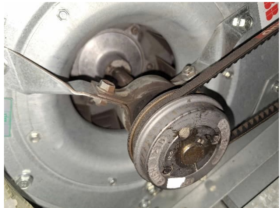
Kuva 57. Yleiskuvat poistoilmapuhaltimesta. Puhaltimen hihnat ja hihnapyörät ovat kuluneet. Myös puhaltimen äänenvaimennustyynyt ovat paikoin kuluneet.
