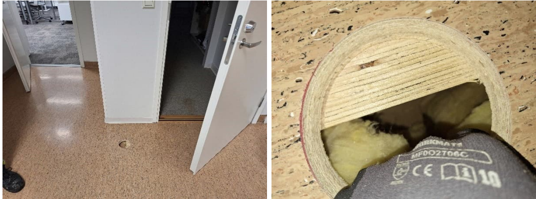
Kuva 13. Alapohjarakenteen rakenneavaus RA1 tehtiin käytävälle, rakennuksen keskiosaan. Alapohjarakenteen pinnassa on 22 mm paksu lastulevy, jonka päälle on asennettu muovimattopinnoite. Alapohjarakenteen ulkopinnassa on tuulensuojalevy. Rakenneavauksessa ei havaittu poikkeavia hajuja.
