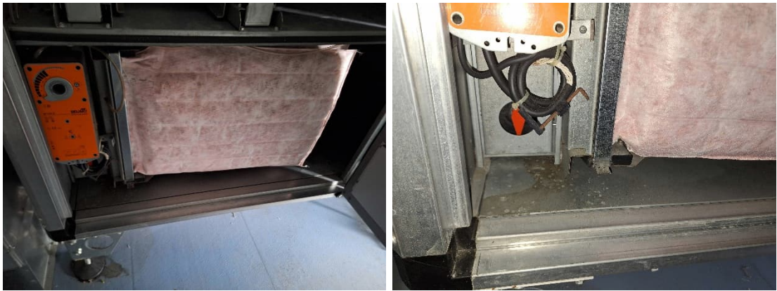
Kuva 53. Yleiskuvat ilmanvaihtokoneen raitisilmapellin moottorista sekä tuloilmasuodattimista. Suodatinkehikossa ei havaittu ohivuotoja ja raitisilmapelti sulkeutuu kiinni koneen ollessa seis -tilassa. Kammion pohjalla havaittiin likaa ja hieman vanhoja kosteusjälkiä.
