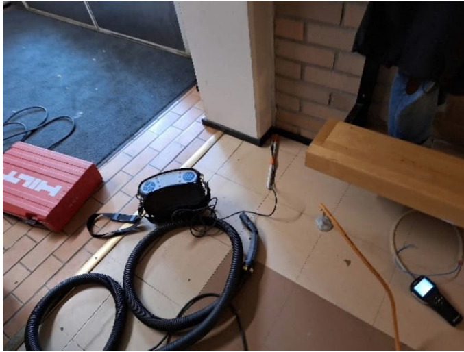
Kuva 26. Merkkiainevuotoa havaittiin pilarien ja alapohjan rakenneliittymistä. Pilarien lattia-rajasta havaittiin vuotoa normaalikäyttöä vastaavissa olosuhteissa ja ne olivat voimakkaita vuotoa.
