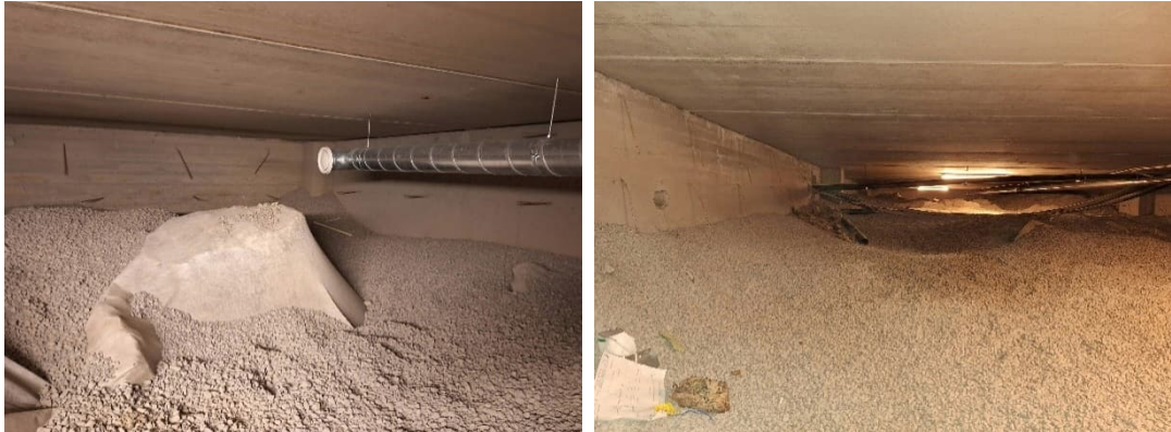
Kuva 4. Yleiskuvia ryömintätilasta. Ryömintätilassa on toimiva poistoilman vaihto. Ryömintätila kautta betonipinnoilla ei havaittu liialliseen kosteusrasitukseen viittaavia vauriojälkiä. Soratäytössä ei havaittu viitteitä poikkeavasta kosteuspitoisuudesta.
