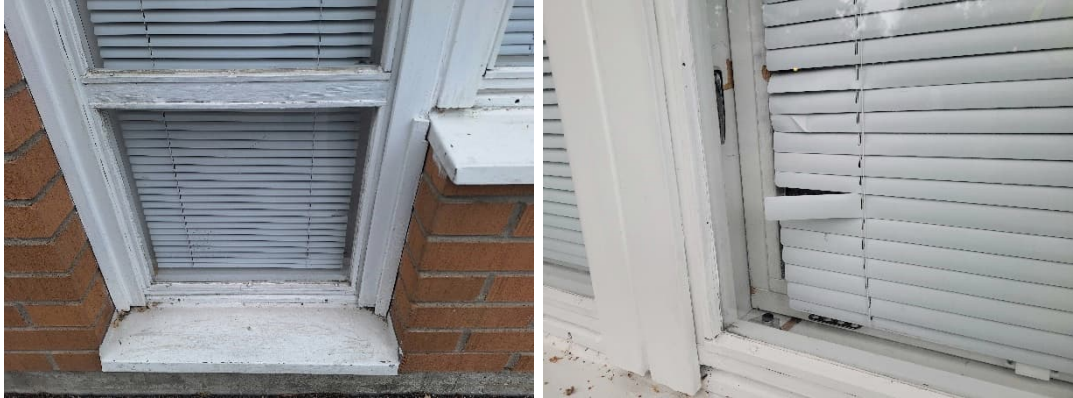
Kuva 43. Rakennuksen ikkunat ovat puuikkunoita, jotka ovat kohtalaisessa kunnossa. Ikkunoiden ulkopuitteiden maalipinta on hilseillyt etenkin sisäpihan puoleisilla seinillä. Luokkatilojen ikkunoissa on sälekaihtimet, joissa esiintyy myös vaurioita.
