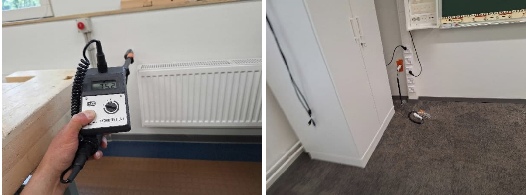
Kuva 53. Ulkoseinien sisäpinnoilla ei havaittu pintakosteuspoikkeamia. Pintakosteusmittausten lisäksi ulkoseinän kosteusolosuhteita mitattiin eristetilan hetkellisillä kosteusmittauksilla.
