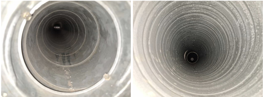
Kuva 115. Yleiskuvat ilmanvaihtokanavien sisäosista. Poistoilmakanavistossa havaittiin pölyä ja karkeaa kiviainesta. Tuloilmakanavistossa havaittiin lievää pölykertymää.
