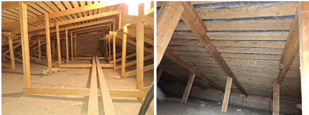
Kuva 79. Yläpohjan ontelolaattojen päälle on pukitettu puurakenteiset vesikattorakenteet. Kattorakenteessa ei ole aluskatetta.
