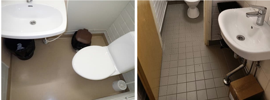
Kuva 13. Märkätilojen latioissa on käytetty muovimattoa ja keraamista laattaa vuonna 2019 uusituilla osilla.
