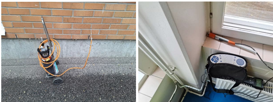
Kuva 61. Merkkiainetutkimuksissa merkkiainetta laskettiin ulkoseinän eristetilaan ulkoverhouksen tuuletusaukkojen kautta. Merkkiainevuodot
