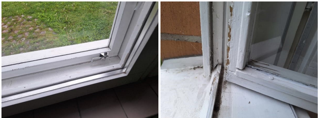
Kuva 42. Ikkunat ovat kaksipuitteisia sisään aukeavia MSE-ikkunoita. Sisäpuitteessa on lämpölasielementti. Ikkunapuitteita on tehtyjen havaintojen perusteella huoltomaalattu rakennuksen historian aikana. Ikkunapuitteiden ulkopinnassa maalipinta ei ole ehjä. Etupihan puolella ikkunapuitteiden maalipinta on hieman paremmassa kunnossa sisäpuhan puoleisiin ikkunoihin verrattuna.
