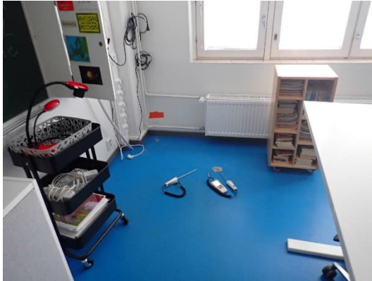
Kuva 18. Viiltomittaukset lattian vinyylilaattapinnon alta luokkatilassa 108. Sisäilman olosuhteet mitattiin viiltomittauskohdan vierestä.
