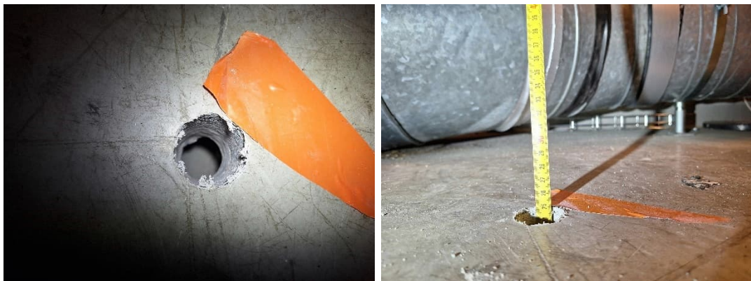
Kuva 35. Välipohjaan tehtiin rakenneavaus RA22 välipohjarakenteen kunnan ja toteutustavan varmistamiseksi. Välipohjarakenne vastaa pääosin alkuperäisiä piirustuksia. Välipohjarakenne koostuu pintalaatasta ja ontelolaatoista.
