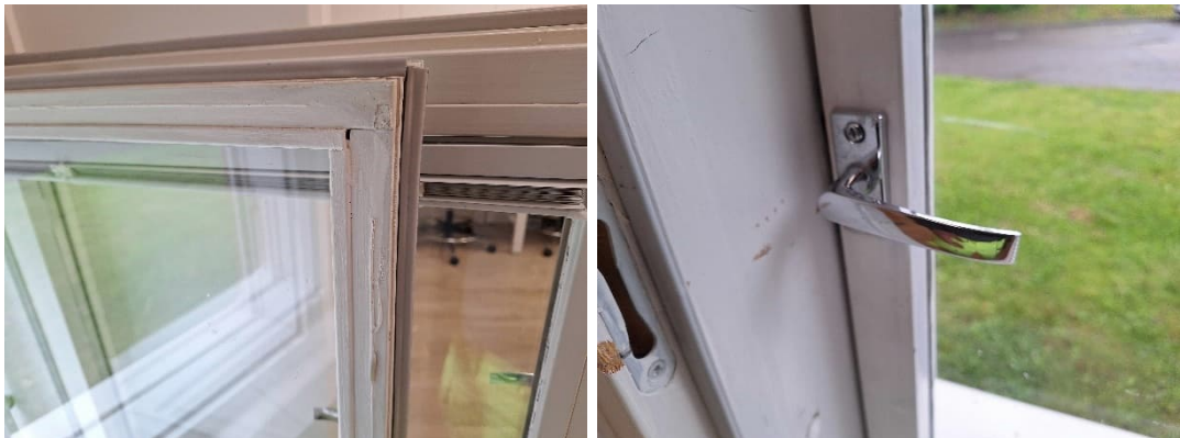
Kuva 44. Ikkunatiivisteet ovat pääasiassa hyvässä kunnossa. Ikkunoiden käynnissä havaittiin vähäisiä puutteita. Ikkunoiden sulkeminen on paikoin hieman työlästä, karmeissa on käytön jälkiä.
