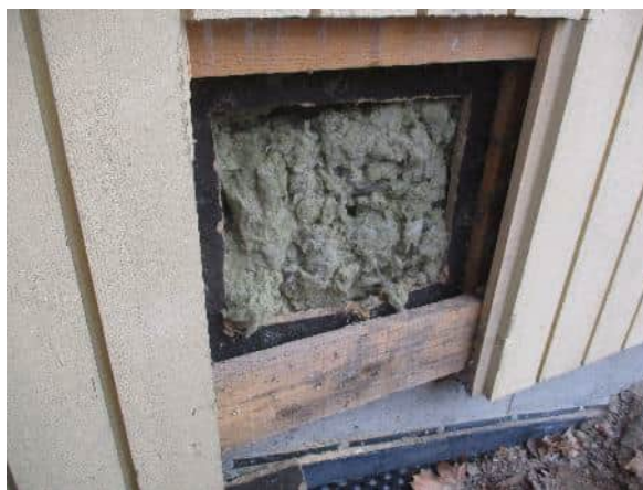
Havainnekuva rakenneavauksesta. Rakenneavauskohdassa ei aistinvaraisesti todettu viitteitä seinärakenteen alaosan vaurioitumisesta.
