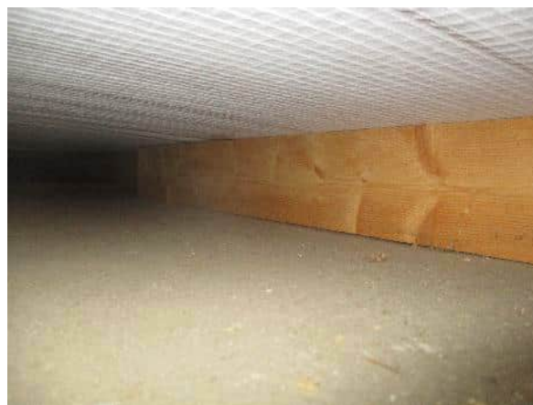
Havainnekuva rakenneavauksesta. Vesikaton aluskate [1] ei ylety selkeästi julkisivuverhouksen [2] ulkopuolelle.
