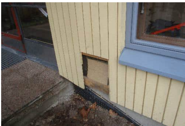
Yleiskuva rakenneavauksesta. Rakenneavauskohdassa rakennuksen viereinen maanpinta viettää silmämääräisesti tarkasteltuna loivasti rakennukseen päin.
