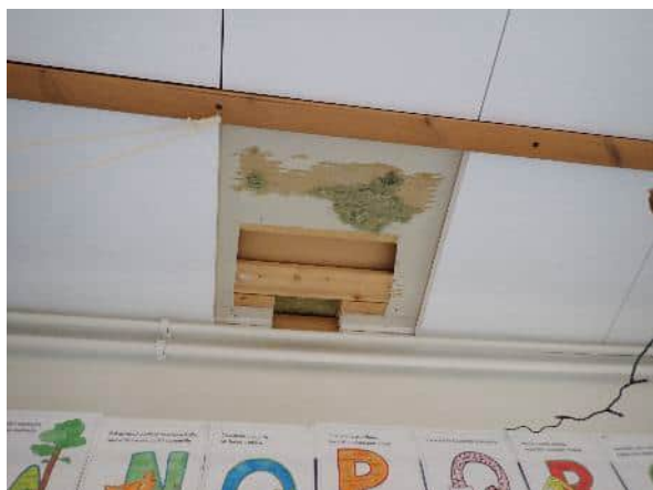
Yleiskuva yläpohjan ja ulkoseinän liittymään tehdystä rakenneavauksesta.
