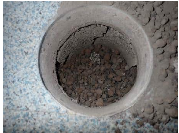
Havainnekuva rakenneavauksesta. Rakenneavauksen kohdalla kevytsorakerroksessa oli lisäksi kevytsoraharkkoja.
