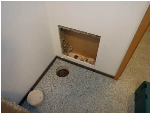
Yleiskuva väliseinän rakenneavauksesta. Kuvassa lisäksi välipohjan rakenneavaus RA.14-VP.
