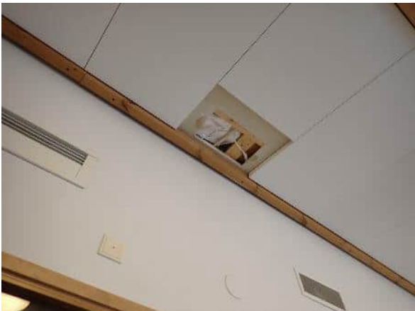
Yleiskuva yläpohjaan tehdystä rakenneavauksesta.
