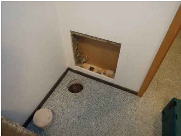
Yleiskuva välipohjan rakenneavauksesta. Kuvassa lisäksi väliseinän rakenneavaus RA.15-VS.
