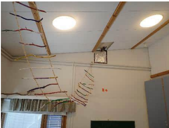
Yleiskuva yläpohjan ja ulkoseinän liittymään tehdystä rakenneavauksesta.
