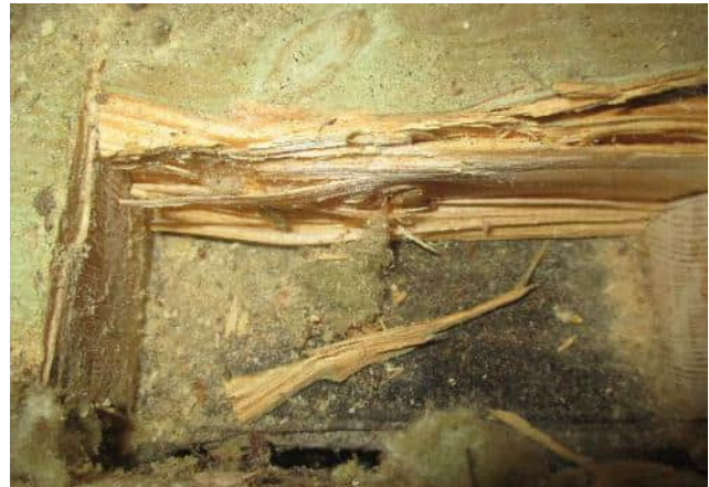
Havainnekuva rakenneavauksesta. Alaohjauspuun alapuolella on kermi. Rakenneavauskohdassa ei aistinvaraisesti todettu viitteitä seinärakenteen alaosan vaurioitumisesta.
