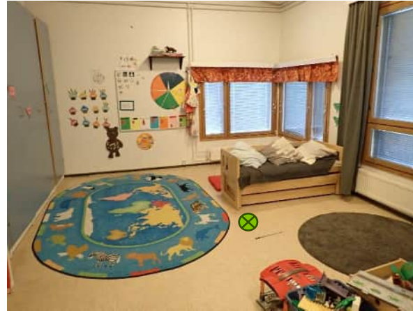
2. Välipohjan ja ulkoseinän liittymistä ei havaittu ilmavuotoja
