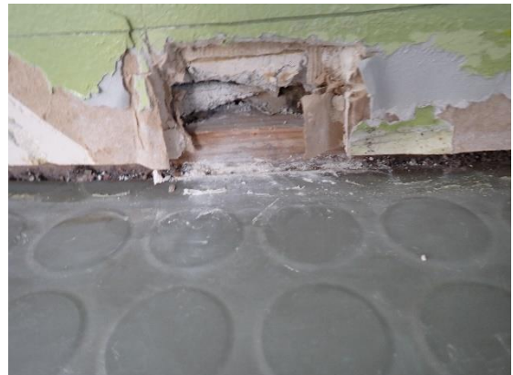
Kuva 5 Käytävän 217 seinän alaosassa siporex-elementtien alla puukiilat ja mineraalivillatilke.
