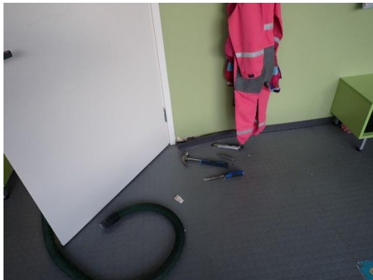
Kuva 4 Väliseinän alaosan tarkastuspiste käytävällä 217
