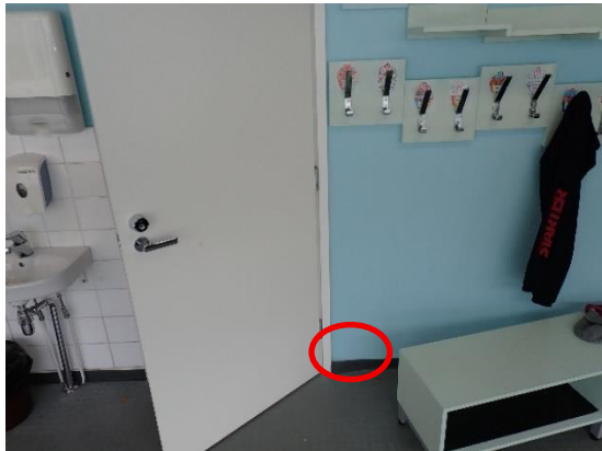
Kuva 2 Väliseinän alaosan tarkastuspiste käytävällä 242
