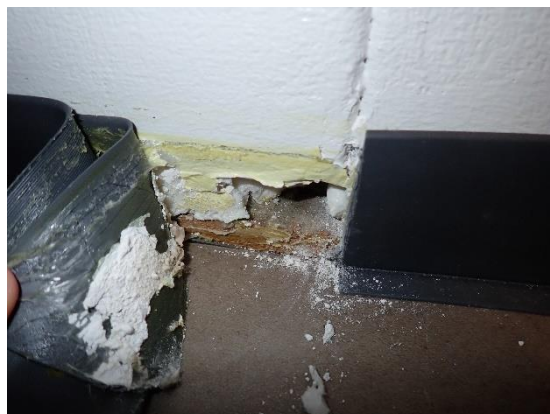
Kuva 9 Väliseinän alaosan tarkastuspiste ko- piohuoneessa 234.
