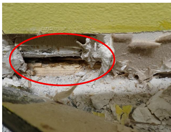
Kuva 7 Käytävän 201 seinän alaosassa sipo- rex-elementtien alla puukiilat
