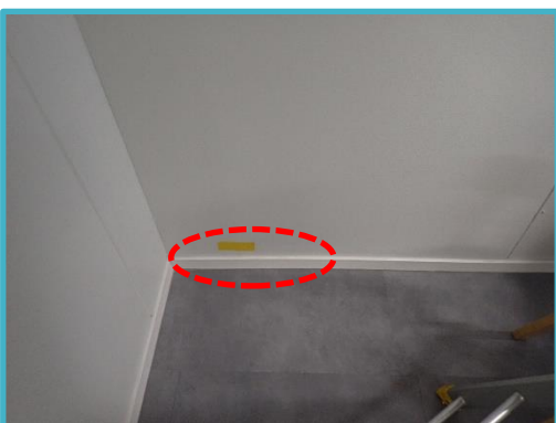
Vuotoa havaittiin myös tilan 224 ulkopuolella käytävän oviliittymässä
