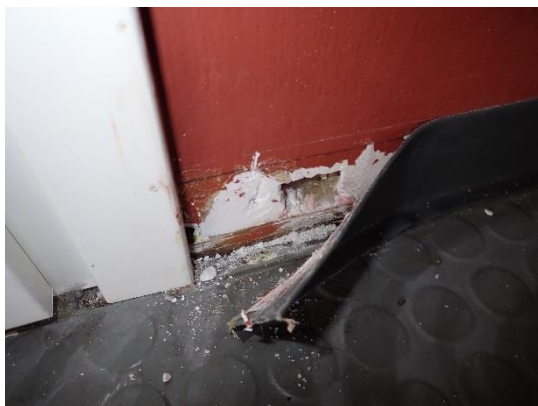
Kuva 8 Väliseinän alaosan tarkastuspiste käytävällä 257
