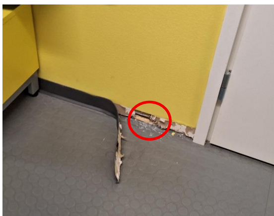
Kuva 6 Väliseinän alaosan tarkastuspiste käytävällä 201
