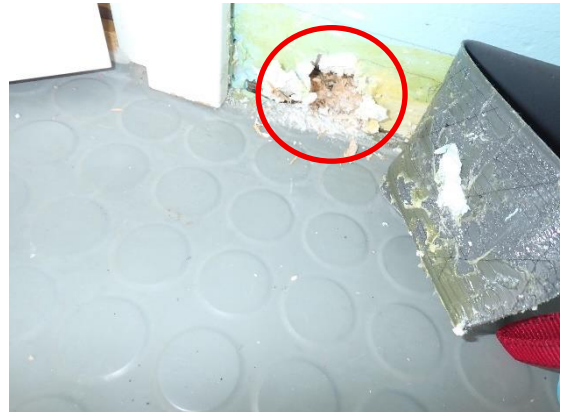
Kuva 3 Käytävän 242 seinän alaosassa siporex-elementtien alla puukiilat ja mineraalivillatilke.
