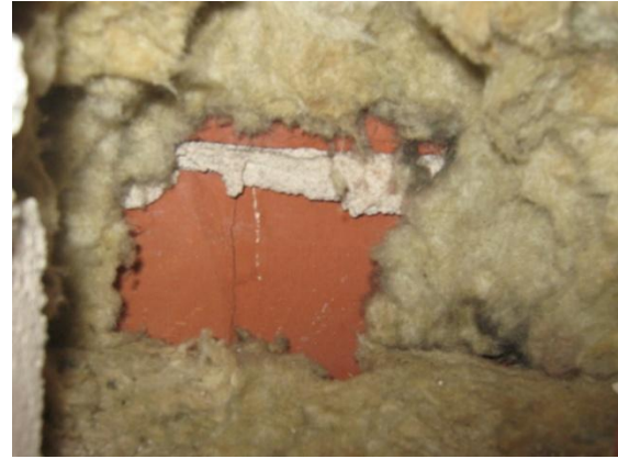
Kuva 66. Käytävän 2–30 rakenneavaus RA-US17. Rakenteet ovat kuivat eikä niissä ole normaalista poikkeavaa.
