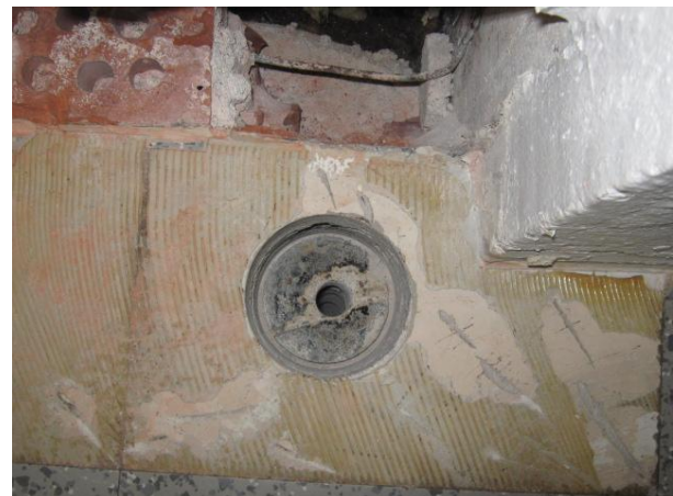
Kuva 2. Rakenneavauksen betonikerrosten välissä olevaa pikisivelyä.
