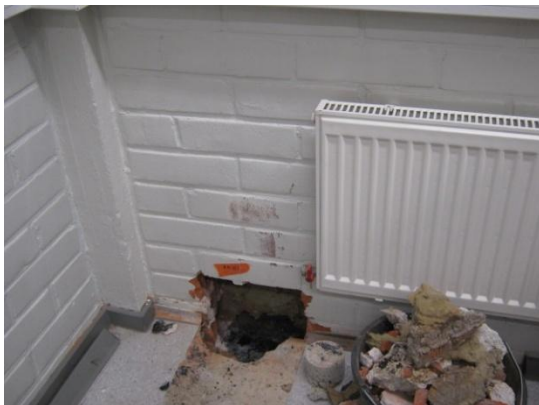
Kuva 1. Valokuva rakenneavauksen kohdasta.
