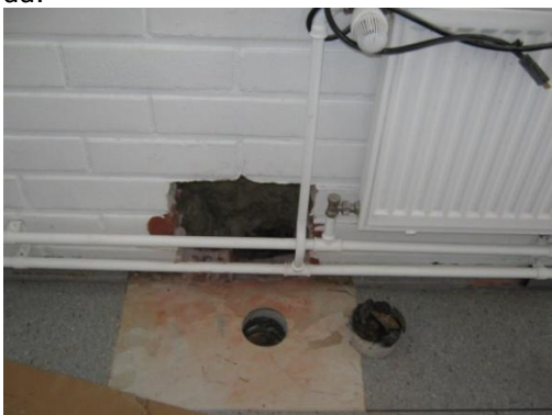
Kuva 1. Rakenneavaus ja betonista porattu lieriö rakenneavauksesta oikealla.
