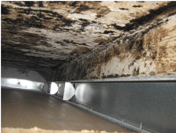
Kuva 80. Näkymä rakenneavauksesta ylöspäin. Rakenne on kuiva eikä siinä esiinny ummehtunutta tai muuta poikkeavaa hajua.
