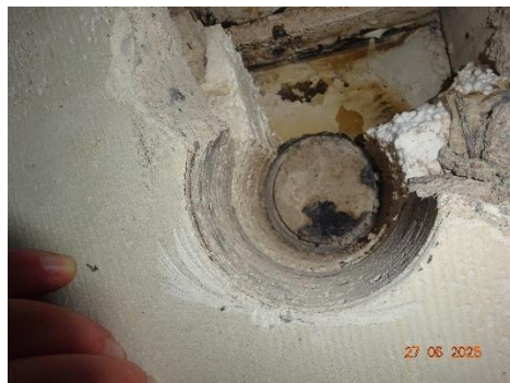
Kuva 2. Rakenteessa ei havaittu poikkeavaa.
