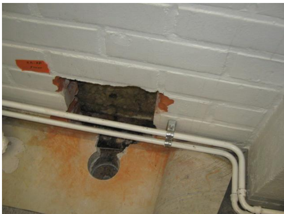
Kuva 1. Valokuva ulkoseinän rakenneavauskohdasta.
