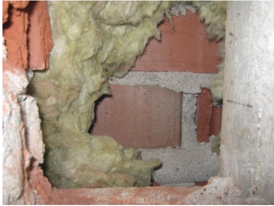
Kuva 65. Luokan 2–27 ulkoseinän rakenneavaus RA-US15. Rakenteet ovat kuivat eikä niissä ole normaalista poikkeavaa.
