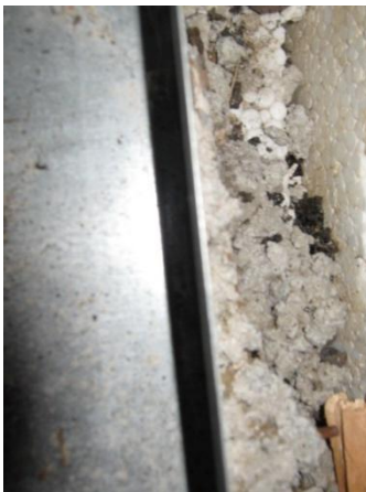
Kuva 82. Alapohjan ja maanpaineseinän välissä oleva EPS-eriste.
