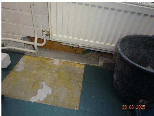
Kuva 1. Rakenneavaus tehtiin ulkoseinän alaosaan luokassa K-43.
