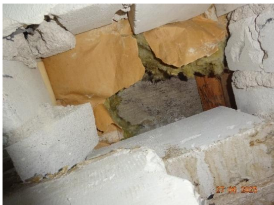
Kuva 51. Luokan K-03 RA-US2 ulkoseinän rakenneavaus (lisäosa). Sokkelin sisäpinnassa ei ole kosteudeneristystä.
