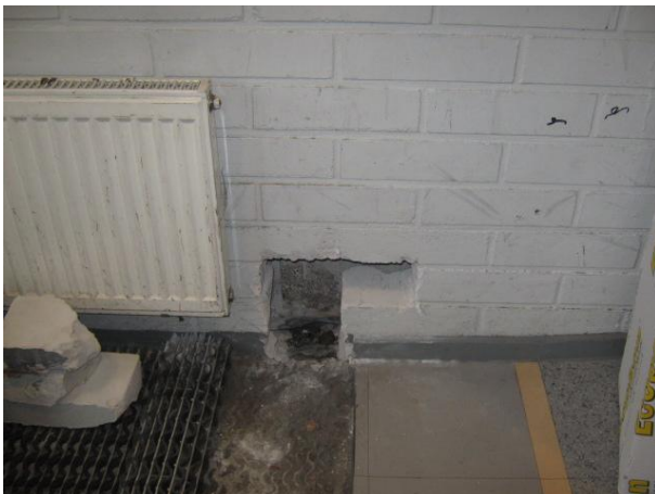
Kuva 1. Rakenneavaus TK K-04 väliseinässä.
