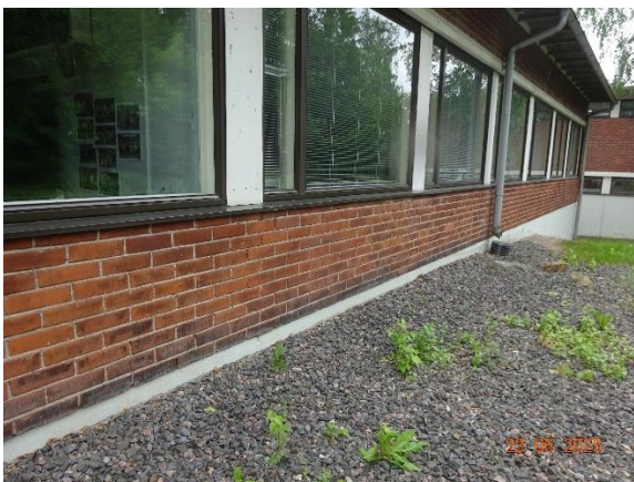
Kuva 41. Erikoisluokkasiiven luoteissivu. Kuvan oikeassa laidassa näkyy luokkaosaa.
