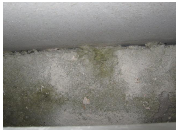
Kuva 2. Välipohjassa olevaa lämmön-/ääneneristettä.
