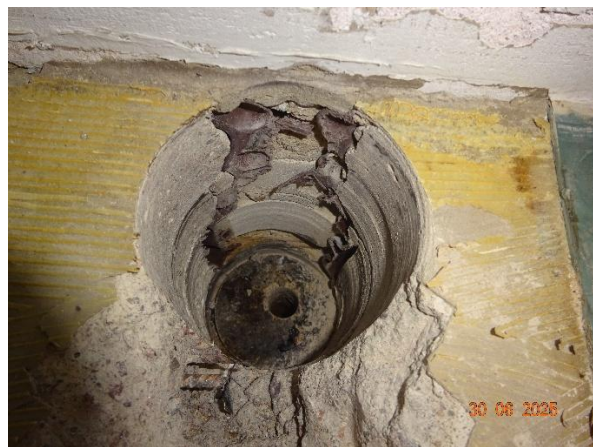
Kuva 2. Rakenneavaus, jossa näkyy alalaatan kosteuseriste sekä väliseinän patolevy.
