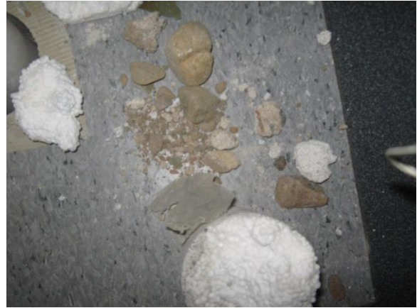
Kuva 88. Luokan 1–60 välipohjassa on pintabetonin alla EPS-eriste, muovi ja täyttönä hiekka/rakennusjäte.
