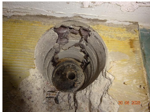
Kuva 2. Väliseinän pinnassa on patolevy. Rakenneavauksen pohjassa on näkyvillä alimman betonilaatan yläpinnassa oleva vedeneristyspiki, joka ylettyy väliseinämuurauksen pohjalaastin alle.
