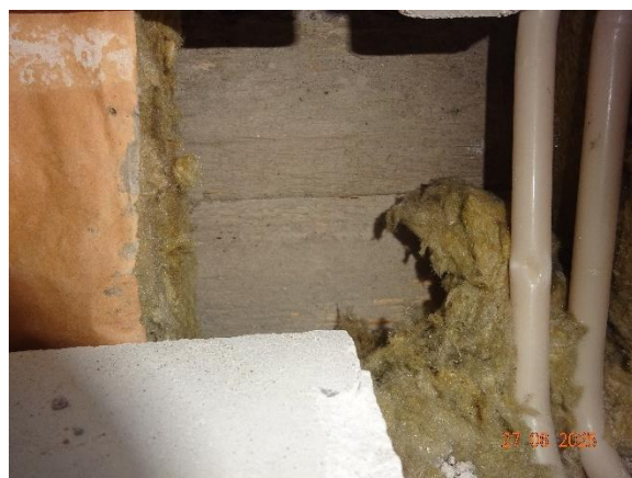
Kuva 2. Rakenneavauksessa näkyy betonirakenteinen sokkelirakenne.
