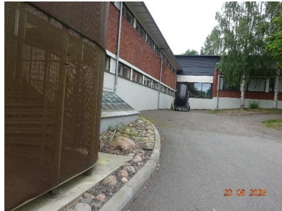
Kuva 137. Koillissivulla luokkaosan käytävän puoleisella sivulla on asfaltointi. Pinnote kallistaa rakennuksesta pois-päin riittävästi.
