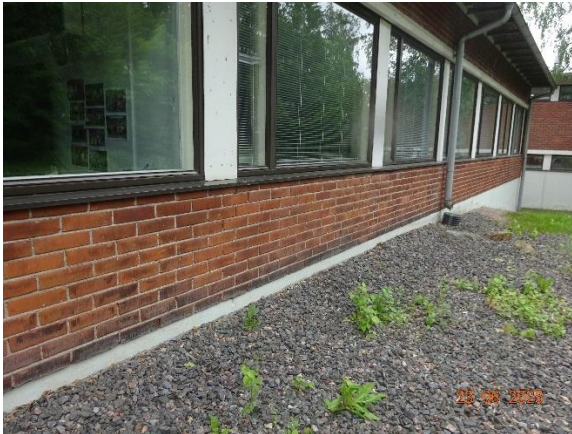
Kuva 140. Erikoisluokkasiiven luoteissivu. Rakennuksen sivulla oleva maa kallistaa rakennuksesta pois päin riittävästi.
