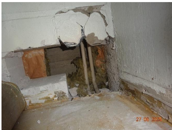
Kuva 1. Rakenneavaus tehtiin alapohjan yläpinnasta ylöspäin.
