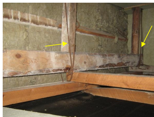
Kuva 2. Kuvassa ripustuslangat (kelt. nuoli) ja 50×50 mm kiristyspuut sekä 50×100 mm soiro.
