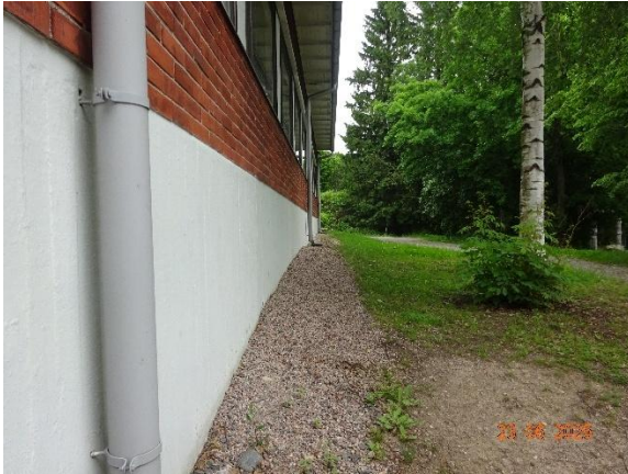
Kuva 138. erikoisluokkasiiven kaakkoissivulla on nurmikkoa sekä rakennuksen sokkelin vieressä sepelikaista. Maaperän kallistus on riittävä.
