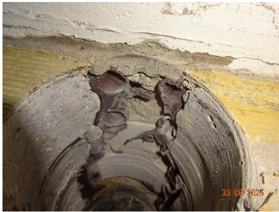
Kuva 74. VS-1 rakennetta teknisentyön luokan puolelta. Kuvassa näkyy ruskeaa patolevyä.
