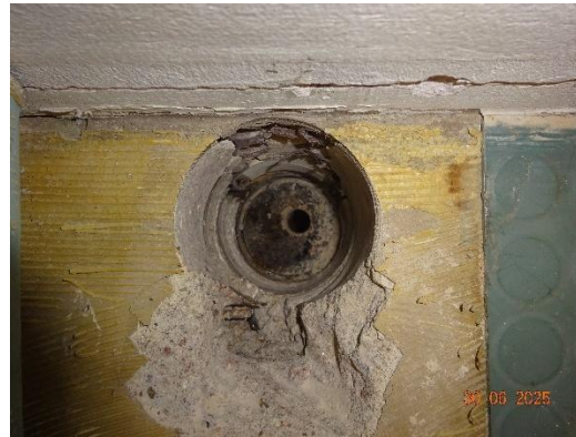
Kuva 20. Alapohjan rakenneavaus luokassa K-43, RA-AP4. Avauksessa näkyvissä alalaatan pinnassa olevaa vedeneristys sekä väliseinän patolevyä.
