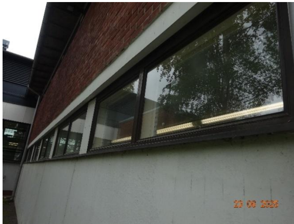
Kuva 43. Luokkaosan koillissivua luoteispäädystä.
