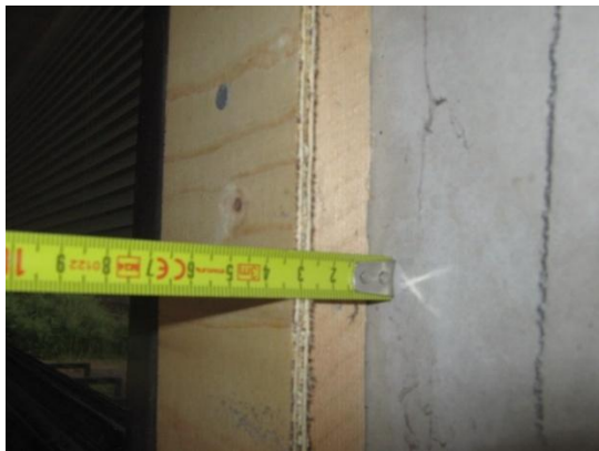
Kuva 1. Valokuva ulkoseinän rakenneavauksesta, josta on poistettu ulkoverhouslevy.
