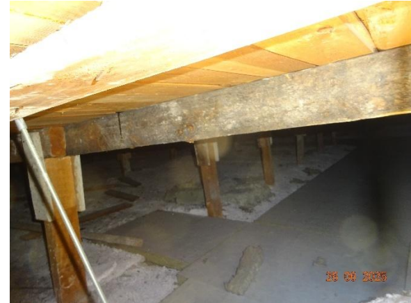
Kuva 131. Yläpohjan palopermantoa ja mineraalivillaa. Yläpohjan tuulettuvuus on hyvä.
