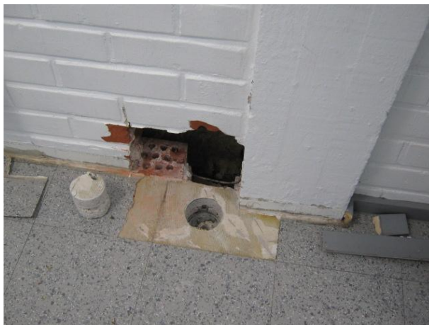
Kuva 1. Rakenneavaus ja betonista porattu lieriö.
