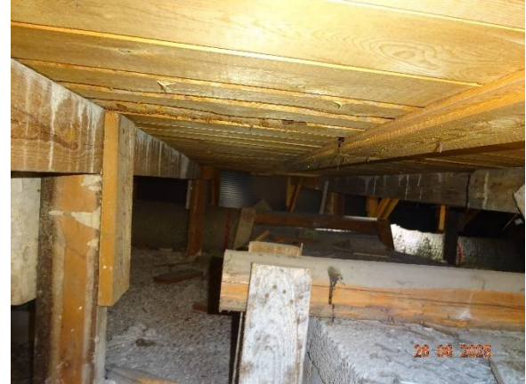
Kuva 129. Etualalla betoni- ja tiilirakenteista IV-kanaalia sekä takana eristettyä IV-kanavaa.
