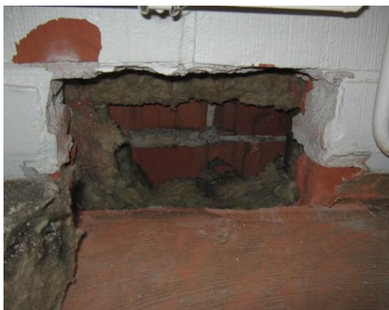
Kuva 1. Valokuva ulkoseinän rakenneavauksesta (US 12).
