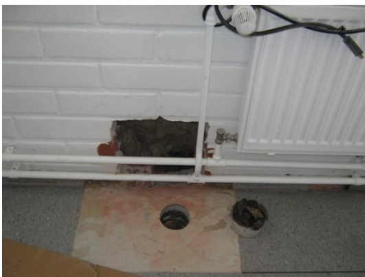
Kuva 1. Valokuva ulkoseinän rakenneavauksesta.
