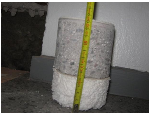
Kuva 1. Näyte rakenneavauksesta otetusta lieriöstä.
