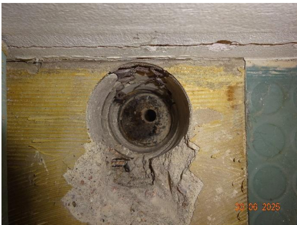
Kuva 1. Rakenneavaus luokan K-43 alapohjassa.
