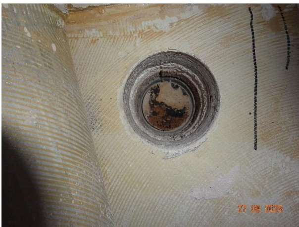
Kuva 1. Alapohjan rakenneavaus.
