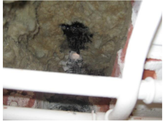
Kuva 58. Luokan 1–54 ulkoseinän rakenneavaus RA-US7. Sokkelin sisäpinnassa on pikisively.
