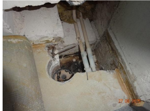
Kuva 18. Alapohjan rakenneavaus luokassa K-03, RA-AP2. Avauksessa näkyvissä alalaatan pinnassa olevaa vedeneristys.
