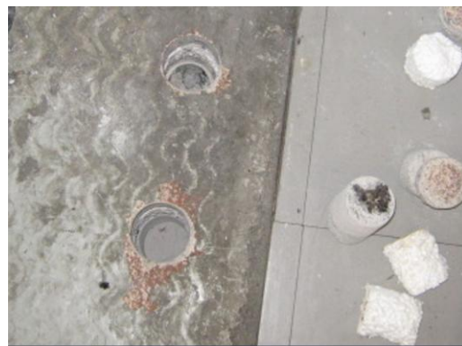
Kuva 2. Kuvassa rakenneavaukset ja näytepalat.
