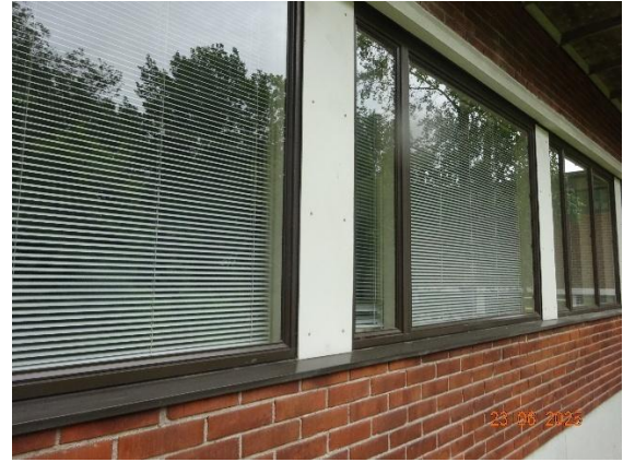
Kuva 68. Erikoisluokkasiiven kaakkoisivulla olevia ikkunoita. Ikkunat ovat hyväkuntoiset.
