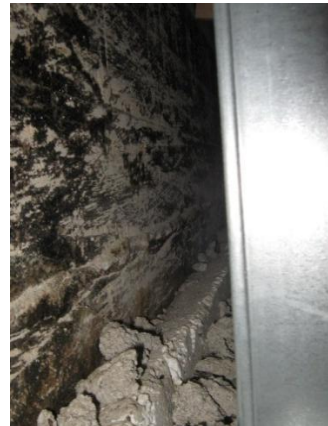
Kuva 81. Näkymä rakenneavauksesta sivusuuntaan.
