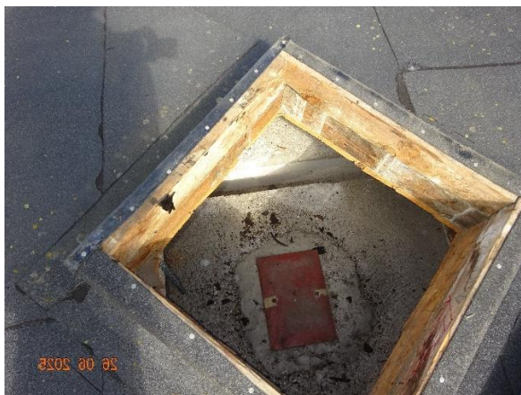
Kuva 116. Liikuntasalin katon avattu kattoluukku sekä yläpohjan päällä olevaa rakennusaienistä IV-hormia.
