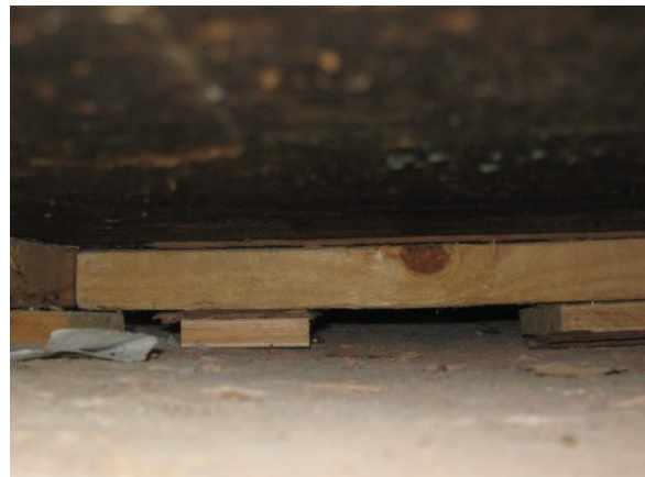
Kuva 90. Lattiaa oli korotettu noin 55 mm. Lattiapinnan alla olevan lastulevyn alapuolella on pikiliimaa.
