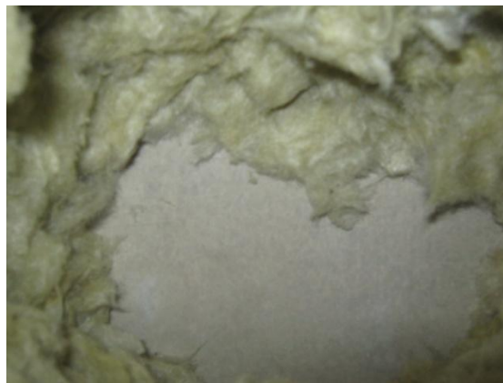
Kuva 2. Lämmöneristekerroksen takana on tuulensuojalevy.
