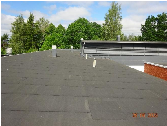
Kuva 120. Luokkasiiven vesikattoa. Oikealla erikoisluokkarakennus.
