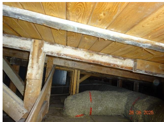
Kuva 127. Erikoisluokkasiiven puisia vesikattorakenteita. Puurakenteissa ei ole havaittavissa kosteuden aiheuttamia muutoksia.
