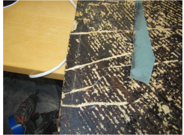
Kuva 92. Korotetun lattian alla oli vinyyli- laatan palasia.
