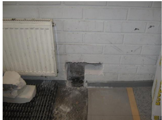
Kuva 75. TK K-04 entisen ulkoseinän rakenneavaus RA-VS-2.
