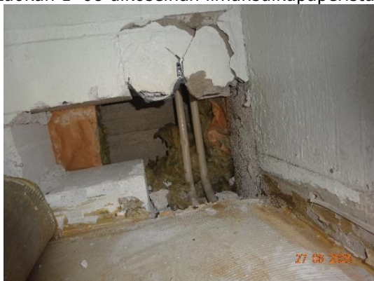
Kuva 49. Luokan K-07 RA-US1 ulkoseinän rakenneavaus (lisäosa). Sokkelin sisäpinnassa ei ole kosteudeneristystä.
