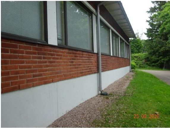
Kuva 39. Erikoisluokkasiiven kaakonpuoleinen sivu. Syöksytorvien alla on sadevesikaivot.
