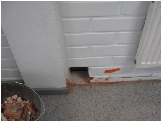
Kuva 1. Valokuva ulkoseinän rakenneavauksesta.
