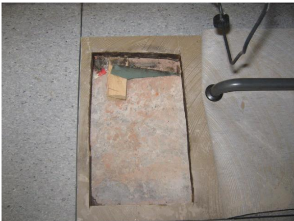
Kuva 89. Opettajainhuoneen 2–17 välipohjaan tehty rakenneavaus.
