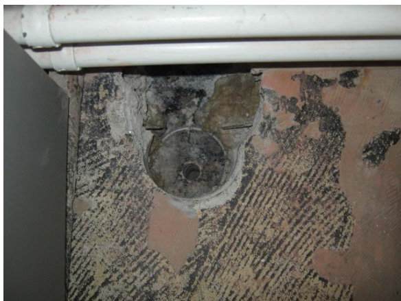
Kuva 1. Rakenneavaus kotitalousluokan alapohjassa.
