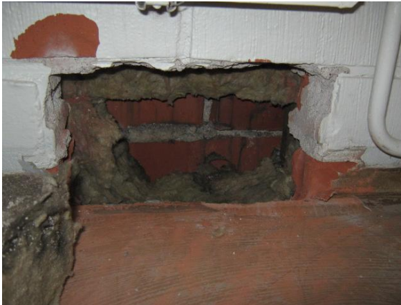
Kuva 63. Opettajainhuoneen 2-17 rakenneavaus RA-US12. Rakenteet ovat hyväkuntoiset.
