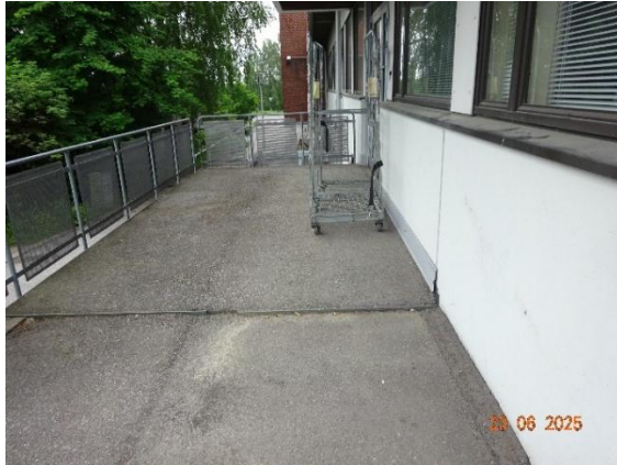
Kuva 67. Ikkunarakenteita ja pellityksiä. Pellitysten kaadot ovat loivat (lastauslaituri).
