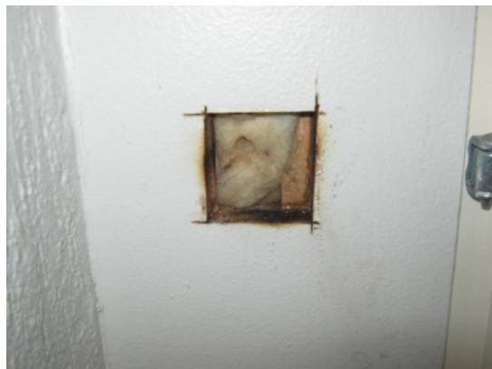
Kuva 2. Rakenneavaus sisäpuolelta.
