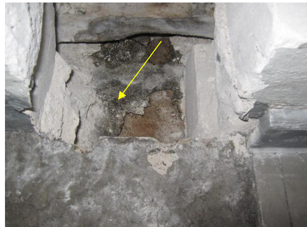
Kuva 2. Väliseinän tiilimuurauksen alla on huopa (keltainen nuoli).
