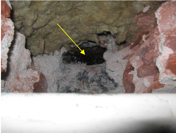
Kuva 61. Luokan 1-66 rakenneavaus RA-US10. Sokkelin sisäpinnassa on pikisively. Kuvassa näkyvissä myös sokkelihalkaisun bitumoitu korkkieriste (keltainen nuoli).
