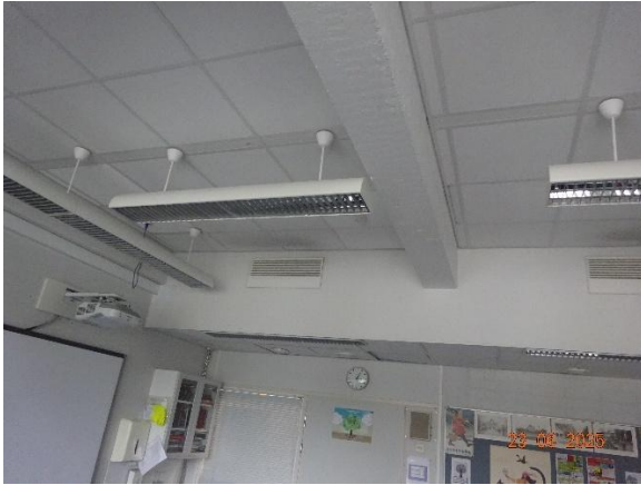
Kuva 104. Luokassa 1–60 olevaa alakattoa.
