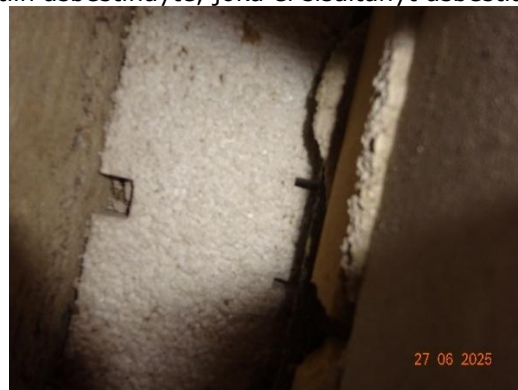
Kuva 50. Luokan K-07 RA-US1 ulkoseinässä on sokkelin sisäpinnassa 100 mm EPS-eriste, jonka ylälaita on alemman betonilaatan yläpinnan tasossa.
