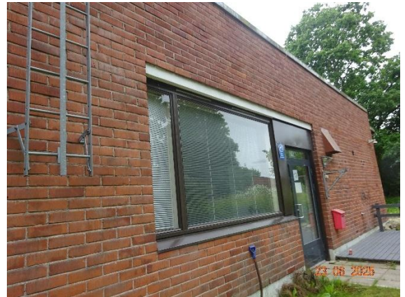
Kuva 40. Erikoisluokkasiiven koillispääty. Päädyssä on aikaisemmin ollut talonmiehen asunto.
