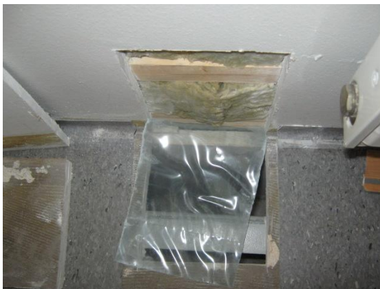
Kuva 1. Valokuva ulkoseinän rakenneavauksesta.
