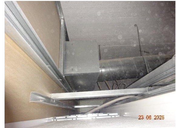
Kuva 107. Näkymä musiikkiluokan 1–74 alakaton päältä. Yläpohjan alapinnassa on pölynsidontamaalaus.
