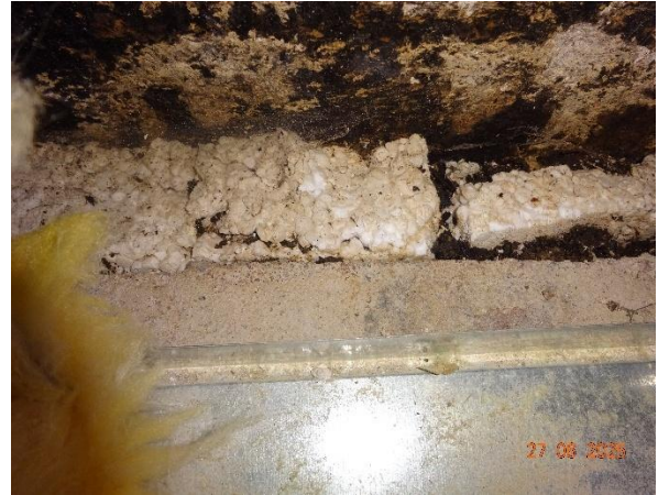
Kuva 54. Terveydenhoitajan huoneen K-39 RA-US3 ulkoseinän rakenneavaus. Alapohjan laatta on eristetty EPS-eristeellä alapohjan kohdalla ulkoseinän betonirakenteesta.
