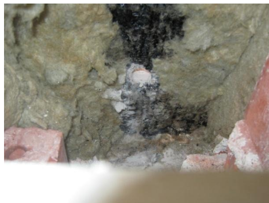
Kuva 2. Rakenneavauksessa ulkopuolen sokkelin sisäpinnassa olevaa pikisivelyä.
