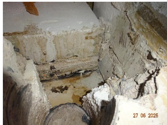
Kuva 2. Sisäverhouksmuuraus alkaa alimman betonilaatan päältä.
