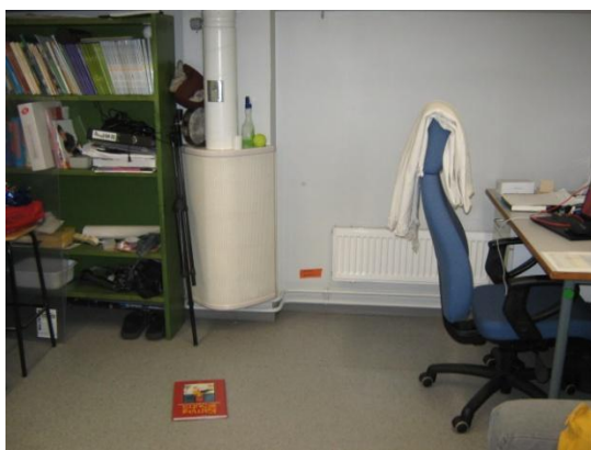
Kuva 1. Rakenneavaus tehtiin maanvastaiseen seinään oranssin teipin kohdalle.
