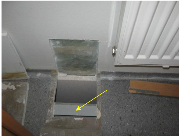
Kuva 93. Kanslian 2-05 välipohjan raken- neavaus. Näkyvissä U-palkki (keltainen nuoli).
