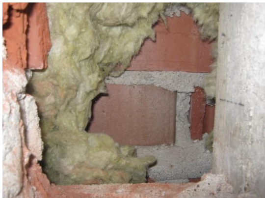
Kuva 1. Valokuva ulkoseinän rakenneavauksesta. Lämmöneristekerroksen takana on julkisivumuuraus.
