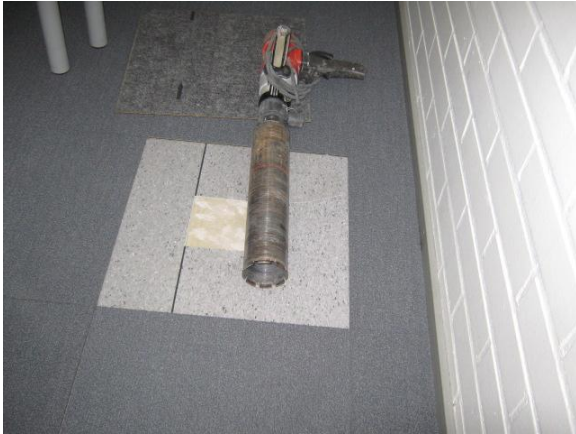
Kuva 87. Luokan 1–60 välipohjan muovimaton päällä on tekstiililaatta.
