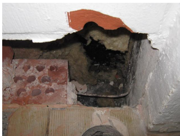
Kuva 2. Rakenneavauksesta voidaan nähdä ulkoseinän pikisiveli sokkelin sisäpinnan betonirakenteessa.
