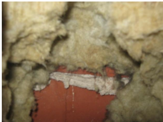
Kuva 2. Lämmöneristekerroksen takana on julkisivumuuraus.
