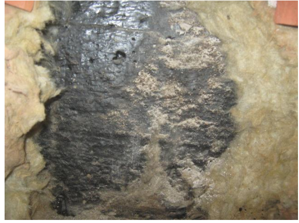
Kuva 62. Luokan 1-77 rakenneavaus RA-US11. Rakenne on samanlainen kuin luokassa 1-66.
