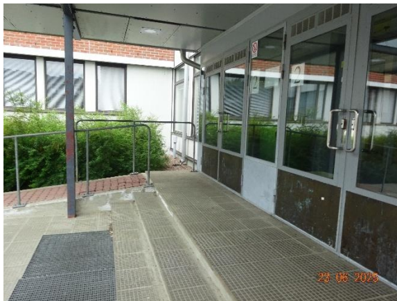
Kuva 144. Pääsisäänkäynnin edessä olevaa betonilaatoitusta.
