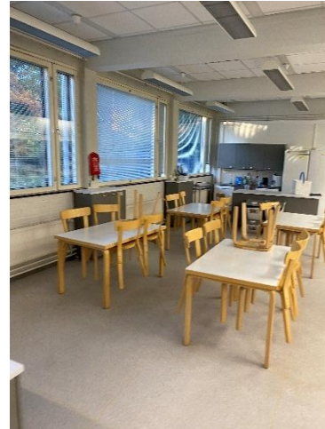
Kuva 16. Kotitalousluokan lattiapäällysteenä on muovimatto.
