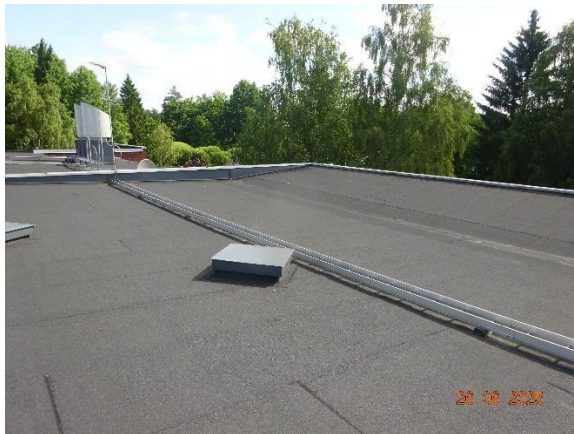
Kuva 114. Yleiskuva liikuntasalin vesikattosta.
