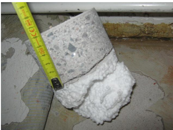
Kuva 1. Näyte rakenneavauksesta otetusta lieriöstä.
