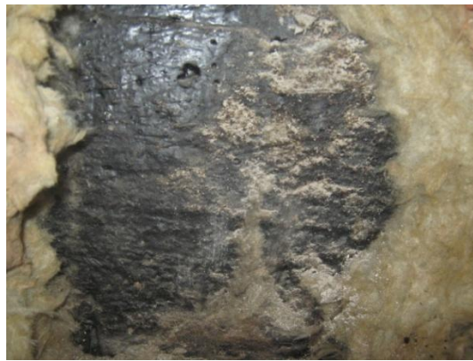
Kuva 2. Kuva rakenneavausaukon pohjalta, jossa näkyy sokkelin sisäpinnassa oleva pikisively.
