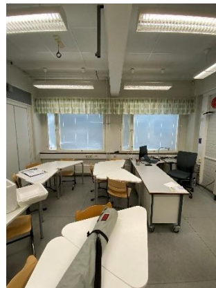
Kuva 10. Luokan K-5 lattiapinnoitetta (muovimatto).
