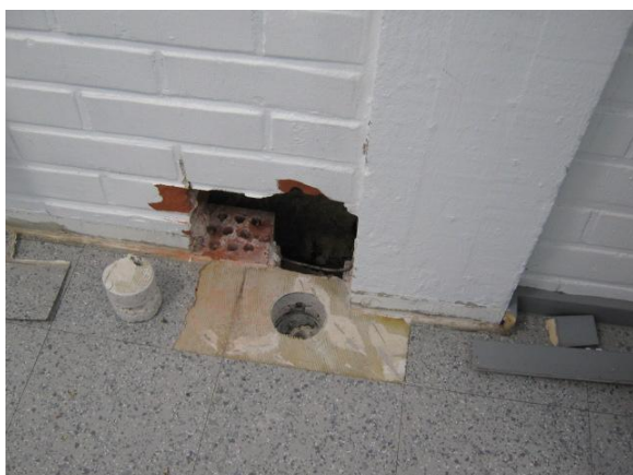
Kuva 1. Ulkoseinän rakenneavaus käytävällä 1-57.
