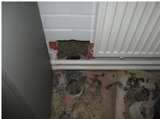
Kuva 1. Valokuva rakenneavauksen kohdasta.
