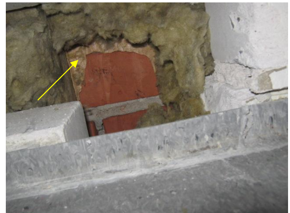
Kuva 56. Tilan 1-08 ulkoseinän rakenneavaus RA-US5. Lämmöneristeen takana on näkyvissä ilmansulkupaperia (keltainen nuoli).
