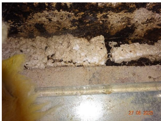
Kuva 2. Kuvassa alapohjan ylimmäisen laatan ja ulkoseinän betoniseinän välissä oleva EPS-eristyskaista.
