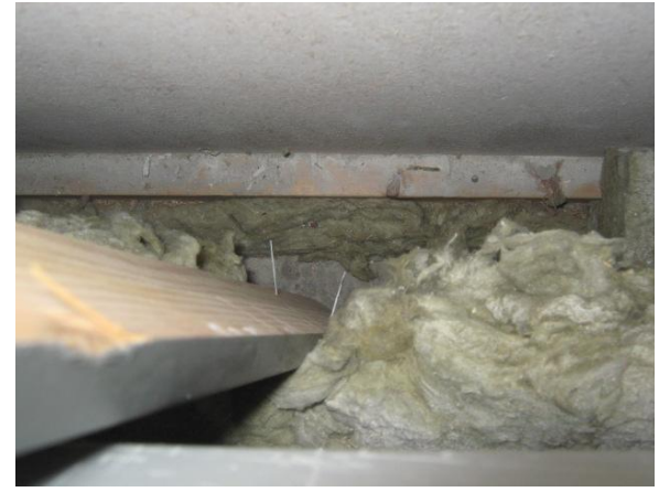
Kuva 94. Rakenneavauksesta on havait- tavissa eristekerros ja kantava betoni- laatta.
