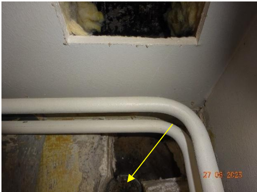
Kuva 19. Alapohjan rakenneavaus luokassa K-39, RA-AP3. Avauksessa näkyvissä alalaatan pinnassa olevaa vedeneristys.
