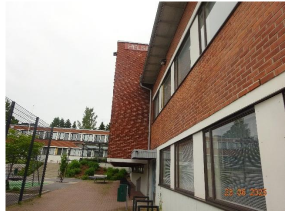
Kuva 70. Lisäosan lounaissivulla olevia ikkunoita. Ikkunoiden pellitykset ovat loivat.
