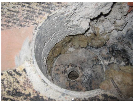
Kuva 2. Alimman laatan alla oleva täyttökerros on painunut.
