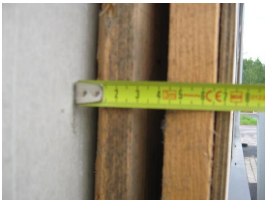
Kuva 1. Valokuva ulkoseinän rakenneavauksesta, josta on poistettu ulkoverhouslevy.
