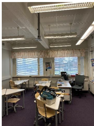
Kuva 11. Luokan K-02 muovimaton päällä olevaa tekstiililaattaa.
