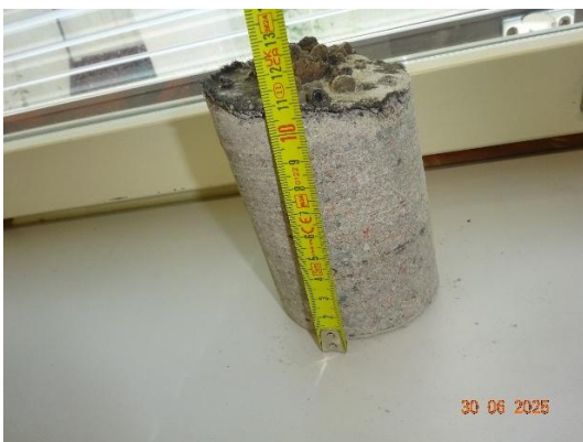
Kuva 21. Luokan K-43, RA-AP5, jossa alapohjan betonilaatan alla oli suodatin kangas ja 200 mm kevytsoraa.
