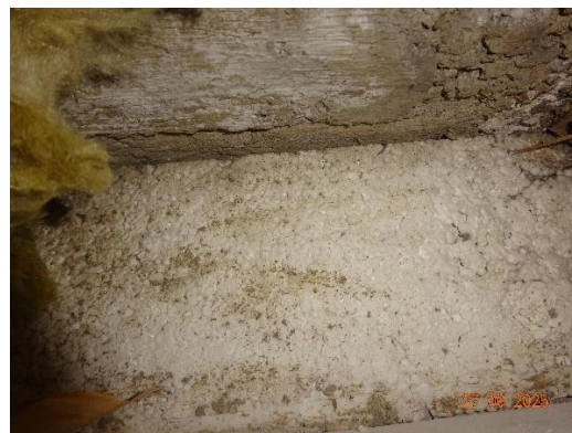
Kuva 52. Luokan K-03 RA-US2 ulkoseinässä on sokkelin sisäpinnassa 100 mm EPS-eriste.
