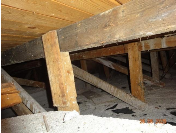
Kuva 118. Liikuntasalin yläpohjan puisia vesikaton kannatinrakenteita.
