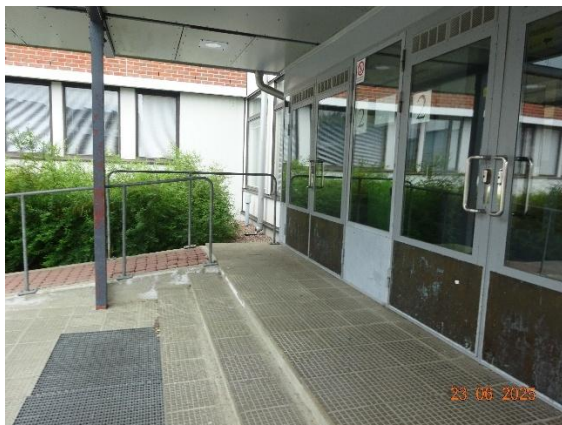
Kuva 71. Helsingin skolan metallirakenteiset pääovet.
