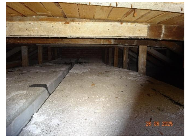
Kuva 117. Yläpohjan puurakenteita ja IV-hormeja.
