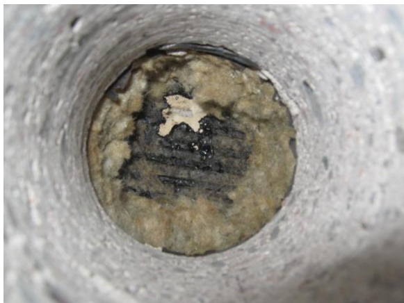
Kuva 85. Ruokalan 1–23 välipohjan rakenneavaus. Avauksessa näkyvissä tervapaperi, mineraalivillakerros ja pikisively.
