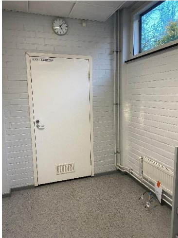
Kuva 15. Käytävän 1–57 lattian muovilaattapinnoitetta.
