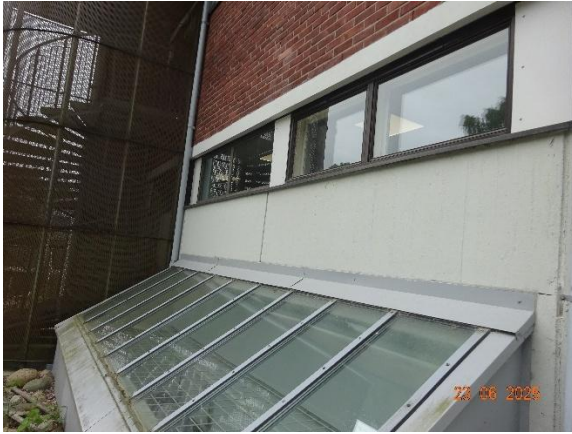
Kuva 37. Koillispäädyssä oleva kellarikerroksen tilan ikkunarakenne. Kuvan vasemmassa laidassa on hätäpoistumistie.
