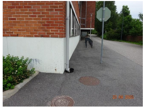
Kuva 135. Kaakkoissivulla olevaa asfaltointia. Maa kallistuu rakennuksesta pois-päin riittävästi.
