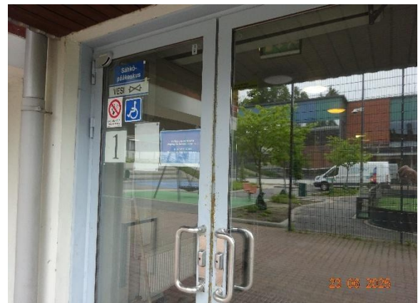
Kuva 72. Lisäsiiven metallirakenteiset ulko-ovet.
