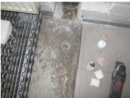
Kuva 1. Rakenneavauksia tehtiin 2 kpl näytepala lieriö.
