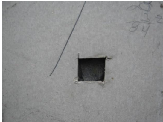
Kuva 2. Kuitusementtilevyyn tehtiin aukko, jonka kautta mitattiin lämmöneristeen paksuus ja rakennekerrokset.
