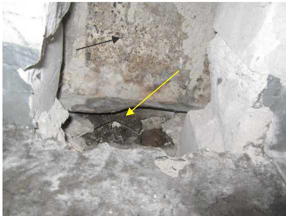
Kuva 76. RA-VS-2, jossa on havaittavissa kalkkiahiekkatiili ja sen takan ilmarako. Kalkkiahiekkatiilimuurauksen alla oli huopakasta (keltainen nuoli). Kuvan pohjalla on näkyvissä vanhan ulkoseinän betonipinta (musta nuoli).
