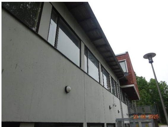
Kuva 35. Betonirakenteista julkisivua kaakkoissivulla (alalaidassa lastauslaituri).
