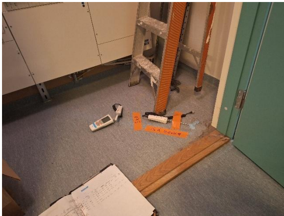
Kuva 39. Viiltomittaus VM5 tehtiin sähköpääkeskus 115:n kynnyksen läheisyyteen.
