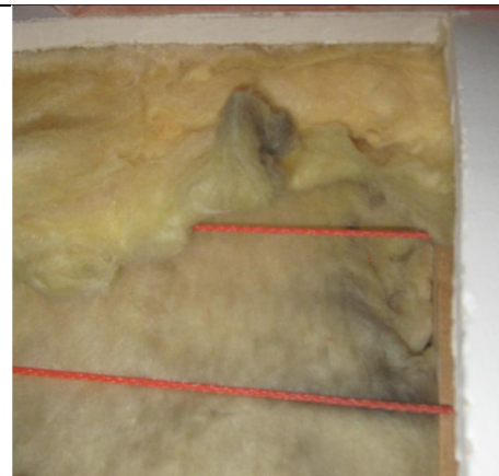
Kuva 61. Seinässä on eristekerrokset, joiden välissä on ilmarako. Luokan 111 puoleisen väliseinän eristekerros on tuettu nailon naruilla.
