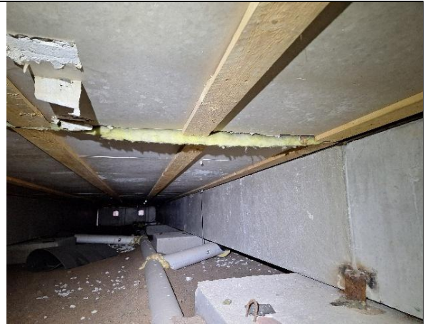
Kuva 26. Kuvassa elementtien sauma, jonka lämmöneristeet ovat näkyvissä.
