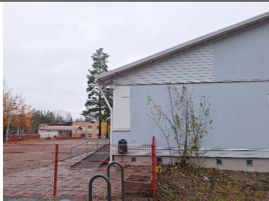
Kuva 92. Eteläpäädyssä oleva syöksytorvi.
