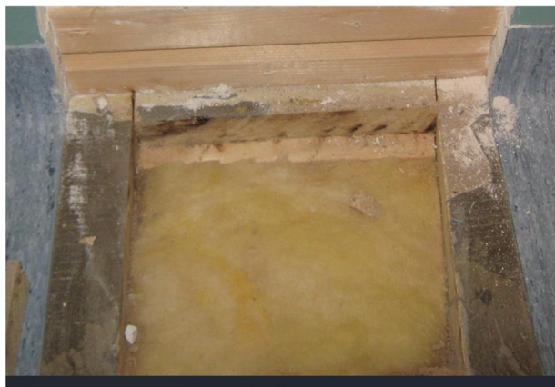
Kuva 2. Rakenneavauksessa ei havaittu normaalista poikkeavaa. Lämmöneriste ulottui lastulevyn alapintaan saakka.
