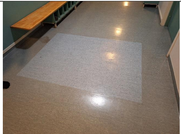
Kuva 18. Käytävä 126:n muovimattoja uusittu.
