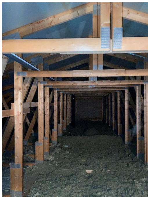
Kuva 80. Yläpohjan kattoristikoita. Ristikkoiden pystydiakonaalien kohdalla on alapuolella kantavat käytävän seinät.
