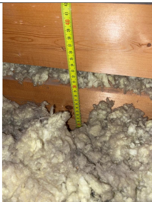
Kuva 83. Lämmöneristekerroksen paksuus on paikoin 250 mm
