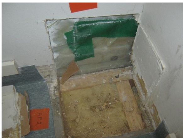
Kuva 1. Rakenneavaukseen kohtaan oli aikaisemmin tehty rakenneavaus.
