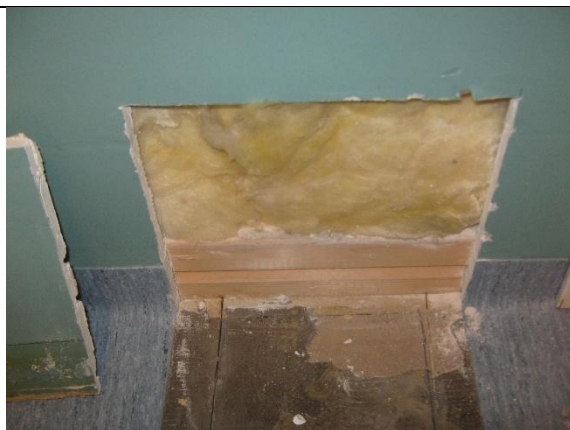
Kuva 56. Iepohuoneen 125 ja käytävän 126 väliseinä.
