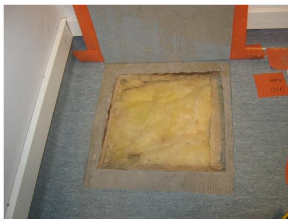
Kuva 2. Alapohjan rakenneavauksessa ei havaittu normaalista poikkeavaa.
