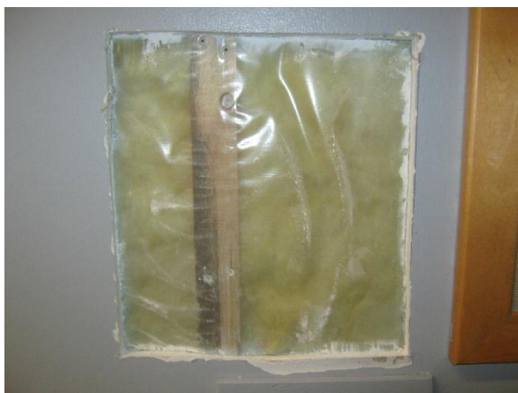
Kuva 1. Rakenneavaus luokan 111 ulkoseinässä.
