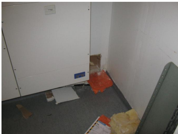
Kuva 1. Rakenneavaus SPK 115 ja keittiön 116 väliseinässä.
