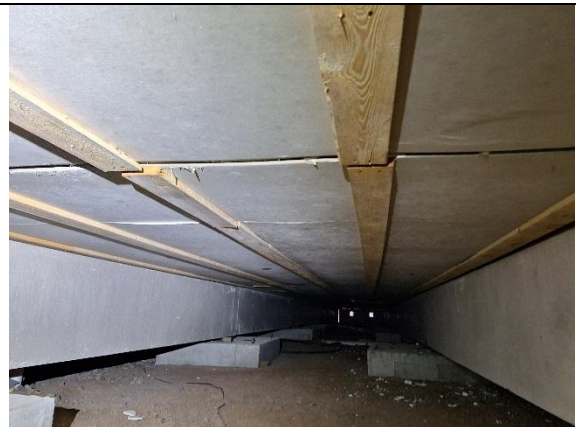
Kuva 24. Näkymä alapohjasta. Ryömintätilan korkeus on 950 mm.
