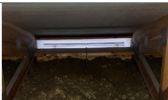
Kuva 82. Pien-eläinverkko on asennettu kattoristikkoiden väliin räystääslinjalla.
