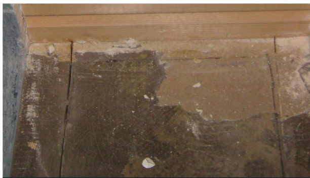
Kuva 1. Ryhmätilan 125 alapohjanrakenneavauskohta käytävän 126 väliseinän vieressä.
