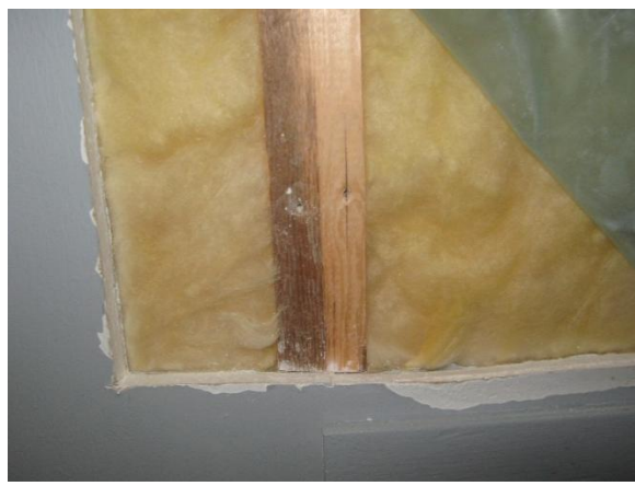
Kuva 2. Kuvassa näkyvän runkopuun vasemmassa laidassa oleva tummempi kohta ei ole kosteuden aiheuttama jälki.
