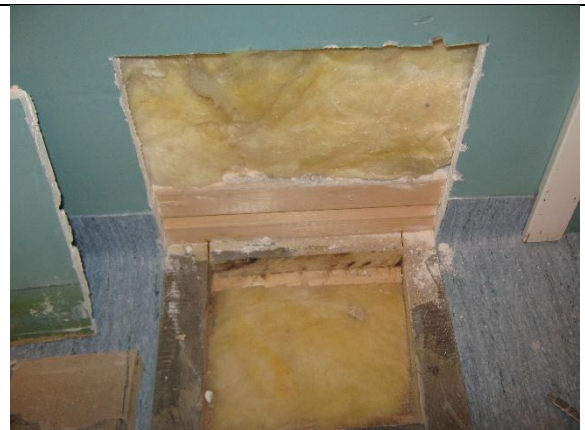
Kuva 36. Rakenneavaus AP4, huone 125. Alapohjan lämmöneriste oli asennettu tiiviisti alapohjaan.
