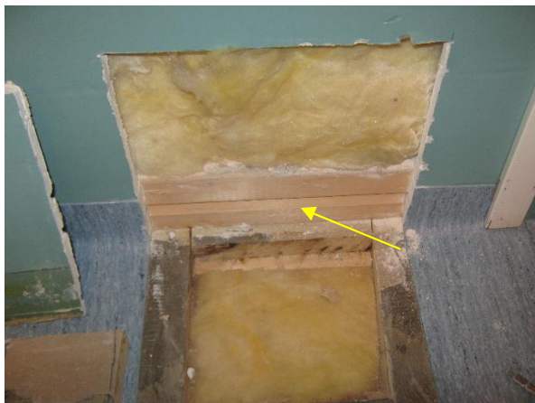
Kuva 1. Rakenneavaus lepo7leikkihuoneen 125 seinässä. Väliseinän elementtirungon alla on alaohjauspuu (keltainen nuoli).
