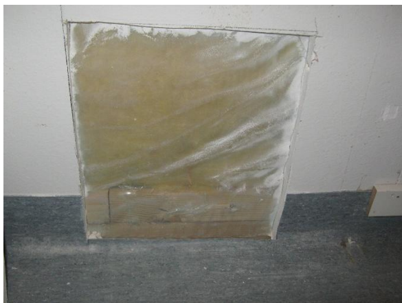
Kuva 1. Rakenneavaus luokan 125 ulkoseinässä.
