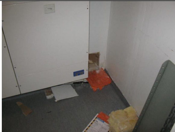
Kuva 58. Rakenneavaus SKP 115 ja keittiön väliseinässä.
