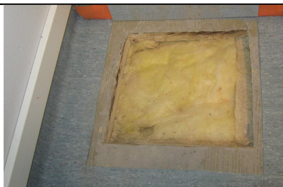
Kuva 37. Rakenneavaus AP5 työtila 108. Alapohjan lämmöneriste oli asennettu tiiviisti alapohjaan.
