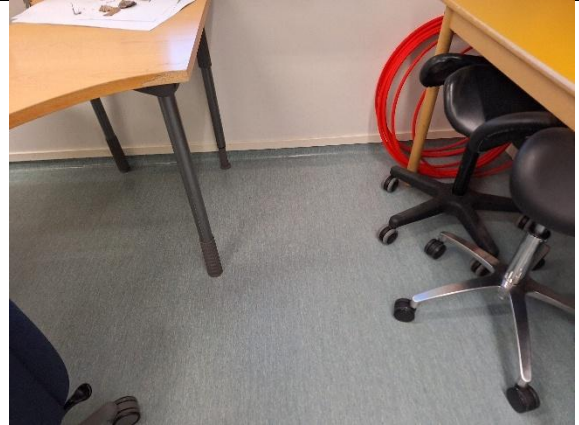
Kuva 16. Muovimatto on nostettu reunoilta seinää vasten.
