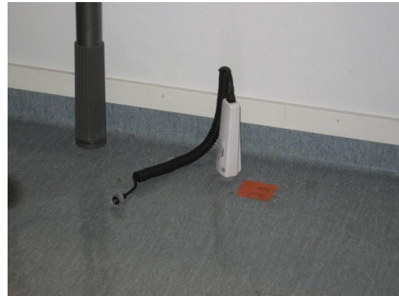
Kuva 42. Lämmöneristeen kosteuspitoisuutta mitattiin n. 200 mm syvyydeltä.
