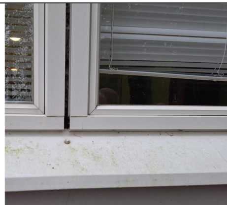
Kuva 50. Ikkunan vesipellititys ulottuu ikkunan karmissa olevaan vesipellin uraan.
