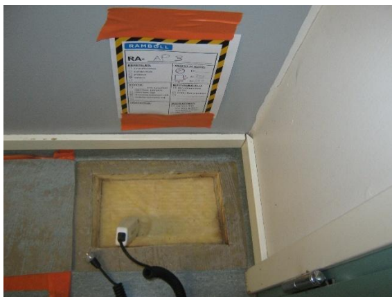
Kuva 1. Luokan 111 alapohjanrakenneavaus. Rakenteet on toteutettu suunnitelmien mukaan.
