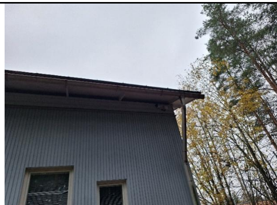
Kuva 48. Kuva länsisivun ulkoverhouk- sesta.
