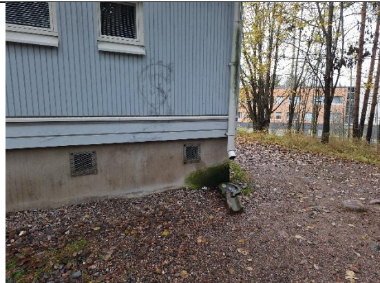
Kuva 95. Näkymä itäsivun pohjoispäädyn syöksytorvesta ja betonisesta loiskekupista.
