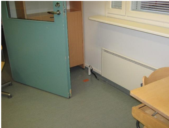
Kuva 41. Alapohjan lämmöneristekerroksen kosteuspitoisuutta mitattiin puikkomittareilla.
