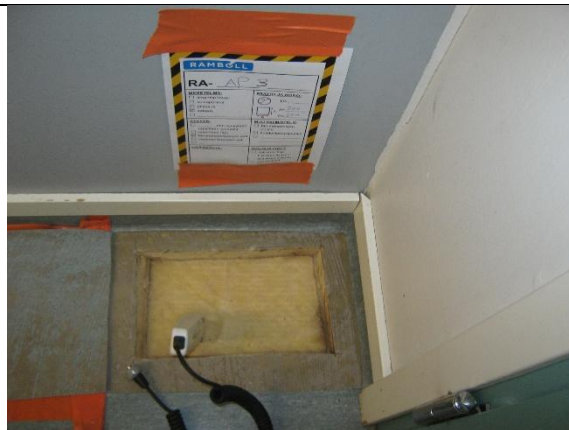
Kuva 35. Rakenneavaus AP3 luokka 111. Alapohjan lämmöneriste oli asennettu tiiviisti alapohjaan.
