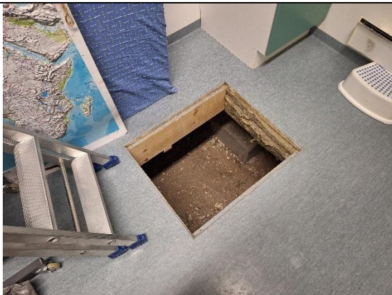
Kuva 23. Ryömintätilaan on kulku varaston 106:n kulkuluukusta.
