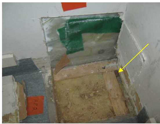
Kuva 2. Varaston 101 alapohjan raken-neavaus. Alapohjan lämmöneriste ulkosei-nän vierellä on osittain vajaa (keltainen nuoli).
