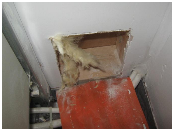
Kuva 2. Väliseinän lämmöneristekerroksessa ei havaittu aistienvaraisesti havainnoituna vaurioita.
