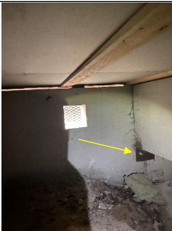
Kuva 27. Kantava palkisto on kiinnitetty sokkelipalkistoon (keltainen nuoli).
