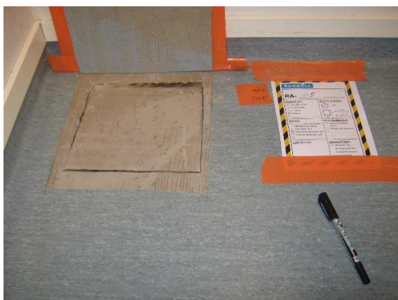
Kuva 1. Työtilan 108 rakenneavaus kohta.
