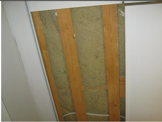
Kuva 76. Työtilan 124 yläpohjan rakenneavaus. Kyseisessä rakenneavauksessa ei ole normaalista poikkeavaa.
