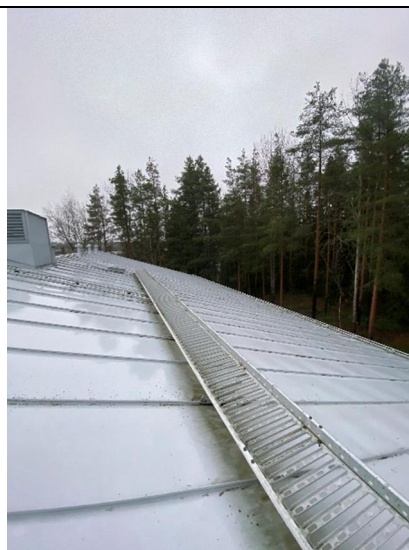
Kuva 89. Itäsivun lape ja kulkusilta.
