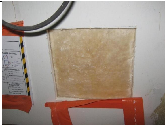
Kuva 60. Siivouskomeron 113 ja luokan 111 väliseinän rakenneavaus.
