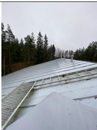
Kuva 88. Katto on tehty konesaumasta pellistä. Lappeella näkyvissä kulkusilta ja lapetikas.
