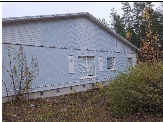
Kuva 47. Rakennuksen eteläpäädyn ulko- verhousta.
