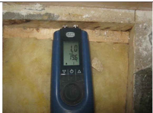
Kuva 57. Rakenneavauksessa alaohjauspuun alla olevassa lastulevyssä ei ollut kosteutta.
