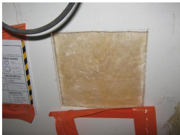
Kuva 1. Rakenneavaus siivouskomeron 113 ja luokan 111 väliseinässä.
