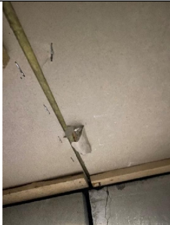
Kuva 25. Kipsilevyt on kiinnitetty niiteillä kiinni alapohjan palkistoon.
