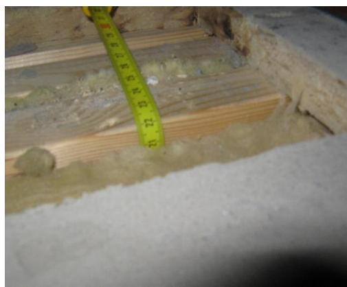
Kuva 2. Rakenneavauksesta mitattiin myös eristekerroksen paksuus. alapohjan eristepaksuus on 200 mm.
