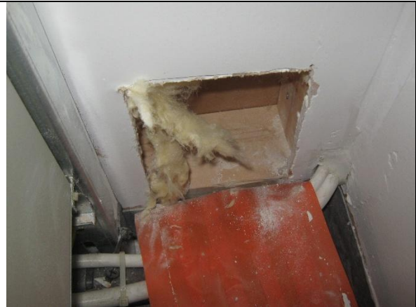
Kuva 59. Väliseinärakenne oli kuiva.
