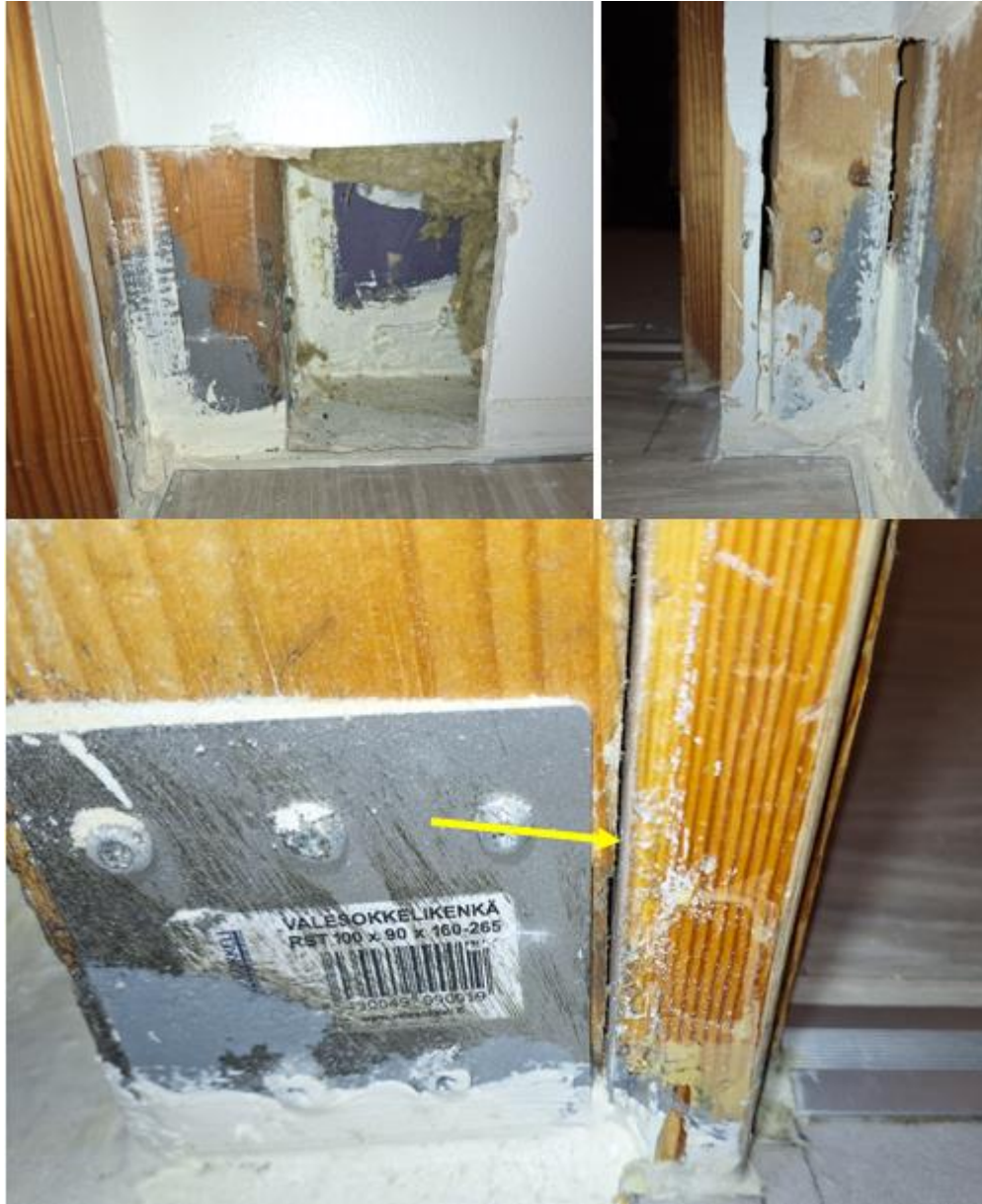
Kuvat 4. Väliseinärakenne on tiivistyskorjattu. Avauskohdassa ei havaittu alaohjauspuuta. Tiivistyspinnoitetta on asennettu lattiapinnan tasoon ja nostettu pystyrunkotolppaa sekä wc-tilan 29 seinäpintaa vasten. Oven karmi- ja pystyrungon välisiin liittymiin on nostettu tiivistyspinnoite noin 100 mm korkeudelle, joka ei havaintojen perusteella jatku yhtenäisenä koko karmen leveydeltä (keltainen nuoli).
