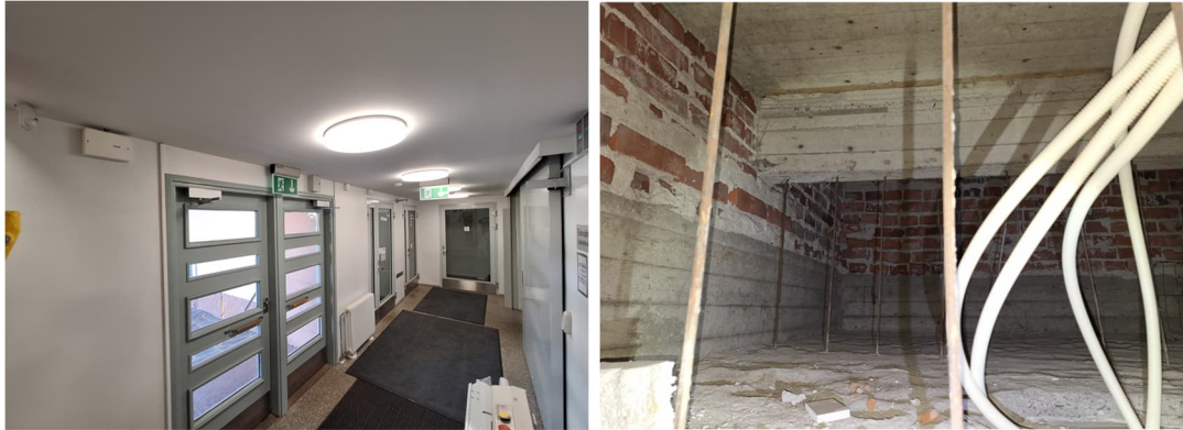
Kuvat 31. Eteistila 1100 ja rakenneavauksen RA2 kautta tilan alakattorakenteen sisältä otettu valokuva. Kuvat on otettu samalta kohdalta samaan suuntaan.
