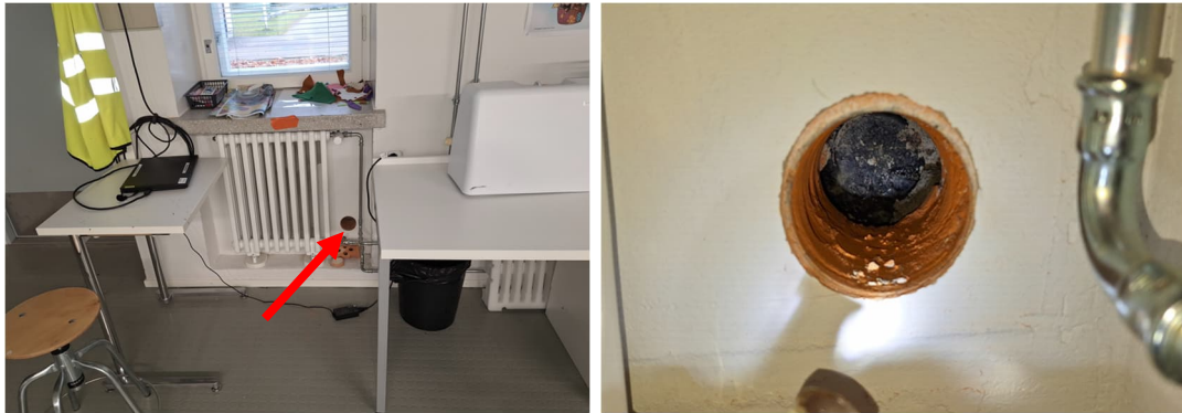
Kuvat 35. Avauskohdassa RA4 havaittiin lämmöneristeenä Toja-eriste.
