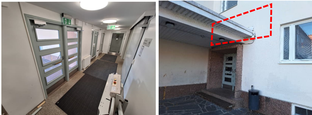
Kuva 13. Yleiskuva ensimmäisen kerroksen eteistilasta 1100. Rakenteiden pinnat olivat siistikuntoiset, eikä silminnähdessä havaittu viitteitä vaurioista. Tilassa oli tutkimushetkelläkin aistittavissa poikkeava mikrobiperäinen haju. Eteistilan alapuolisissa varastotiloissa 008 ja 011 ei todettu vastaavaa hajua eikä rakenteiden pinnoilla viitteitä vaurioista. Alakaton yläpuolella on noin ½ kerroksen korkuinen umpitila (merkattu suuntaa antavasti kuvaan punaisella katkoviivalla).
