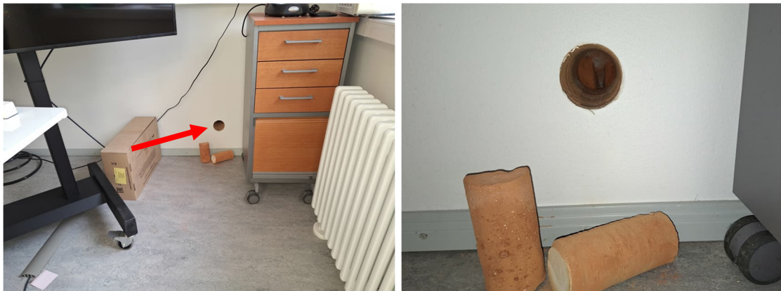
Kuvat 37. Tilan 037 ulkoseinän rakenneavaus RA6, päätyseinä.
