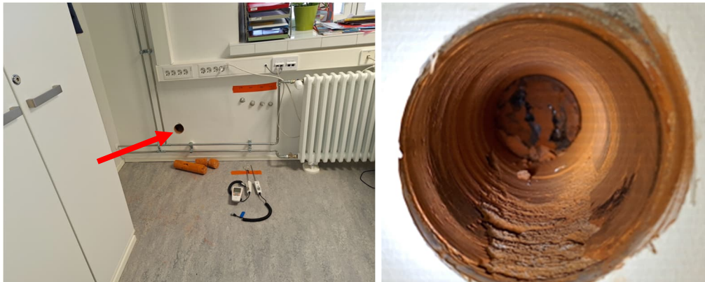
Kuvat 36. Tilan 029 ulkoseinän rakenneavaus RA5.
