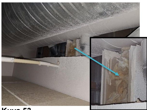
Kuva 53 Tilan 219 alaslaskutilassa on kotelointi, jossa on avonaista villaa.
