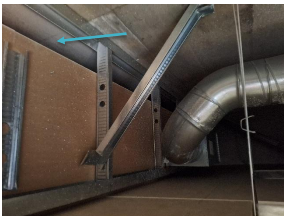
Kuva 41 Tilan 149 alaslasku on siisti. Nuolen kohdalla on tilan korkeammalla osalla olevaa matalampaa alaslaskutilaa.
