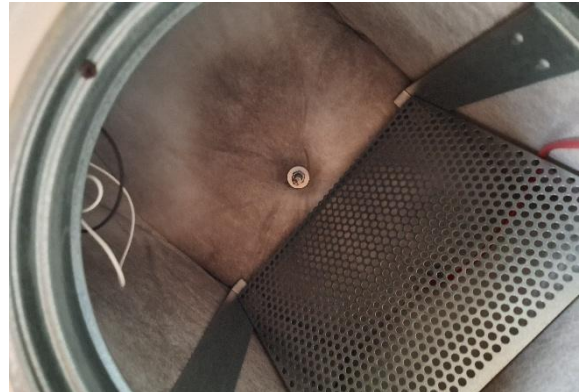
Kuva 46 Tilan 209 päätelaite ei sisällä mineraalivillakuituja.
