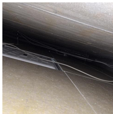
Kuva 42 Tilan 149 matalampaa alaslaskutilaa.
