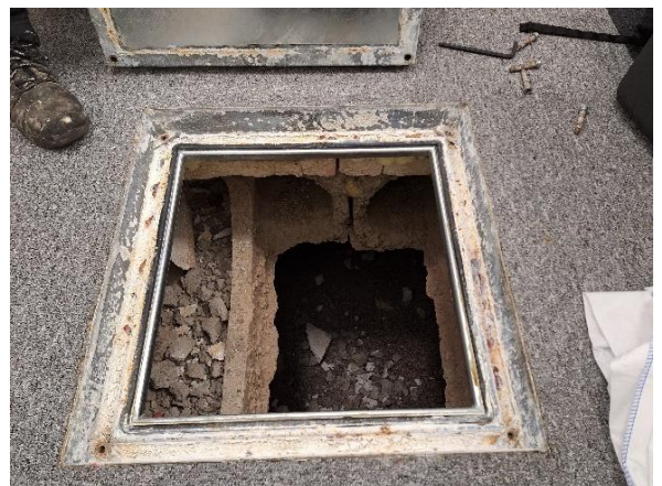
Kuva 50 Vanhan osan itäsiiven kaasutiivis ala- pohjaluukku.
