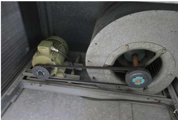
Kuva 279 Tuloilmapuhallin.
