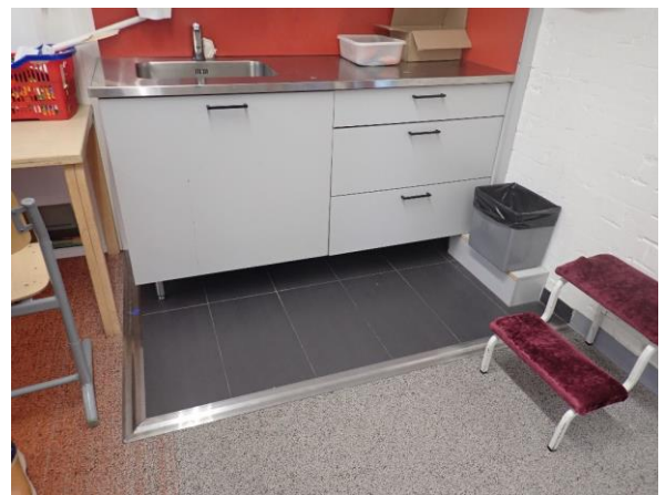
Kuva 22 Tiivistyskorjatuissa luokkatiloissa lattiapinnoitteena on pääasiassa tekstiilimattot ja pesualtaan luona keraaminen laatoitus.
