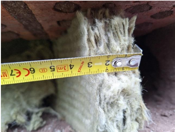
Kuva 41 Avaus US5, tuulensuojavillan paksuus 30 mm.
