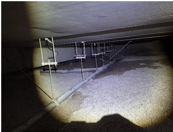
Kuva 47 Toinen alapohjaluukku laajennusosan ti- lassa 232. Viemärit ovat kannakoituja.
