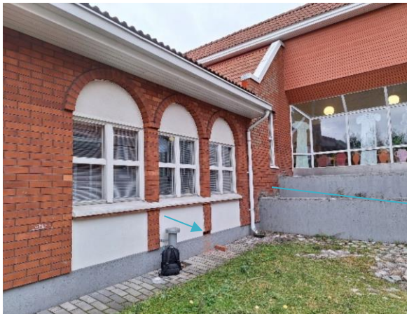
Kuva 105 Rakenneavaus, US10, luokan 174 kohdalla, sisäpihalle ikkunoiden väliin.
