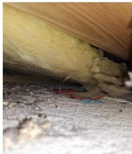
Kuva 34 Pääosin villa on betonilaattapinnan yläpuolella puukoolausten päällä.
