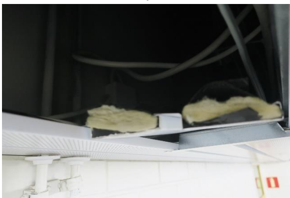
Kuva 245 Alkuperäisosalla metallisälekaton yläpuolella on muovitettu mineraalivilla.
