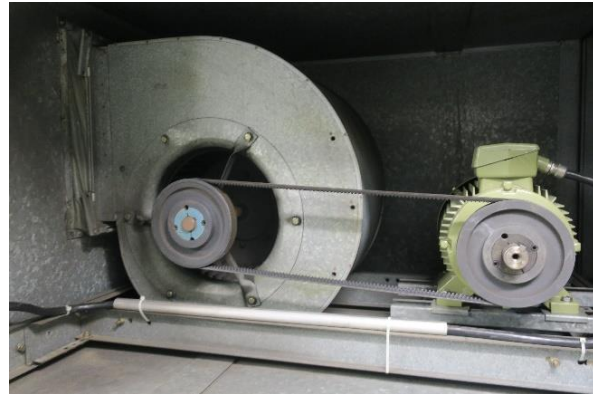
Kuva 273 Tuloilmapuhallin.
