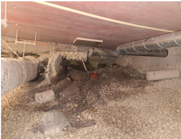
Kuva 55 Vanhan osan länsisiiven (C-osan luokan 181 alapuolella) tuulettuva alapohja, jonka toisessa päädyssä oli kosteusvaurio-kohta.
