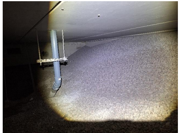
Kuva 48 Sorastus nousee laajennososan yh- dessä päädyssä sokkelia vasten.
