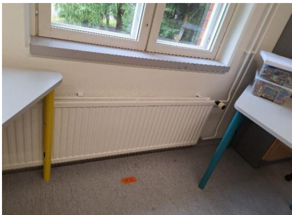
Kuva 5 Luokkatilan 192 alapohjan avaus AP2.
