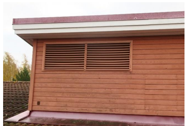
Kuva 282 Ulkoilmanottosäleikkö.
