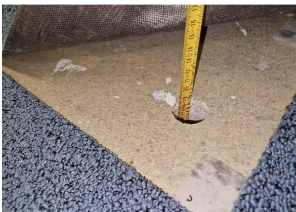
Kuva 41 Laajennososan pintalaatan vahvuus oli 90 mm.
