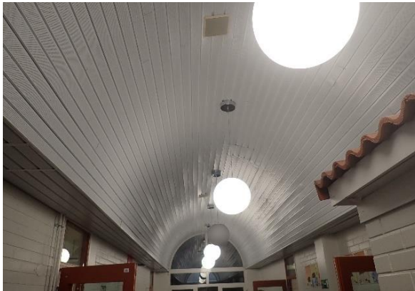
Kuva 243 Metallisälekatto alkuperäisosalla.
