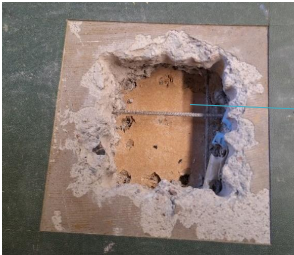
Kuva 29 Puutyöluokan 185 lattian avaus, AP3.
