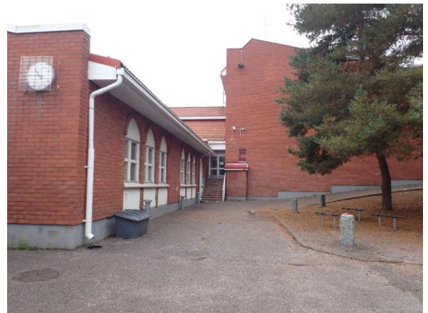
Kuva 15 Muut puut ja kasvillisuus on kauempana rakennuksista. Maanpinta viettää pai- koin rakennusta kohden.
