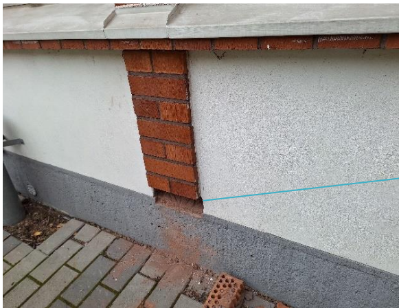
Kuva 107 Rakenneavaus US10, luokan 174 kohdalla.
