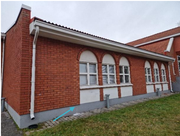
Kuva 57 Vanhan osan toinen sokkelireikä (SOK2). Sokkelihalkaisun lämmöneristeenä on EPS.
