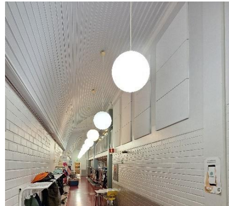
Kuva 244 Metallisälekatto laajennusosalla.
