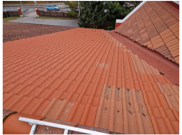
Kuva 190 Tiilikatetta on uusittu laajemmalla alu- eelta luokan 183 kohdalta.
