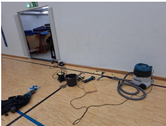
Kuva 31 Liikuntasalin 108 rakenneavaus kantavan väliseinän kohdalle.
