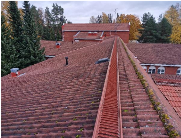
Kuva 187 C-osan vesikatto ruokalan ja puutyö- luokkien kohdalla.
