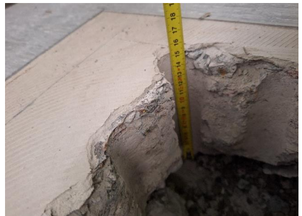
Kuva 6 Betonilaatan paksuus 150 mm.
