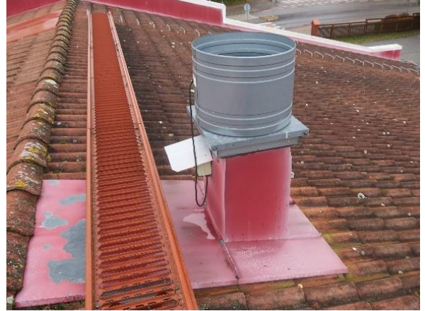
Kuva 294 Huippuimuri TK4 PF-1 on uusittu jossain vaiheessa.
