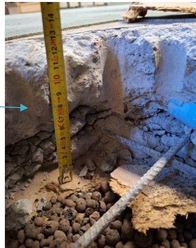
Kuva 30 Betonin vahvuus oli 120 mm, ja sen alla oli ohut vaneri ja yli 370 mm kevytsoraa.
