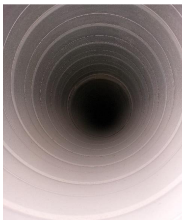
Kuva 302 Laajennusosan tuloilmakanavat eivät ole merkittävän likaantuneet (TK4).
