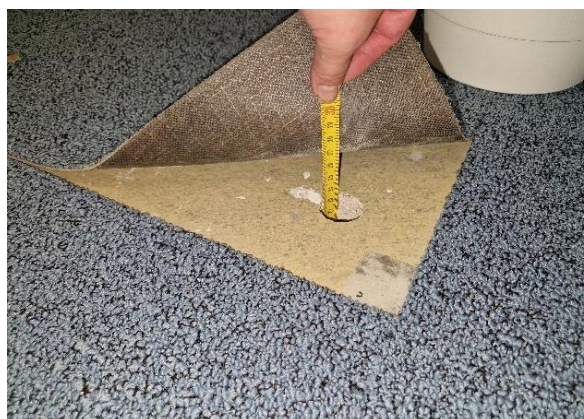
Kuva 42 Laajennusosalla pintalaatan ja alla olevan eristevahvuuden paksuus oli yhteensä noin 220...230 mm.
