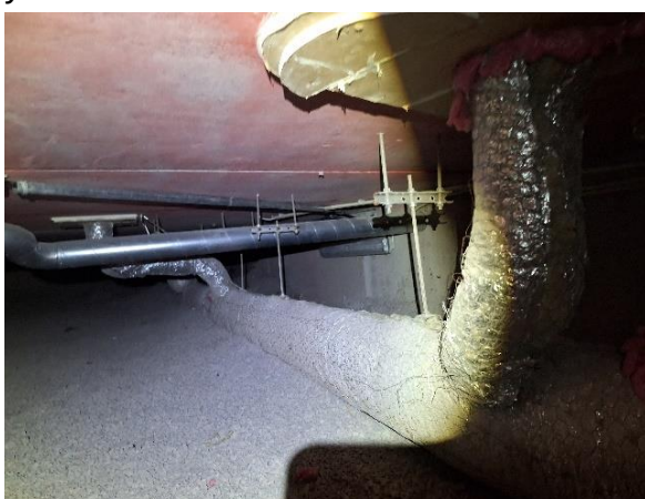
Kuva 51 Yleiskuva läpiviennistä ja kannakoin- neista, vanha osa.
