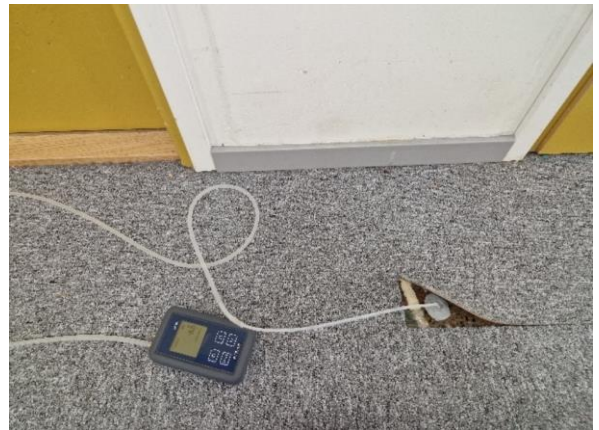
Kuva 73 Käytävän 152 merkkiainekoe. Ilmavuotoja ei todettu.
