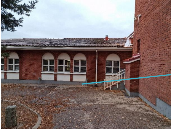
Kuva 55 Sokkelin tutkimusreikä vanhalle osalle (SOK1).
