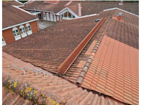
Kuva 188 C-osan luokkasiiven vesikatto.
