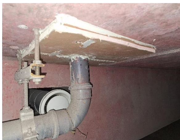
Kuva 46 Läpivientejä on tiivistetty.
