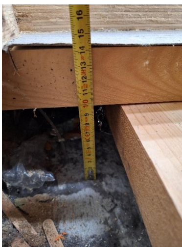
Kuva 33 Tyhjä tila on 100 mm ja puukoolaukset on tehty 40 mm paksuista laudoista.
