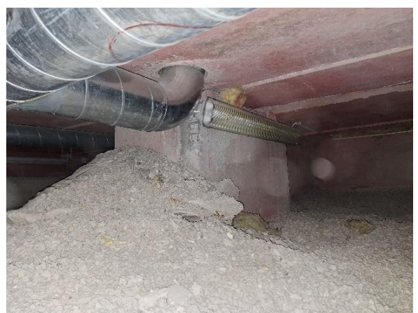
Kuva 52 Kantavan anturan kohta alkuperäis- osalla.
