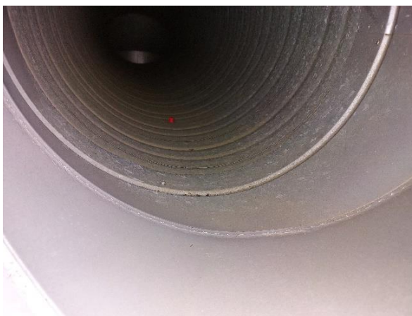
Kuva 301 Laajennusosan tuloilmakanavat eivät ole merkittävän likaantuneet (TK4).
