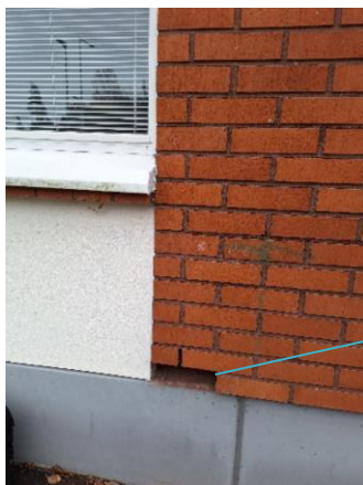
Kuva 113 Laajennososan rakenneavaus, US2, tilan 204 kohdalla.
