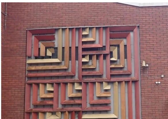
Kuva 263 Ulkoilmanotto on sijoitettu taideteoksen taakse.
