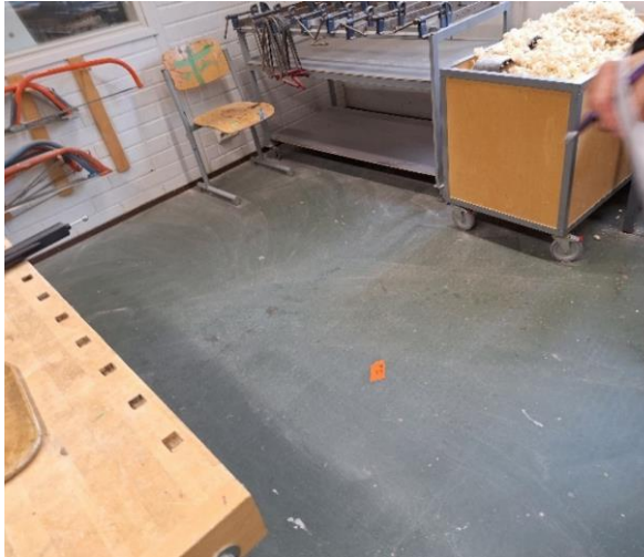
Kuva 9 Puutyöluokan 185 lattia avaus, AP3.
