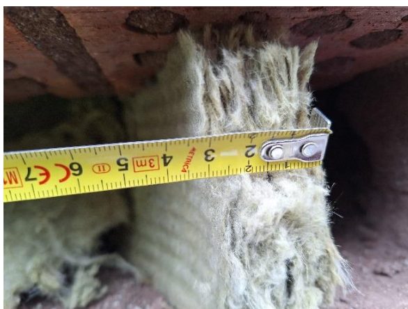
Kuva 111 Tuulensuojavillan paksuus 30 mm.
