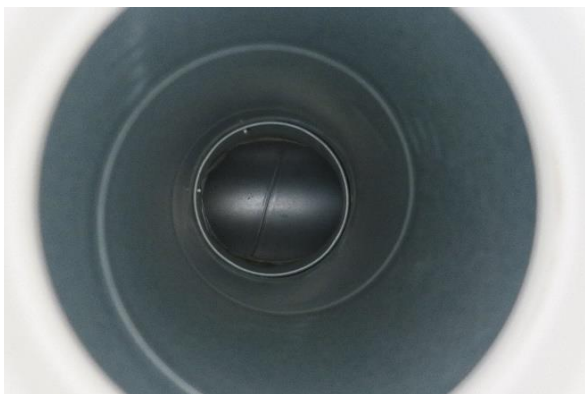
Kuva 303 Laajennusosan tuloilmakanavat eivät ole merkittävän likaantuneet (TK5).
