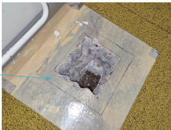
Kuva 4 Betonilaatan paksuus on noin 170 mm, eps-eristepaksuus 150 mm. Maa-aines oli osittain hienojakoista. Alapohjarakenteessa on kapselointiepoksi.
