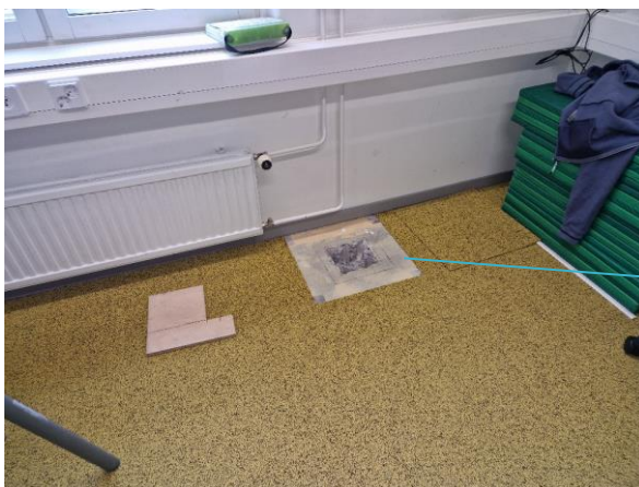
Kuva 3 Rakenneavaus AP1 pienryhmätilassa 124.
