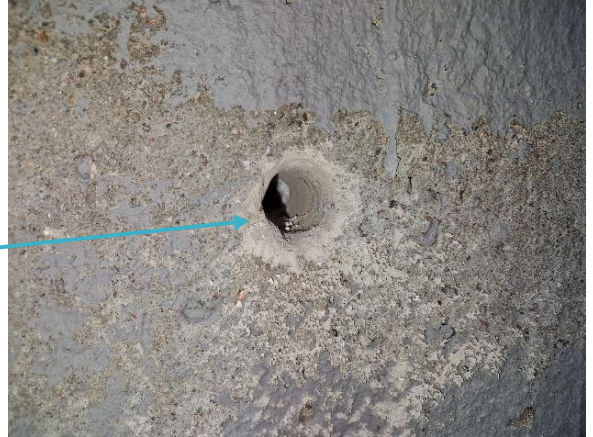
Kuva 56 Sokkelihalkaisun eristeenä oli EPS-eristettä (styrox).
