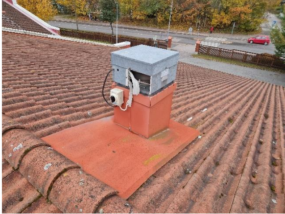
Kuva 293 Esimerkki alkuperäisestä huippuimurista PK2.4
