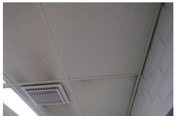
Kuva 246 A-osan alkuperäistä akustiikkalevyalakattoa.
