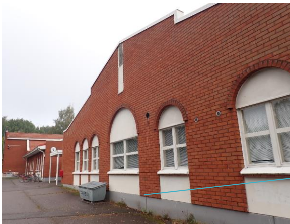
Kuva 43 Laajennososan rakenneavaus, US2, tilan 204 kohdalla.
