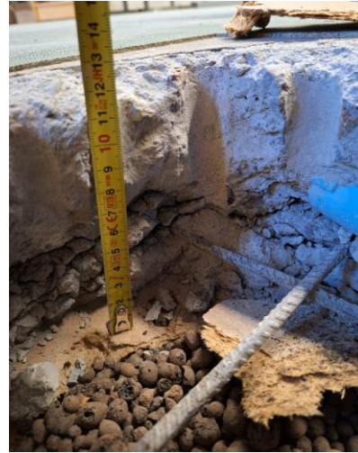
Kuva 10 Betonin vahvuus oli 120 mm, ja sen alla oli ohut vaneri ja yli 370 mm kevytsoraa.
