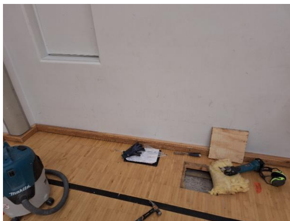
Kuva 17 Liikuntasalin toinen rakenneavaus tehtiin ulkoseinän viereen.
