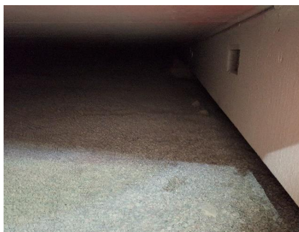
Kuva 44 Yleiskuva alapohjatilasta laajennusosalla.
