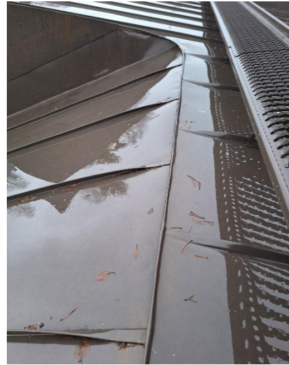
Kuva 82 Vesikatteen harjan pellityksen saumat olivat kunnossa.
