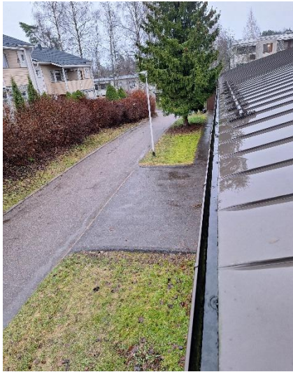
Kuva 81 Rännit olivat puhtaat sateisena tarkastushetkellä.
