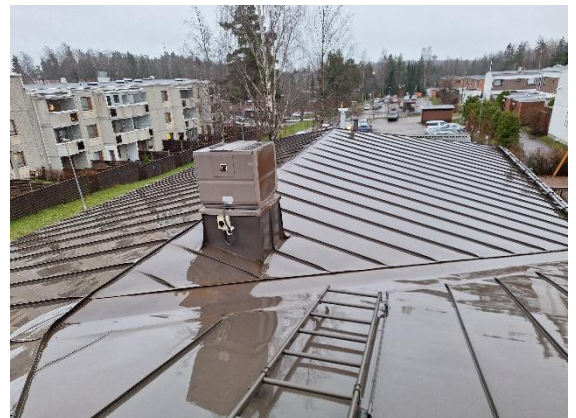
Kuva 84 Rakennuksen länsipään vesikattoa.
