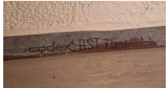
Kuva 8 IV-koneen kaappitilassa on myös lattian ja väliseinän rakenneliittymässä tiivistysnauhaa.
