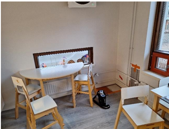
Kuva 18 Tilaan H50 tehtiin lattiaan rakenneavaus.
