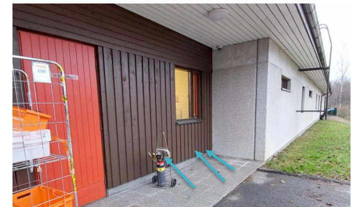
Merkkikaasun syöttö lomalaudoituksen taakse.
