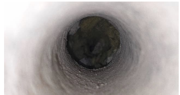
Kuva 12 US2 rakenneavaus tilassa H50.
