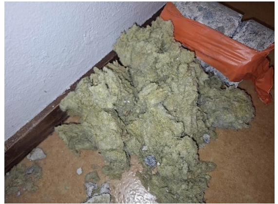
Kuva 32 US7. Eristevillaa avauskohdasta.
