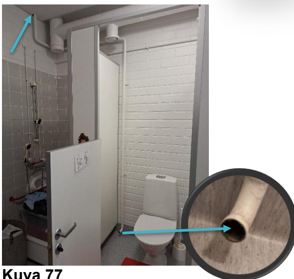
Kuva 75 Märkätilassa H35 on putken pää teipattu ilmanvaihtoteipillä.
