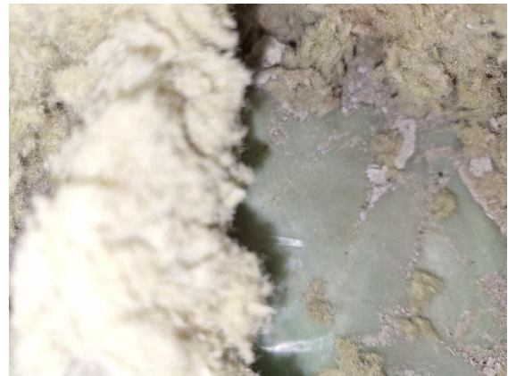
Kuva 57 US7. Eristeen alapuolella on muovitus sokkelin päällä.
