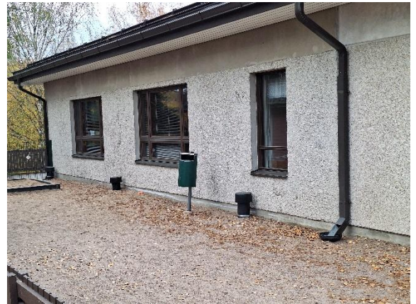
Kuva 9 Laajennusosan yleiskuva pihalta. Alapohjan tuuletusputket ovat näkyvissä. Vesisyöksy on jatkettu sadevesikäivöön.
