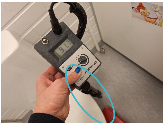
Kuva 41 Märkätilassa H35 oli wc-istuinten vieressä kohonneita pintakosteuslukemia.
