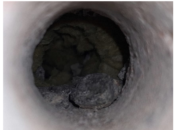
Kuva 28 US6 rakenneavaus tilassa H49.
