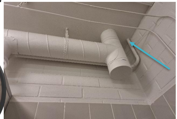
Kuva 76 Putki johtaa yläpohjaan.
