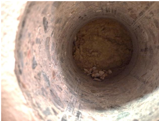
Kuva 56 US7. Eristevilla kiinni sisäkuoressa.
