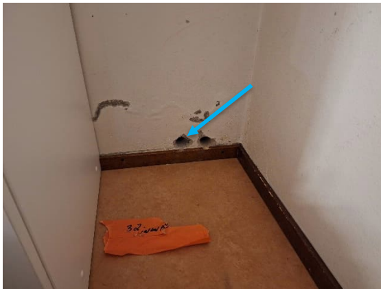
Kuva 27 US6 tilan H49 ulkoseinien kulmaukseen.
