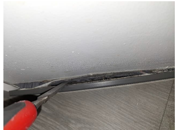
Kuva 6 Tilan L15 väliseinän ja lattian rajalla on tiivistysnauhaa.
