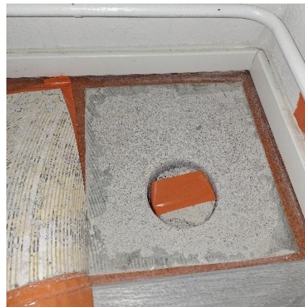
Kuva 19 Laminaatin alla on muovimatto ja betonirakenne.
