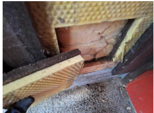
Kuva 40 US9. Julkisivulaudoituksen jälkeen on kova villa ja tuulensuojalevy.
