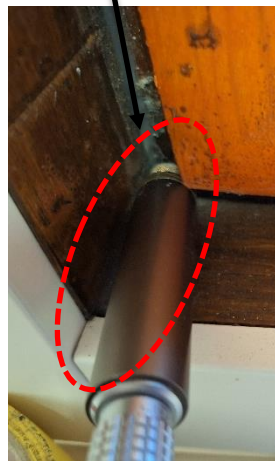
Selvää ilmavuotoa ikkunan vasemmasta alakulmasta, karmien liittymästä ja listan päältä.
