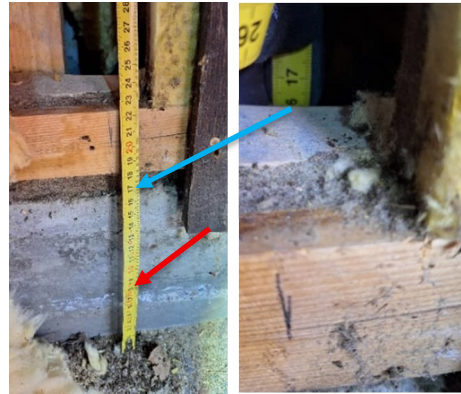
Kuva 42 US9. Alaohjauspuun yläpinta (punainen nuoli) on rappauksen kohdalla, noin 50 mm maanpinnasta.
