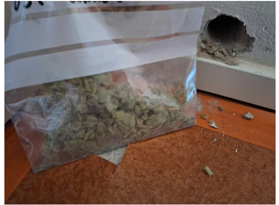
Kuva 10 Materiaalinäyte MN15 ulkoseinän eristeestä (avaus US1).
