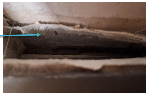
Kuva 35 Väliseinällä on näkyvissä harmaa tiivistyskaistale.
