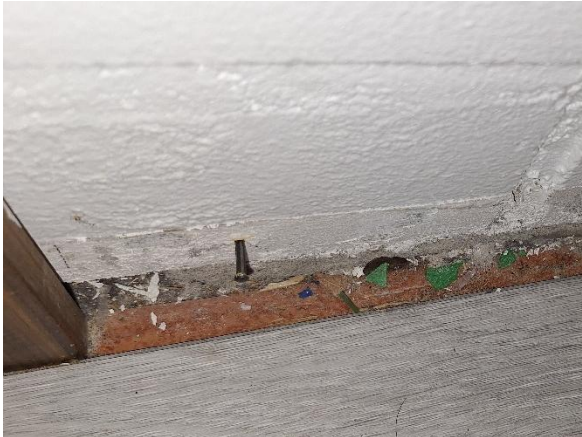
Kuva 23 Tilan H51 laminaatin alla on punaoranssia vinyylimattoa.
