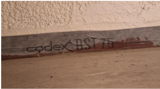
Kuva 38 IV-konetilassa olevaa lattian eristysnauhaa.
