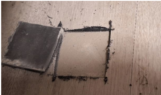
Kuva 7 Tilan L15 ilmanvaihtokoneen kaapin alle tehtiin pieni avaus. Vinyylilankun alla vaalea tasotekerros.
