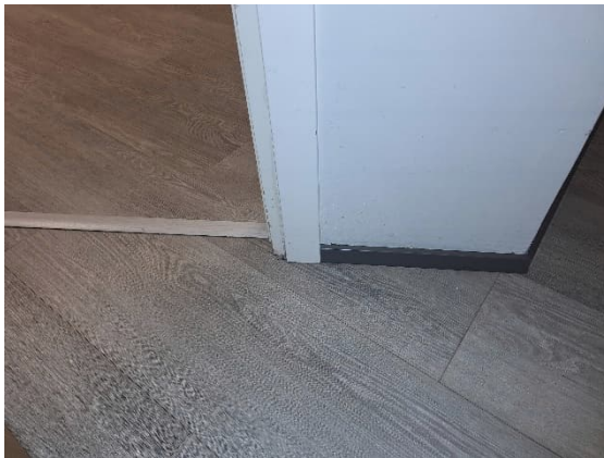
Kuva 5 Tilan L15 oven kohta.
