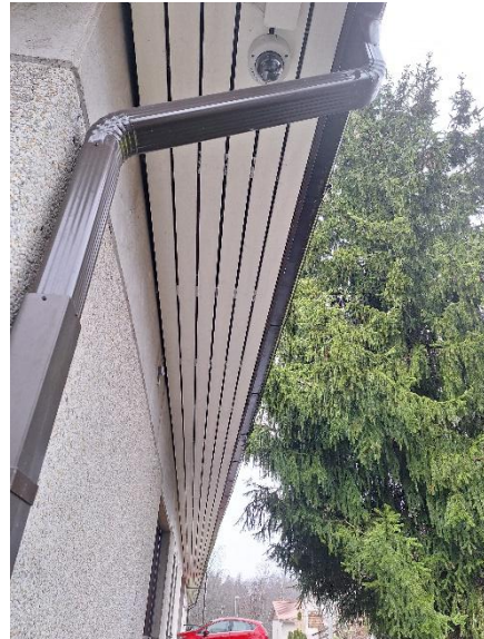
Kuva 14 Räystäät ovat leveät.
