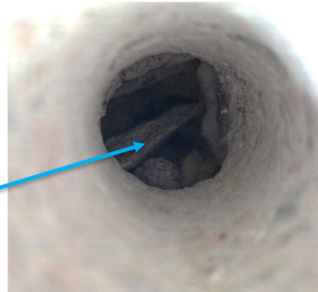
Kuva 36 US8 rakenneavaus tilassa H33.
