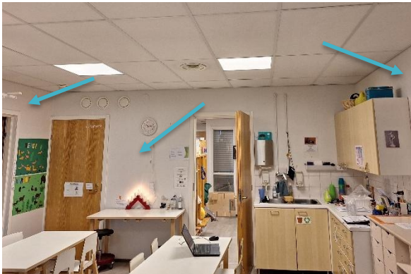
Kuva 73 Laajennusosan levyrakenteisia väliseiniä tilassa L18.
