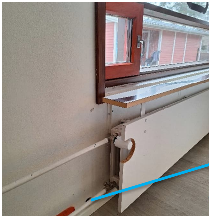
Kuva 35 US8 tehtiin tilan H33 ikkunan alle jalkalistan yläpuolelle.
