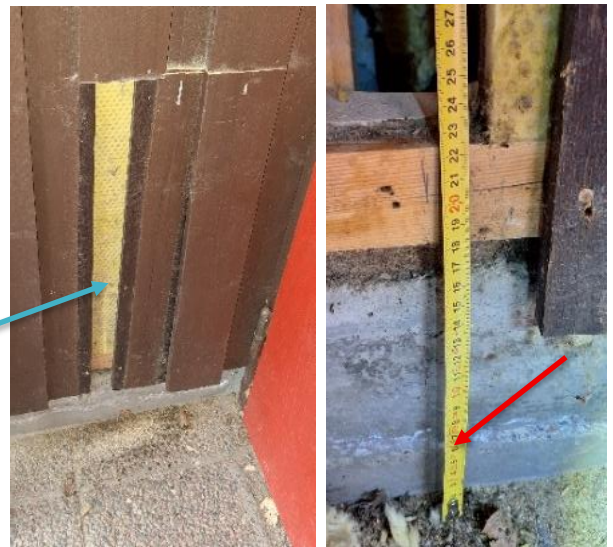
Kuva 61 US9. Alaohjauspuun yläpinta (punainen nuoli) on rappauksen kohdalla, noin 50 mm maanpinnasta.
