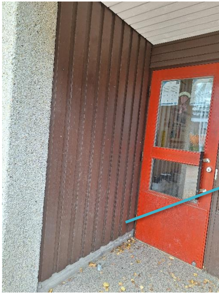
Kuva 60 US9, puujulkivisun kohdalle.
