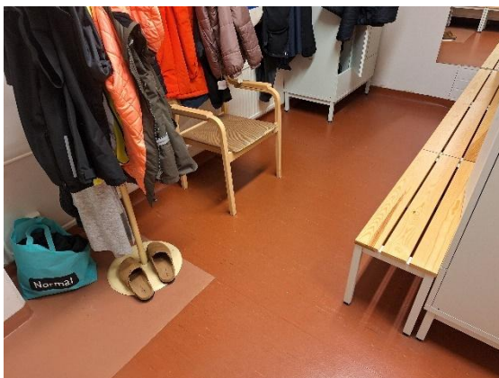
Kuva 31 Sosiaalitilan H8 muovimatot. Vaaleampi matto on vanhaa märkätilamattoa. Sosiaalitilan wc:ssä on vanha märkätilamatto.
