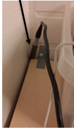
Selkeä ilmavuoto hyllykön takaa, mahdollisesti myös väliseinän liittymästä.
