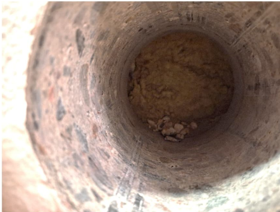
Kuva 31 US7. Eristevilla kiinni sisäkuoressa.
