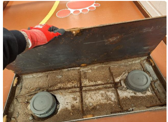
Kuva 94 Käytävän H23 tarkastusluukku.
