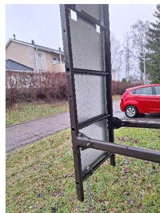
Kuva 13 Kattotikkaassa on suojalevy.
