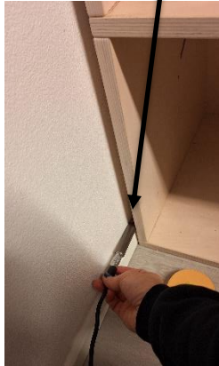
Selkeä ilmavuoto hyllykön takaa, mahdollisesti myös väliseinän liittymästä.
