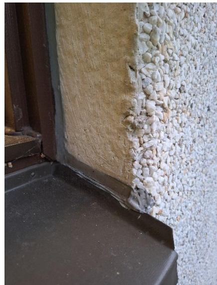
Kuva 16 Ikkunoiden ulkopuolinen tiivistys on kunnossa.
