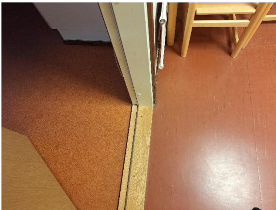
Kuva 25 Punaisia lattiamattoja: toimistotilan H28 pilkukas matto ja käytävän H27 viirukas matto.
