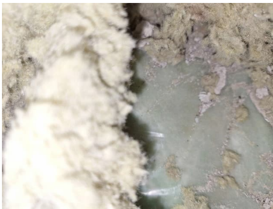
Kuva 33 US7. Eristeen alapuolella on muovitus sokkelin päällä.
