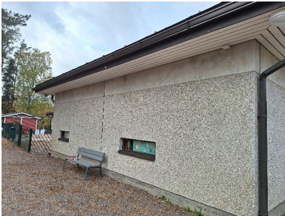
Kuva 8 Alkuperäisosaa. Pihan puolella on hiekkaa rakennuksen vierustoilla. Sokkeliosa on matala.
