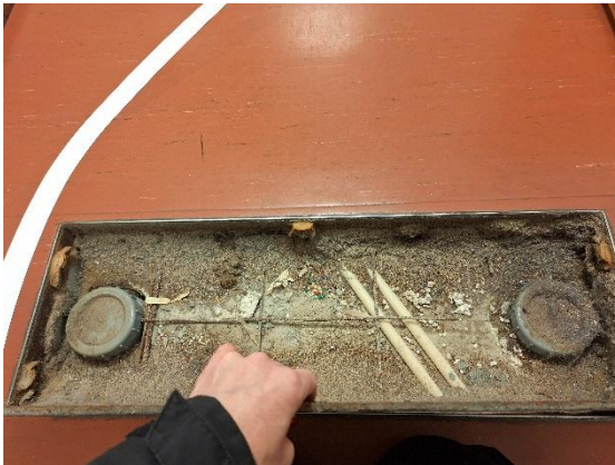
Kuva 93 Käytävän H26/H27 tarkastusluukku.
