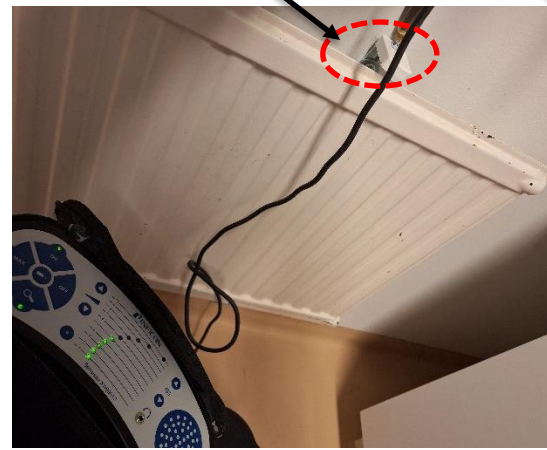
Selviä, pistemäisiä ilmavuotoja lähes kaikista patterikannakkeista.
