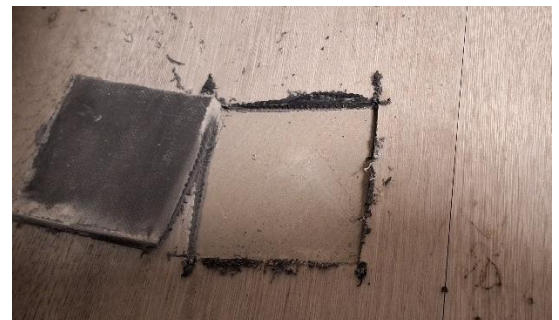
Kuva 37 Tilassa L15 on pieni kaappi, jossa sijaitsee ilmanvaihtokone. Sen alla on myös vinyylilankku ja vaalea tasoitekerros.
