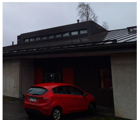
Kuva 59 Liikuntasalin parven kohta ulkopuolelta katsottuna.
