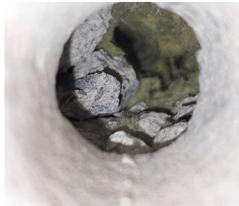
Kuva 44 US10 rakenneavaus tilassa H1.
