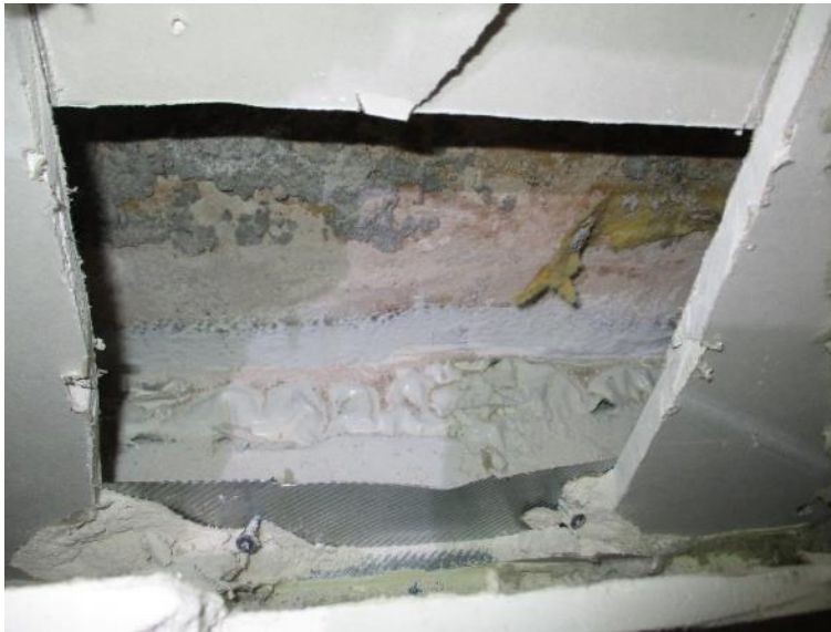
Kuva 6.3. Rakenneavaus RA.02-MV.US studiossa 047.
