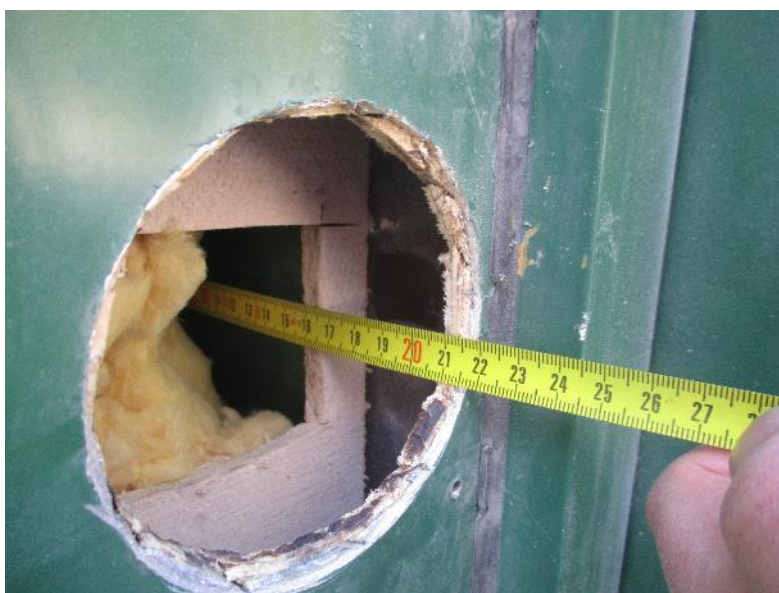
Kuva 7.4. Rakenneavaus RA.05-US opetustilan 248 ulkoseinään. Ulkoseinän liittymät on huonetilan puolella tiivistetty.
