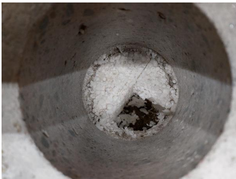
Kuva 5.6. Rakenneavaus RA.01-AP auditoriossa.
