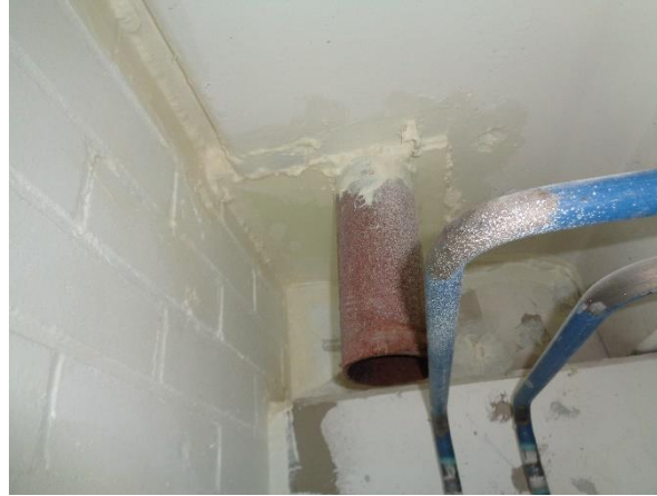
8. Yläpohjan rakenneliittymät ja läpiviennit on tiivistetty.
