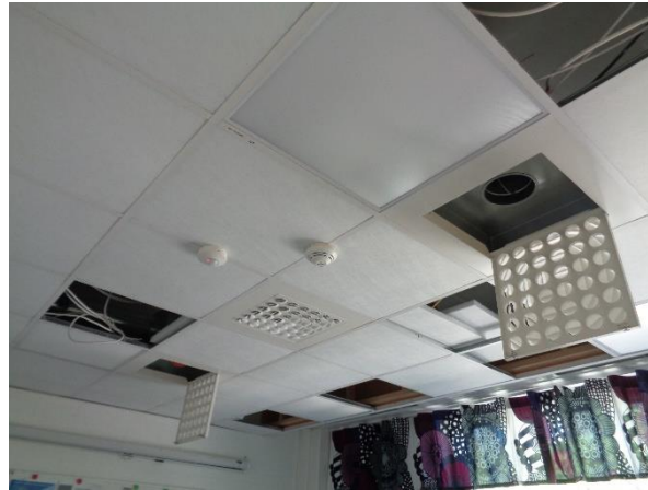
2. Yläpohjan rakenneliittymistä ei todettu ilmavuotoja.
