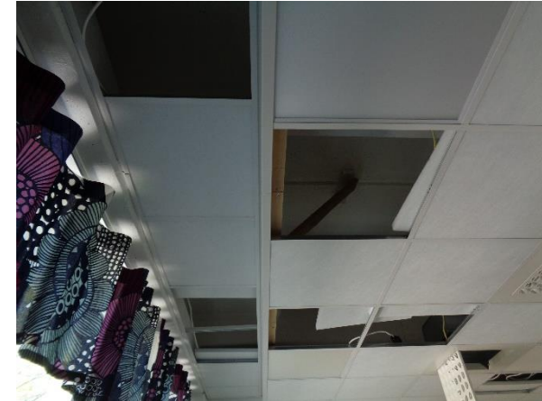
9. Yläpohjaliittymistä ei havaittu ilmavuotoja ulkoseinän tai yläpohjan merkkiainekokeissa.
