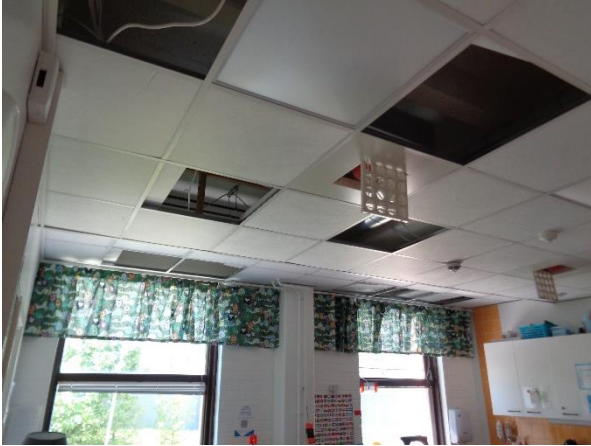
7. Yläpohjan merkkiainekokeessa ei havaittu ilmavuotoja.
