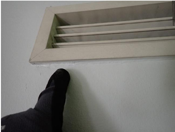
Kuva 8.2.9. Tuloilmasäleiköt on kiinnitetty silikonilla ja tuloilman päätelaitetarkastelu edellyttäisi sauman leikkaamista.
