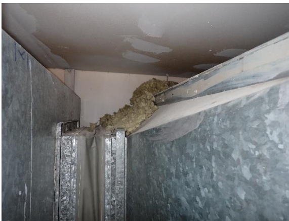
Kuva 8.2.9. Tuloilmasäleiköt on kiinnitetty silikonilla ja tuloilman päätelaitetarkastelu edellyttäisi sauman leikkaamista.
