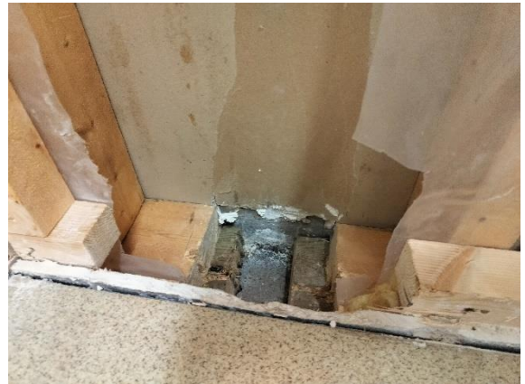
Kuva 6.2.2 Yleiskuva rakennavauksesta RA.01
