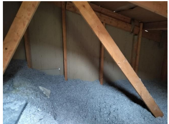
Kuva 7.2.4 Eristekerros on paikoin epätasainen
