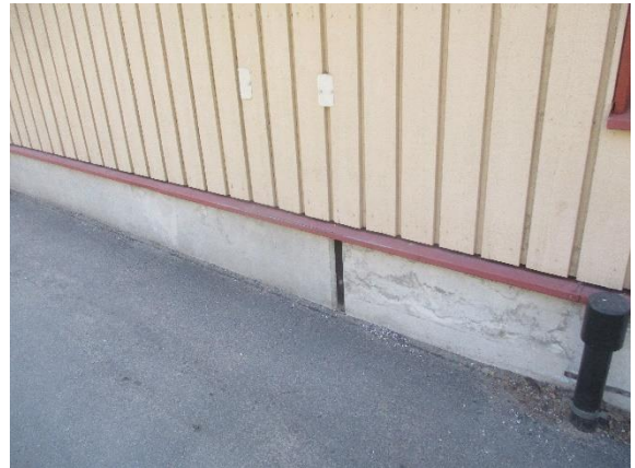
Kuva 4.2.1 ja 4.2.2 Rakennuksen vierustat mm. hiekka- ja asfalttipintaisia, sokkelissa viitteitä kohonneesta kosteusrasituksesta
