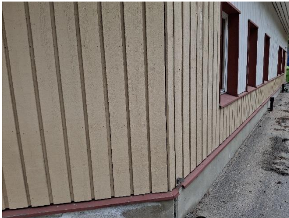
Kuva 6.2.1 Yleiskuva ulkoseinä rakenteesta
