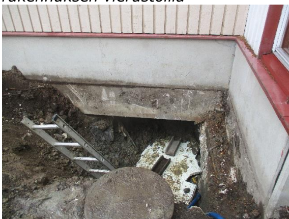
Kuva 4.2.7 Kaivanto sokkelirakenteen ali
