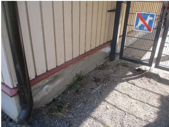
Kuva 4.2.1 ja 4.2.2 Rakennuksen vierustat mm. hiekka- ja asfalttipintaisia, sokkelissa viitteitä kohonneesta kosteusrasituksesta
