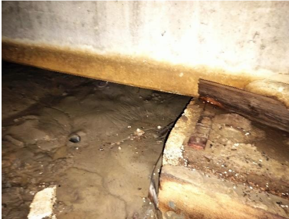
Kuva 5.2.5 Kulkuaukko toisen osan alle ryömintätilassa
