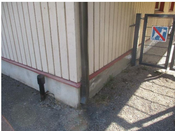
Kuva 4.2.3 ja 4.2.4 Sadevesien ohjaus vesikatolta suoraan rakennuksen vierustoille / betonikourujen avulla kauemmas rakennuksesta. Sokkelissa viitteitä kohonneesta kosteusrasituksesta syöksytorvien taustalla
