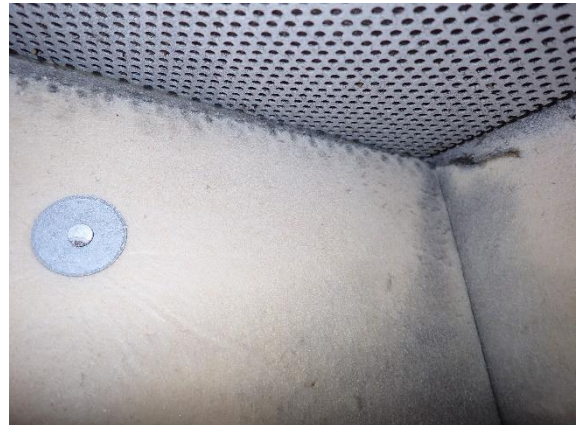
Kuva 8.2.8. Äänenvaimennuspinnat voivat olla pinnoitettua villaa, suositellaan näytteen ottamista.
