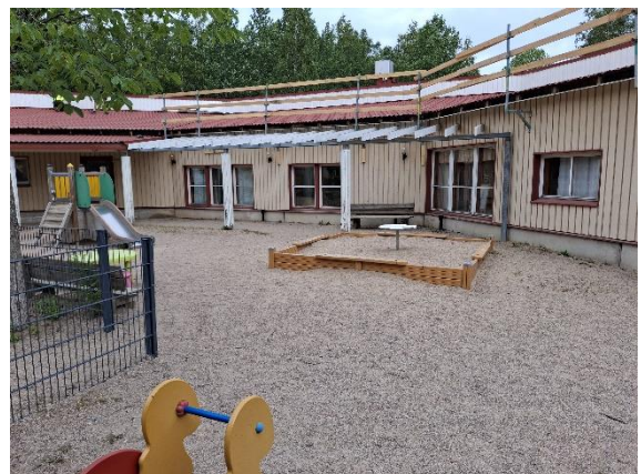
Yleiskuva kohteesta leikkipihalta kuvattuna
