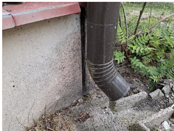
Kuva 4.2.3 ja 4.2.4 Sadevesien ohjaus vesikatolta suoraan rakennuksen vierustoille / betonikourujen avulla kauemmas rakennuksesta. Sokkelissa viitteitä kohonneesta kosteusrasituksesta syöksytorvien taustalla
