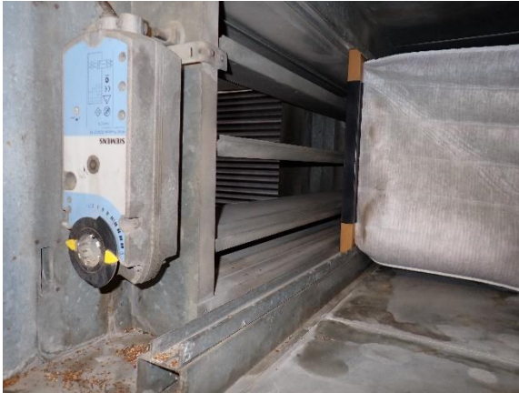
Kuva 8.2.1. Raitisilmakammion jälkeä on raitisilmapelti, toimilaitte uusittu vuosien saatossa
