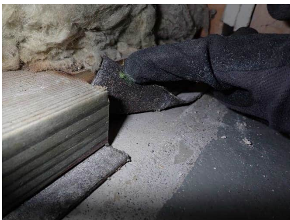
Alaohjauspuun alla erotuskaistana bitumikermi.
