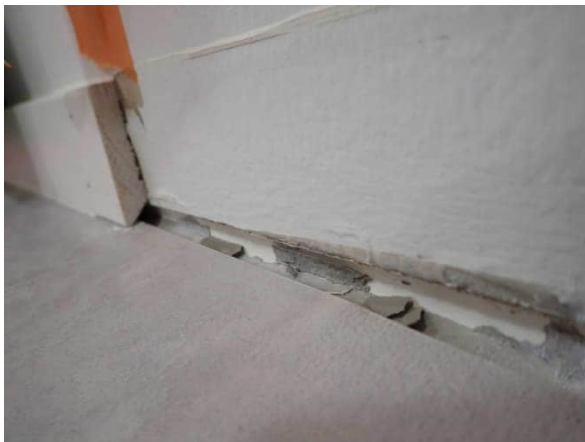
Ulkoseinän sisälevytyksen ja alapohjan liittymä on tiivistetty elastisella tiivistysmassalla (DET1).
