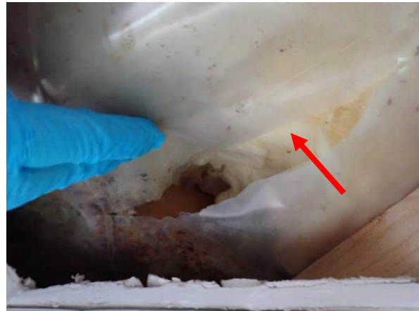
Mineraalivillasta otettiin materiaalinäyte MA.24-YP.
