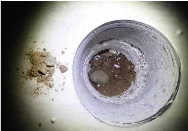
Kuva rakenneavauksesta RA.02-AP
