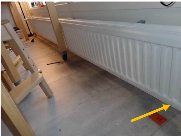
4. Ulkoseinän ja alapohjan liittymästä todettiin vähäinen pistemäinen ilmavuotokohta tilan normaaleissa käyttöolosuhteissa.
