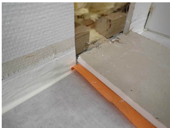
Ulkoseinän ja alapohjan liittymä on tiivistetty.
