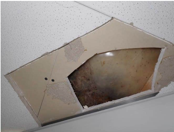
Rakenneavaus RA.12-YP. Lämmöneristeenä on mineraalivilla.
