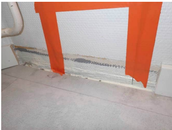
Ulkoseinän ja alapohjan liittymä on tiivistetty.
