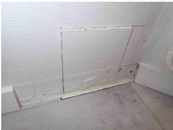
Ulkoseinän ja alapohjan liittymä on tiivistetty.
