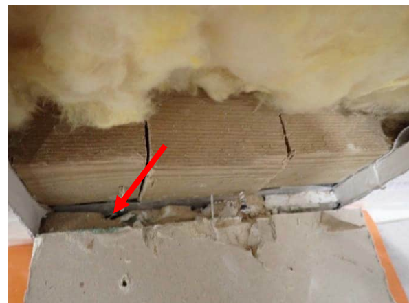
Höyrynsulkumuovi on havaintojen perusteella asennettu tiiviisti ulkoseinän ja alapohjan väliin.
