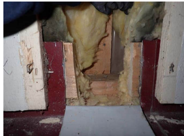
Kuva rakenneavauksesta RA.08-US.
