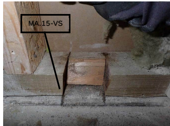
Alaohjauspuusta otettiin näyte.
