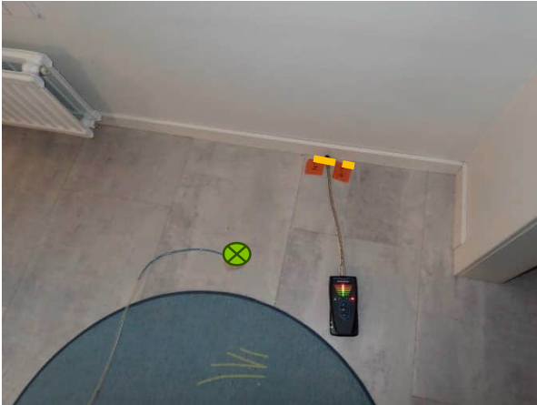
1. Alapohjan ja ulkoseinän liittymästä todettiin vähäistä rakomaista ilmavuotoa kaasunsyöttöpisteen kohdalla tilan normaaleissa käyttöolosuhteissa.
