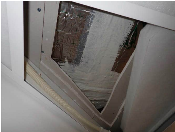
Ulkoseinän ja alapohjan liittymä on tiivistetty.
