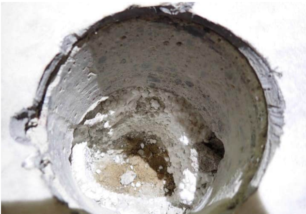
Kuva rakenneavauksesta RA.01-AP
