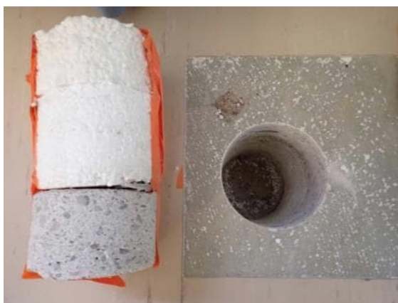
Kuva 5.3 Rakenneavaus RA.01-AP, ryhmähuoneessa 20.
