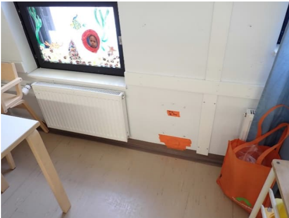
Rakenneavauksen RA.05-SO/US sijainti ulkoseinän alaosassa.
