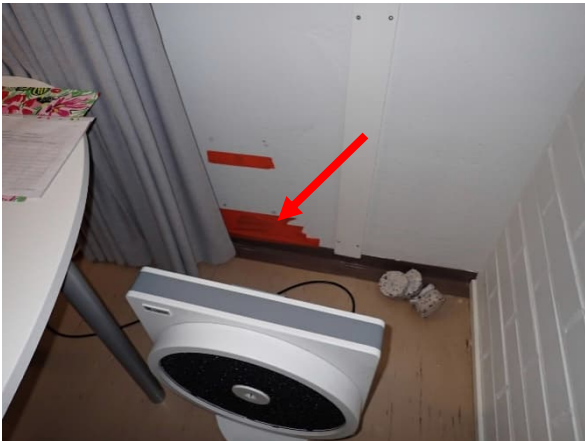
Kuva rakenneavauksesta RA.08-US.
