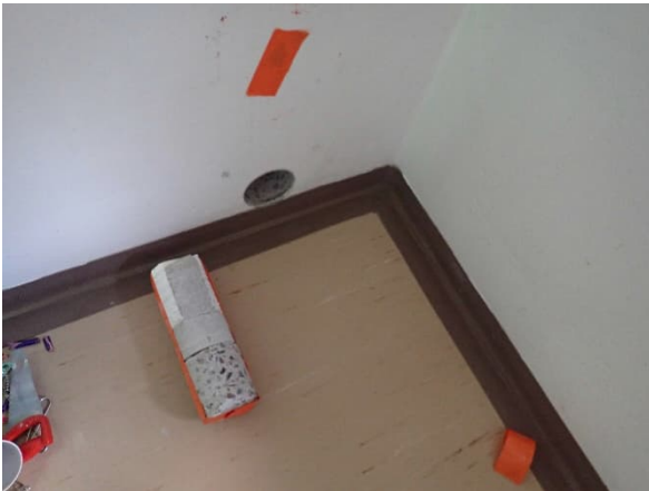
Kuva rakenneavauksesta RA.04-SO/US.
