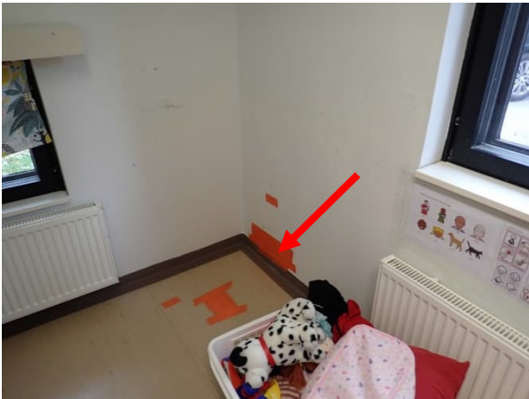
Kuva rakenneavauksesta RA.07-SO/US.
