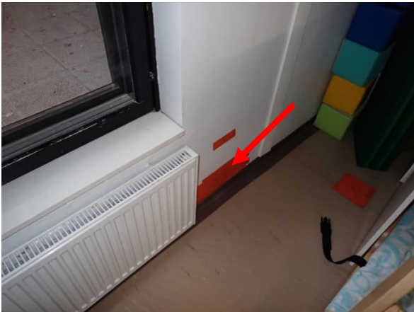
Rakenneavauksen RA.05-SO/US sijainti ulkoseinän alaosassa.
