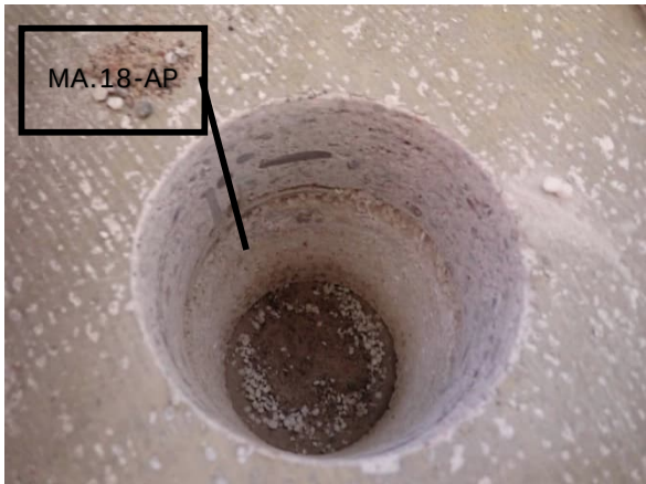
Kuva rakenneavauksesta RA.01-AP.
