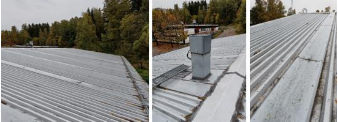
Kuva 39. Yleiskuvia rakennuksen vesikatosta.
