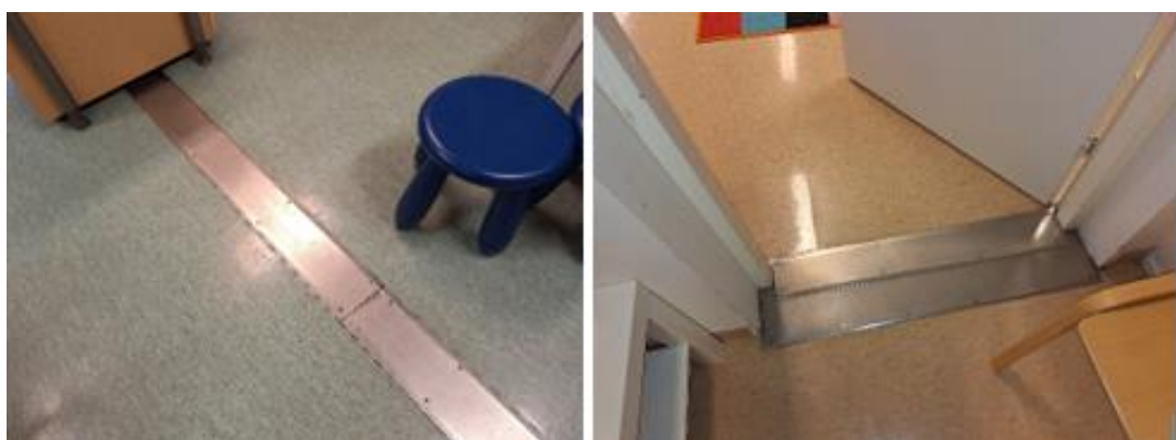
Kuva 8. Alapohjassa tilaelementtien välisissä liitoskohdissa on teräslistat. Liitoskohtia on myös joidenkin tilojen ovien kohdilla, joissa kynnyksenä on käytetty samaa teräslistoitusta kuin saumoissa muuallakin.
