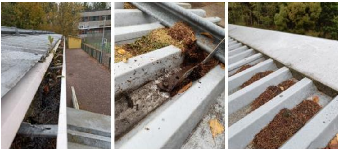
Kuva 41. Vesikatolla on paljon lehtiä, sammalta ja muuta moskaa. Räystäskourut ovat täynnä moskaa.
