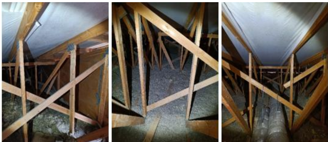
Kuva 43. Yleiskuvia rakennuksen yläpohjasta.
