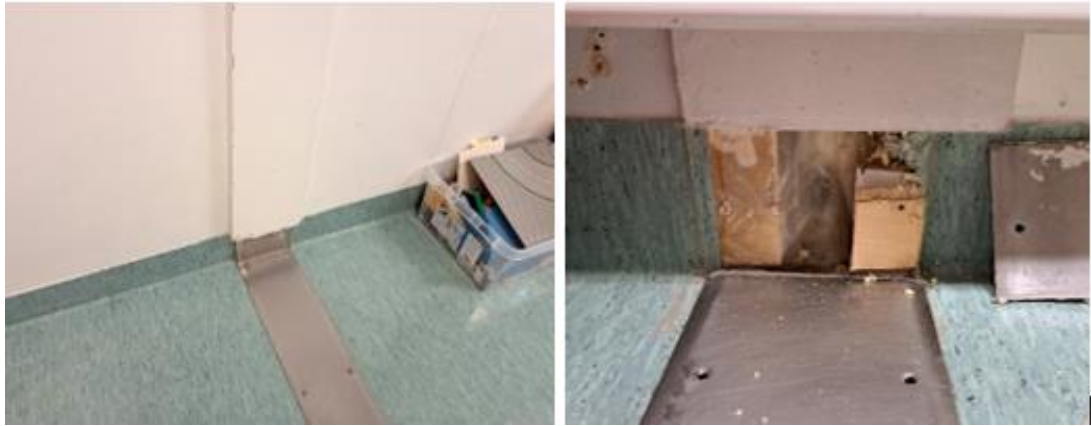
Kuva 30. Rakenneavaus RA13 olotilan 25 ulkoseinässä. Höyrinsulku seinän sisäpinnassa on viety tilaelementtien välisen sauman yli.
