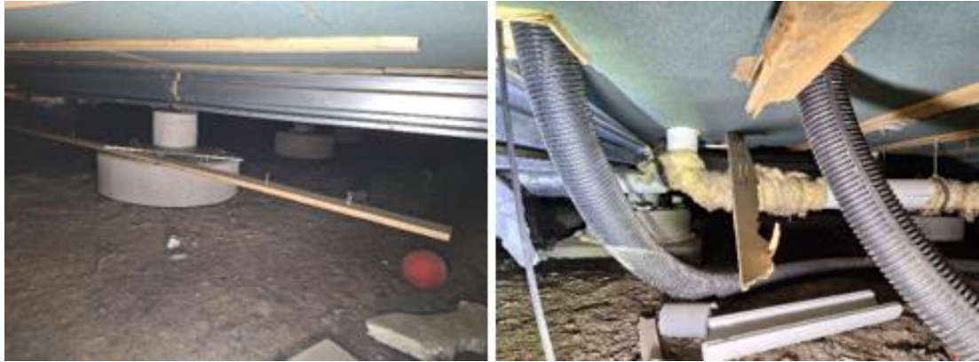
Kuva 17. Tuulensuojalevyt on kiinnitetty nauloilla ja koolingeilla alapohjaan. Koolingit ovat irtoilleet paikoitellen ja tuulensuojalevy on irronnut joissakin kohdissa vähäisesti raolleen.
