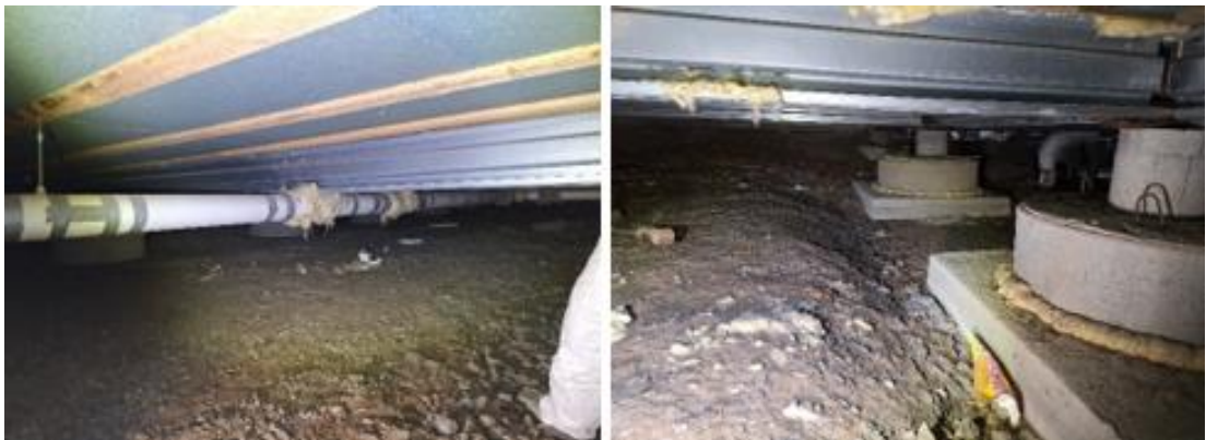
Kuva 16. Yleiskuvia ryömintätilasta. Ryömintätilan keskeisellä anturalinjalla maanpinta on muuta tilaa matalammalla (oikea kuva).
