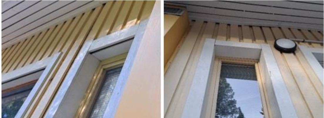
Kuva 28. Ikkunoiden yläosissa on osassa ikkunoita tuuletusrako/rako vedenpoistoa varten (vasen kuva). Osassa ikkunoita tuuletusrakoa ei ole (oikea kuva). Ikkunoiden yhteydessä ei havaittu kosteusrasitukseen viittaavia jälkiä.
