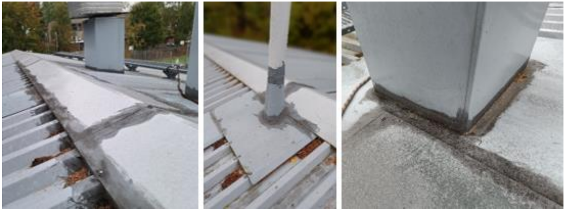
Kuva 40. Pellityksen liitoksia on tiivistetty siveltävällä massalla, joka oli aistinvaraisesti arvioituna tiivis.
