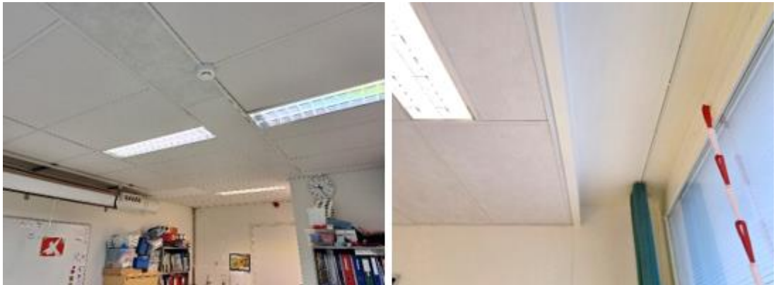
Kuva 45. Yleiskuvia rakennuksen alakatoista. Ulkoseinän lähetyvillä katossa ei ole alakattoa vaan kohdat on toteutettu levytyksellä ja kohdissa kattopinta on alakattoa korkeammalla.
