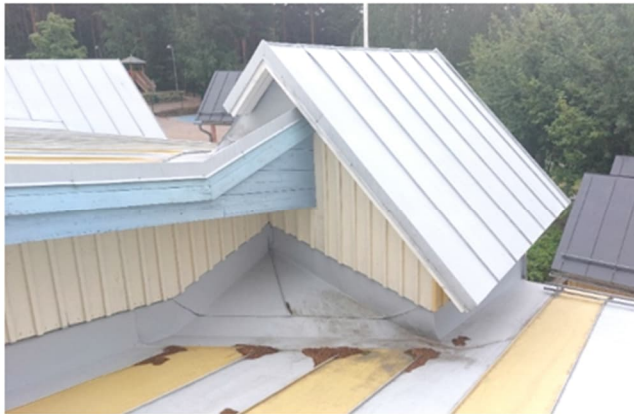
Kuva 43. Pellitys on hyväkuntoinen ja vastakaadot ohjaavat vedet poispäin julkisivusta. Katolla on paikoin lehtipuurooskaa katteen pinnalla.
