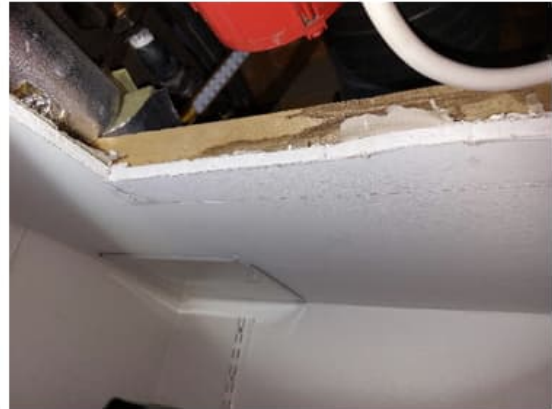
Kuva 52. Varaston vanhoja, tarkasteluhetkellä kuivia vuotojälkiä.
