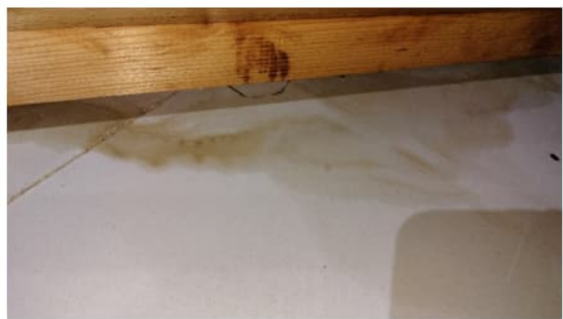
Kuva 49. Länsipäädyssä ilmanvaihtokonehuoneen kipsilevyseinässä oli vanhoja, tarkasteluhetkellä kuivalta vaikuttavia vuotojälkiä. Sadevesi on päässyt aluskatteen alapuolelle. Sisätiloissa vuotokohta osuu varastohuoneen kohdalle, jonka katossa on ajoittain havaittu vuotoa.
