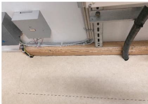
Kuva 20. Vasemmalla sähköpääkeskuksessa tiivistämättömiä läpivientejä. Oikealla on ryhmäkeskuksen suojaputkessa olevia kaapeliläpivientejä, joita ei ollut tiivistetty.
