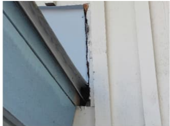
Kuva 29. Keittiön sisääntulokatoksen katoksen pellityksen liittymä ulkoseinään ei ole vesitiivis.
