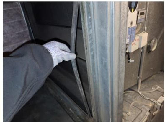
Kuva 59a ja b. Tuloilmasuodatinkammiossa havaittiin kosteusjälkiä ja hieman likaa. Suodatinrunkojen sekä huoltoluukkujen tiivistekkeet ovat
