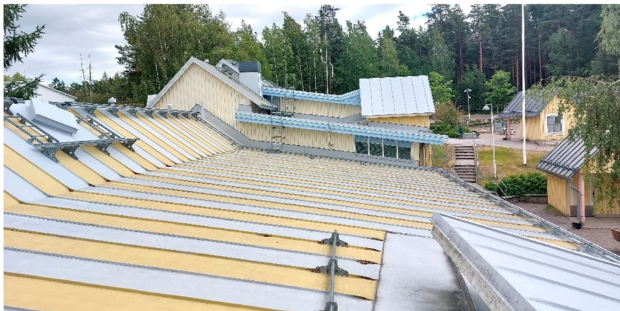
Kuva 40. Vesikaton länsipääty ja keskiosa.
