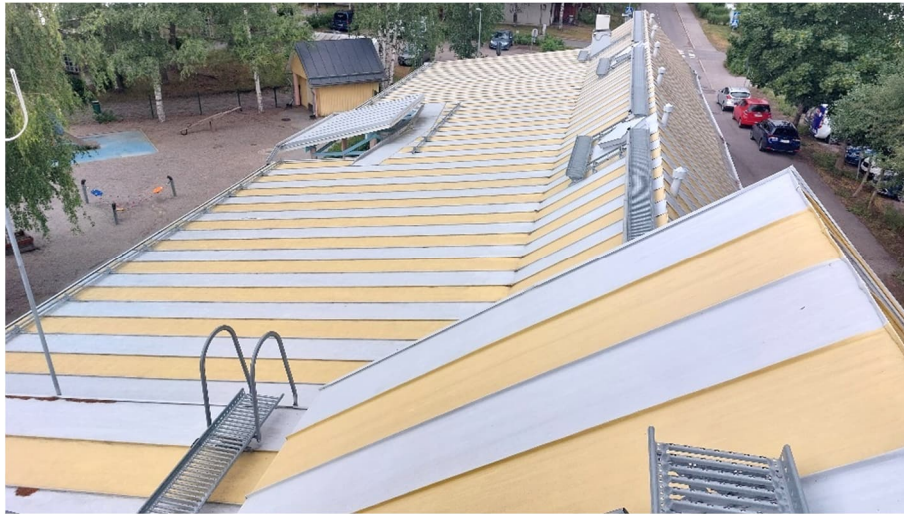
Kuva 39. Vesikaton länsipääty kuvattuna keskiosan päältä.
