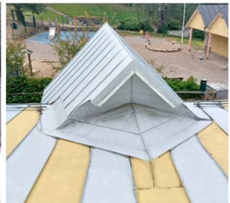
Kuva 43. Pellitys on hyväkuntoinen ja vastakaadot ohjaavat vedet poispäin julkisivusta. Katolla on paikoin lehtipuurooskaa katteen pinnalla.
