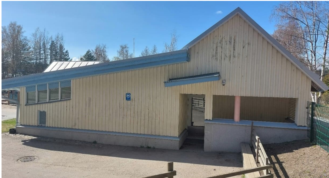
Kuva 6. Rakennuksen itäpääty. Julkisivun lautaverhous on uusittu seinän alaosassa.
