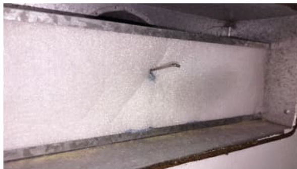
Kuva 55. Tuloilman päätelaitteet olivat pölyiset. päätelaitteiden äänenvaimentimet on vaihdettu kuiduttomaan materiaaliin, mutta kanavan pinnoilla oli jäämiä mineraalivillasta (näkyvät keltaisina kuituina).
