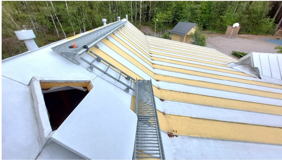
Kuva 42. Vesikaton itäpääty. Kattoluukut oli ruuvattu kiinni.
