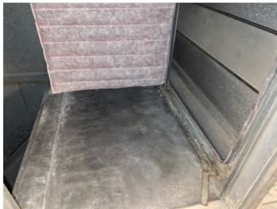
Kuva 59a ja b. Tuloilmasuodatinkammiossa havaittiin kosteusjälkiä ja hieman likaa. Suodatinrunkojen sekä huoltoluukkujen tiivistekkeet ovat
