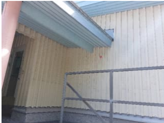
Kuva 29. Keittiön sisääntulokatoksen katoksen pellityksen liittymä ulkoseinään ei ole vesitiivis.
