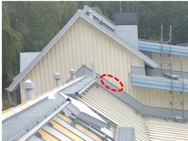
Kuva 51. IV-konehuoneen ja varaston katon vuotoon liittyvä kosteusjäljen sijainti yläpohjassa ympyröity kuvaan. Oikealla IV-konehuoneen katossa on korjattu rakenteita, materiaaleissa näkyy pieniä kosteusjälkiä.
