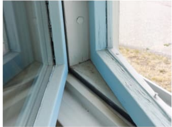
Kuva 28. Ikkunoiden puukarmeissa havaittiin etenkin pihan puolella (eteläjulkisivu) maalipinnan hilseilyä ja halkeilua. Myös uloimman lasin sisäpuutteesta tehtiin vastaavia havaintoja.
