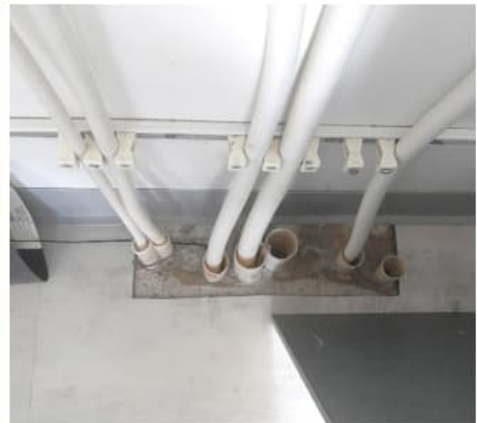
Kuva 20. Vasemmalla sähköpääkeskuksessa tiivistämättömiä läpivientejä. Oikealla on ryhmäkeskuksen suojaputkessa olevia kaapeliläpivientejä, joita ei ollut tiivistetty.
