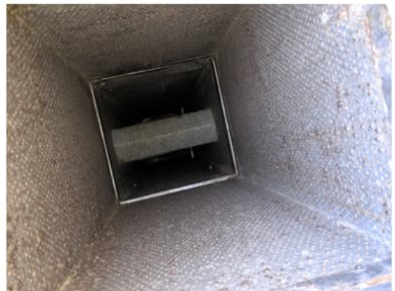
Kuva 66 a ja b. Vasemmassa kuvassa huippuimurin puhallin. Puhaltimessa ei havaittu poikkeavaa ääntä, puhallin on aistinvaraisesti arvioiden toimintakuntoinen. Oikeanpuoleisessa kuvassa puhallinkammio. Puhallinkammiossa on hieman likaa.
