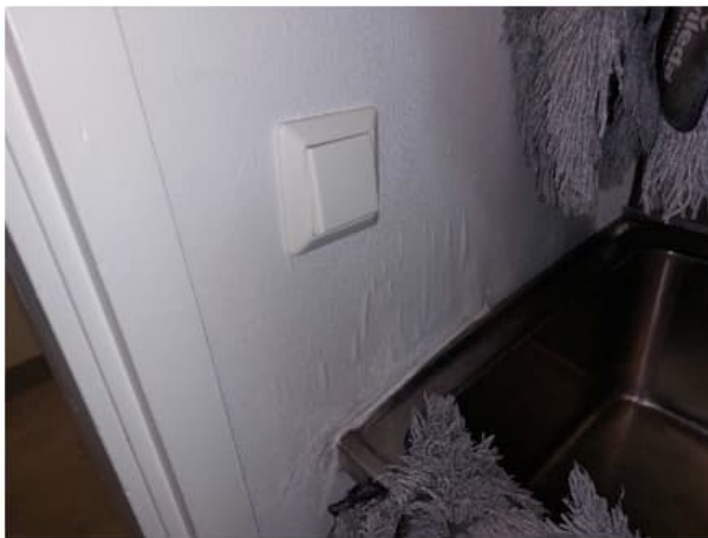
Kuva 36. Siivousskomeron vesipisteen vieressä väliseinän lasikuitutapetissa oli kosteusjälkiä ja kupruilua.
