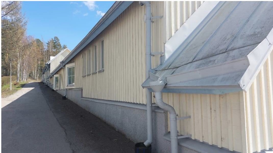
Kuva 5. Rakennuksen pohjoisjulkisivu. Sokkeli ja julkisivu ovat hyväkuntoiset.
