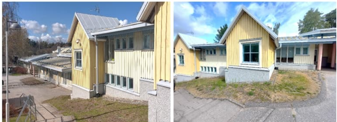
Kuva 7. Rakennuksen eteläjulkisivu, jossa lautaverhous on uusittu monin paikoin.
