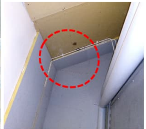
Kuva 51. IV-konehuoneen ja varaston katon vuotoon liittyvä kosteusjäljen sijainti yläpohjassa ympyröity kuvaan. Oikealla IV-konehuoneen katossa on korjattu rakenteita, materiaaleissa näkyy pieniä kosteusjälkiä.
