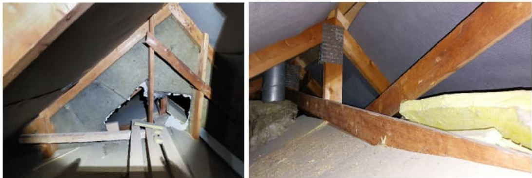
Kuva 46. Itäpäädyn yläpohjatila. Aluskate on hyväkuntoinen ja lämmöneristevillat olivat pölisevän kuivia.
