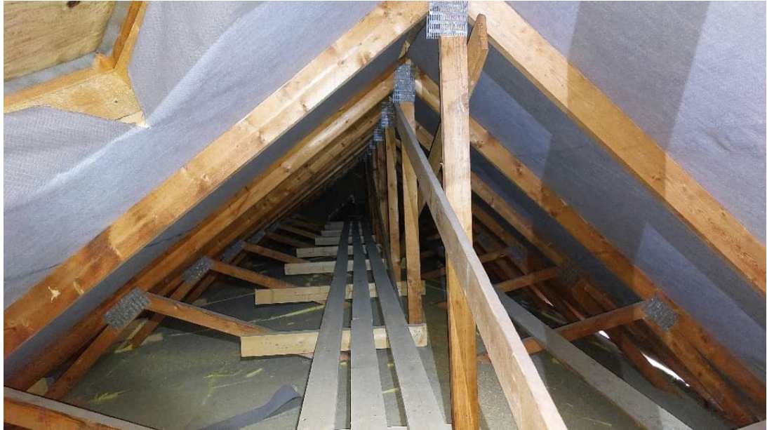
Kuva 46. Itäpäädyn yläpohjatila. Aluskate on hyväkuntoinen ja lämmöneristevillat olivat pölisevän kuivia.
