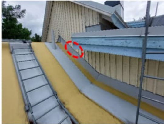
Kuva 50. Vesikatteen pellityksen ylösnosto ulkoseinälle on puutteellinen: vesikatolla on rakoja, joista sadevesi voi päästä ulkoseinien sisälle. Edellisen kuvan kosteusjäljen sijainti yläpohjassa ympyröity kuvaan.
