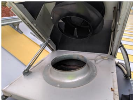
Kuva 66 a ja b. Vasemmassa kuvassa huippuimurin puhallin. Puhaltimessa ei havaittu poikkeavaa ääntä, puhallin on aistinvaraisesti arvioiden toimintakuntoinen. Oikeanpuoleisessa kuvassa puhallinkammio. Puhallinkammiossa on hieman likaa.
