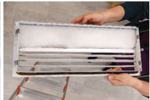
Kuva 55. Tuloilman päätelaitteet olivat pölyiset. päätelaitteiden äänenvaimentimet on vaihdettu kuiduttomaan materiaaliin, mutta kanavan pinnoilla oli jäämiä mineraalivillasta (näkyvät keltaisina kuituina).
