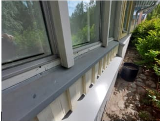
Kuva 28. Ikkunoiden puukarmeissa havaittiin etenkin pihan puolella (eteläjulkisivu) maalipinnan hilseilyä ja halkeilua. Myös uloimman lasin sisäpuutteesta tehtiin vastaavia havaintoja.
