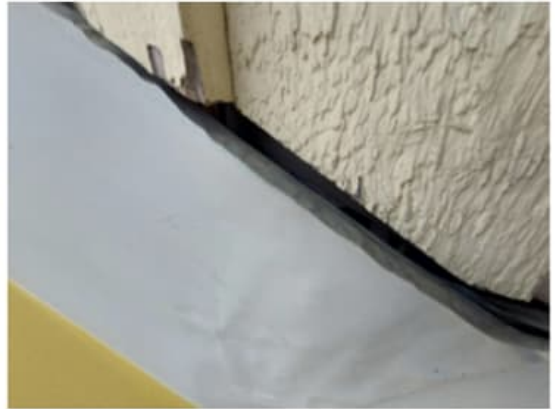
Kuva 50. Vesikatteen pellityksen ylösnosto ulkoseinälle on puutteellinen: vesikatolla on rakoja, joista sadevesi voi päästä ulkoseinien sisälle. Edellisen kuvan kosteusjäljen sijainti yläpohjassa ympyröity kuvaan.
