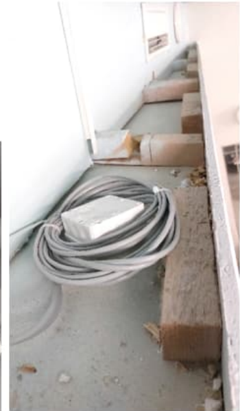
Kuva 54. Korkealla sijaitsevien tasopintojen päälle on kertynyt pölyä ja rakennusmateriaaliperäistä roskaa.
