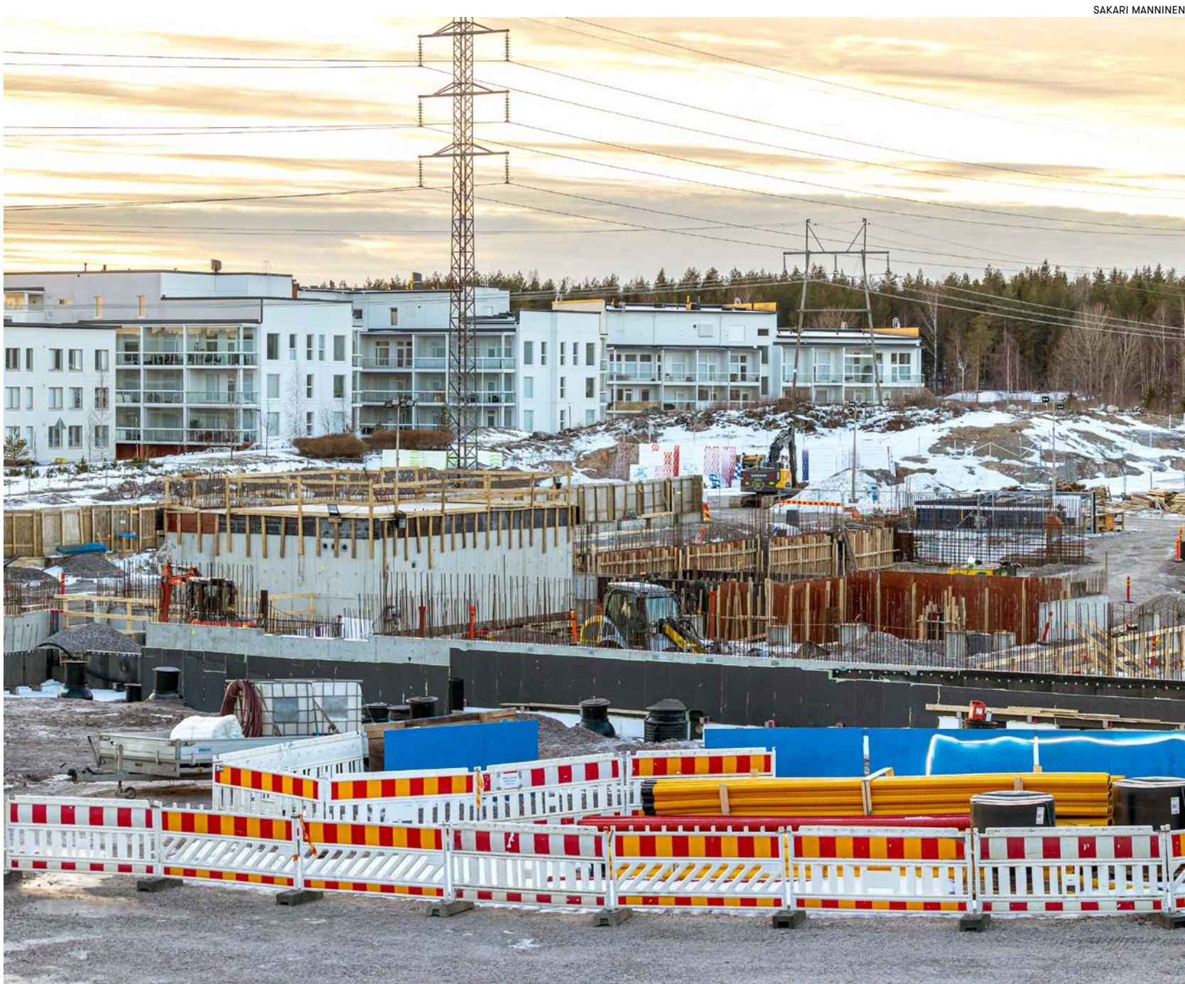
Työmaan vauhti kiihtyy, kun uimahallin runkorakenteet alkavat nousta perustusten päältä kevättalvella.
